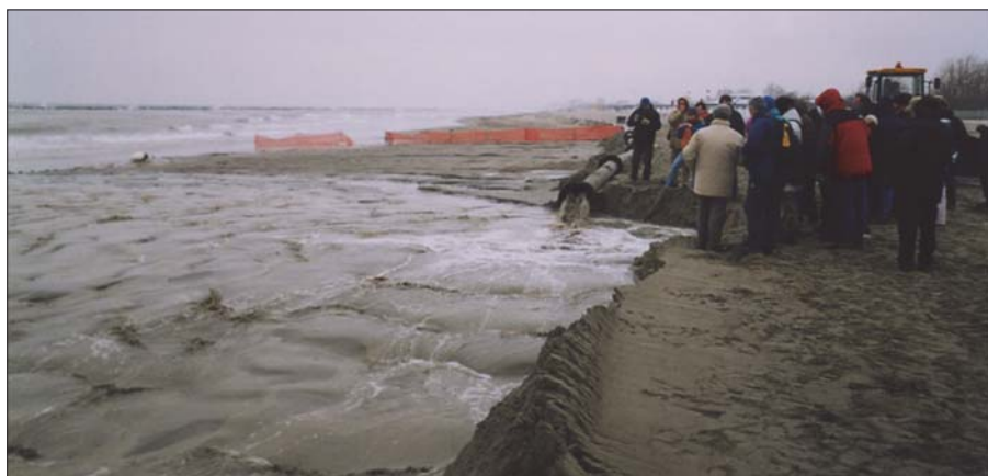
Figura 23 – Espansione della spiaggia degli Estensi (Ferrara) determinata da un versamento di sabbia a mezzo di un sabbiodotto (foto PENNETTA, 2004).
