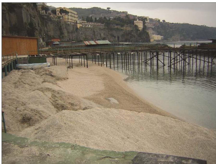
Figura 22 – Ripascimento eseguito con versamento di inerti carbonatici di frantoio biancastri in forma di ciottoli spigolosi; la loro forma riduce sia la fruizione della spiaggia rendendola poco piacevole che la sua valenza paesaggistica. La spiaggia naturale in erosione, alla base di una falesia modellata nel Tufo Grigio Campano, in origine era costituita da sabbia scura vulcanoclastica (Marina Piccola, Sorrento), (foto PENNETTA, 2006).
