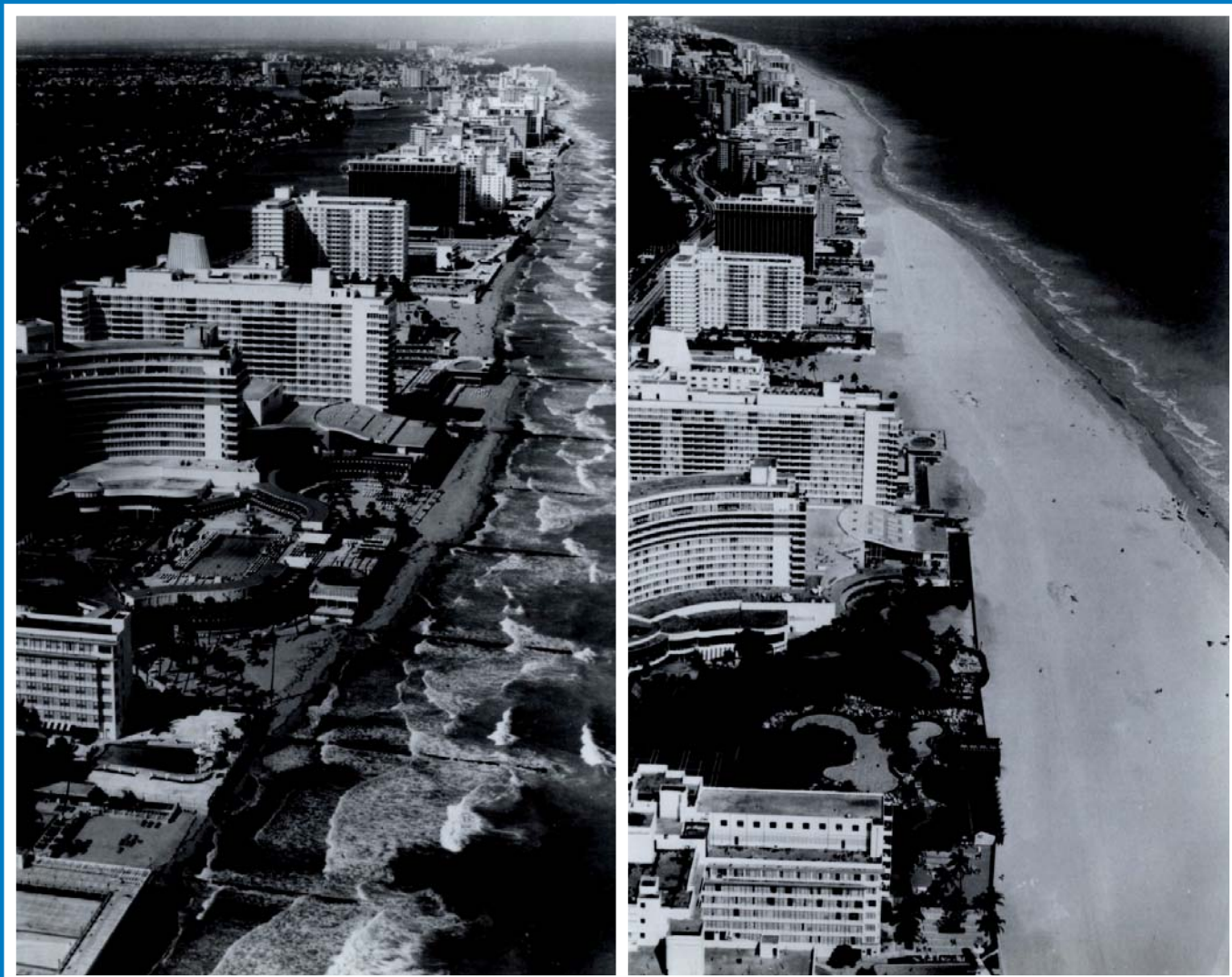
Miami (Florida, USA) prima e dopo il ripascimento della spiaggia eseguito nel 1970 e supervisionato da US Army Corps of Engineers (Foto Racontour)
