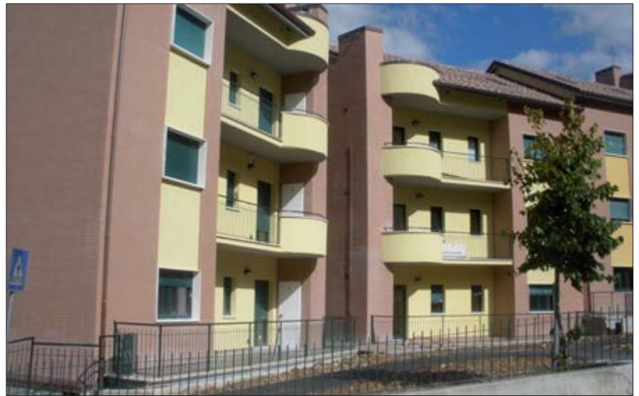
Figura 4 – (a – in alto a sinistra) Villa in c.a. di 3 piani e mansarda a L'Aquila (SS 17), fortemente danneggiata dal sisma del 2009, rinforzata con il Metodo CAM ed adeguata con 8 HDRB e 19 SD (foto a sinistra, del P.I. B. Spadoni); (b – a destra e in basso a sinistra) retrofit con l'isolamento sismico del complesso edilizio residenziale di via dei Tigli di Pianola (AQ) (42 HDRB e 62 SD, progetto dei soci GLIS Ingg. G. Mancinelli e D. Corsetti, collaudo statico in c.o. dello scrivente, in maggio 2014)
