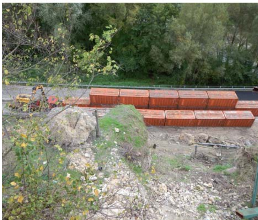
Figura 21 – Intervento di installazione in tempi rapidi di containers marittimi riempiti di pietrame a salvaguardia del traffico sulla SS 4 Salaria
