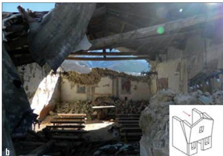
Figura 14 – Chiesa di San Martino: (a) meccanismo degli elementi di copertura (b) meccanismo di ribaltamento della facciata terminale
