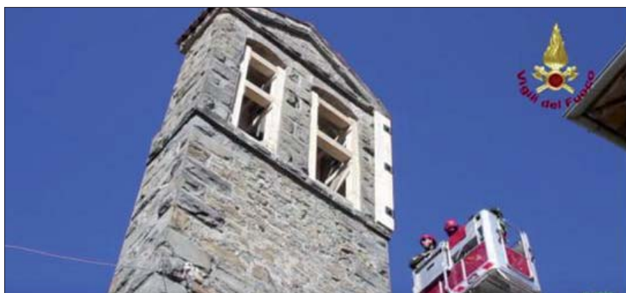
Figura 8 – Chiesa di S. Clemente. Messa in sicurezza del campanile a settembre 2016 (VIGILI DEL FUOCO, 2016)
