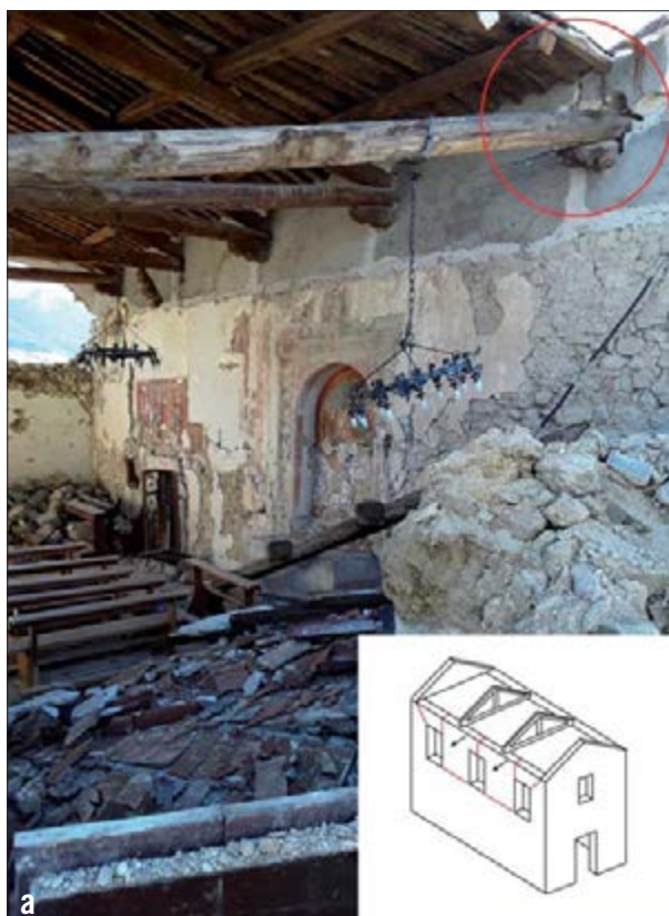
Figura 14 – Chiesa di San Martino: (a) meccanismo degli elementi di copertura (b) meccanismo di ribaltamento della facciata terminale
