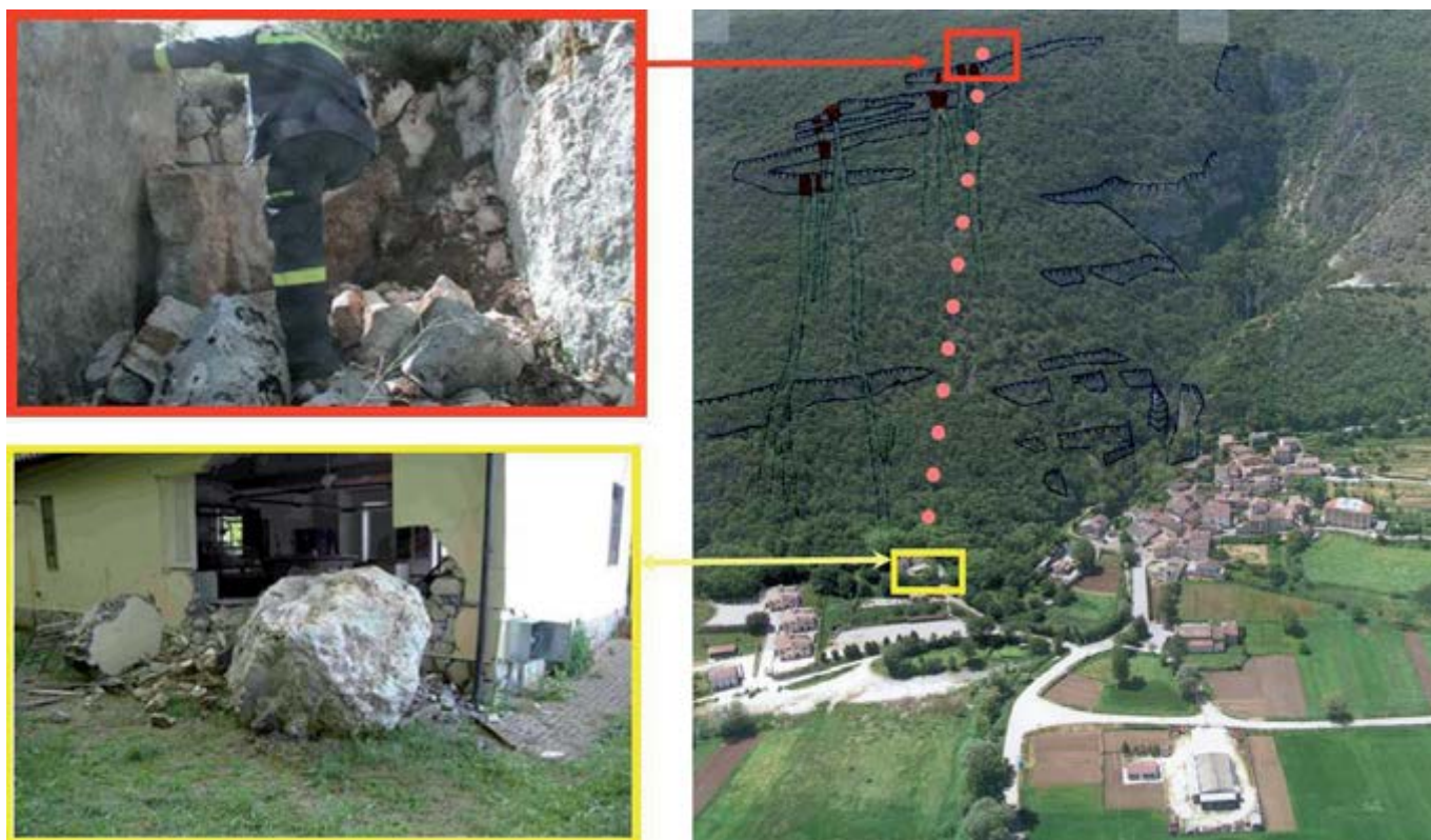
Figura 8 – Caduta di massi dal versante sovrastante l'ingresso delle Grotte di Stiffe nel Comune di San Demetrio Né Vestini (AQ): in rosso è individuata l'area di distacco; in giallo l'edificio di un ristorante distrutto da uno dei massi caduti
