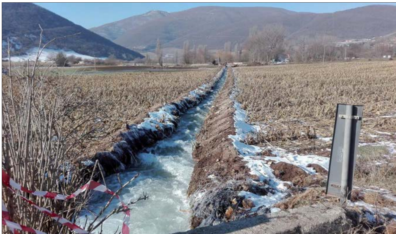
Figura 15 – Sorgente del Torbidone (Norcia), febbraio 2017: il continuo incremento di portata ha reso necessario ricreare ed ampliare il vecchio alveo "tombato" dopo il terremoto del 1979
