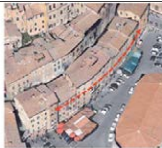
Figura 8 – Siena, Piazza del Mercato: esempio di aggregato edilizio ad impianto concavo sul lato a valle e schema qualitativo
