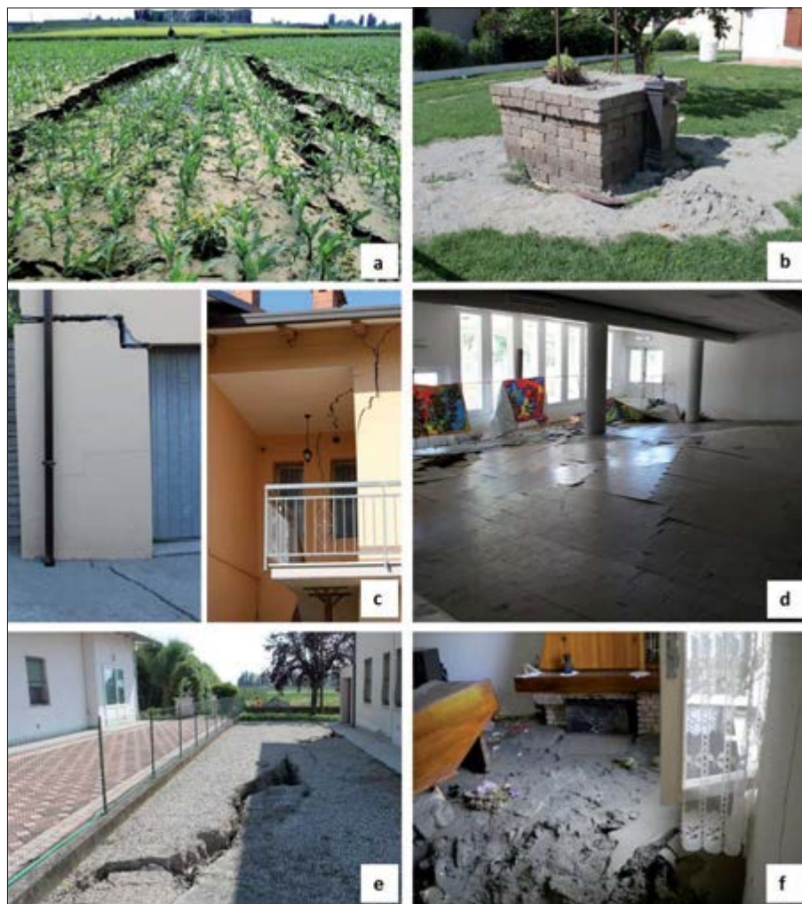
Figura 13 – Effetti dei fenomeni di liquefazione: a – fratture con andamento ad enclon in un campo coltivato; b – fuoriuscita di sabbia da un pozzo; c – fratturazione del terreno con lesioni strutturali ad un edificio; d – rialzamento del pavimento di un vano al piano terra; e – frattura in prossimità di un edificio senza danni per il medesimo; f – invasione di sabbia al piano terra di un appartamento
