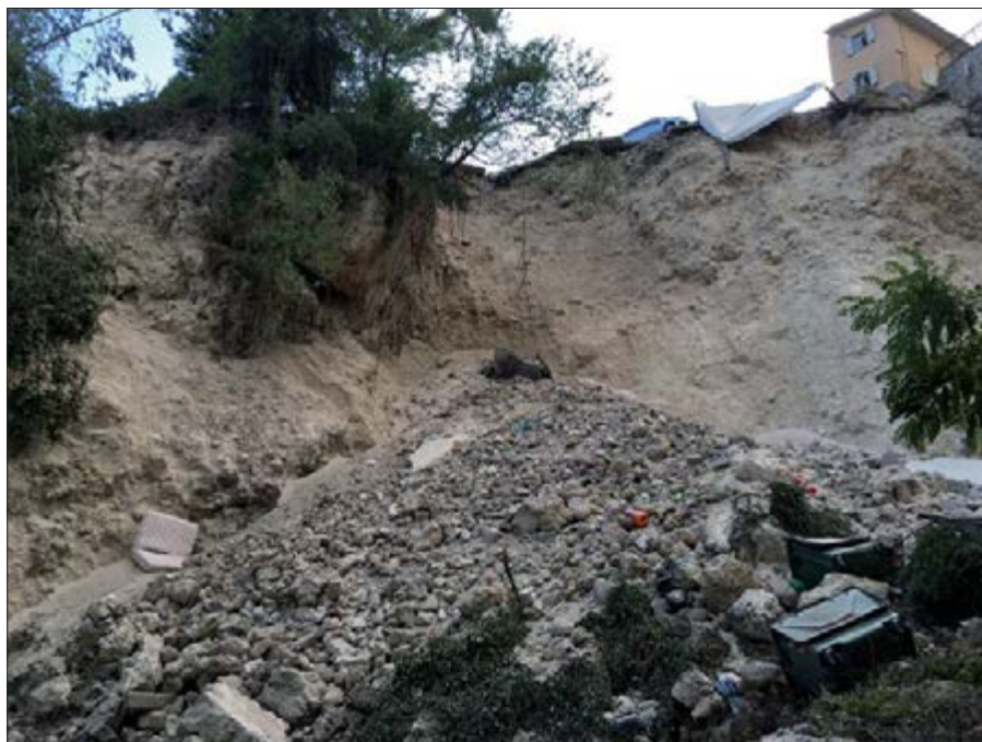
Figura 6 – Fenomeni franosi sismoindotti lungo il versante in sponda destra del Rio Cavone, adiacente alla S.S. 4 Salaria e sopra cui sorgeva l'abitato di Pescara del Tronto (frazione di Arquata del Tronto - AP)
