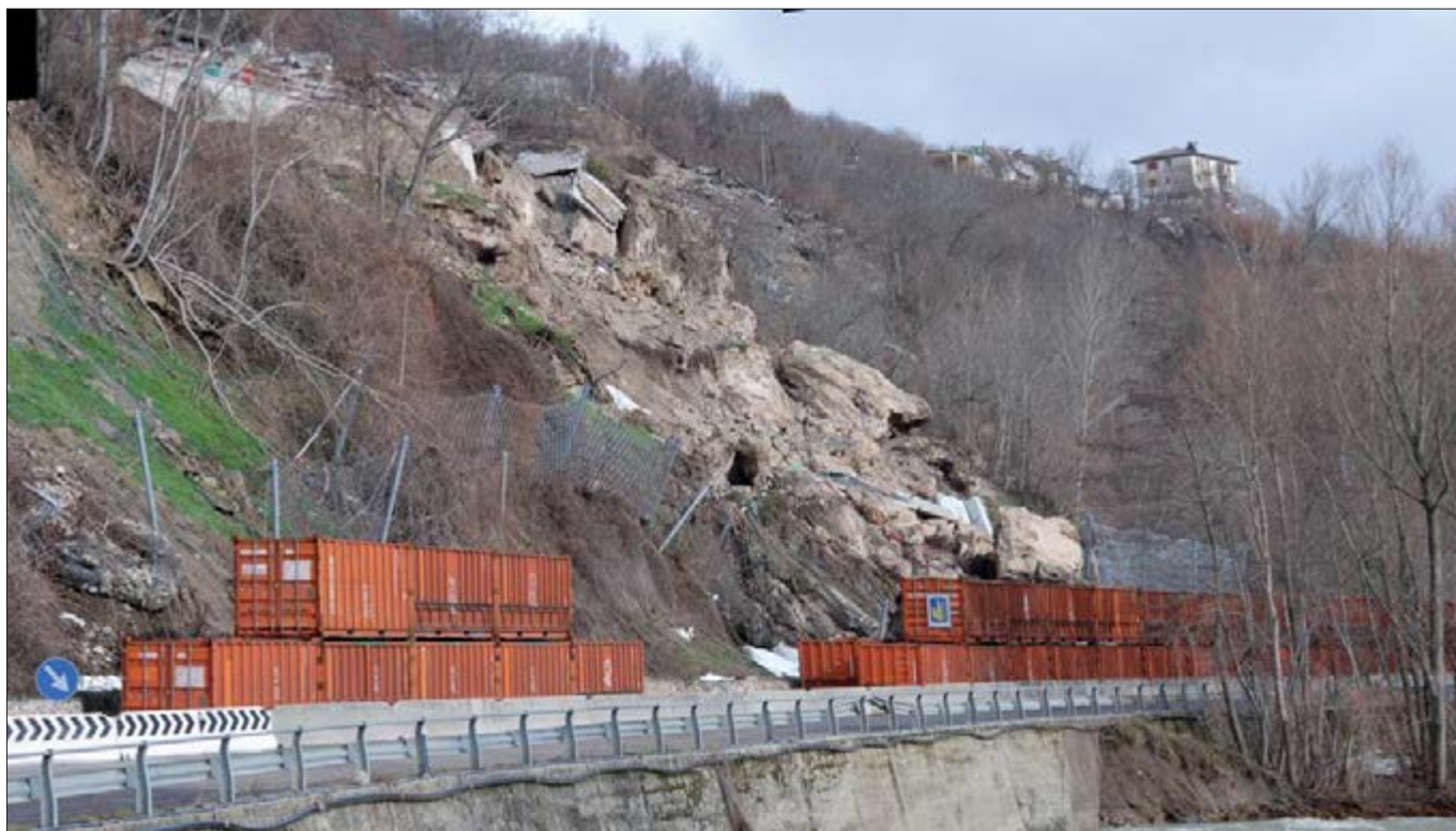
Figura 13 – La frana lungo il versante incombente sulla S.S.4 Salaria e i container installati dall'ANAS a protezione della stessa
