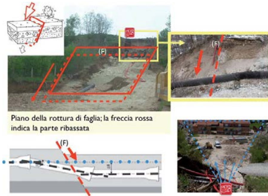
Figura 5 – Rottura dell'acquedotto del Gran Sasso a Paganica; i punti di scatto delle foto sono indicati dal simbolo rosso
