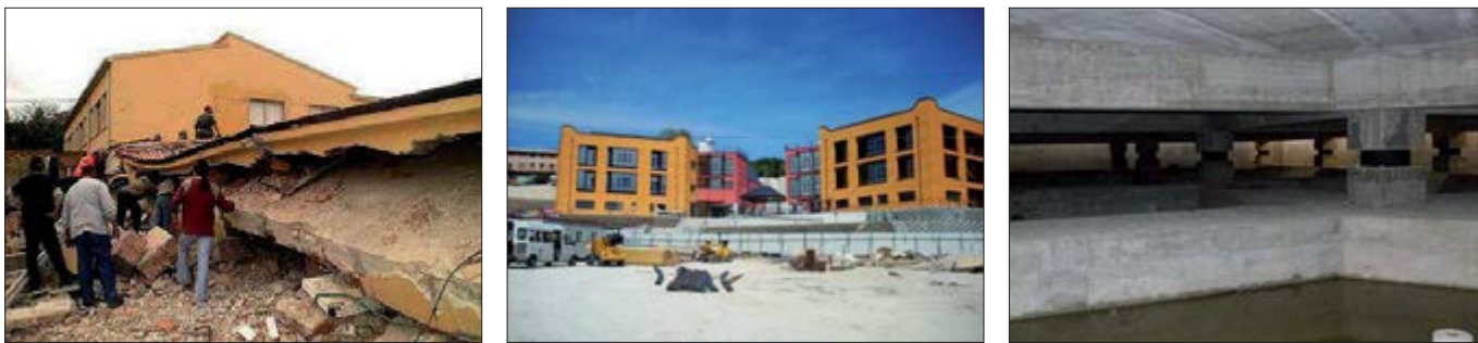
Figura 1 – La scuola elementare Francesco Jovine di San Giuliano di Puglia (CB), distrutta dal terremoto del Molise e della Puglia del 2002 (a sinistra) e ricostruita (in altra posizione), assieme ad un secondo corpo di fabbrica, su una piattaforma comune isolata sismicamente (su progetto di un team coordinato dall'ENEA), mediante 61 HDRB e 12 SD, che permettono anche di minimizzare gli effetti torsionali indotti dalla forte asimmetria della struttura in pianta (si tratta della prima delle ormai oltre 30 scuole isolate in Italia, collaudata in corso d'opera – c.o. – nel 2008 dallo scrivente e dall'Ing. G. Pasquale di Campobasso)
