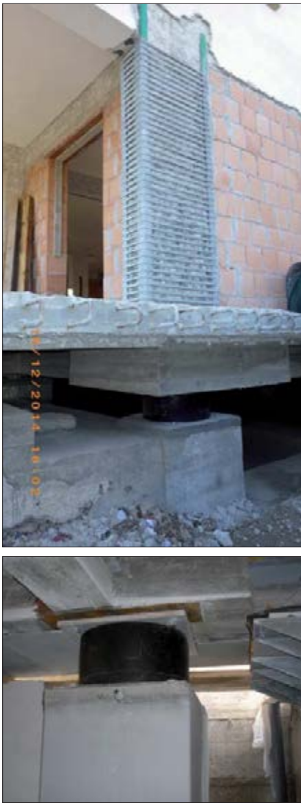
Figura 4 – (a – in alto a sinistra) Villa in c.a. di 3 piani e mansarda a L'Aquila (SS 17), fortemente danneggiata dal sisma del 2009, rinforzata con il Metodo CAM ed adeguata con 8 HDRB e 19 SD (foto a sinistra, del P.I. B. Spadoni); (b – a destra e in basso a sinistra) retrofit con l'isolamento sismico del complesso edilizio residenziale di via dei Tigli di Pianola (AQ) (42 HDRB e 62 SD, progetto dei soci GLIS Ingg. G. Mancinelli e D. Corsetti, collaudo statico in c.o. dello scrivente, in maggio 2014)
