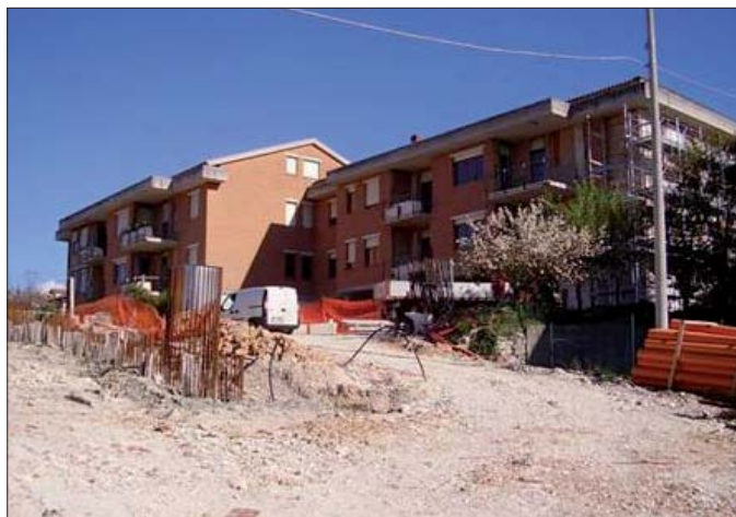
Figura 5 – Palazzina di via Fratelli Latini a Fabriano (Ancona), che aveva riportato danni non strutturali durante i terremoti umbro-marchigiani del 1997-98 e che fu adeguata sismicamente, per la prima volta in Europa, dal compianto socio del GLIS e dell'ASSISi Ing. G. Mancinelli, con l'isolamento sismico in sottofondazione (costituito da 56 HDRB) e fu collaudata in c.o. dallo scrivente nel 2006 (questa palazzina non ha sinora riportato alcun danno durante la crisi sismica iniziata, nell'Italia Centrale, il 24 agosto, neppure durante l'evento di Norcia del 30 ottobre 2016)
