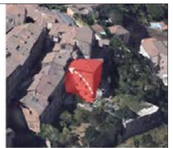
Figura 10 – Siena: aggregato edilizio con corpi di contrasto collocati sul lato del pendio
