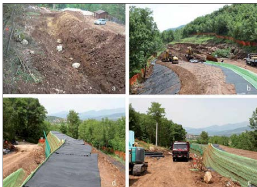
Figura 10 – Fasi di realizzazione del tomovallo: a - scavi di fondazione con prove di caduta massi; b - realizzazione del 1° livello dell'opera; c - completamento della sommità; d - impermeabilizzazione del tomovallo
