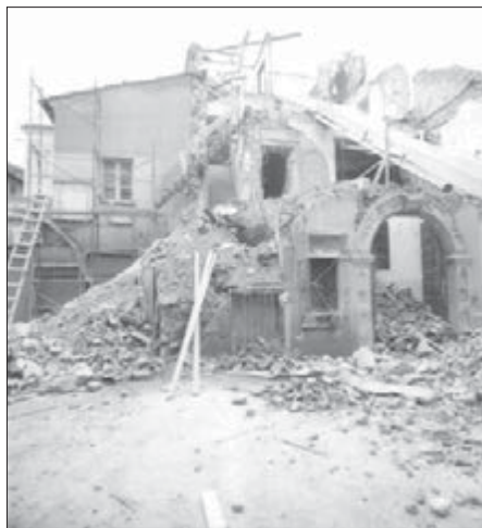
Figura 11 – Terremoto del 23 novembre 1980: crollo del Palazzo Bollettino nella città di Potenza (Fonte: Soprintendenza Archeologia, Belle Arti e Paesaggio della Basilicata, Potenza)
