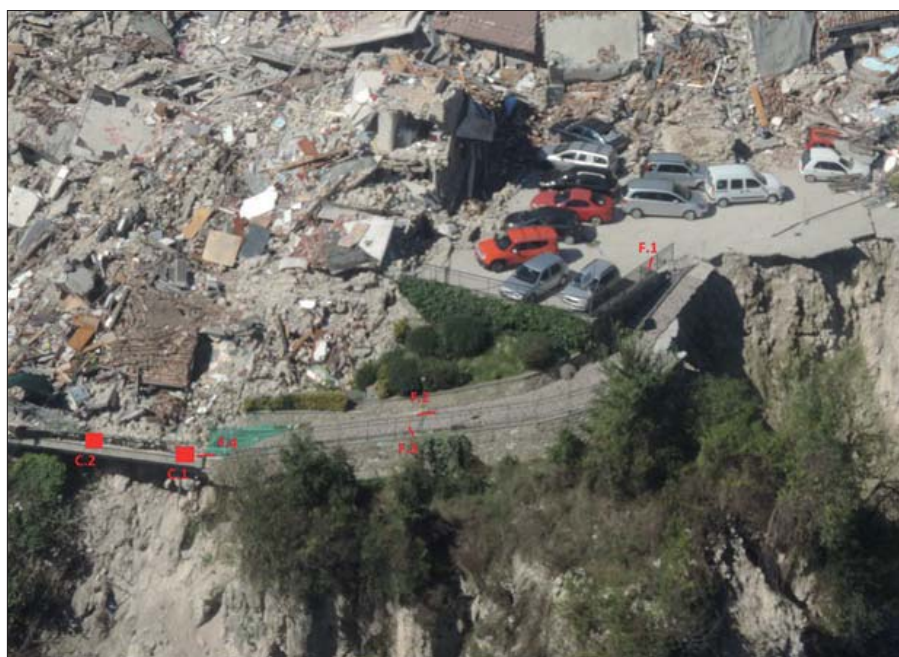
Figura 20 – Sistema di monitoraggio del versante. Strumenti di monitoraggio (in rosso): C – Inclinatori; F – Estensimetro di superficie (Crackmeter)
