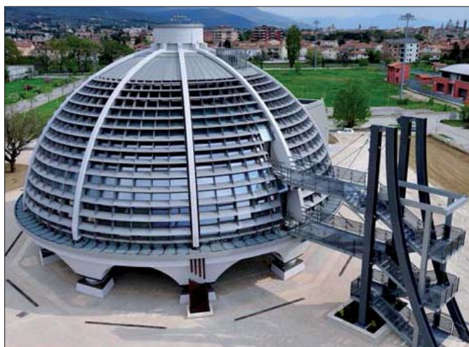
Figura 2 – L'edificio principale ("Sale Operative") del Centro della Protezione Civile di Foligno (ove sono numerosi gli edifici isolati), che poggia su 10 HDRB di 1 metro di diametro (il corpo centrale, contenente le scale di accesso, è sospeso e giuntato), progettato dal socio GLIS ed ASSISI Prof. A. Parducci (con la collaborazione dell'ENEA per la ridefinizione delle azioni sismiche di progetto) e collaudato in c.o. dallo scrivente nel 2011 (si notino l'architettura, impossibile con fondazioni convenzionali e per la quale il Prof. Parducci ha ottenuto premi, ed il fatto che l'edificio è stato dotato di un sistema di monitoraggio sismico, come raccomandato dallo scrivente nella sua relazione di collaudo, realizzato con la collaborazione dell'ENEA e che ha permesso l'ottenimento di dati di estrema importanza durante la crisi sismica iniziata il 24 agosto 2016 nell'Italia Centrale)
