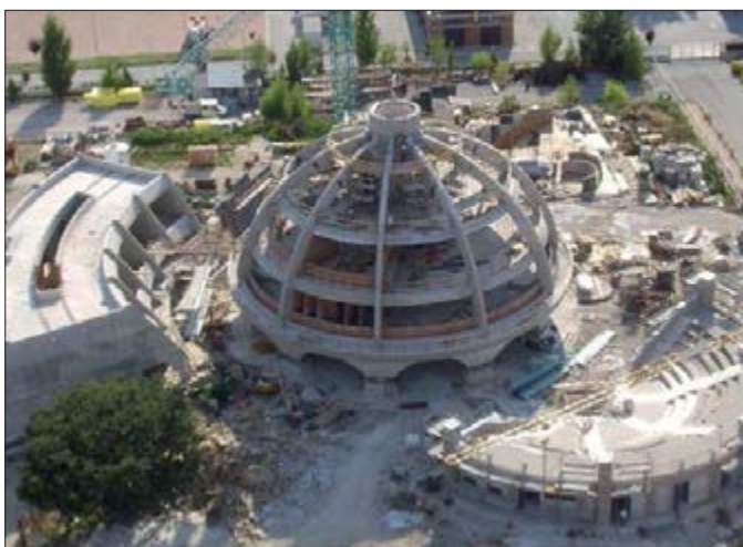
Figura 2 – L'edificio principale ("Sale Operative") del Centro della Protezione Civile di Foligno (ove sono numerosi gli edifici isolati), che poggia su 10 HDRB di 1 metro di diametro (il corpo centrale, contenente le scale di accesso, è sospeso e giuntato), progettato dal socio GLIS ed ASSISI Prof. A. Parducci (con la collaborazione dell'ENEA per la ridefinizione delle azioni sismiche di progetto) e collaudato in c.o. dallo scrivente nel 2011 (si notino l'architettura, impossibile con fondazioni convenzionali e per la quale il Prof. Parducci ha ottenuto premi, ed il fatto che l'edificio è stato dotato di un sistema di monitoraggio sismico, come raccomandato dallo scrivente nella sua relazione di collaudo, realizzato con la collaborazione dell'ENEA e che ha permesso l'ottenimento di dati di estrema importanza durante la crisi sismica iniziata il 24 agosto 2016 nell'Italia Centrale)
