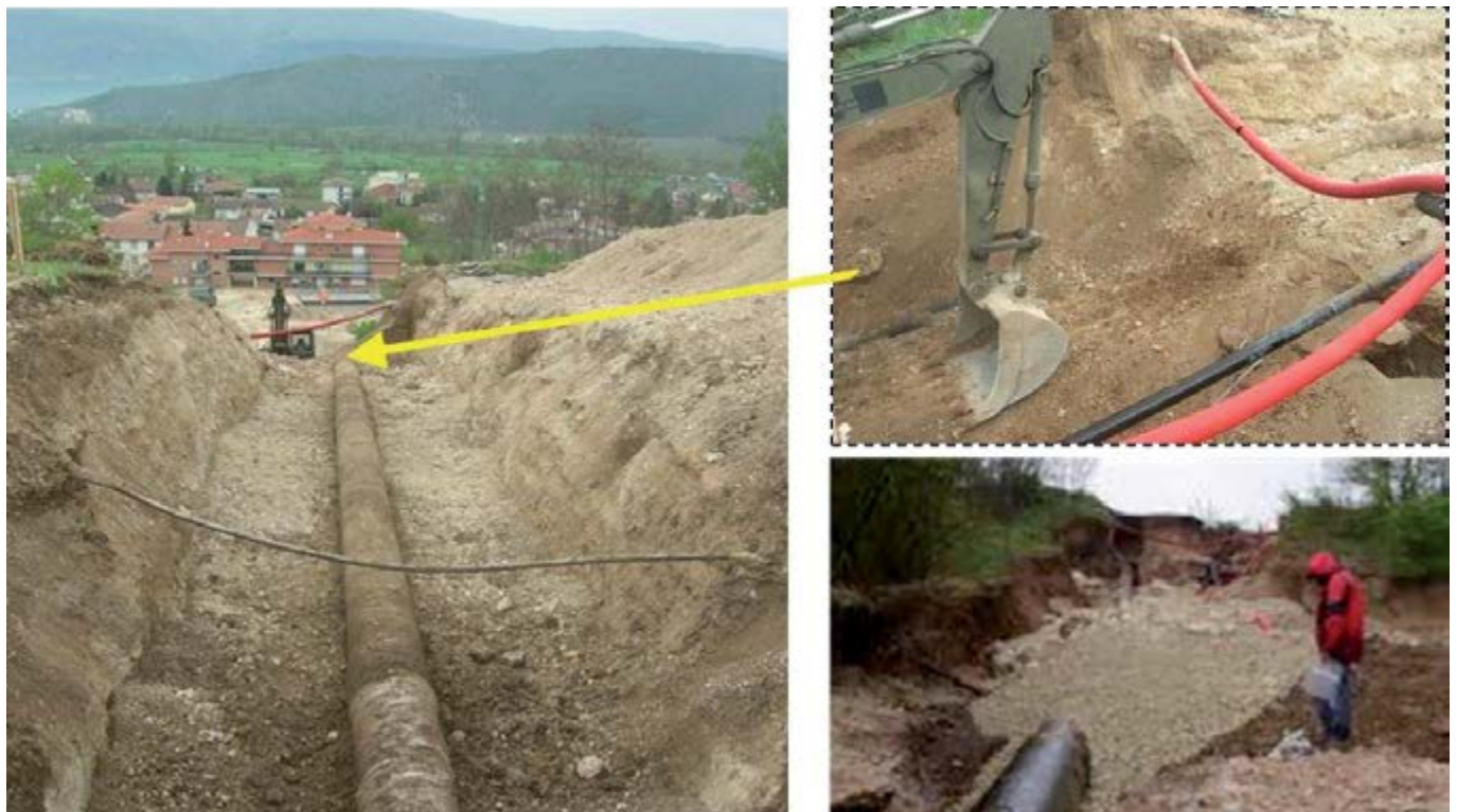
Figura 6 – Rottura dell'acquedotto a Paganica: interventi di ripristino della condotta posata su uno strato di ghiaia
