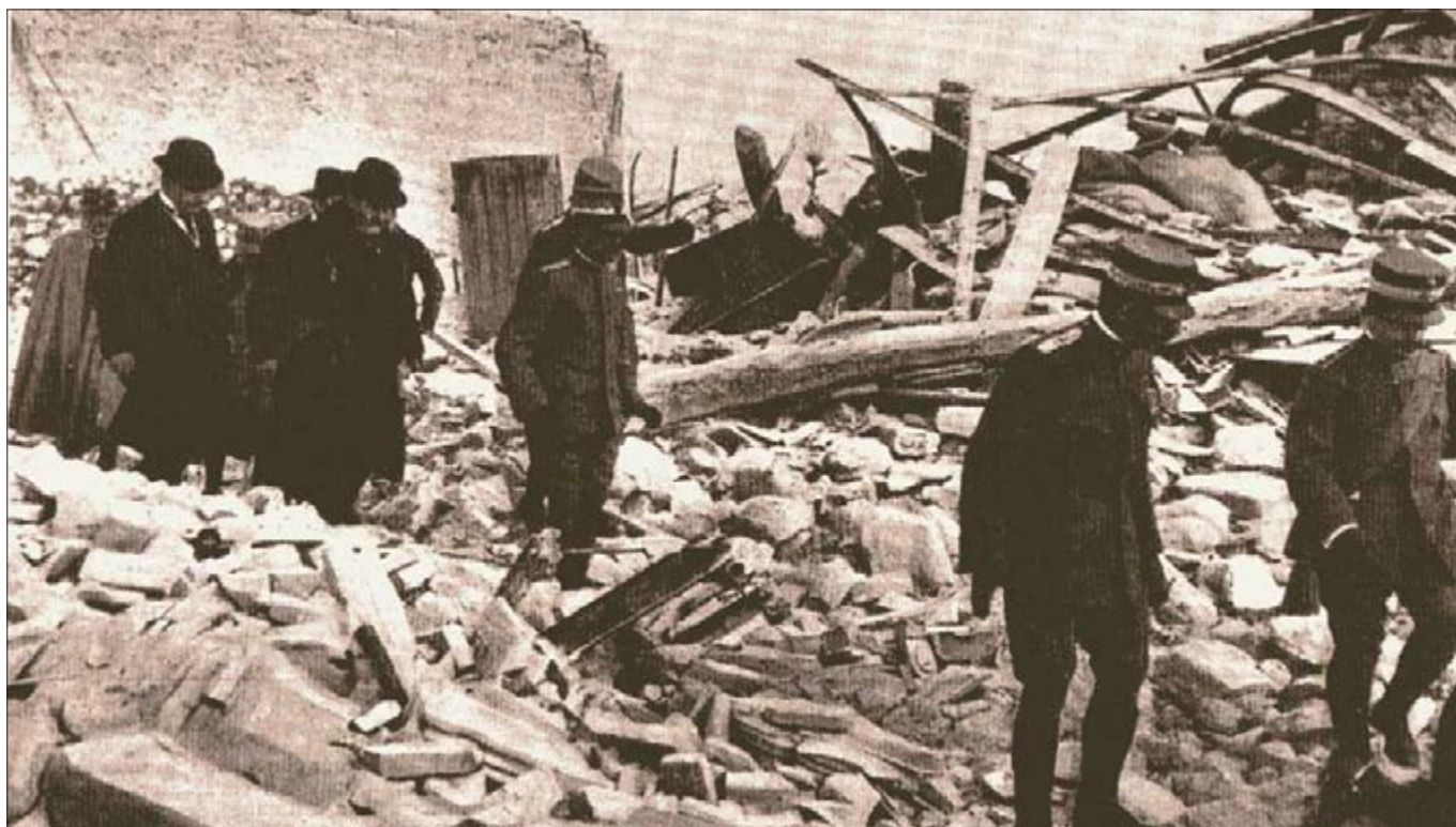
Figura 5 – Fotografia del terremoto di Avezzano (1915)
