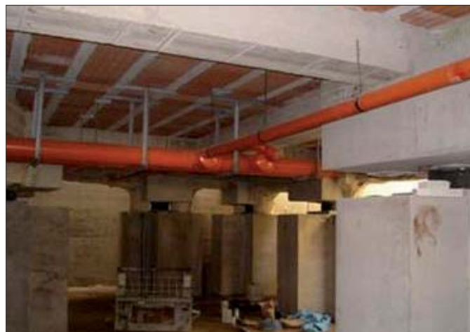
Figura 5 – Palazzina di via Fratelli Latini a Fabriano (Ancona), che aveva riportato danni non strutturali durante i terremoti umbro-marchigiani del 1997-98 e che fu adeguata sismicamente, per la prima volta in Europa, dal compianto socio del GLIS e dell'ASSISi Ing. G. Mancinelli, con l'isolamento sismico in sottofondazione (costituito da 56 HDRB) e fu collaudata in c.o. dallo scrivente nel 2006 (questa palazzina non ha sinora riportato alcun danno durante la crisi sismica iniziata, nell'Italia Centrale, il 24 agosto, neppure durante l'evento di Norcia del 30 ottobre 2016)
