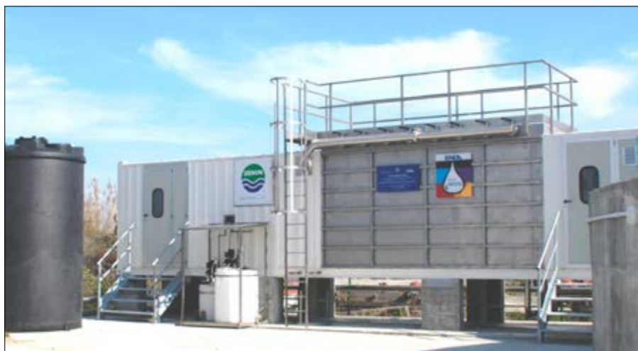
Figura 4. Impianto sperimentale ENEA-Goccia per il trattamento terziario dei reflui con membrane microfiltranti, Rocca Imperiale (CS)
