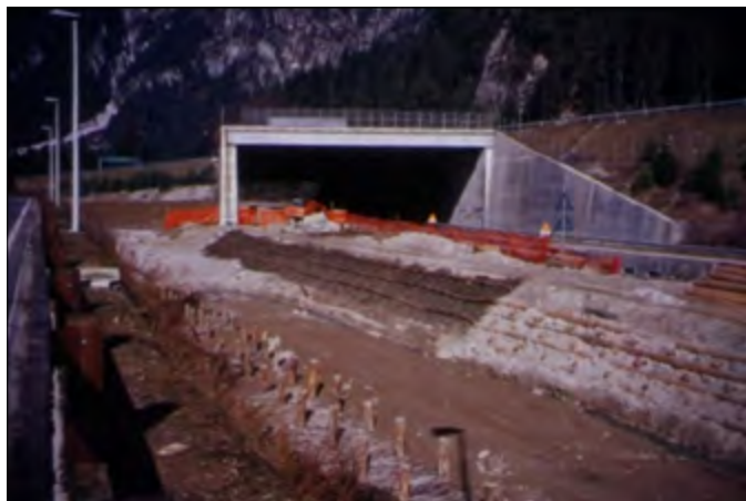
Fiume Fella, in opera, 1998
