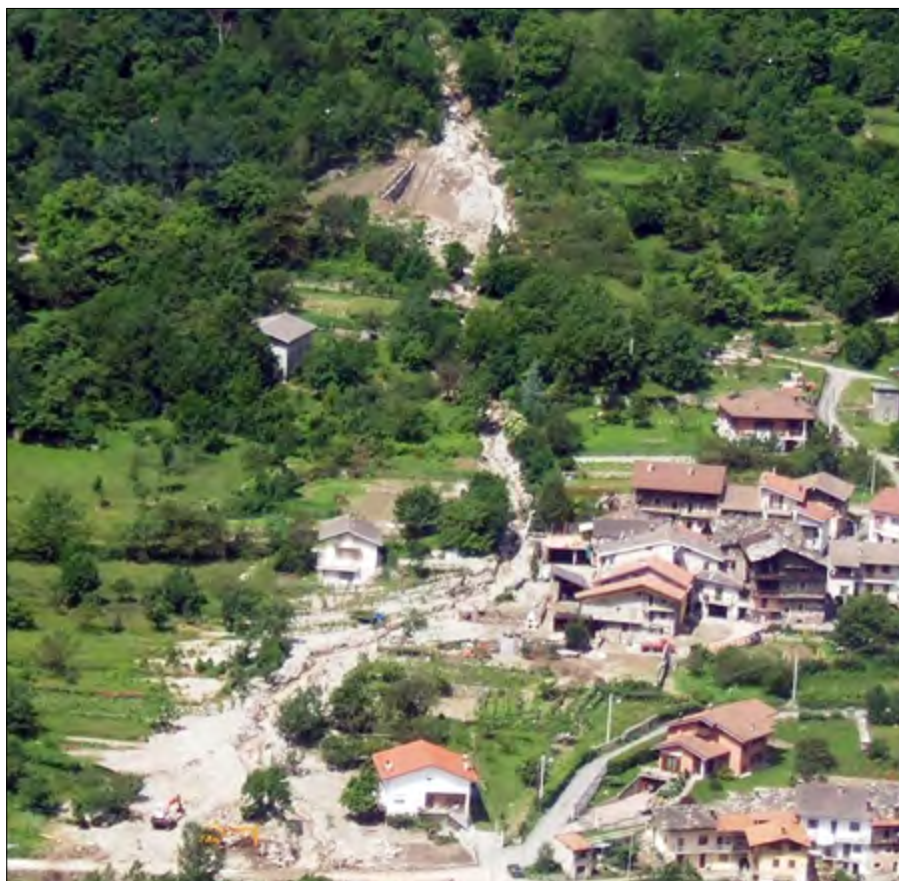
Figura 10. Effetti della colata detritica del maggio 1977 (foto Archivio IRPI)(A); immagini dell'areale di invasione da parte dei detriti trasportati lungo il T. Supita il 29 maggio 2008. Vista aerea dell'accumulo in conoide (B)(in Luino e Turconi, 2017, foto G. Savio)
