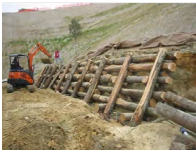
Palificata Roma - Urbanizzazione La Leprignano (RM) 2007. Foto P. Cornelini
