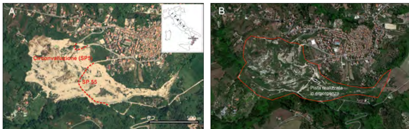
Fig. 1. A) La frana di Maierato dopo qualche mese dalla sua attivazione. In rosso sono riportati il tratto della Strada Provinciale Maierato-Filogaso (SP55) e il tornante della circonvallazione distrutti dal movimento franoso. B) La frana dopo circa sette anni dalla sua attivazione. In rosso il limite della frana; la freccia indica il tracciato di servizio realizzato in emergenza
