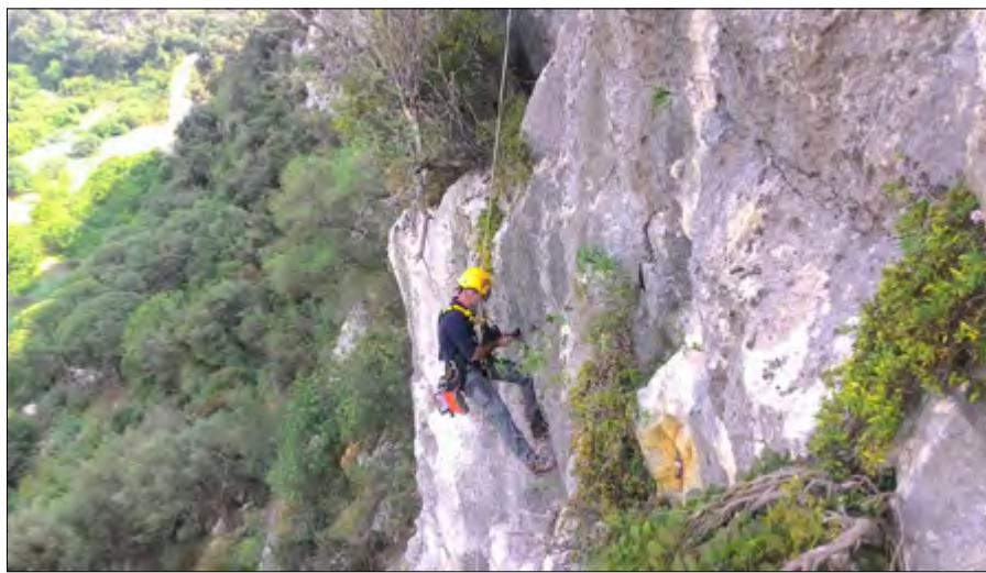
Figura 5. Fasi esecutive dei rilievi geostrutturali e geomeccanici
