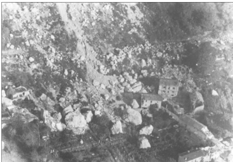
Figura 7. Crolli a seguito del terremoto del 1976, abitato di Braulins, Comune di Trasaghis, tratto da Cavallo R. Bertini T. (1976)
