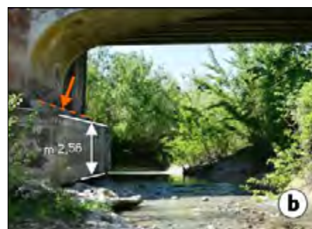
Figura 6. Ponte di Pozza: luce destra nel 1977, oggi occlusa (a), e luce centrale nel 2019, occlusa nel 1977 (b)
