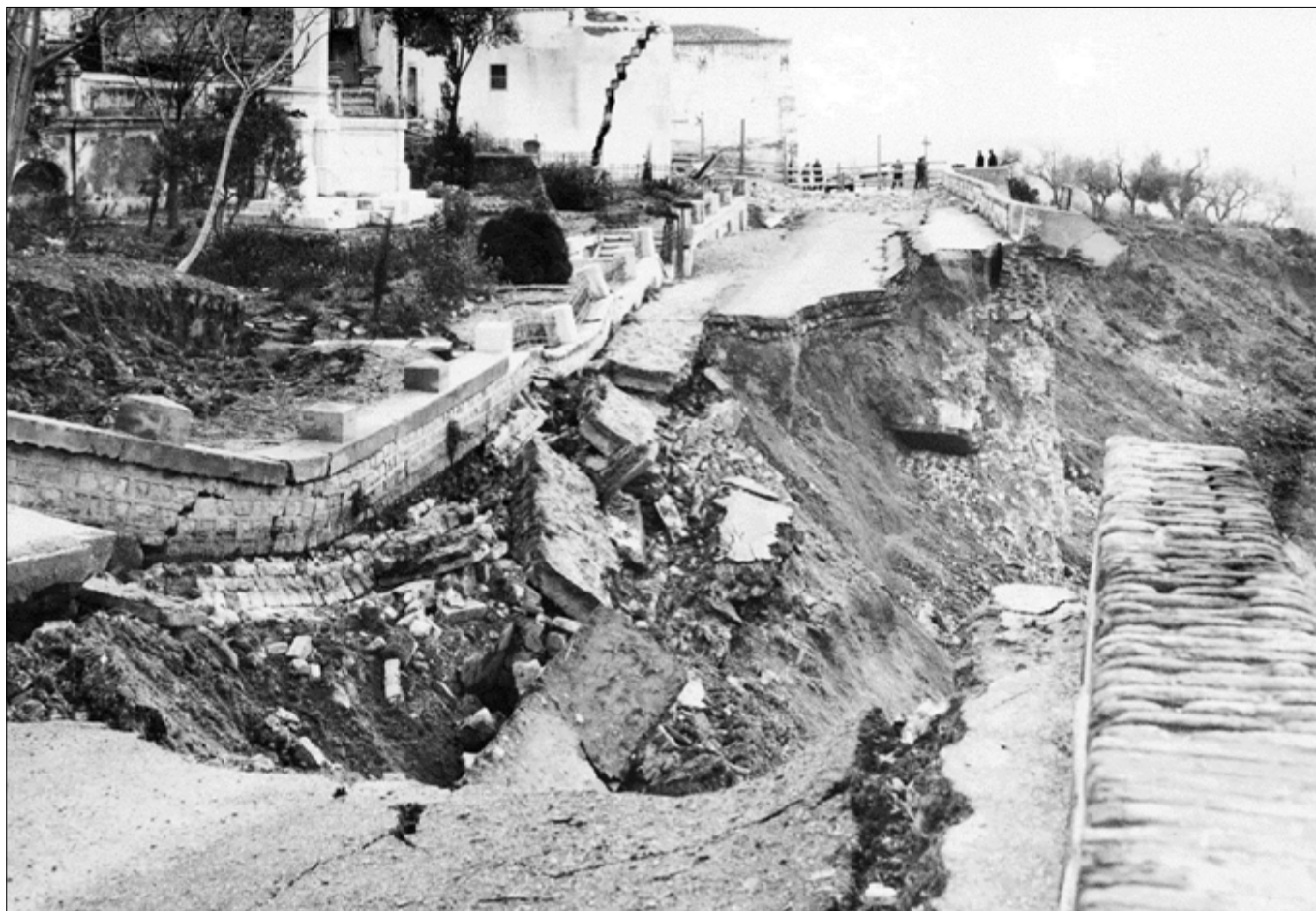
Figura 3. Craco. Frana del 17 gennaio 1965. Muro a sostegno della SS103 crollato a seguito della riattivazione della frana (Fonte: Archivio Storico Dipartimento Protezione Civile, Ministero LL. PP., Divisione 29, Matera C., Colobraro-Craco, B. 4. Craco - Zona movimento franoso. Foto sciolte. Craco, 17 gennaio 1965)
