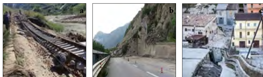
Figura 2. Danneggiamenti causati da: a) alluvione, b) frana e c) sisma
