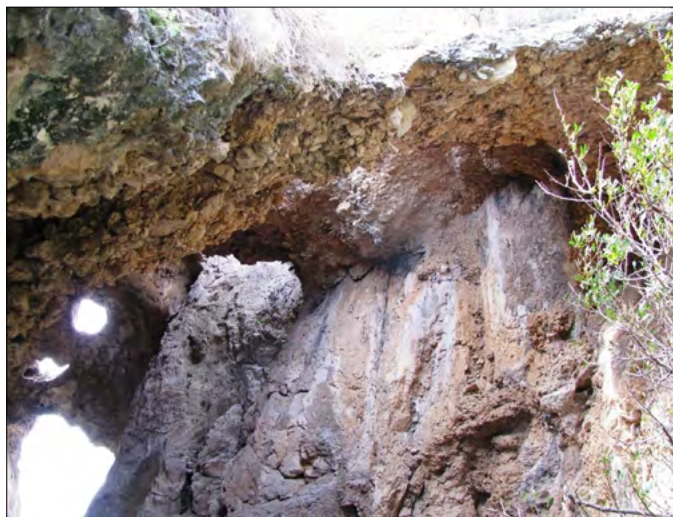
Figura 29. Sforzellamento della volta della galleria a punta Trapani (da F. Boccalaro, 2008)
