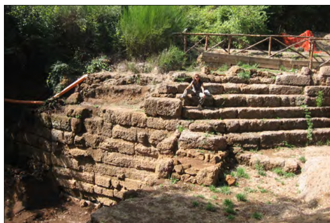
Figura 16. La spalla settentrionale del ponte sul Rio Maggiore (foto Gianluca Cerri)
