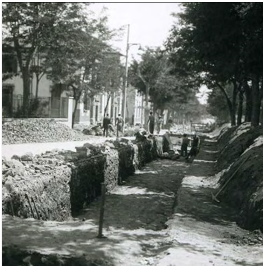
Figura 6. PAOANT, Archivio Fotografico, n. 2640, part.: l'antica via Ostiense rinvenuta al di sotto dell'attuale via dei Romagnoli all'altezza della moderna borgata di Ostia Antica
