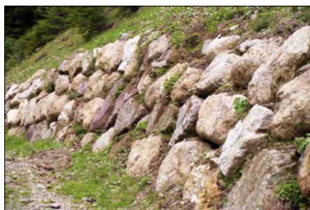
Figura 49. Muratura in pietrame a secco rinverdita in Val Venosta (da F. Boccalaro, 2005)
