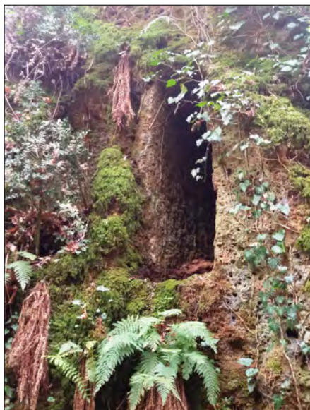
Figura 18. Cunicolo di drenaggio presso il ponte sul Rio Fossitello a Nepi (foto Gianluca Cerri)
