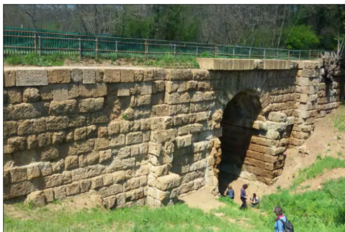
Figura 15. Il ponte sul Fosso dei Tre Ponti (foto Gianluca Cerri)
