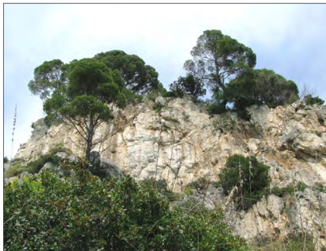
Figura 30. Parete rocciosa a rischio crolli (da F. Boccalaro, 2008)
