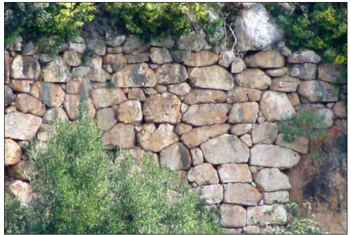
Figura 9. Muro ciclopico in opera poligonale su cui poggia spesso la via litoranea (da F. Boccalaro, 2008)
