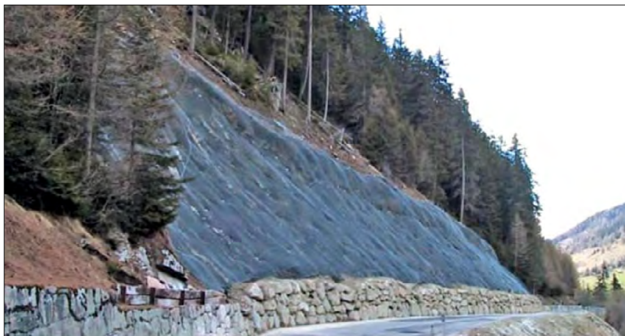
Figura 52. Chiodatura del terreno durante i lavori (da GEOBRUGG)
