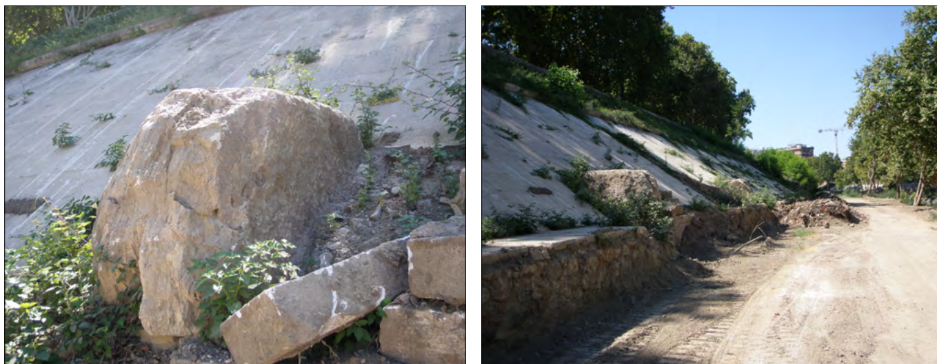
Figura 12. a) bitta in travertino vandalizzata, faceva parte del molo scavato da Padre Bruzza nel 1868, inglobata nei muraglioni del Tevere in sinistra idrografica all'altezza di via Florio a Testaccio; b) vista delle due bitte vandalizzate tuttora visibili dopo la periodica pulizia delle sponde, inglobate nel muraglione in riva sinistra idrografica del Tevere
