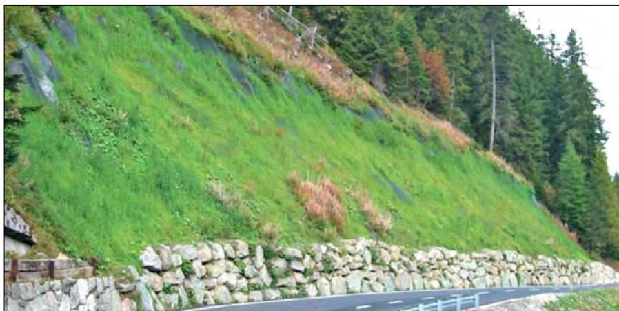
Figura 53. Chiodatura del terreno dopo i lavori (da GEOBRUGG)
