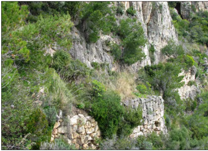
Figura 8. Muri di terrazzamento in opera poligonale (da F. Boccalaro, 2008)
