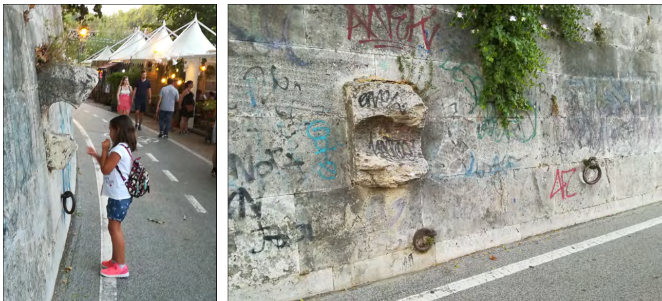
Figura 11. a) bitta in travertino vandalizzata, inglobata nei muraglioni in riva destra idrografica del Tevere poco a sud dell'Isola Tiberina e di Ponte Palatino; b) bitta in travertino vandalizzata, inglobata nei muraglioni in riva destra idrografica del Tevere poco a sud dell'Isola Tiberina e di Ponte Palatino poco più a nord della precedente
