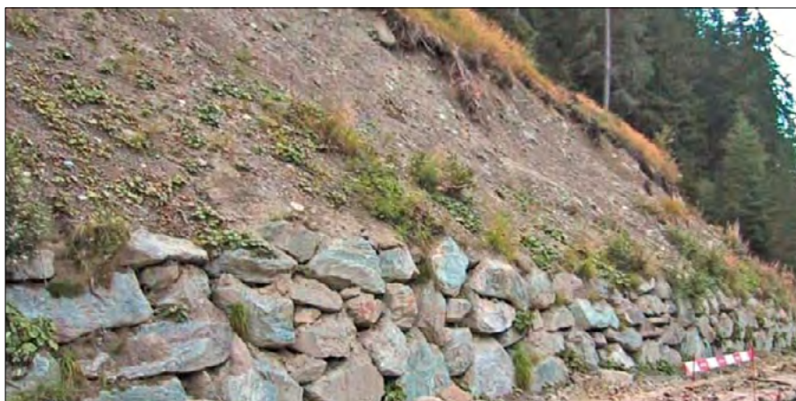
Figura 51. Chiodatura del terreno prima dei lavori (da GEOBRUGG)
