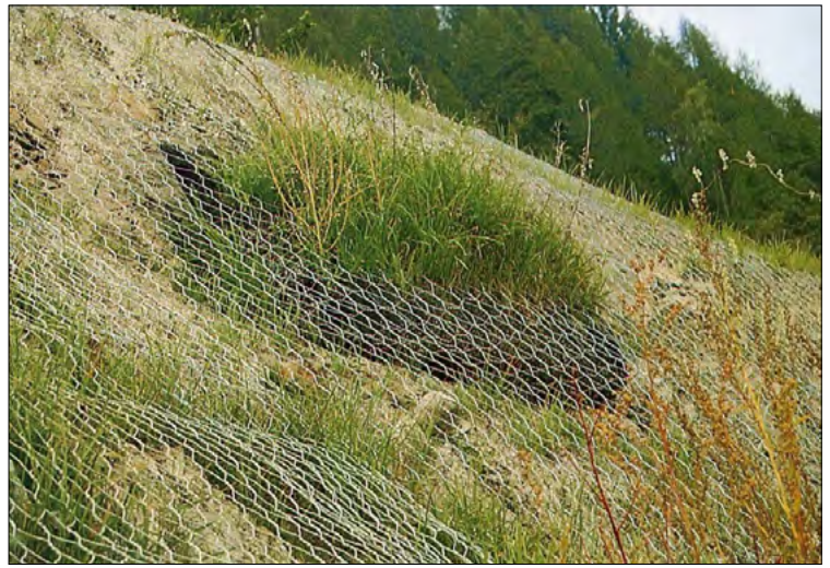
Figura 38. Rivestimento vegetativo a tasche (da Ferraiolo, 2003)
