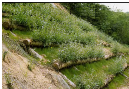
Figura 45. Grata viva a Cadibona (SV) (da F. Boccalaro, 1994)
