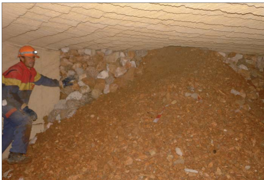
Figura 17 – Realizzazione di sbarramento mediante cono detritici – completamento
