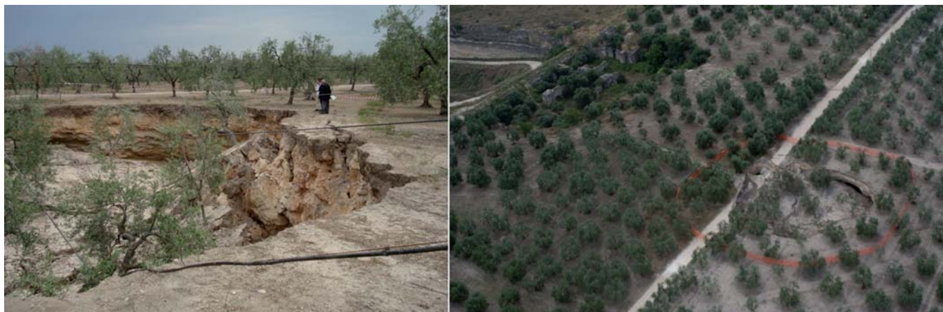
Figura 3 - Vedute del sink-hole di "San Procopio" - Agro di Barletta
