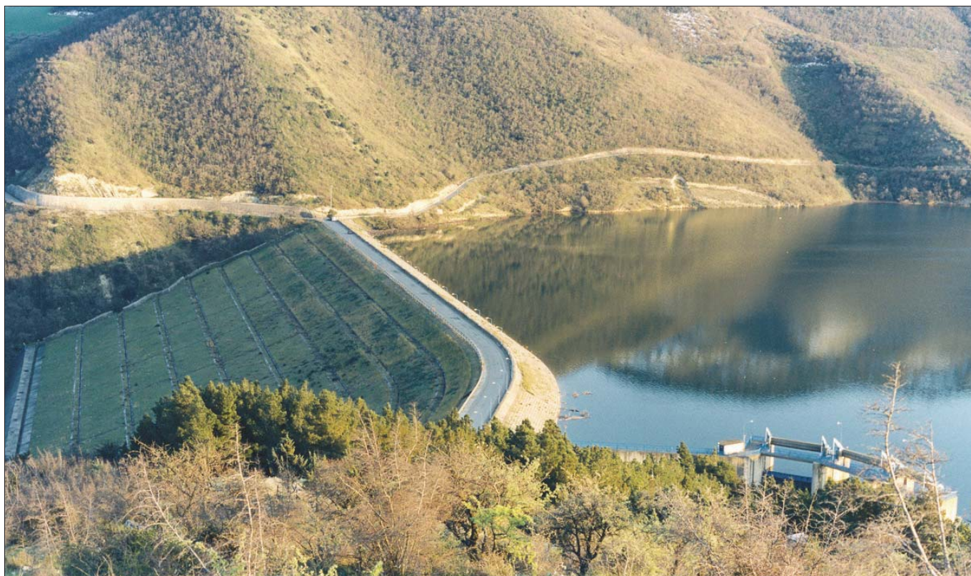
Figura 2 – Paramento di valle, coronamento ed invaso di una diga in terra
