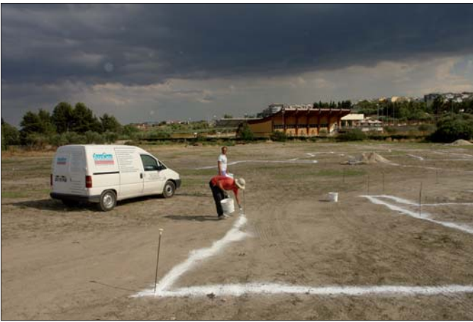
Figura 7 – Tracciamento delle cavità su aree non urbanizzate mediante picchettamento topografico
