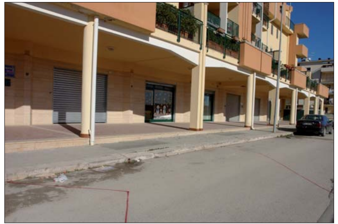
Figura 8 – Tracciamento delle cavità su strada mediante picchettamento topografico
