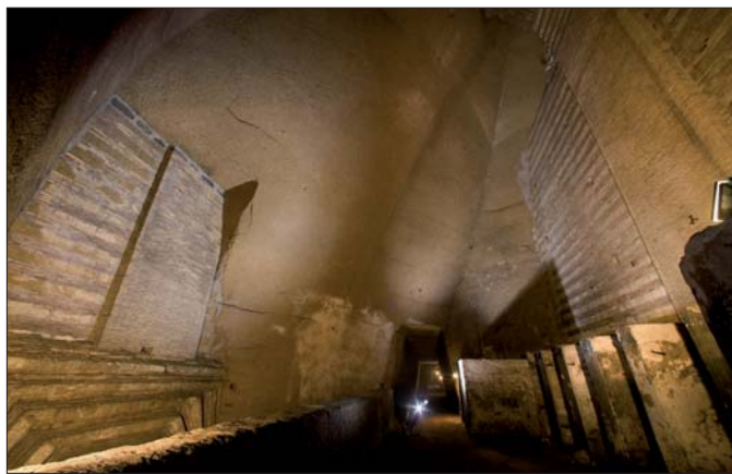
Figura 8 – Ponte di attraversamento di una cisterna dell'acquedotto del Carmignano
