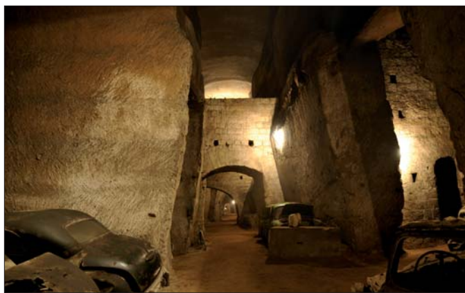
Figura 7 – Archi in conci di tufo e laterizi realizzati per il contenimento delle pareti laterali
