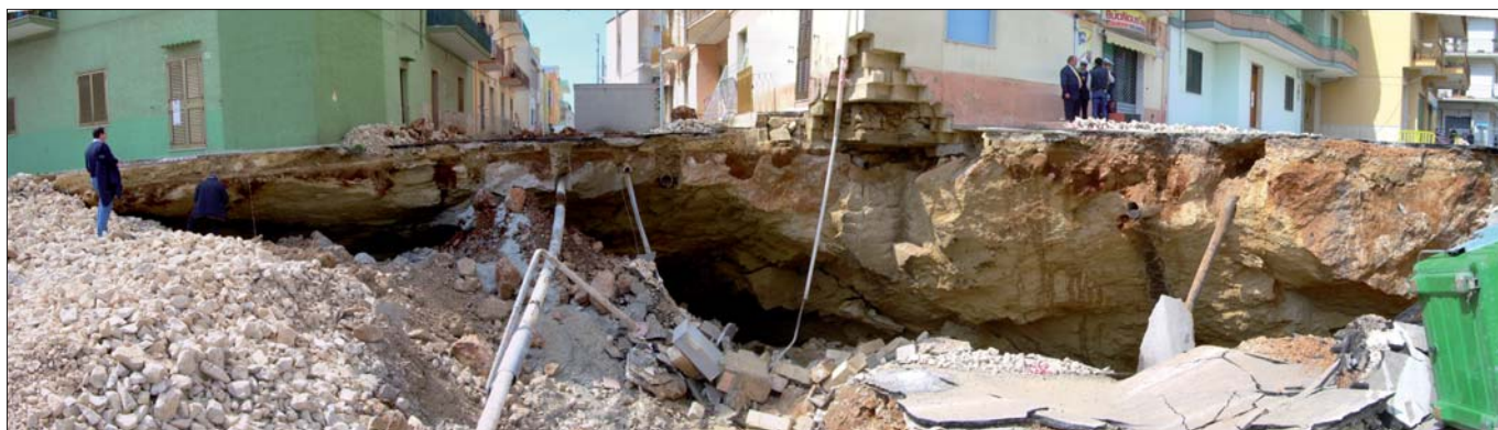
Foto 2 – Gallipoli (LE), calotta della cavità sezionata dai sottoservizi messi in evidenza da crollo via Firenze (2007)
