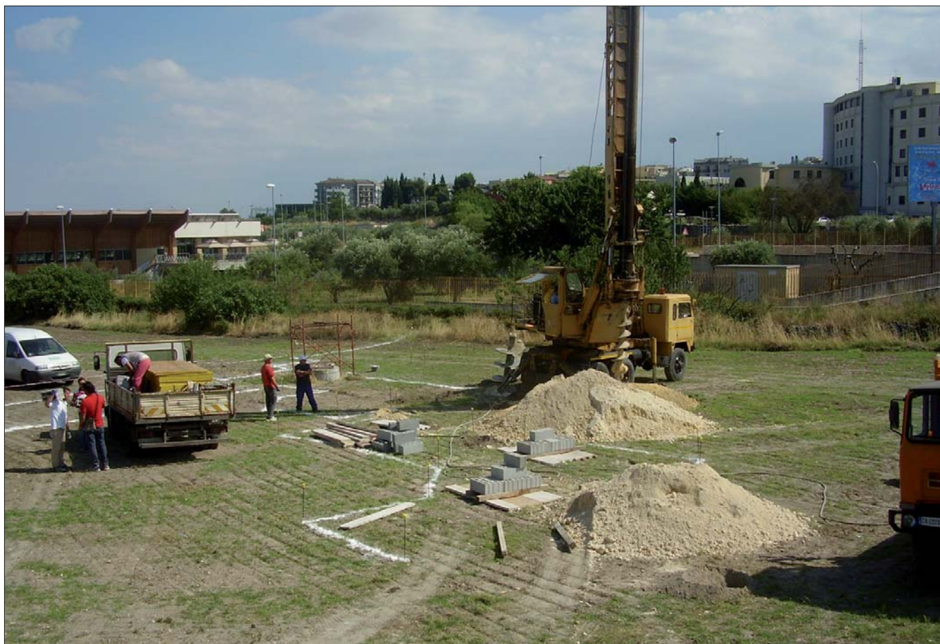
Figura 4 – Tracciamento del contorno delle cavità in superficie finalizzato all'ubicazione dei fori per l'iniezione della miscela
