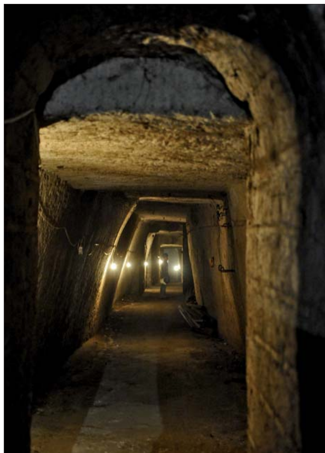
Figura 10 – Riduzione della sezione dello scavo nel tratto terminale della galleria
