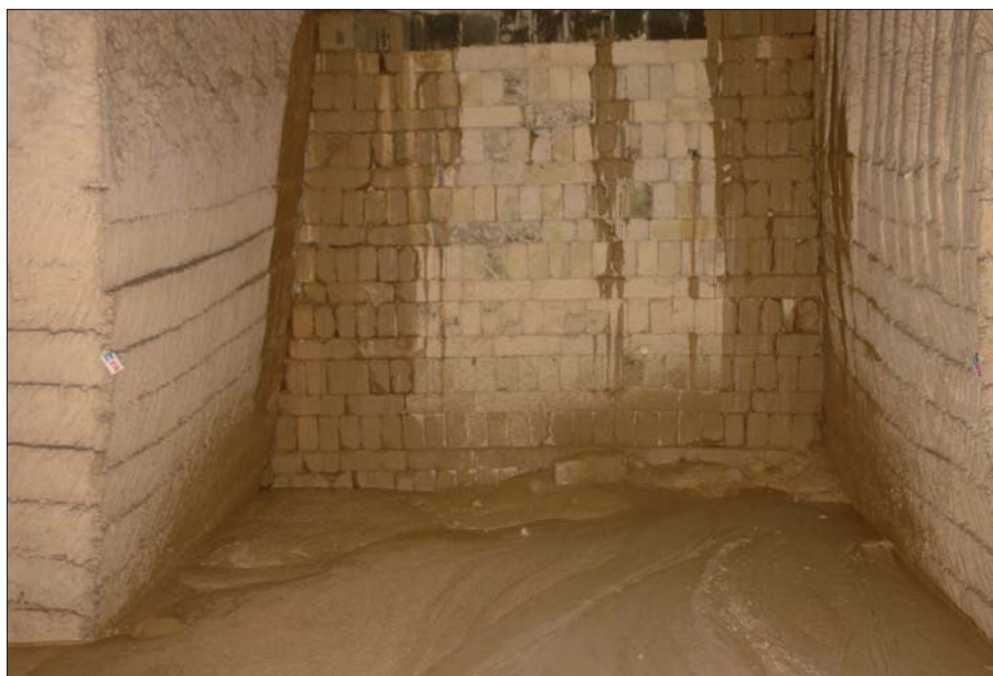
Figura 15 – Realizzazione di sbarramento mediante conci di calcarenite
