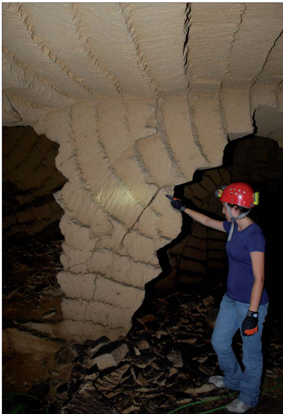
Foto 2 – Gallipoli (LE), calotta della cavità sezionata dai sottoservizi messi in evidenza da crollo via Firenze (2007)
