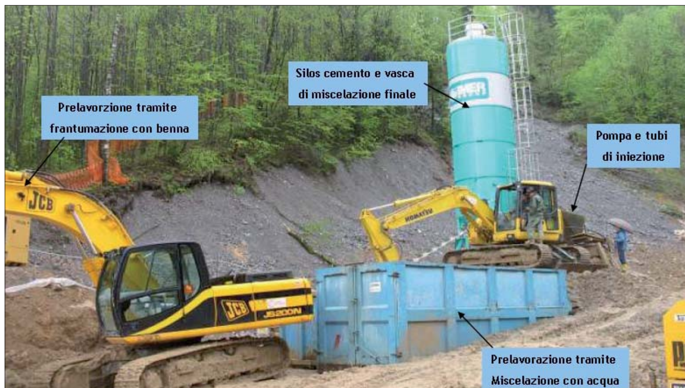
Figura 7 – Impianto di cantiere
