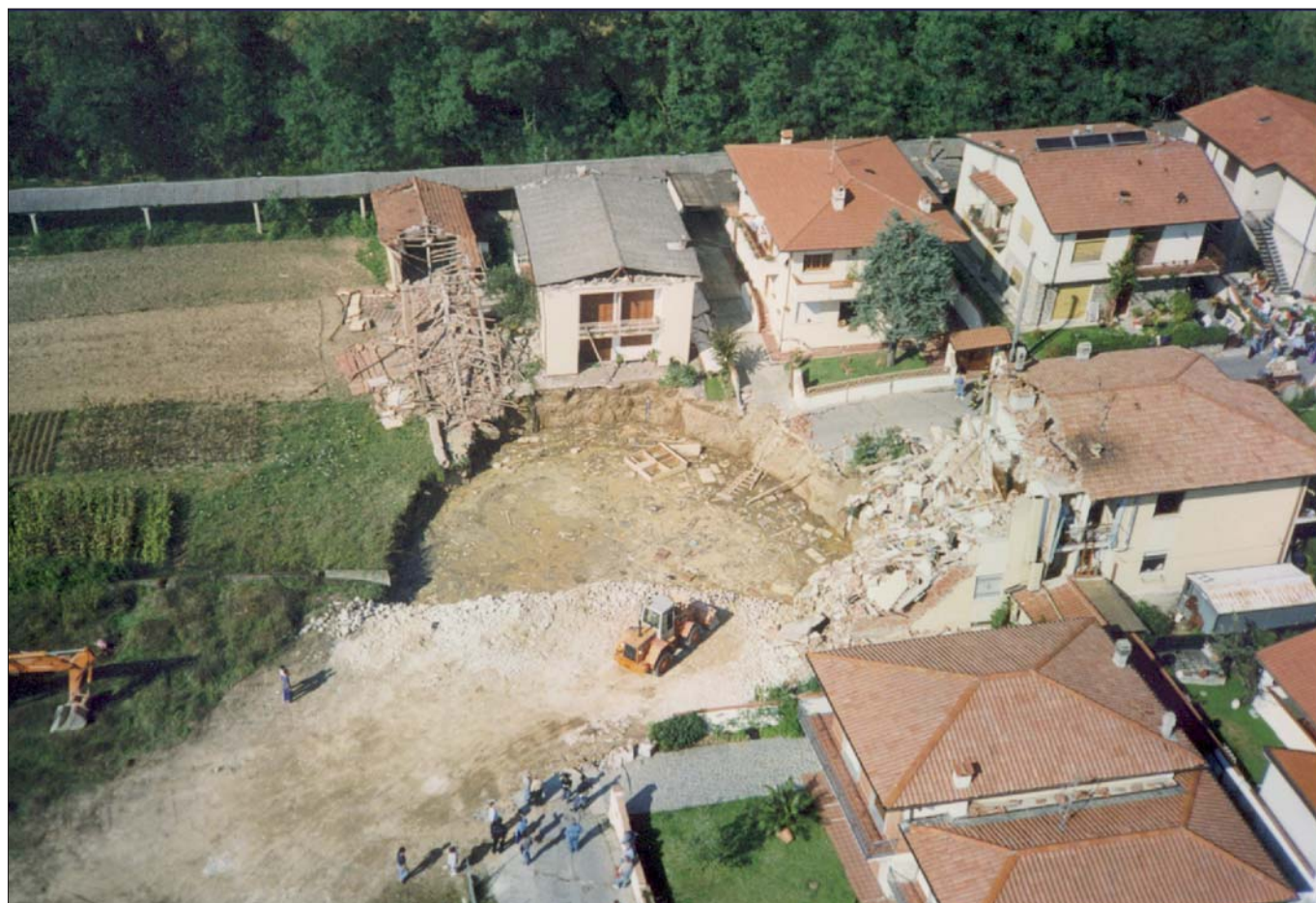
Foto 2 – Operazioni di colmamento della "voragine"
