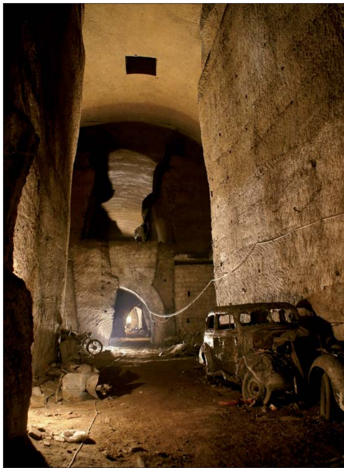
Figura 6 – Raddoppiamento dell'altezza della sezione della galleria legato all'abbattimento del diaframma in tufo che separava lo scavo da un cunicolo preesistente
