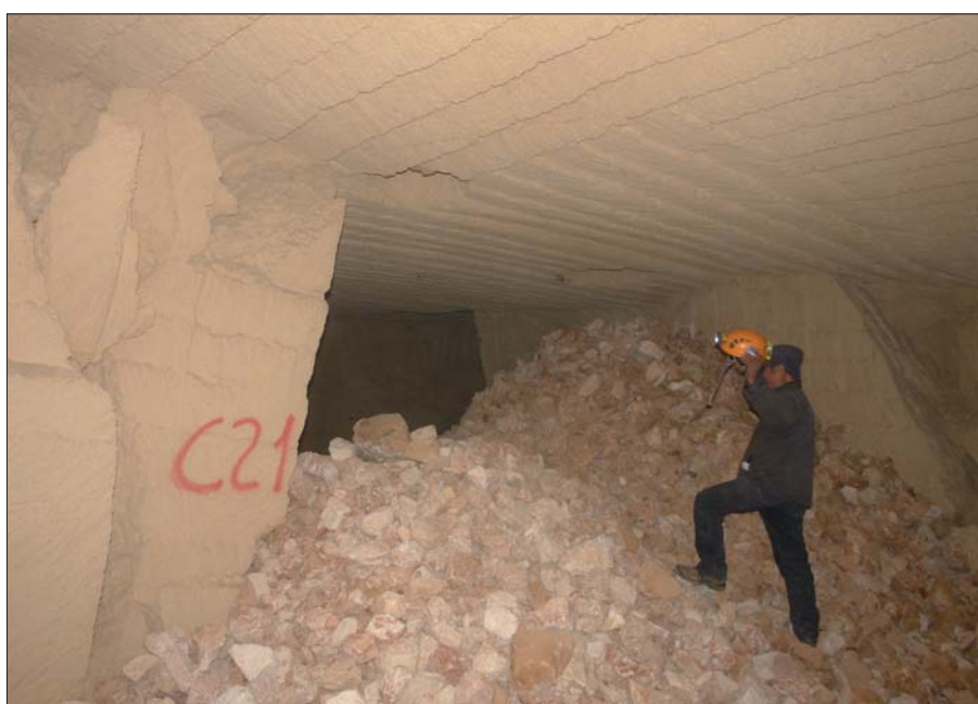
Figura 16 – Realizzazione di sbarramento mediante cono detritici – fase iniziale
