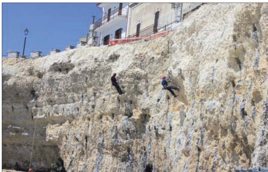
Figura 12 – Esecuzione in acrobatico dei lavori di finitura dei placcaggi con barre in acciaio inox
