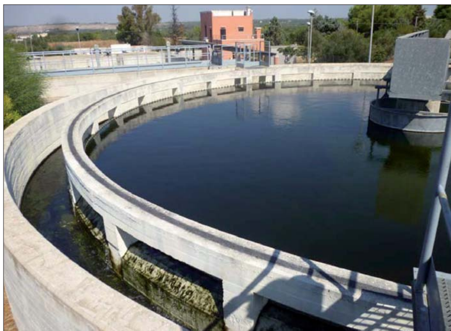
Figura 1 – La vasca per il trattamento secondario (chiariflocculazione) delle acque reflue gestito dall'Acquedotto pugliese (AQP) a Gallipoli (Le)
