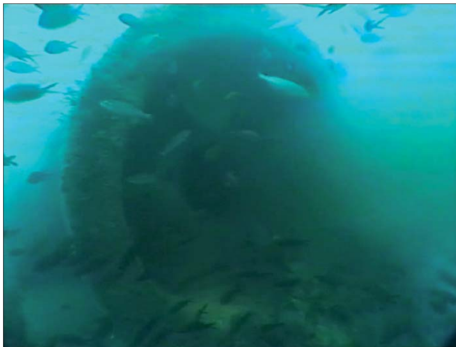
Figura 5 – Bocca terminale della condotta sottomarina che smaltisce in mare le acque reflue del depuratore di Bari Orientale. Studi del clima meteomarine e delle correnti nella zona sono stati condotti dallo scrivente (si veda Mossa, 2006)
