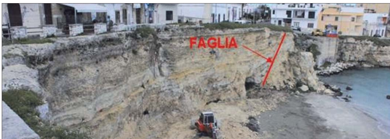
Figura 11 – Veduta della falesia dopo i lavori di risagomatura con l'indicazione di una significativa faglia
