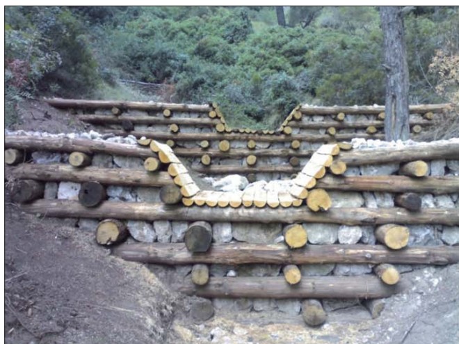
Figura 8 – A sinistra, Consorzio di Bonifica Montana del Gargano: briglie in legname pietrame e, a destra, Consorzio di Bonifica Montana del Gargano: palificata viva
