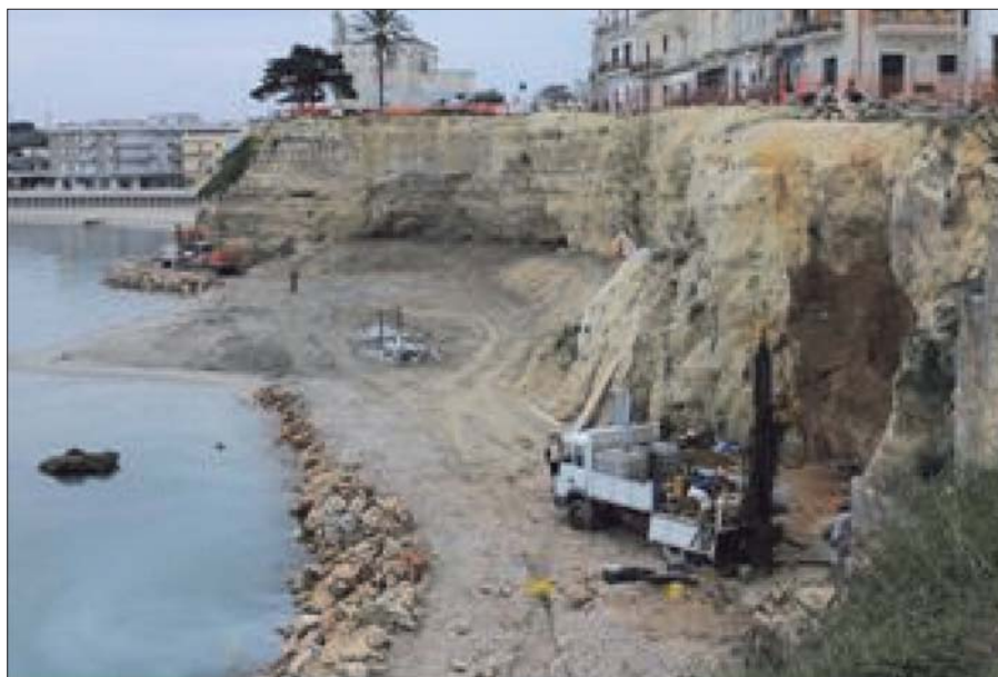
Figura 17 – Esecuzione di un sondaggio S5 attraversante la cavità
