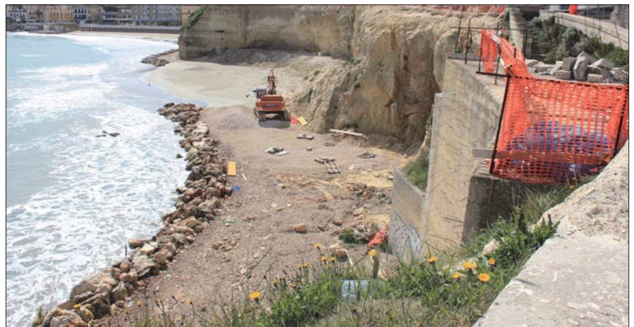
Figura 2 – Vista da Nord a Sud della falesia di Otranto, nel tratto già scavato nel corso dei lavori di risanamento della falesia, compreso tra la Chiesa Madonna d'Altomare (sotto la palma) e zona Punta
