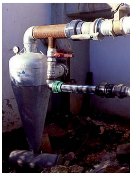
Figura 3 – Filtro a 'idrociclone', per la separazione delle particelle più grossolane presenti nell'acqua per l'irrigazione
