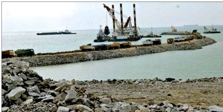
Figura 4 – Un esempio di costruzione di una diga foranea
