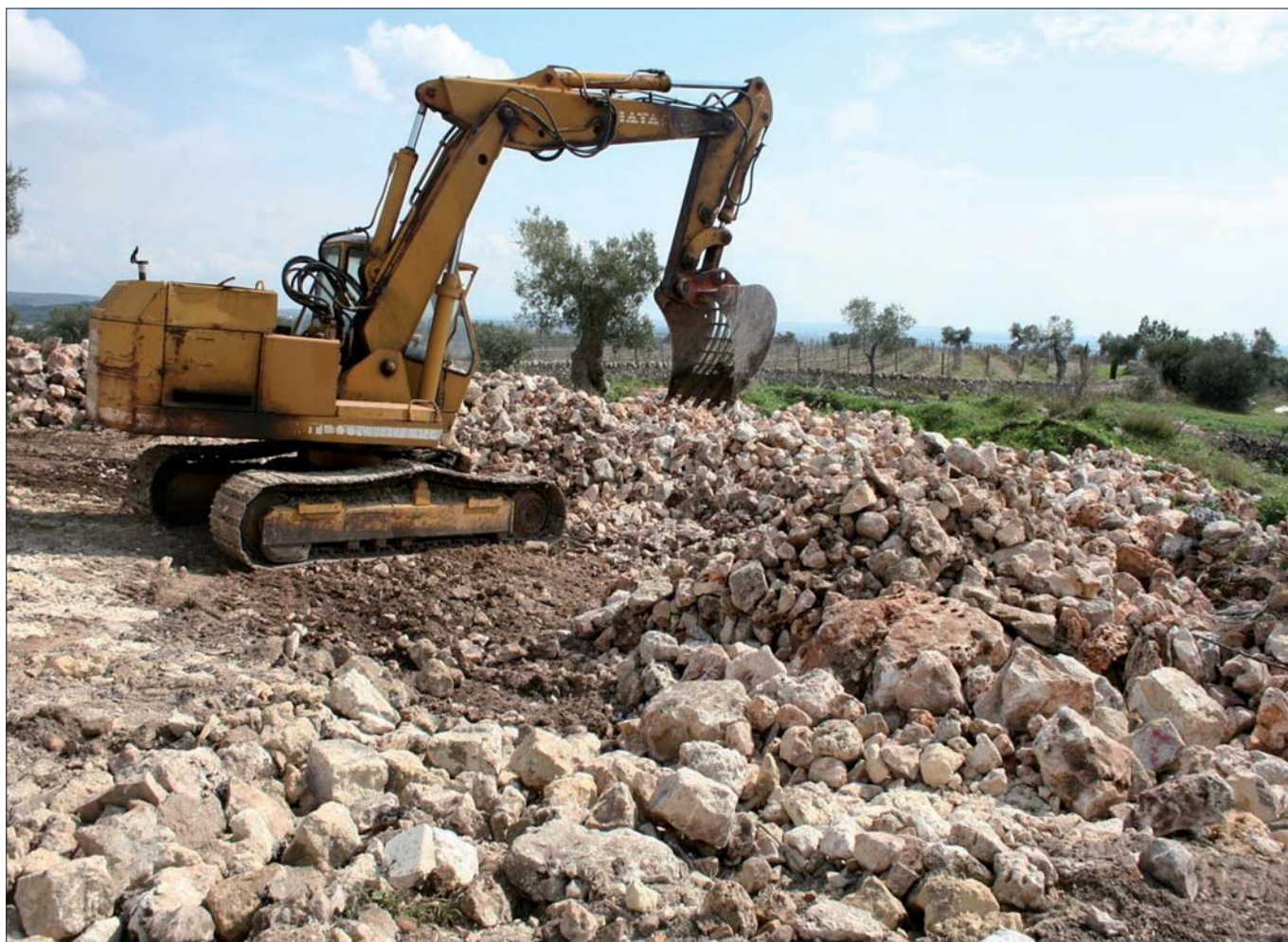
Figura 12 – Opera di sbancamento presso la Masseria L'Amastuola (Crispiano - Ta).
