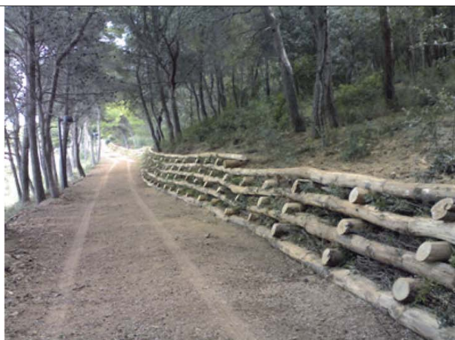
Figura 8 – A sinistra, Consorzio di Bonifica Montana del Gargano: briglie in legname pietrame e, a destra, Consorzio di Bonifica Montana del Gargano: palificata viva
