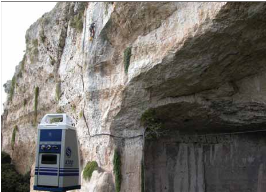
Figura 5 – Operazioni di rilievo in parete
