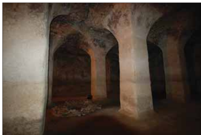
Figura 6 – Interno della cisterna con evidenziazione delle campate suddivise dai pilastri
