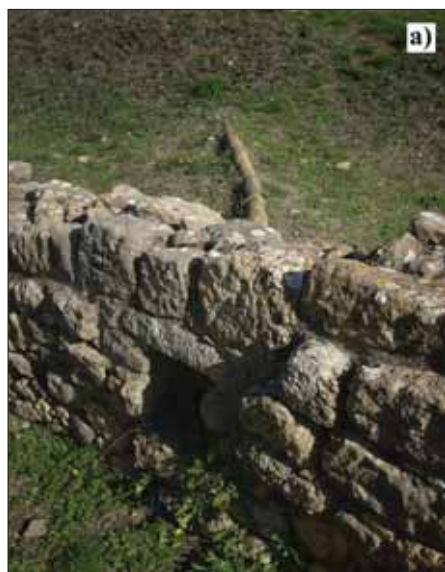
Figura 14 – a) Condotta d'adduzione che conduceva l'acqua del troppo pieno del bacino esterno della Fontana Monumentale al serbatoio del Macellum; b) Particolare del serbatoio del Macellum con resti dell'intonaco a tenuta idraulica, nella parte bassa delle pareti di NE.
