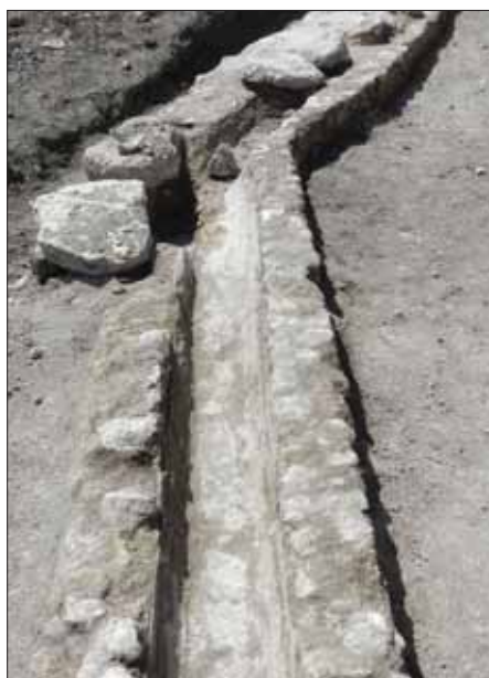
Figura 13 – Particolare della canalizzazione in cui è visibile una delle curve per dare pendenza.
