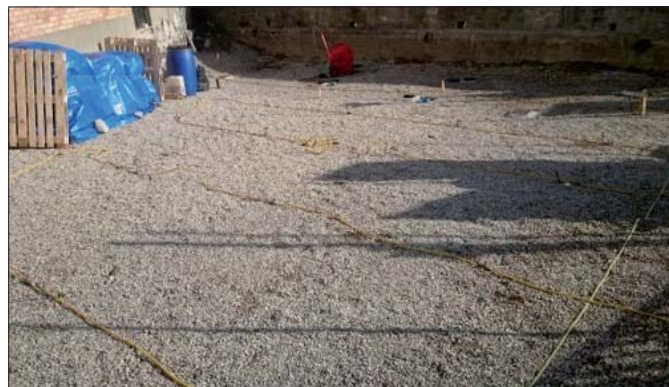
Figura 7. Stendimento degli elettrodi di superficie
