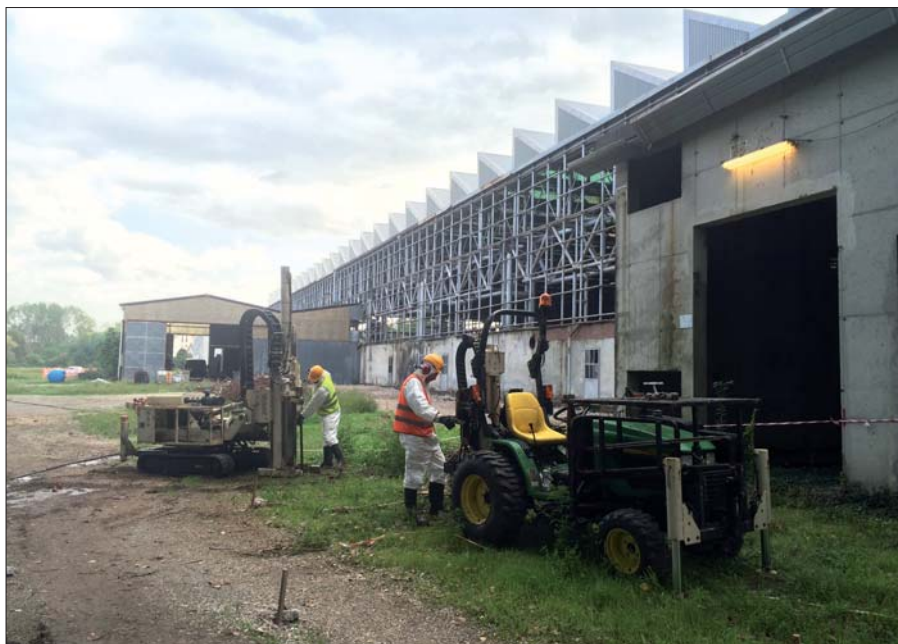
Figura 5. Iniezioni direct-push sul sito mediante due Geoprobe in lavoro in parallelo
