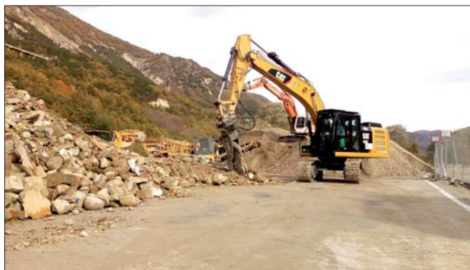
Figura 3. Pinzatura preliminare
