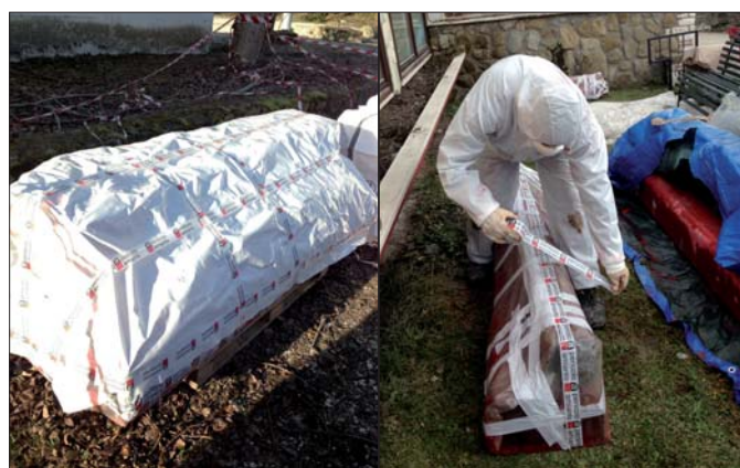
Figura 17. Confezionamento e rimozione
