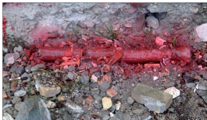
Figura 15. Messa in sicurezza
