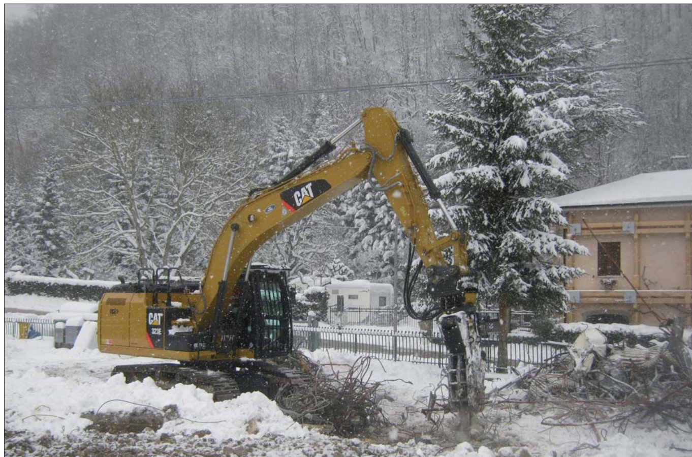
Figura 20. Separazione ferro sul luogo di intervento
