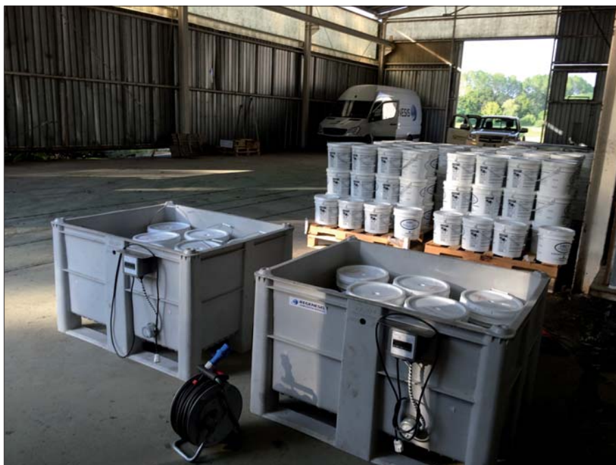
Figura 3. Attività di pre-riscaldamento dei prodotti HRC®
