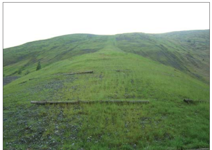
Figura 9 (a,b). Discarica lato Corio, versante di discarica: modificazioni del territorio a seguito della messa in sicurezza delle superfici
