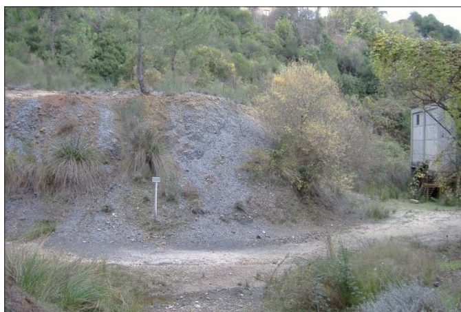
Figura 6. Vista 1 dell'accumulo, con la stazione di sollevamento dell'acquedotto
