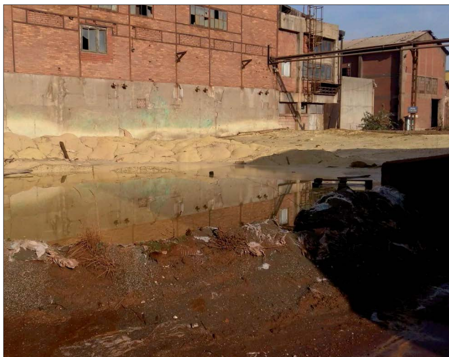
Figura 2. Sali precipitati di PbAg in un bacino di contenimento danneggiato nello stabilimento di Zorka - Obojena Metalurgija a Šabac [Picture by Marco Falconi]
