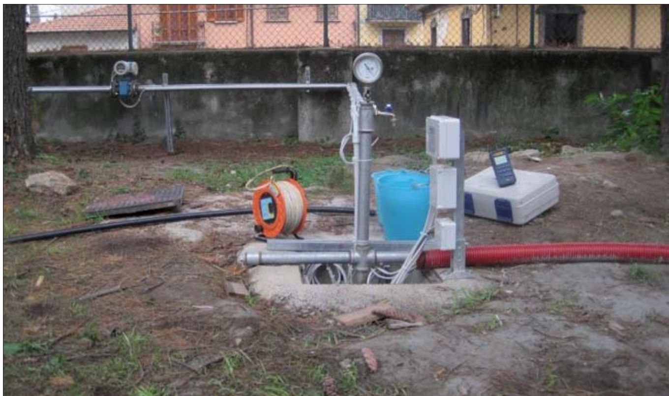
Figura 17. Particolare di iniezione tramite piezometro
