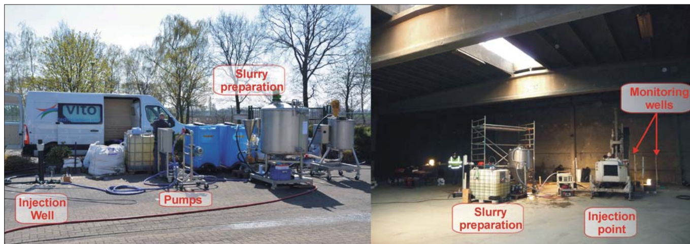
Figura 7. Setup per l'iniezione pilota del Caso 1 (destra) e Caso 2 (sinistra)
