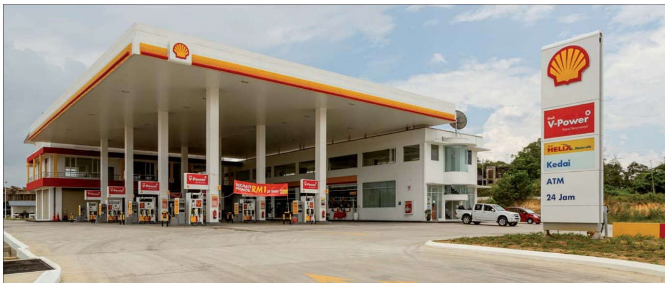
Figura 2. Area di servizio autostradale
