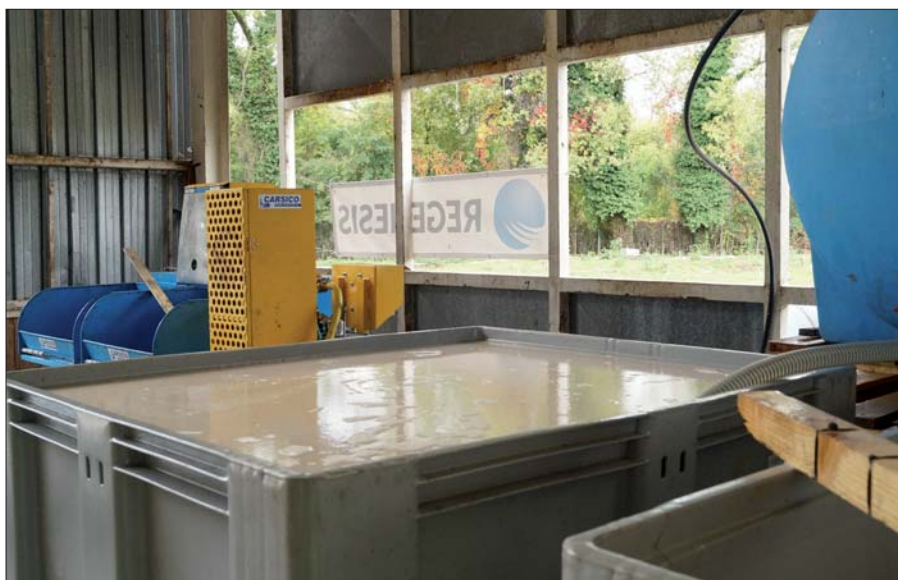
Figura 4. Attività di formazione della microemulsione micellare di 3D-Microemulsion® prima dell'iniezione
