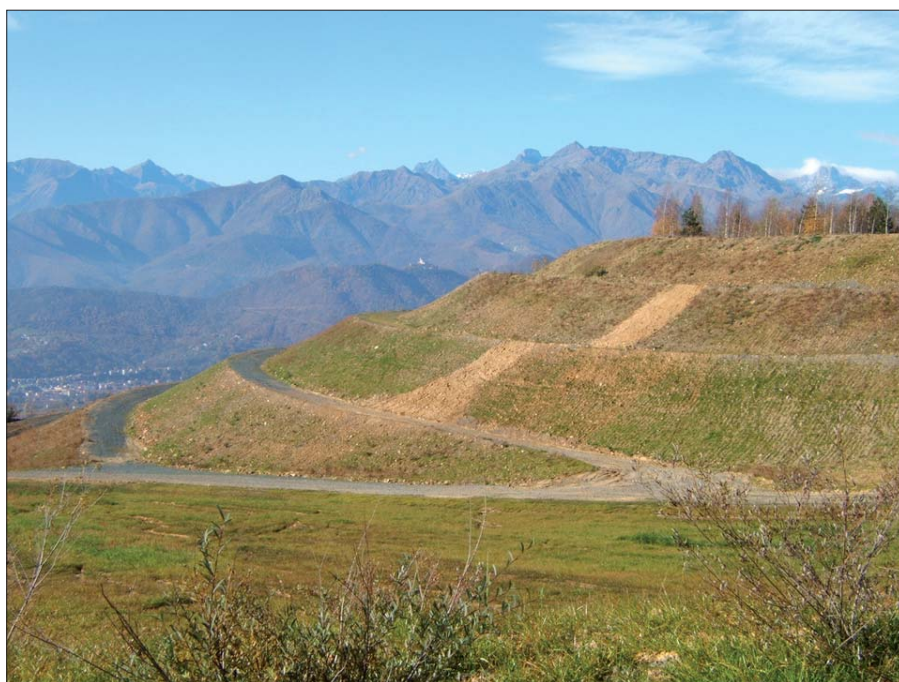
Figura 5 (a,b,c). Discarica lato Balangero: modificazioni del territorio a seguito della messa in sicurezza delle superfici
