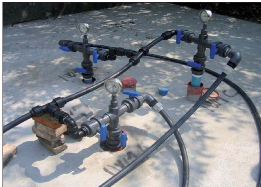
Figura 9. Particolare dei punti di iniezione
