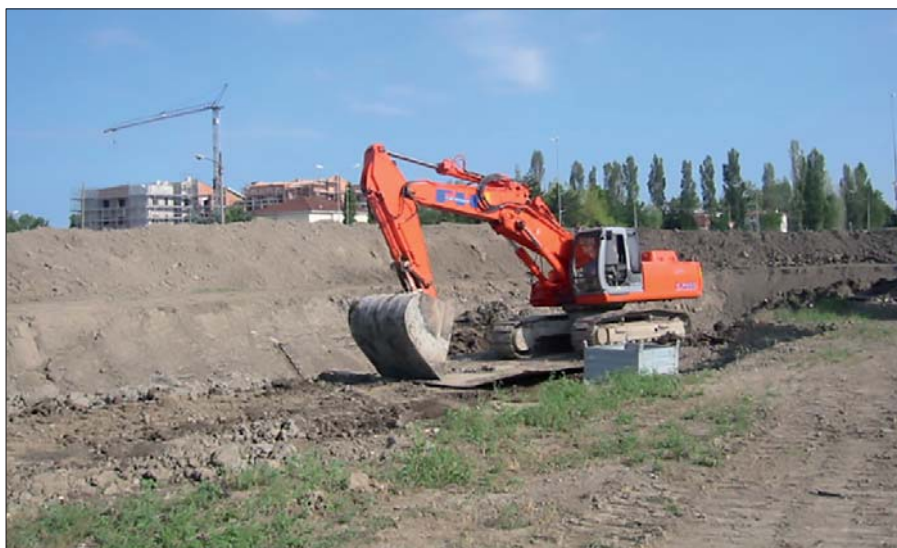
Figura 24. Trincee di scavo
