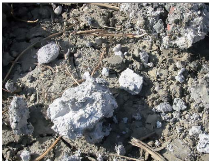
Figure 23. Evidenti residui materiali isolanti di amianto friabile frammisto al terreno
