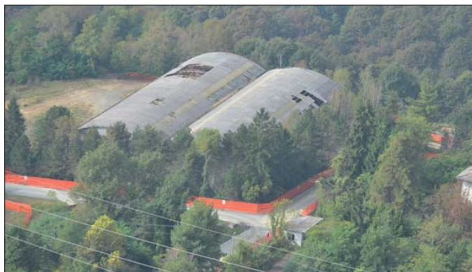
Figura 10 (a,b). Bonifica di un ex edificio industriale mediante rimozione di copertura e tamponamenti in cemento-amianto
