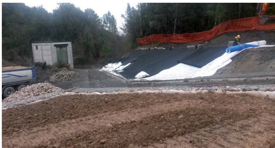
Figura 14. Posa materiali di copertura (gennaio 2014)
