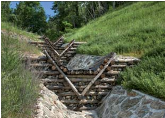
Figura 8 (a,b). Opere in legname e cemento e pietrame per la regimazione delle acque di versante
