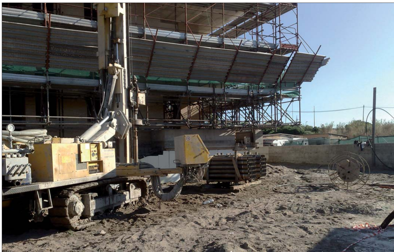
Figura 13. Posizionamento della macchina perforatrice
