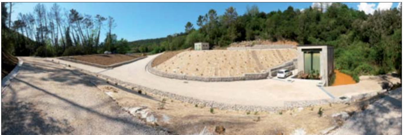
Figura 18. Vista da S-SE stato finale dei luoghi (sulla dx la sala pompe, mentre in alto, al centro, è visibile la cabina elettrica), ancora in fase di rifinitura superficiale. Osservando le piste in stabilizzato e la sala pompe, si nota il piano campagna rialzato
