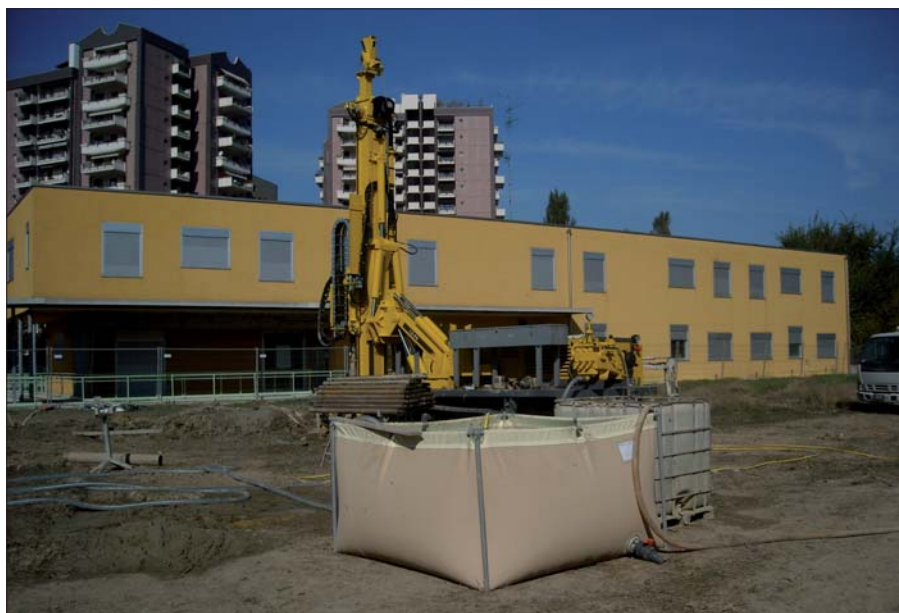
Figura 12. Approntamento del cantiere per la realizzazione del campo sonde
