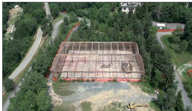
Figura 10 (a,b). Bonifica di un ex edificio industriale mediante rimozione di copertura e tamponamenti in cemento-amianto
