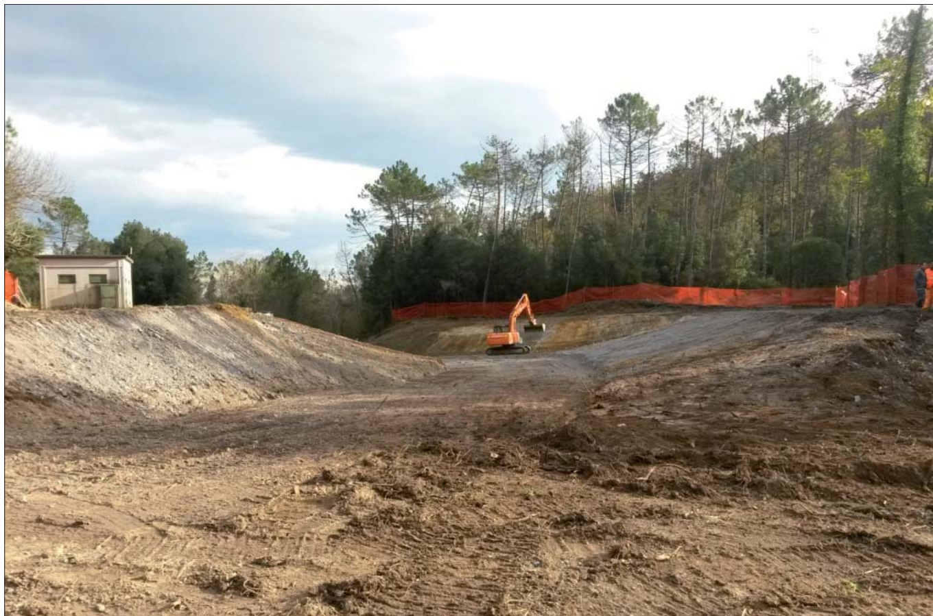
Figura 9. Pulizia e riprofilatura porzioni accumulo (a sx la cabina elettrica)
