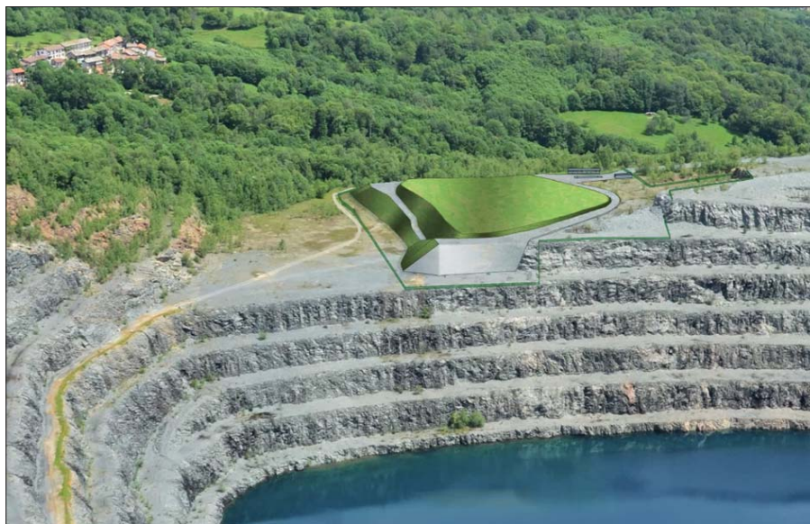
Figura 12. Realizzazione di un volume confinato per il conferimento dei rifiuti derivanti dall'attività di bonifica
