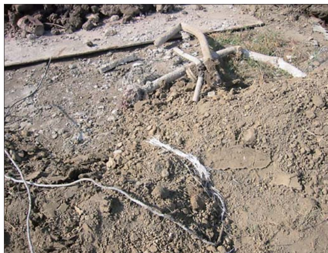
Figura 15. Residui di RCA friabili sparsi sul suolo
