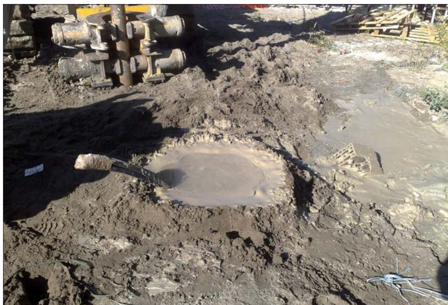
Figura 14. Cementazione della sonda geotermica con malta cementizia
