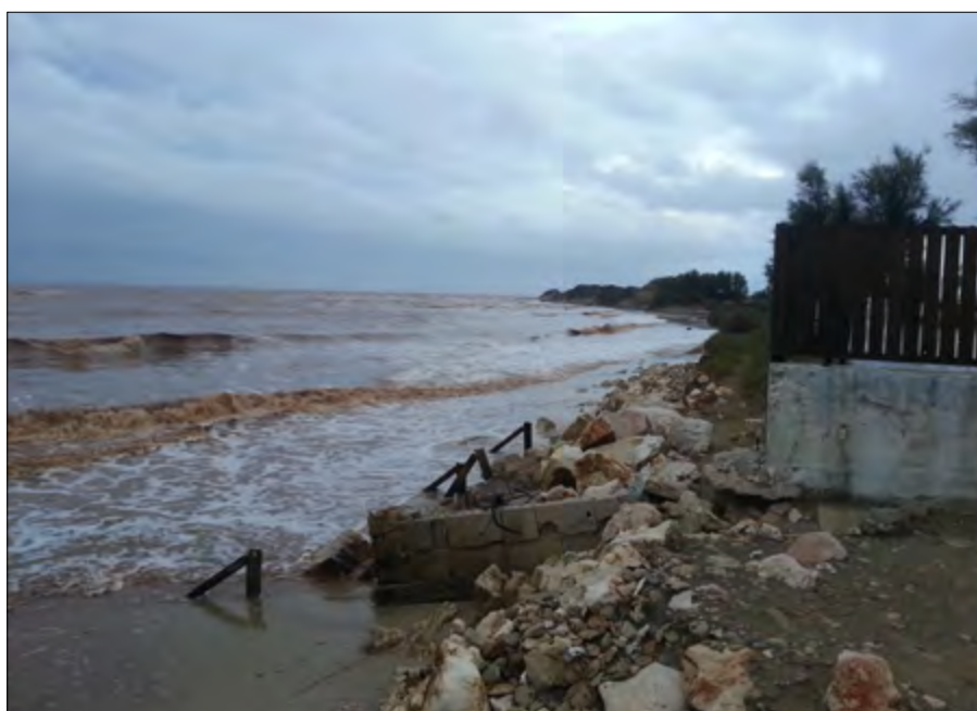
Figura 15. Interventi di protezione costiera inutile e dannosi lungo l'insenatura di Torre Canne - Torre San Leonardo (Fasano - Ostuni, Brindisi)
