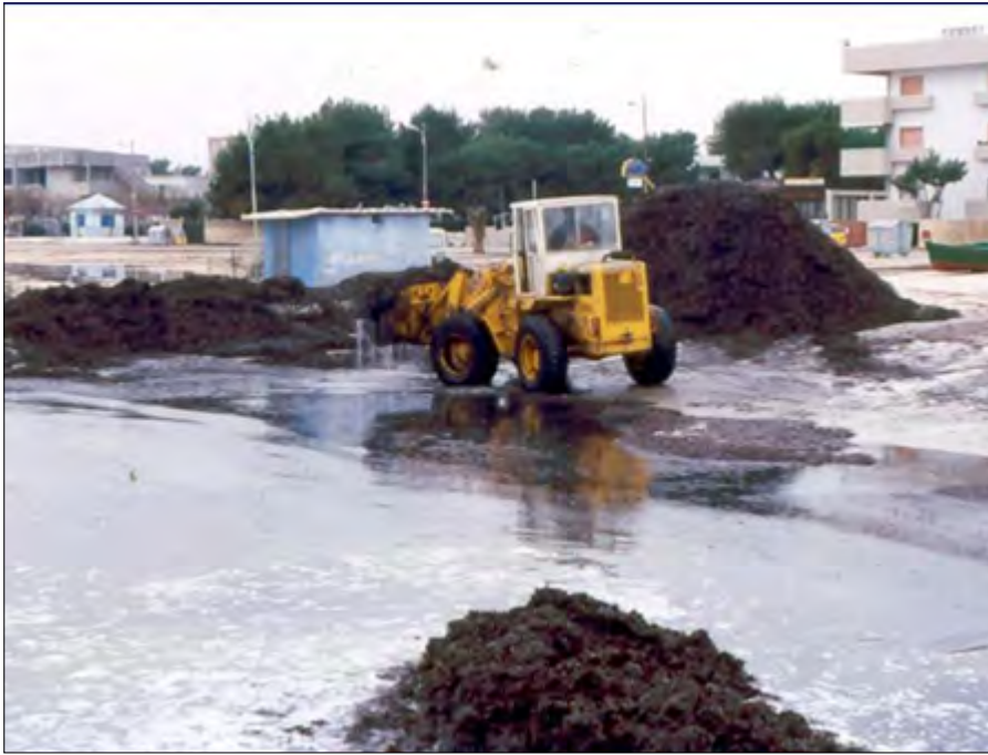
Figura 17. Asportazione di biomassa rappresentata da foglie di Posidonia oceanica ed elevate quantità di sabbia dal porto di Torre Canne (Fasano, Brindisi)
