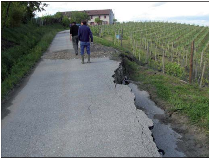
Figura 7 – Esteso fenomeno franoso su un versante a debole pendenza presso Castagnole Lanze (aprile 2009).
