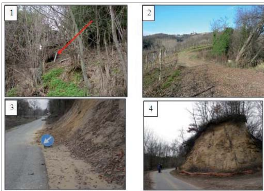
Figura 14 – Esempi dei fattori predisponenti nei casi di dissesto censiti. 1: scarico tubazioni direttamente nel pendio; 2: presenza di vegetazione d'alto fusto; 3: caratteristiche litologiche scadenti; 4: elevata acclività del versante
