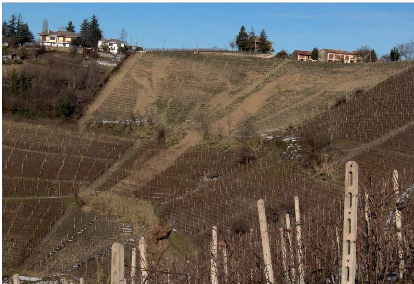
Figura 3 – Frane per saturazione e fluidificazione della coltre superficiale presso Calosso (dicembre 2008).
