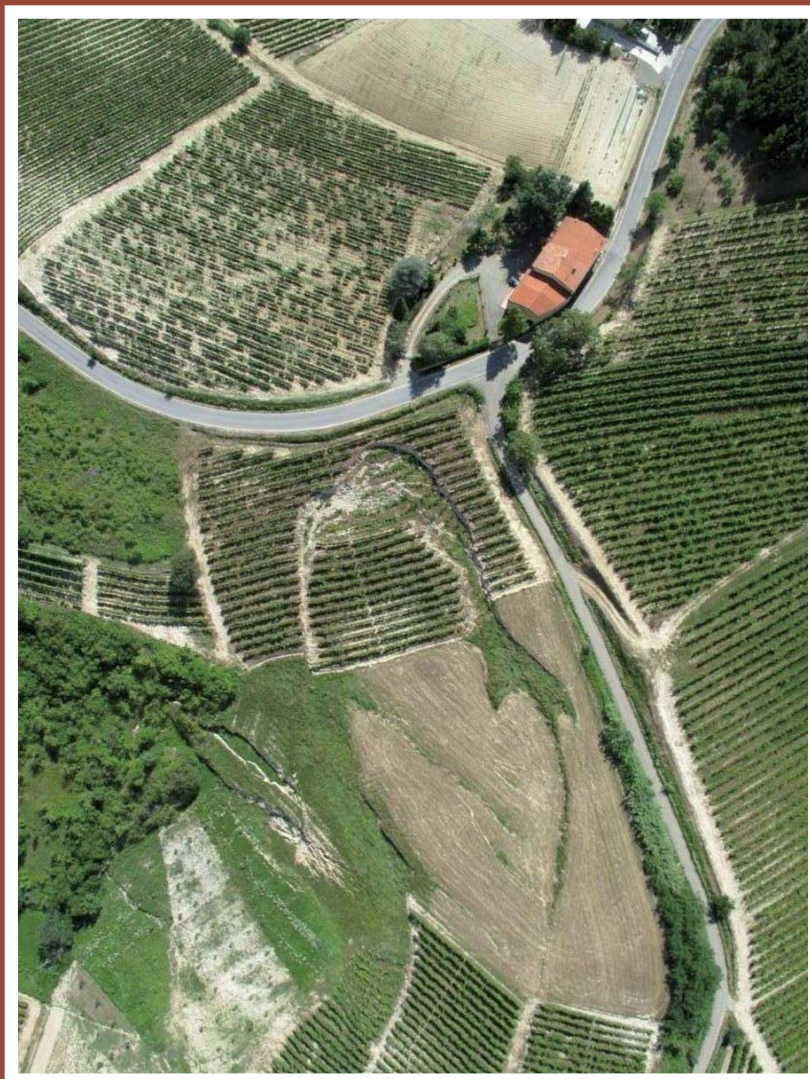
Scivolamento rototraslazionale a seguito degli eventi meteorologici dell'aprile 2009 nelle colline del Piemonte. Comune di Castel Rocchero (AT). Rilievi a cura della Regione Piemonte
