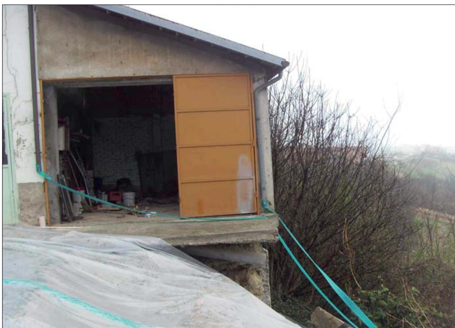
Figura 13 – Scarichi di gronda dispersi sul terrapieno asportato dalla frana di Celle Enomondo (marzo 2011).
