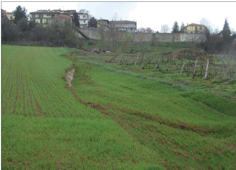
Figura 15 – Vista da valle verso monte della frana di San Marzano Oliveto (marzo 2011).
