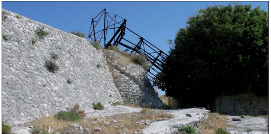
Figura 9 – Traliccio reclinato
