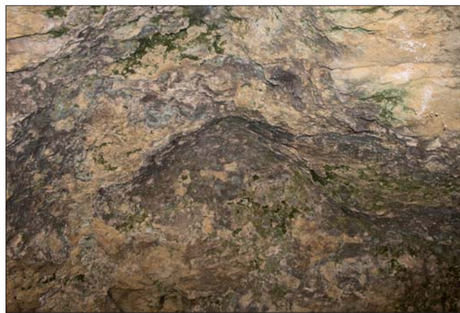
Figura 6 – Versante Sud, particolare dell'incavo sul soffitto, Ingrottato IV
