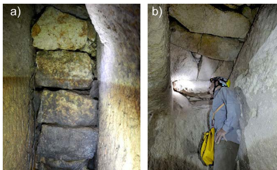
Figura 13 – Trincea integrale, a sinistra, e trincea pensile, a destra (Foto A. Bixio)
