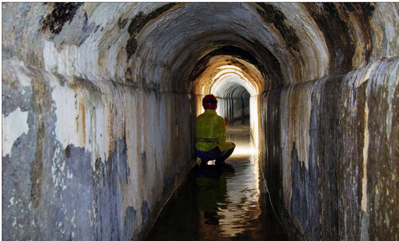
Figura 6 – interno del condotto del ramo di Santa Fiora (Foto C. Germani)
