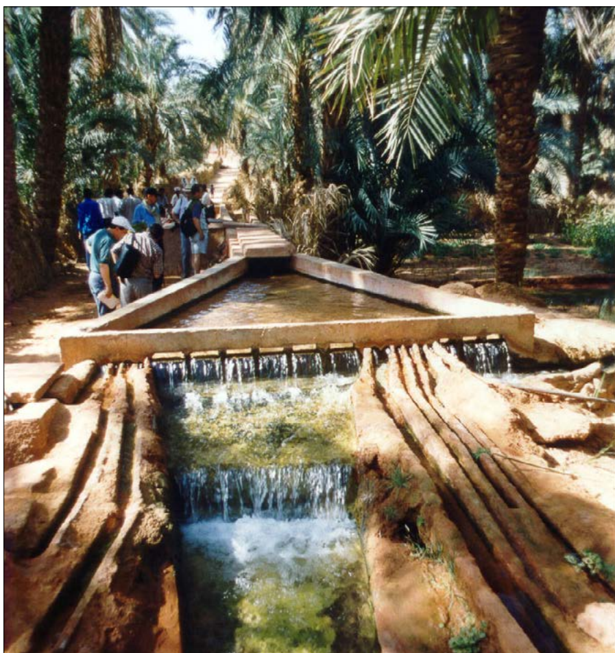
Figura 12 – Ripartitore (kesria) dell'acqua di una foggara di Adrar
