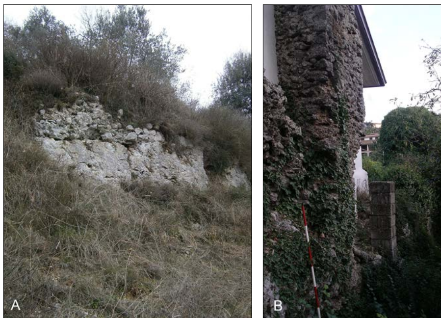
Figura 5 – A) Costa Veggiano (Vico nel Lazio): ben visibile il muro in opera incerta dello speco che, per mantenere la pendenza costante, si imposta su uno sperone di roccia affiorante appositamente regolarizzato (foto A. Valchera 2015). B) Bivio di Colleparado, località Porpuro (Alatri): resti del muro continuo, rinforzato da contrafforti, che sosteneva il condotto in pressione del “sifone 1” nel settore del venter tra il ponte-canale sul fiume Cosa e quello sul torrente Porpuro (foto R. Torre 2010)
