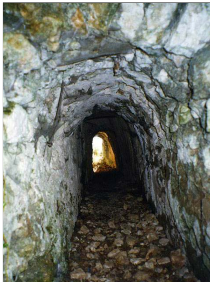
Figura 9 – Cunicolo acquedotto Santalucia, Pozzilli
