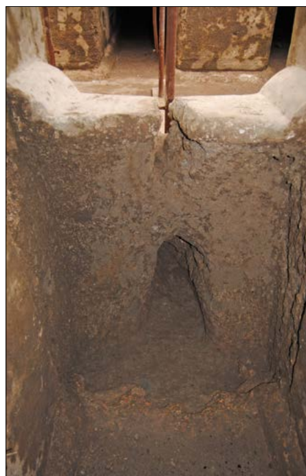
Figura 16 – Cisterna a pettine, galleria 2 muretto (foto ASSO)
