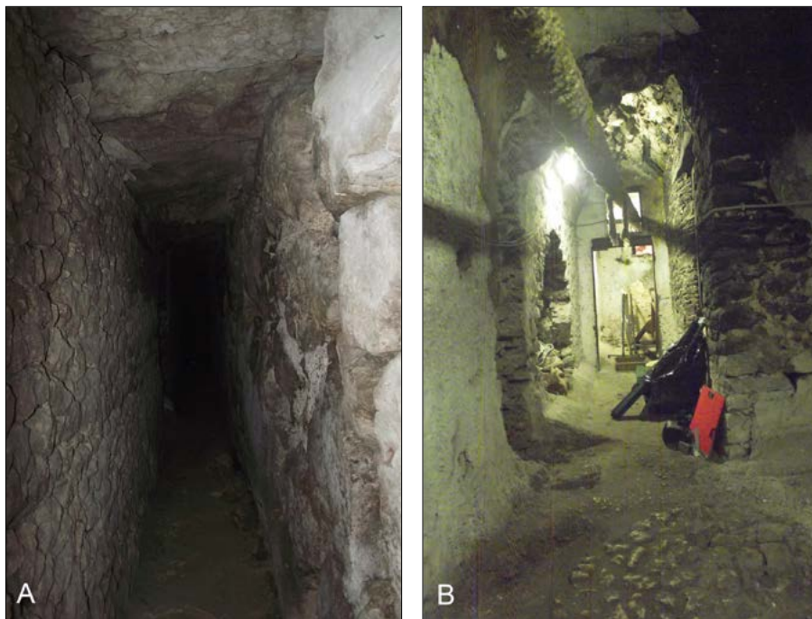
Figura 8 – A) Il corridoio di risulta tra il basamento in opera poligonale (a dx nella foto) e il muro in opera incerta delle cisterne (a sin nella foto); in alto si notano i lastroni di copertura in calcare. B) Le cisterne in opera incerta, a pianta rettangolare; in basso a destra resti del cordolo in cocciopesto
