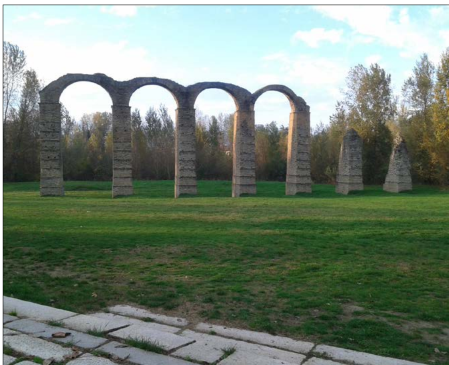
Figura 5 – Struttura in rilievo per l'attraversamento del F. Bormida (Foto C. Caviglia)
