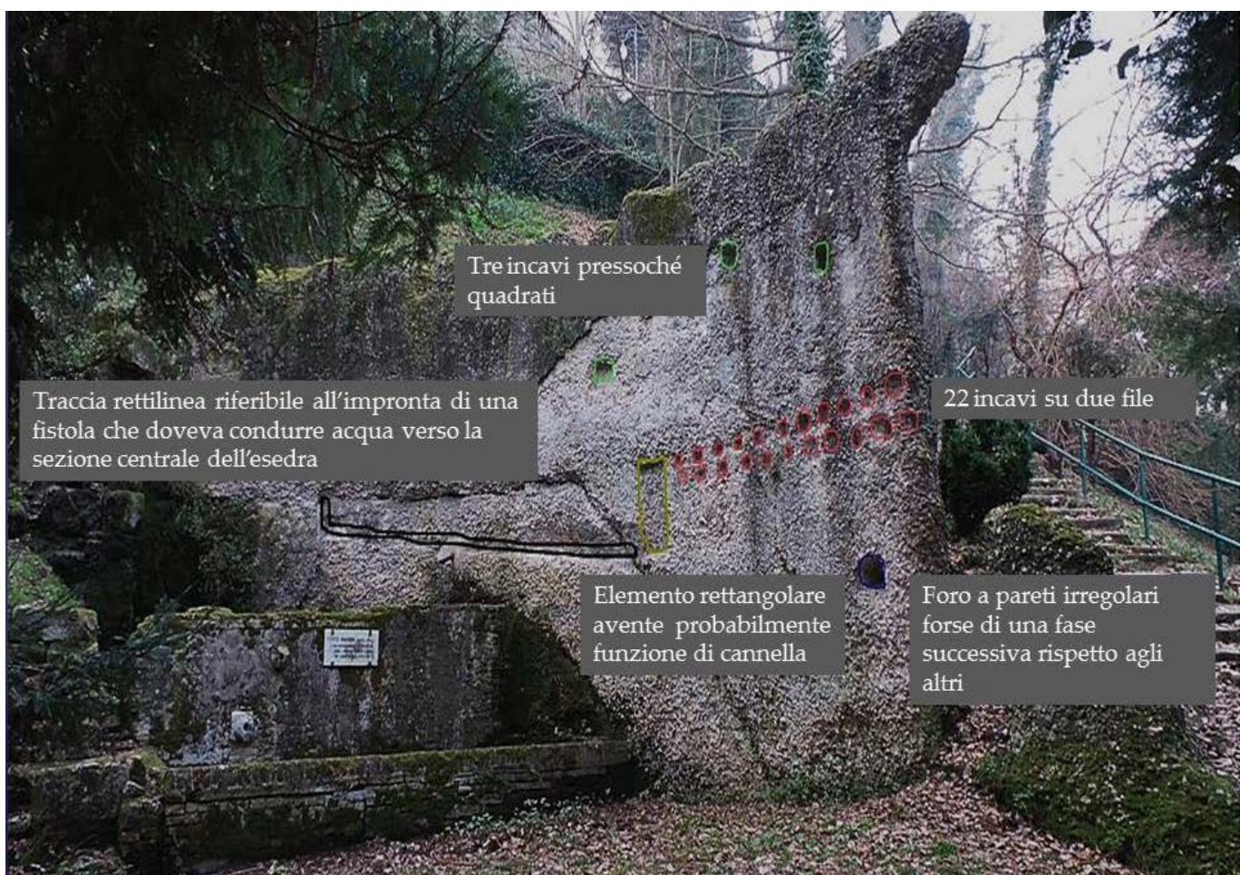
Figura 7 – Osimo: Fonte Magna. Nelle foto sono contraddistinti i diversi componenti del complesso della fonte
