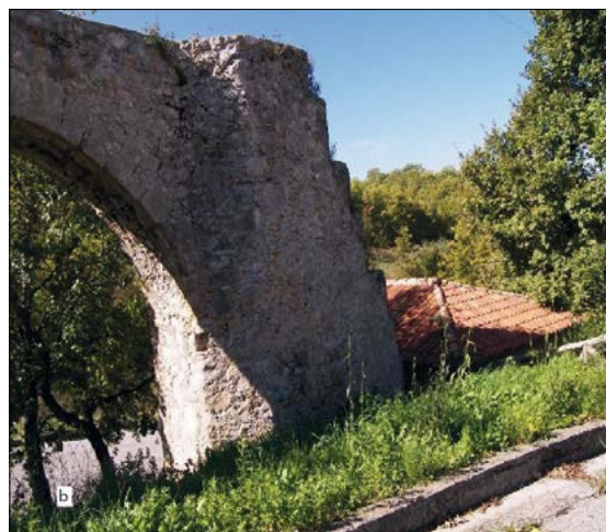
Figura 7 – (a) Condotta ad archi che alimentava il Mulino ad acqua di San Carlo, (b) torre a base poligonale che convogliava le acque dalla condotta al mulino
