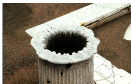
Figura 1 – Vera di pozzo in cui sono visibili i solchi prodotti dall'uso delle corde di sollevamento, Pompei, Casa del Poeta Tragico (Foto: L. Lombardi)
