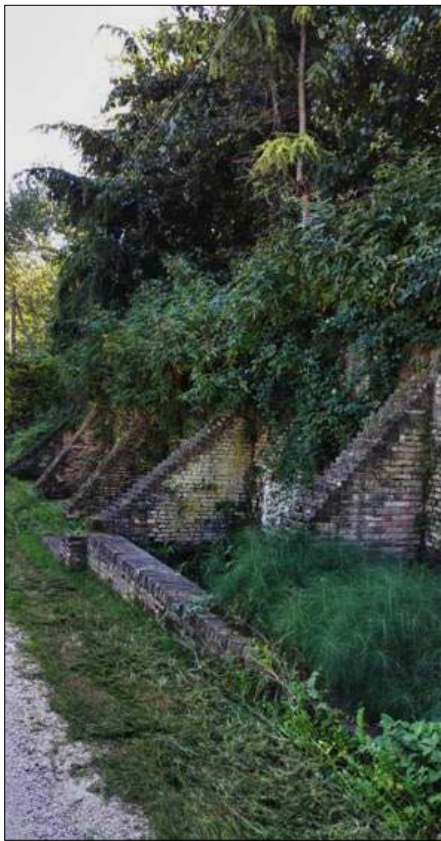
Figura 6 – Osimo: Fonte del Tesoro, a sinistra, piccola fonte senza nome, al centro, e fonte dell'Acquaviva, a destra. La fonte del Tesoro è costituita da 5 vasche e due sorgive. Realizzata con laterizi allettati di piatto e maltati, è stata evidentemente rimaneggiata nel corso dei secoli. L'acqua filtra dalle murature, mentre i condotti alloggiati nella struttura risultano intasati. Le acque stagnanti contenute nelle vasche risultano fortemente invase da vegetazione. A pochi metri di distanza tra i rovi esiste un'altra fonte, realizzata sempre in laterizi, con un accesso ad arco a tutto sesto e volta a botte, con fondo absidato e due ali ricavate lateralmente, una ad arco ribassato e l'altra con arco a tutto sesto. La fonte dell'Acquaviva infine, su cui è stata apposta una lapide commemorativa del restauro, è stata realizzata in laterizi ed è caratterizzata da linee curve che ne determinano il profilo delle vasche e di tutta la struttura. Nel disegno di Mattioli Benvenuti si osserva la presenza di una seconda fonte dell'Acquaviva completamente rimaneggiata nel tempo
