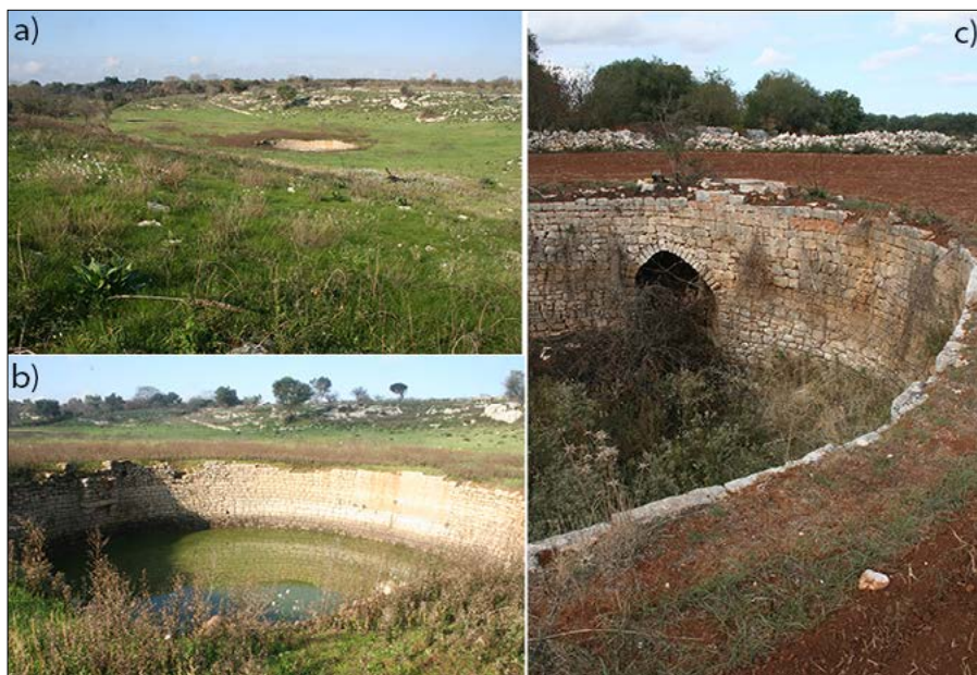
Figura 4 - Strutture idrauliche nel territorio di Ceglie Messapica (provincia di Brindisi): depressione di forma allungata, con presenza di ampie strutture per la raccolta dell'acqua (A), e dettaglio (B); C) particolare di una delle cisterne, con evidenza del canale di arrivo per il deflusso delle acque
