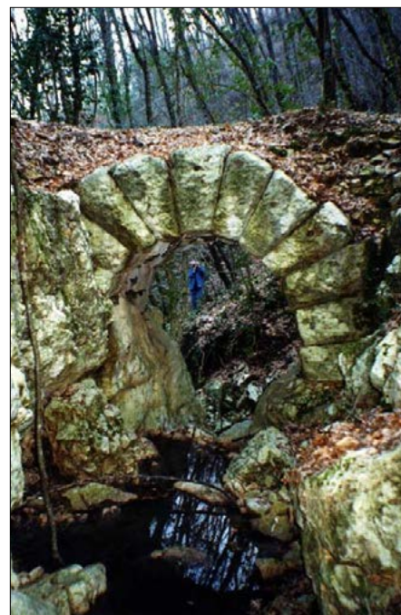
Figura 5 – Il ponte a Montaquila
