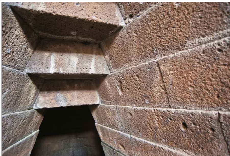
Figura 4 – Paulilatino Gli architravi che coprono la scala che conduce al pozzo
