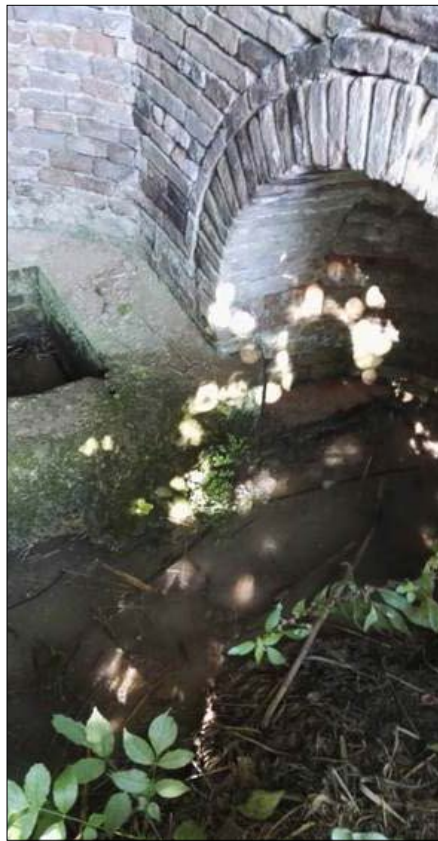
Figura 6 – Osimo: Fonte del Tesoro, a sinistra, piccola fonte senza nome, al centro, e fonte dell'Acquaviva, a destra. La fonte del Tesoro è costituita da 5 vasche e due sorgive. Realizzata con laterizi allettati di piatto e maltati, è stata evidentemente rimaneggiata nel corso dei secoli. L'acqua filtra dalle murature, mentre i condotti alloggiati nella struttura risultano intasati. Le acque stagnanti contenute nelle vasche risultano fortemente invase da vegetazione. A pochi metri di distanza tra i rovi esiste un'altra fonte, realizzata sempre in laterizi, con un accesso ad arco a tutto sesto e volta a botte, con fondo absidato e due ali ricavate lateralmente, una ad arco ribassato e l'altra con arco a tutto sesto. La fonte dell'Acquaviva infine, su cui è stata apposta una lapide commemorativa del restauro, è stata realizzata in laterizi ed è caratterizzata da linee curve che ne determinano il profilo delle vasche e di tutta la struttura. Nel disegno di Mattioli Benvenuti si osserva la presenza di una seconda fonte dell'Acquaviva completamente rimaneggiata nel tempo
