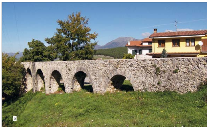
Figura 7 – (a) Condotta ad archi che alimentava il Mulino ad acqua di San Carlo, (b) torre a base poligonale che convogliava le acque dalla condotta al mulino
