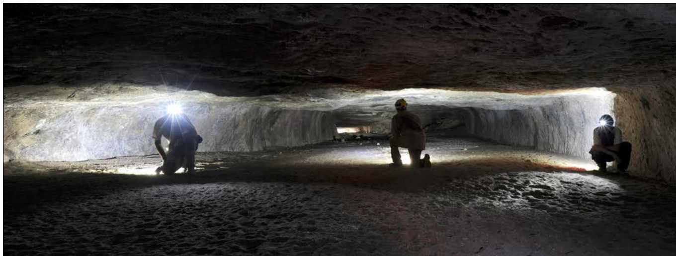
Figura 12 – Sarıhıdır (Cappadocia). Antico by-pass sotterraneo scavato dall'uomo per deviare un tratto del fiume Kızılırmak (Foto A. Bixio)
