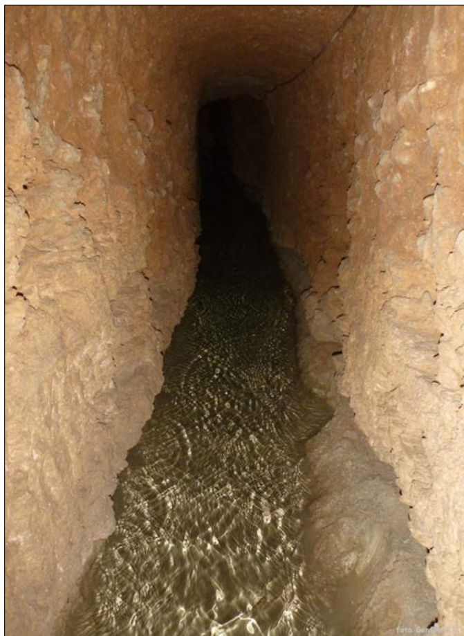
Figura 7 – Frana che chiude il passaggio della galleria
