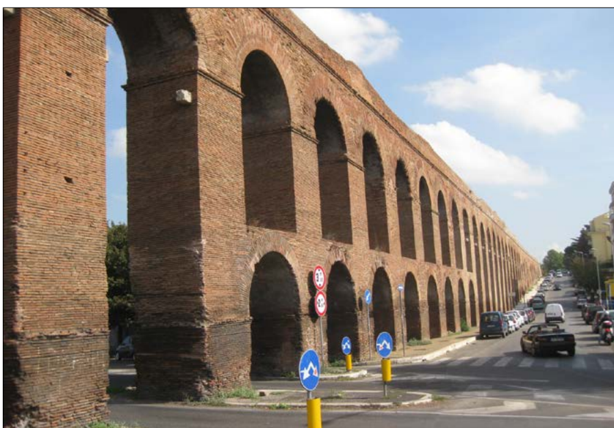
Figura 3 – In Viale P. Togliatti, attraversando la Valle di Centocelle, gli archi sovrapposti raggiungono con 20,65 m la loro massima altezza
