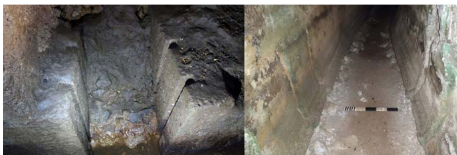
Figura 6 – Scanalature per alloggiamento paratie. Sx acquedotto Fontana (Velletri, Roma) Foto C. Galeazzi; dx acquedotto Marcio (Vicovaro, Roma) Foto M. Parise
