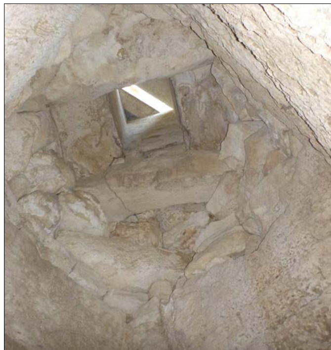
Figura 5 – Vista dal basso di una delle pozzelle
