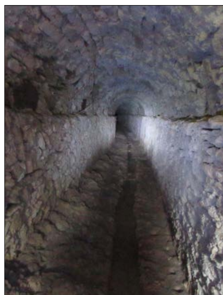
Foto 5 – Cunicolo drenante con canaletta incassata al centro
