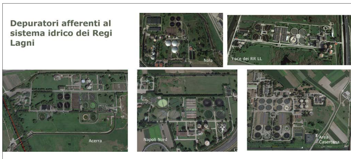
Figura 7 – Depuratori realizzati dalla Cassa per il Mezzogiorno nell'area dei Regi Lagni
