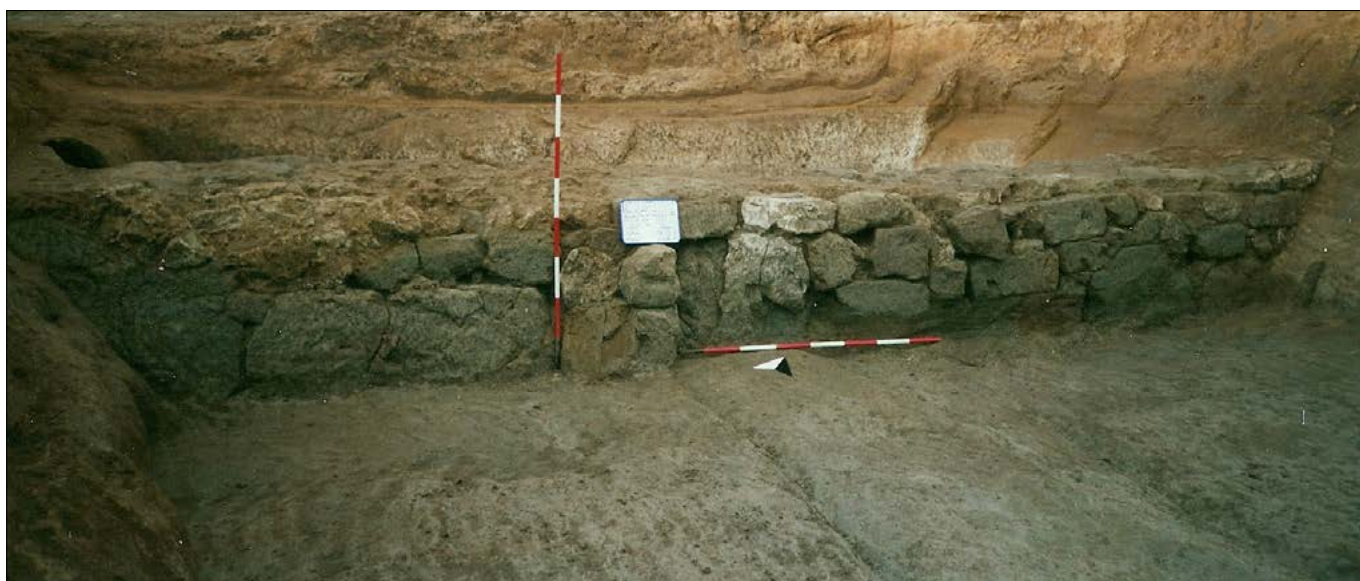
Figura 4 - Particolare del muro divisorio della cisterna A
