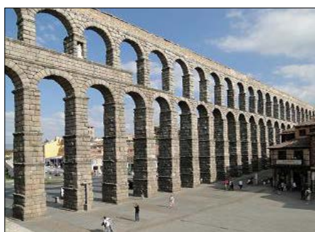
Figura 7 – L'acquedotto di Segovia
