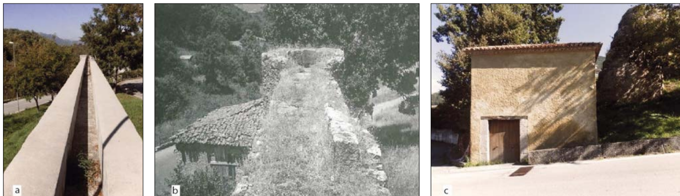
Figura 8 – Mulino San Carlo: canale sopraelevato che convoglia le acque alla torre di raccolta in una ricostruzione attuale (a) e in una foto storica (b) (Masini, 2009); (c) edificio del mulino, le cui pareti sono state ricostruite
