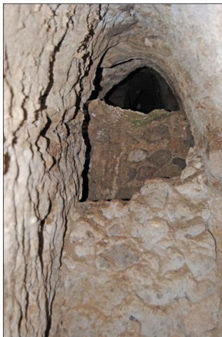
Figura 10 – Intersezione tra C1 e galleria B (foto D.I. Pellandra)
