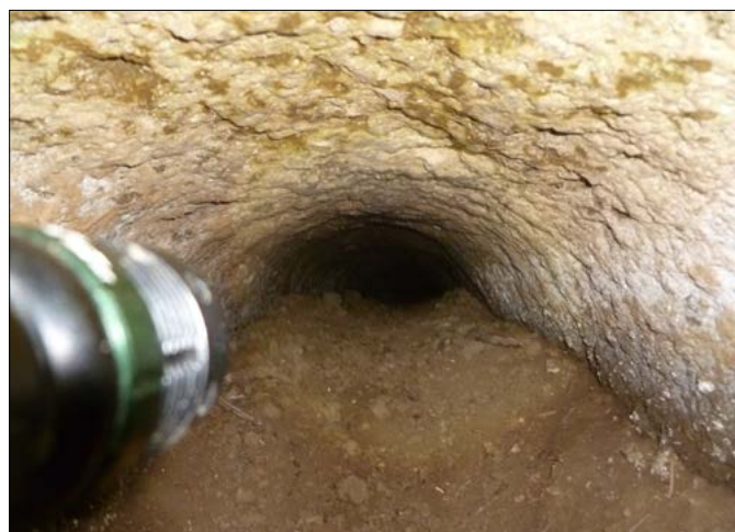
Figura 7 – Interno del cunicolo 2
