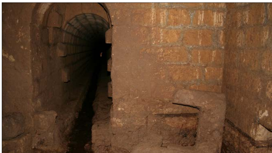
Figura 15 – Tratto sotterraneo del canale di adduzione dell'acquedotto La Signora, Gravina in Puglia
