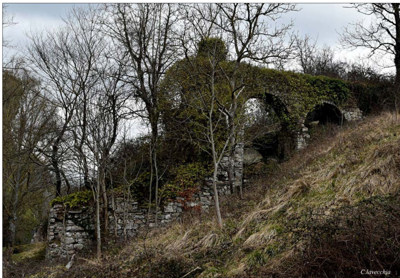
Figura 5 – Canale di derivazione su archi e torre del mulino Sabatella a Brienza (Pz) rinforzata da contrafforti, di fattura distinguibile dalla torre, probabilmente aggiunta in un secondo momento
