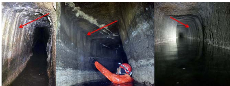
Figura 3 – "Cornici" presenti in diverse strutture idrauliche: sx acquedotto di Palestrina (Roma) Foto L. Casciotti; centro e dx emissario del lago Albano Foto M. Vitelli e V. Puglisi.
