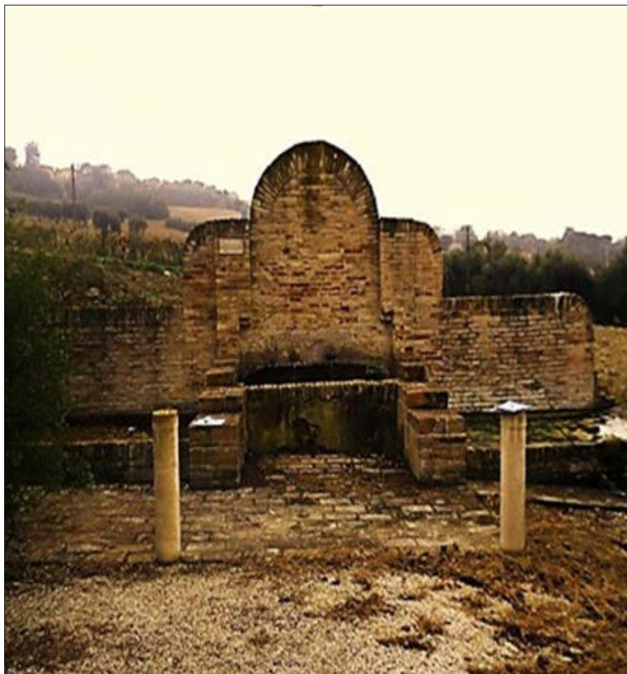
Figura 9 – Castelfidardo: Fonte della Concia, sopra, e Fonte del Gualdo, sotto. La prima ha una struttura realizzata in alzata con laterizi maltati e allettati di piatto in cui sono state ricavate due nicchie con cannella. Le cannelle adducono acqua in un'unica vasca, avente il cordolo in materiale lapideo. A poca distanza si può osservare una vasca quadrangolare incassata nel terreno che, con ogni probabilità, era usata per le operazioni della concia del pellame, come lasciano dedurre i cordoli, sempre in materiale lapideo, opportunamente conformati per tale attività. L'intera area è pavimentata in laterizi. La Fonte del Gualdo è stata realizzata con laterizi maltati ed allettati di piatto in cui la sommità delle murature è in laterizi maltati allettati di taglio in modo da formare un cordolo uniforme. La muratura di fondo ha un profilo singolare, con la porzione centrale, in corrispondenza con la vasca di mezzo, sovrelevata, con un timpano semicircolare, dai quali margini discendono due lesene, che vanno a prolungarsi orizzontalmente a formare le pareti della vasca. Le altre due vasche, adiacenti, sono alimentate da dozzoni che attingono da quella centrale, facenti funzione di sfioratori di quest'ultima. Osservando la fonte frontalmente si può notare come la vasca di destra abbia i cordoli posti ad una minor altezza rispetto a quella posta a sinistra, verosimilmente per compensare la pendenza del piano campagna. L'area antistante le vasche è parzialmente pavimentata con laterizi allettati di piatto
