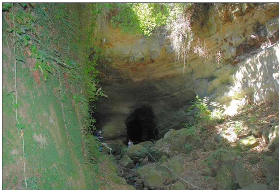
Figura 15 – Ponte Coperto di Cerveteri. Ingresso di monte, crollato in epoca indeterminata per non meno di una decina di metri (Foto W. Dragoni)
