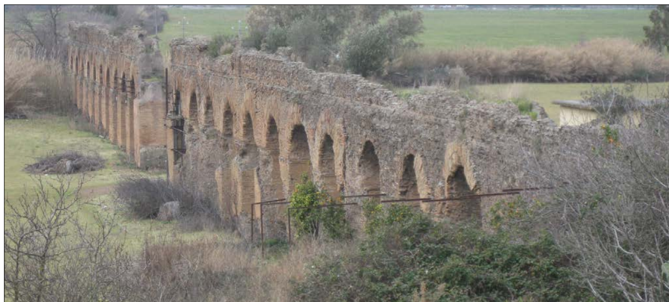
Figura 1 – Sul terreno della Tenuta della Mistica, a pochi passi del G.R.A., si trova un altro ponte che conserva in parte lo specus
