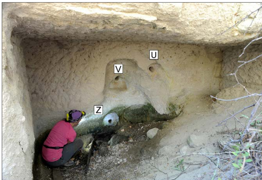
Figura 10 – Cunicolo-cisterna "Sant'Eustachio". La camera di prelievo a diaframma chiuso con due fori pilota (u - v), nella parte superiore e, sotto, il foro di prelievo (z) (Foto A. Bixio)
