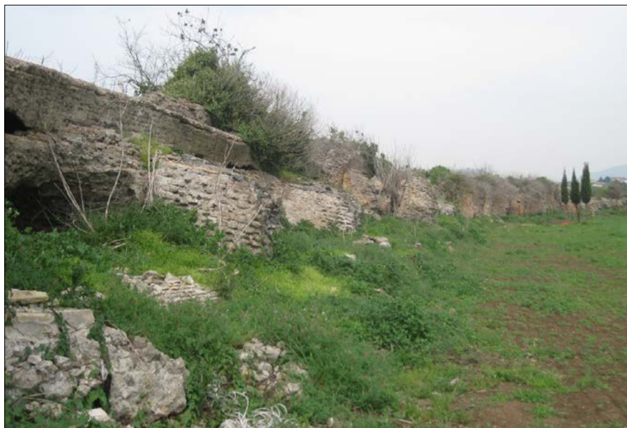
Figura 5 – Nella valle paludosa di Pantano Borghese l'acquedotto si abbassò e si inclinò verso un lato, probabilmente già durante la fase di costruzione
