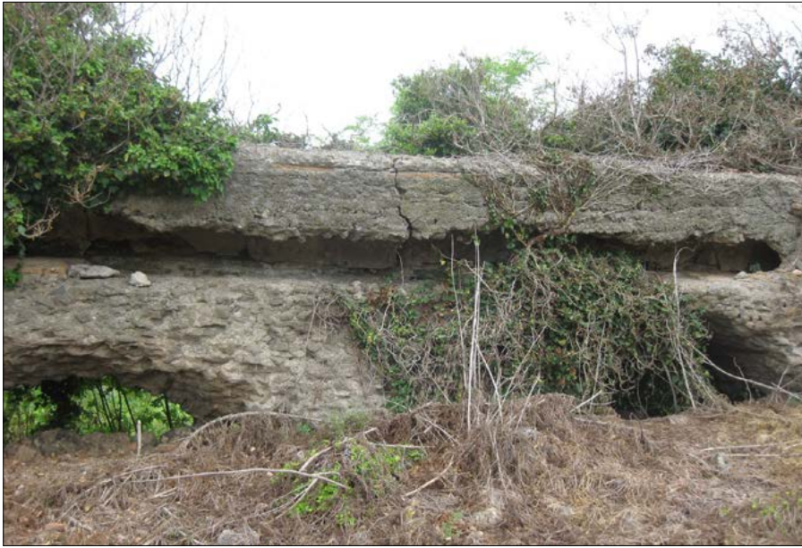
Figura 7 – Nelle valli di Pantano i costruttori rialzarono il livello del condotto originale tramite l'aggiunta di un secondo specus sovrapposto. Vista laterale
