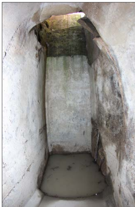
Figura 7 – Pozzo G, all'interno della Cisterna 1 (foto D.I.Pellandra)
