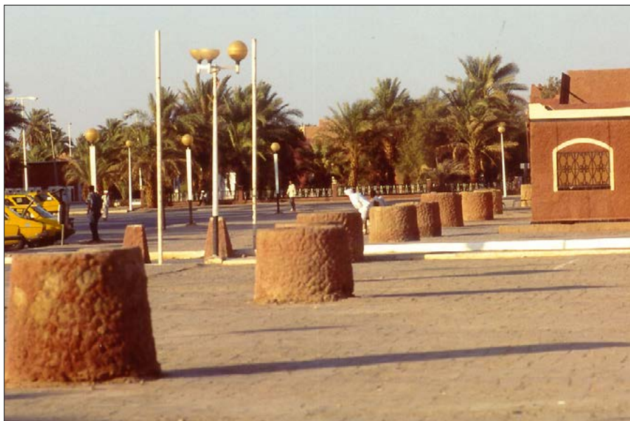
Figura 11 – Allineamento di pozzi di sfiato di una foggara di Adrar
