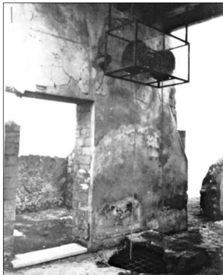
Figura 7 – Ercolano, Grande Taberna (IV, 12-13): verricello in legno collocato su una parete in corrispondenza di un pozzo (da CAMARDO D., MARTELLI CASTALDI M., THOMPSON J. 2006)
