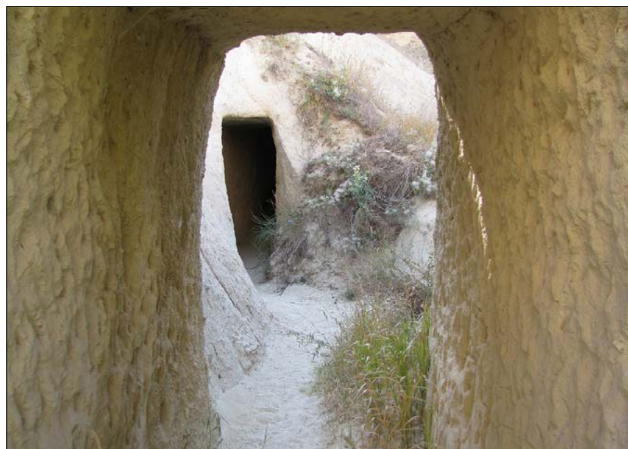
Figura 4 – Cunicolo di drenaggio nella Kılıçlar Vadisi (Valle delle Spade) (Foto A. De Pascale)
