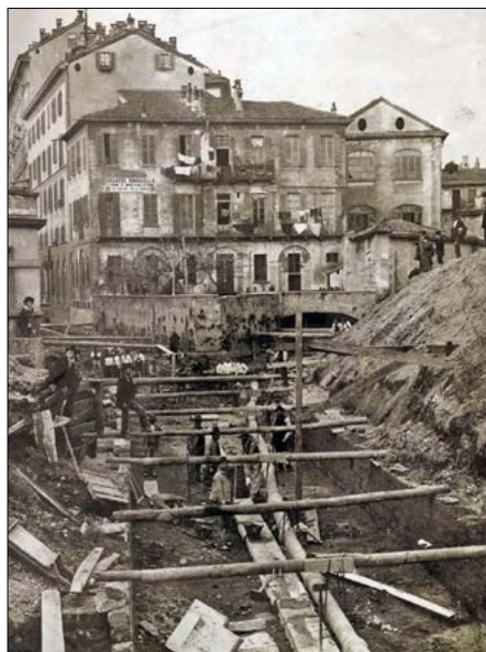
Figura 1 – Via Calatafimi, la copertura della Vettabbia nel 1899 (da Prusicki 2012, p. 156)
