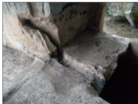
Figura 2.b – Particolare del canale di adduzione ricavato nella Calcarenite di Gravina, Gravina in Puglia
