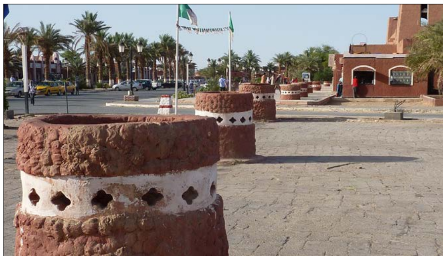
Figura 7 – Allineamento di pozzi di sfiato con parapetti a feritoie di una foggara ad Adrar
