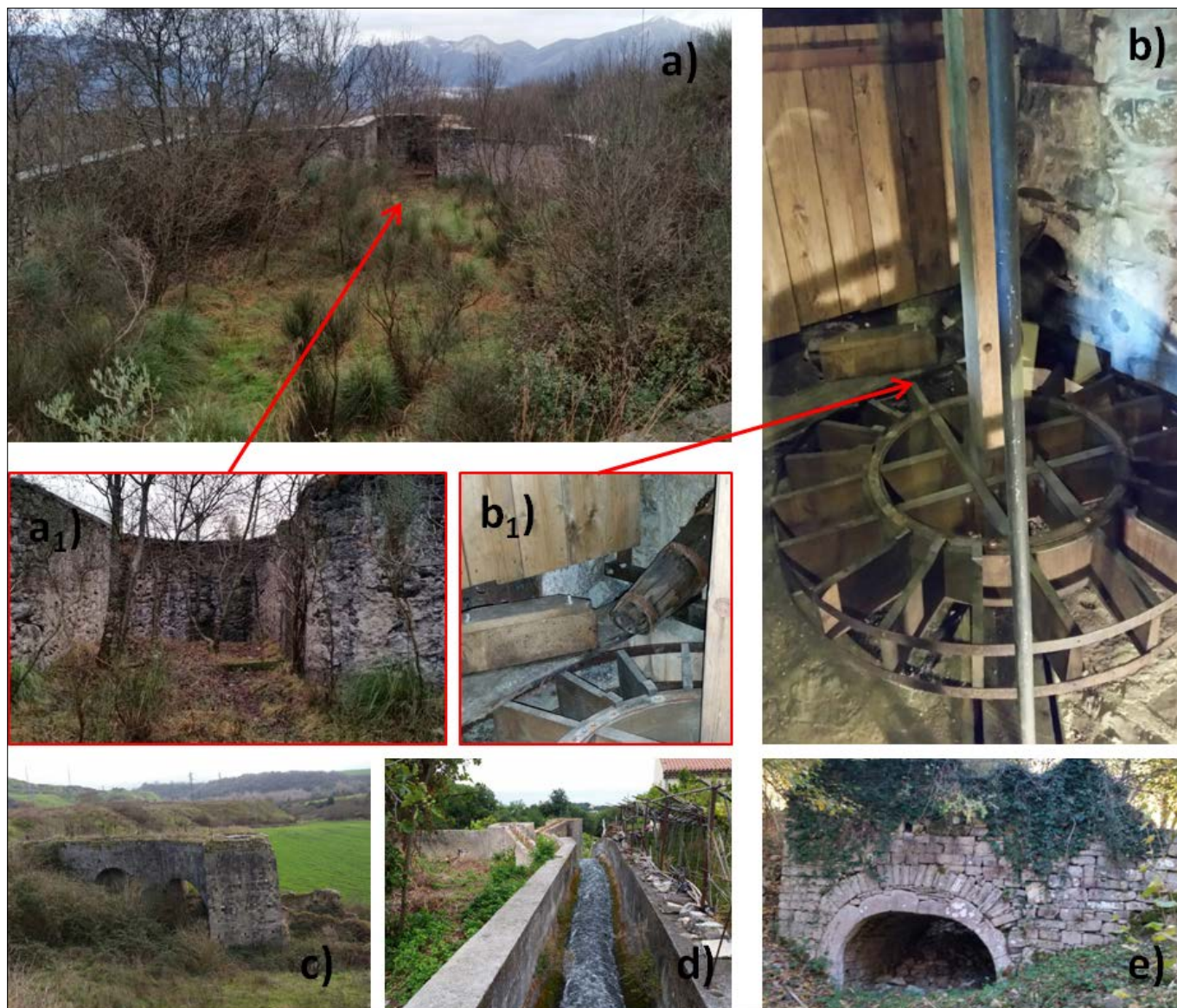
Figura 3 – Esempi di differenti componenti tecnologiche del mulino: a) vasca di raccolta a Nemoli e dettaglio del settore a valle con levata di scarico (a1); b) ruota orizzontale presso il mulino Iannarelli a San Severino Lucano con dettaglio (b1); c) Torre di carica e canale su archi di un mulino sulla Fiumara di Atella; d) canale con doppia alimentazione di due torri separate in mulini a Maratea; e) uscita del canale di scarico di un mulino lungo il Torrente Bradano a San Fele
