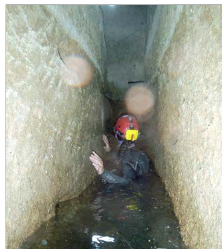
Figura 5 – Parte allagata del cunicolo-cisterna "Traforo" (Foto A. Bixio)
