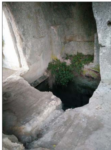
Figura 2.c – Particolare della vasca di accumulo ricavata nella Calcarenite di Gravina, Gravina in Puglia
