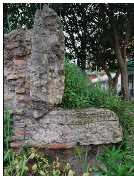
Figura 4 – L'opus signinum dello specus in Viale dei Pioppi è coperto da spessi strati di depositi calcarei
