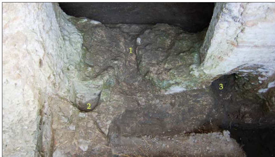
Figura 8 – Impronte di apprestamenti idraulici tra il serbatoio A e la camera B
