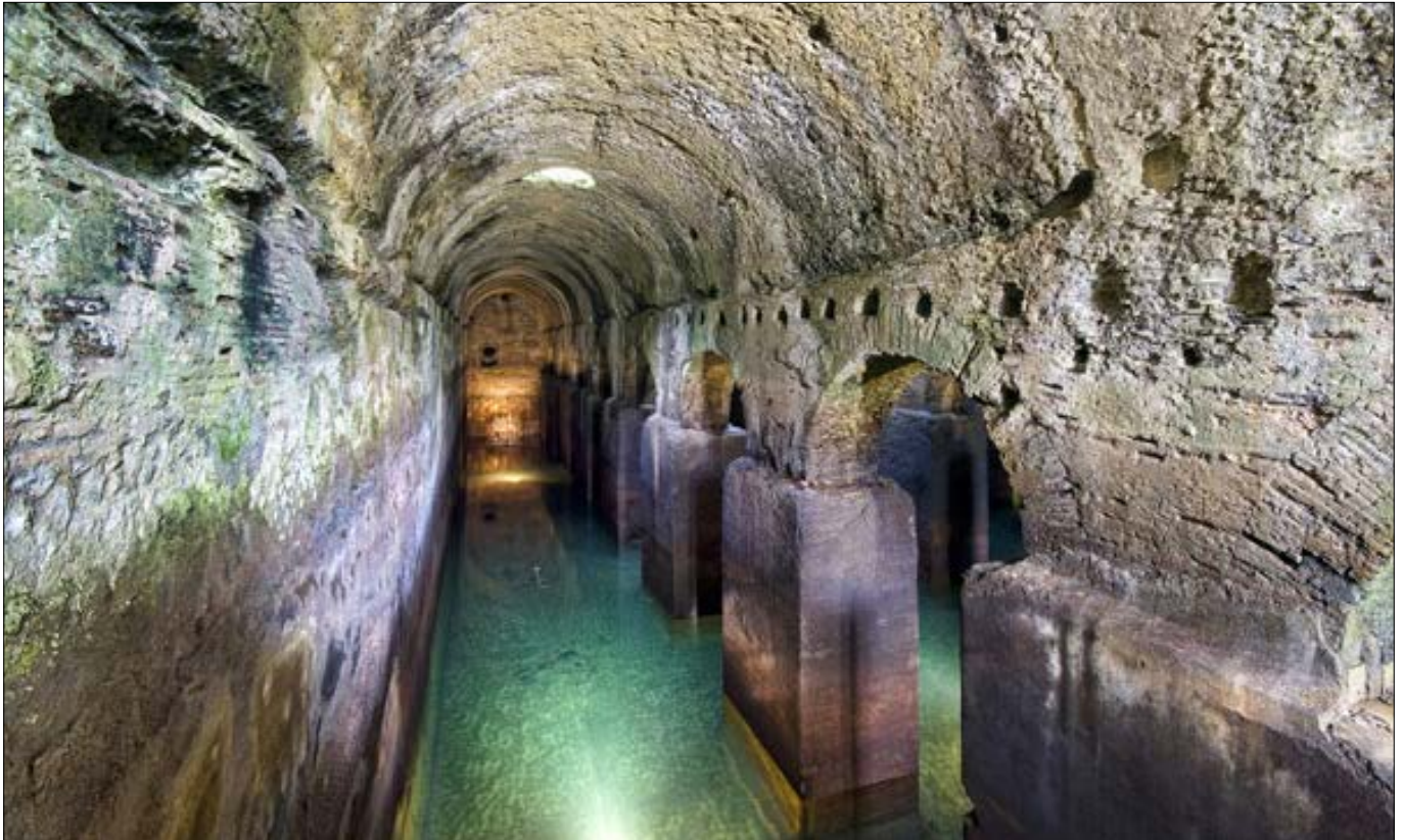
Figura 12 – Formia: interno del cisternone
