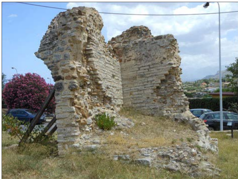
Figura 7 – Serbatoio intermedio del sifone
