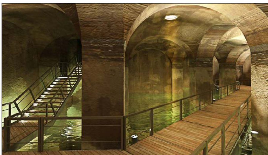
Figura 10 – Formia: interno del cisternone
