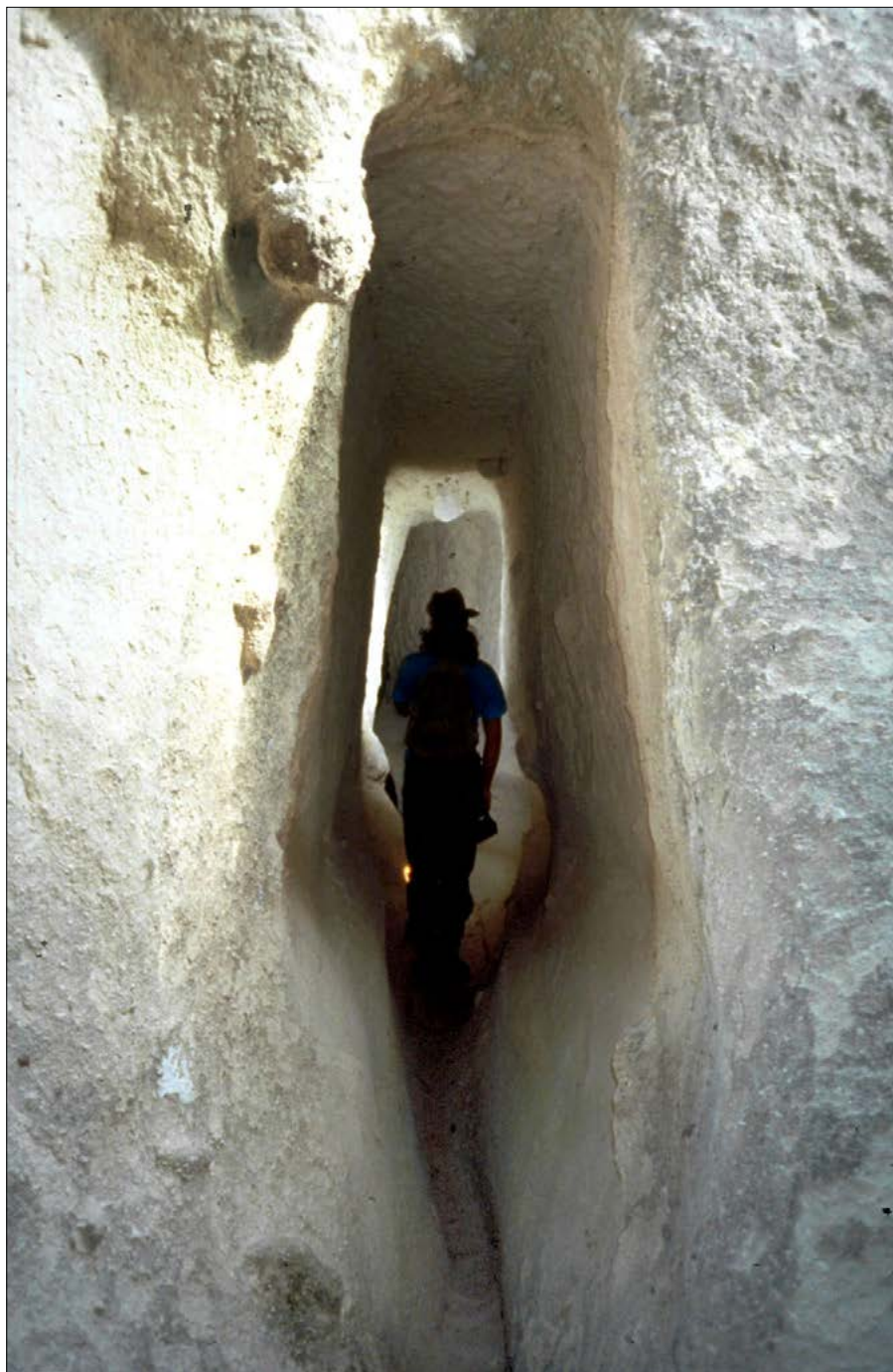
Figura 11 – Valle di Kılıçlar, Göreme (Cappadocia). Condotto di drenaggio evoluto a “buco di serratura”, conservando la sezione rettangolare originale nella parte alta (Foto L. Pagano)
