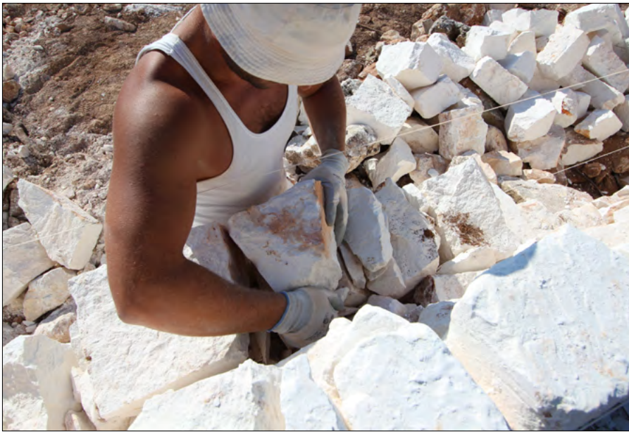
Figura 6. Fase di messa a dimora dei muri di un trullo. Foto Claudio Palma
