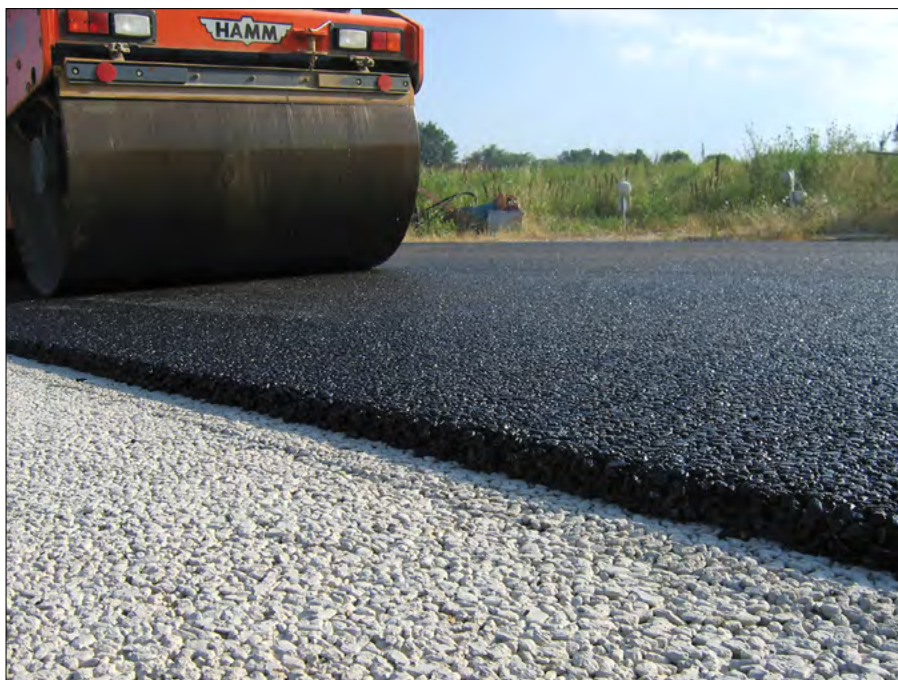
Figura 3. Fase di posa in opera del conglomerato bituminoso
