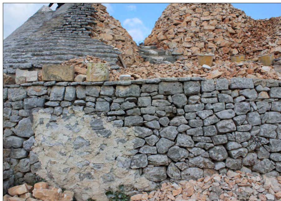
Figura 11. Particolare dei conici nella fase di restauro. Foto Claudio Palma
