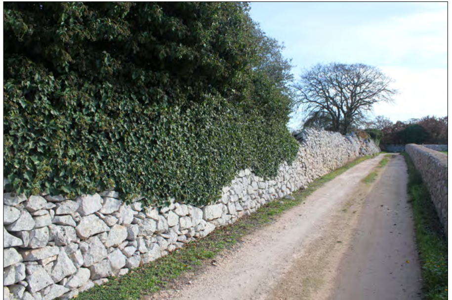
Figura 1. Muretti a secco in pietra calcarea in Valle d'Itria. Foto Claudio Palma
