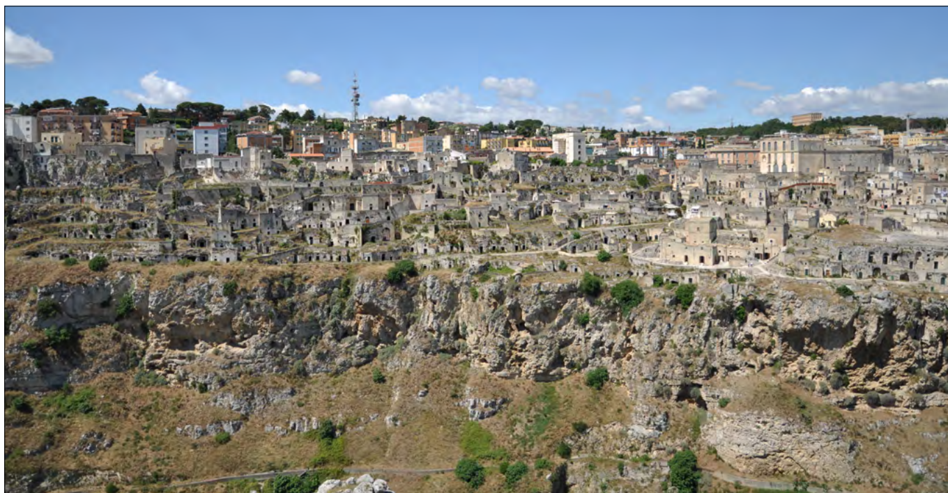
Figura 2. Il complesso sistema del rupestre, ipogeo e costruito tra Casalnuovo ed il Rione Makve. (Fotografia di Marianna Calia)
