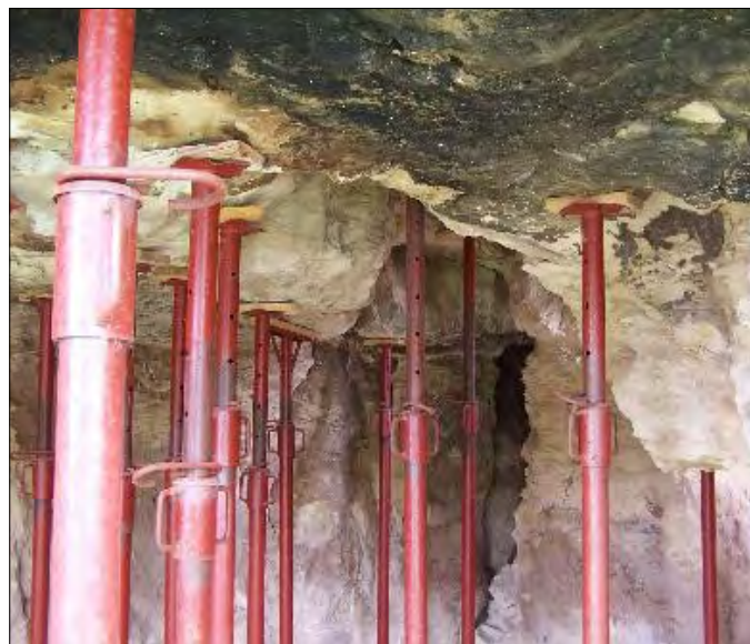
Figura 4. Puntelli a sostegno della volta
