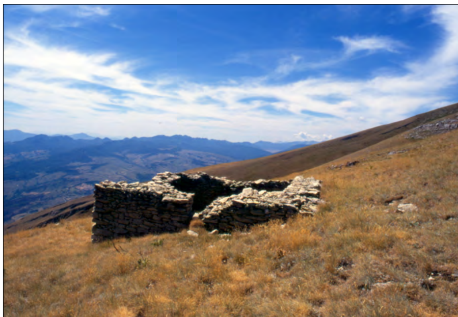
Figura 5. Capanna pastorale sui pascoli di Lama de' Peligni. La copertura era realizzata in materiale stramineo coperto con pietre e zolle erbose
