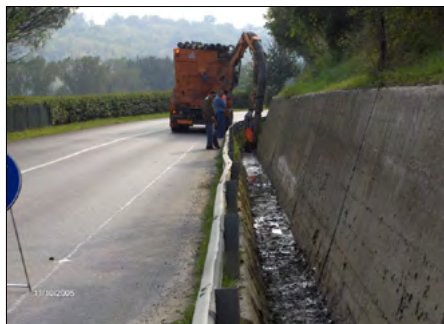
Figura 5. Pulizia delle cunette stradali a macchina, tutto da incrementare e ripristinare
