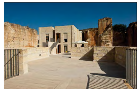
Figure 8-9-10. Cava di tufo a Favignana (Isola Egadi, provincia di Trapani) recuperate e trasformate in un hotel di lusso
