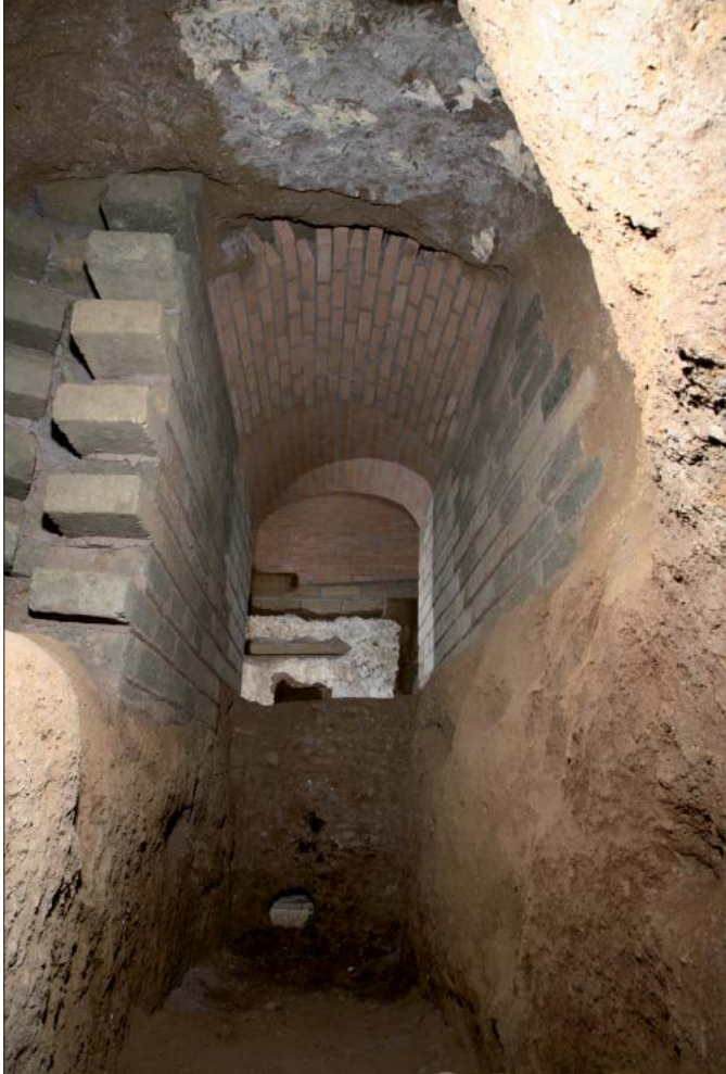
Figura 11 – Galleria X 78, ricostruzione pareti e volta
