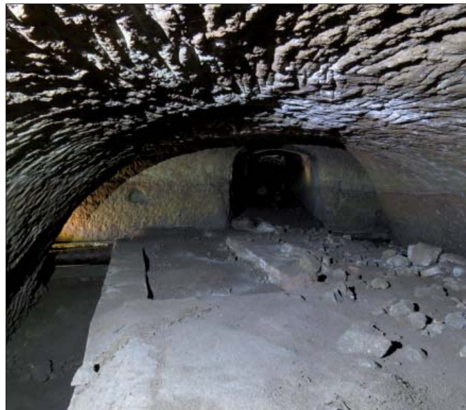
Figura 7 – Acquedotto del Cannellone (Bagnoregio): antiche vasche per la decantazione. Foto di Valerio Chiaraluca
