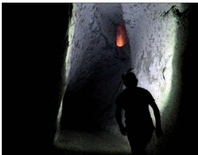
Figura 9 – Galleria stradale tra il Fosso del Cireneo e il Fosso di Lubriano (grotta dei Ghiri): ramo morto visibile sulla volta del traforo, dovuta ad un errore nelle fasi di scavo
