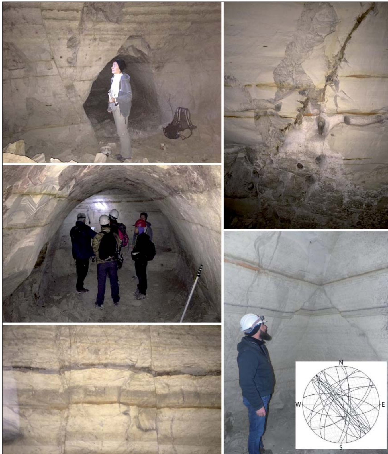
Figura 6 – Particolari dei rilievi geologico-strutturali eseguiti sulle pareti verticali delle porzioni di cavità scavate nei limi e non rivestite da muratura. Si noti la presenza diffusa di discontinuità (NW-SE, nel diagramma in basso a destra) orientate perpendicolarmente allo sviluppo longitudinale delle cavità (SW-NE, si veda anche la figura 3); tale assetto ha portato alla creazione di sezioni di volta confinate da discontinuità, circostanza che ha predisposto a crolli diffusi, anche a seguito dello scuotimento indotto dal terremoto
