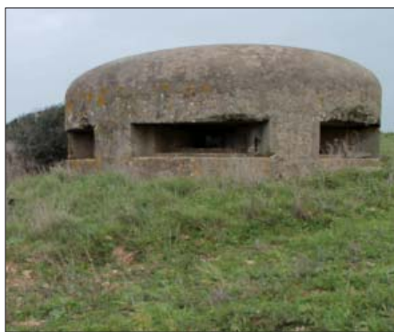
Figura 6 – Immagine di un Pillbox del Caposaldo di Sbarramento Stretto Stintino
