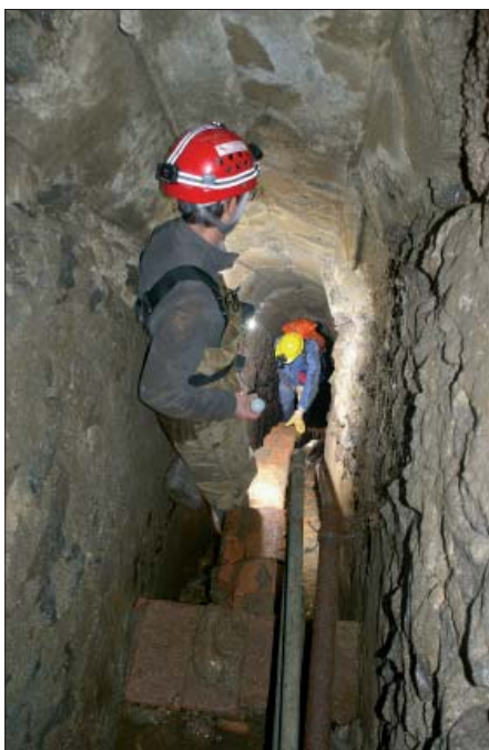
Figura 6 – La scala che consente di rendere percorribile uno dei tratti dell'acquedotto Fontana in fortissima pendenza (foto Carlo Germani archivio Egeria Centro Ricerche Sotterranee)
