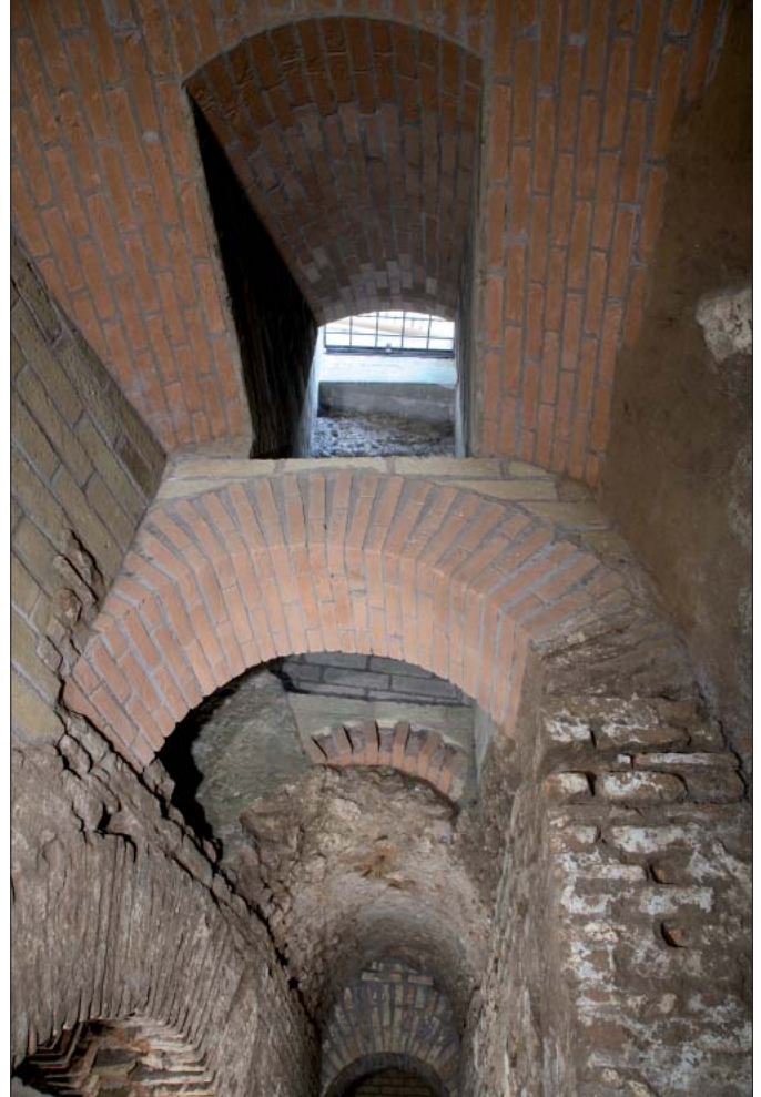
Figura 12 – galleria X53, ricostruzione volta con pozzo-lucernario
