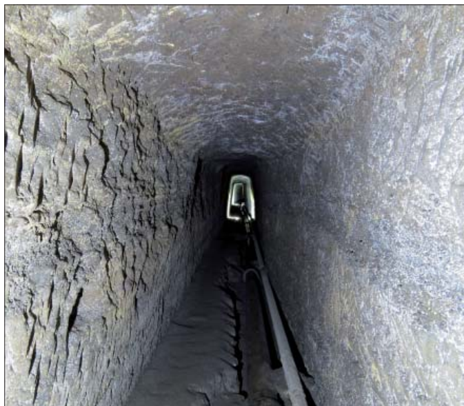
Figura 6 – Acquedotto del Cannellone (Bagnoregio): tratto centrale con la tubatura in funzione. Foto di Valerio Chiaraluca
