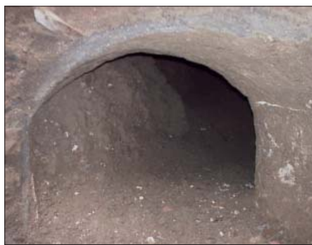
Figura 19 – Cunicolo parzialmente interrato rinvenuto nel fronte di cava della Necropoli di Vigna Pia nel punto indicato con C in fig. 15
