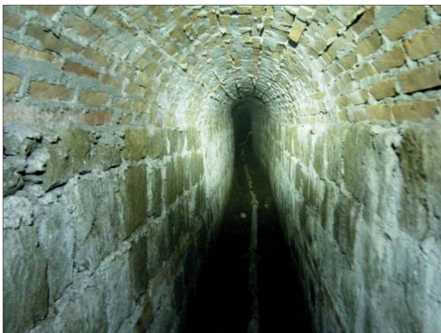
Figura 2 – Tratto iniziale dell'acquedotto farnesiano con i rifacimenti moderni
