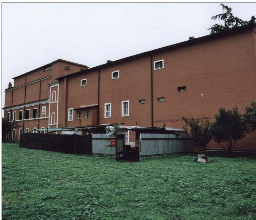
Figura 3 – Area del cantiere presso l'edificio della Suore della Sacra Famiglia
