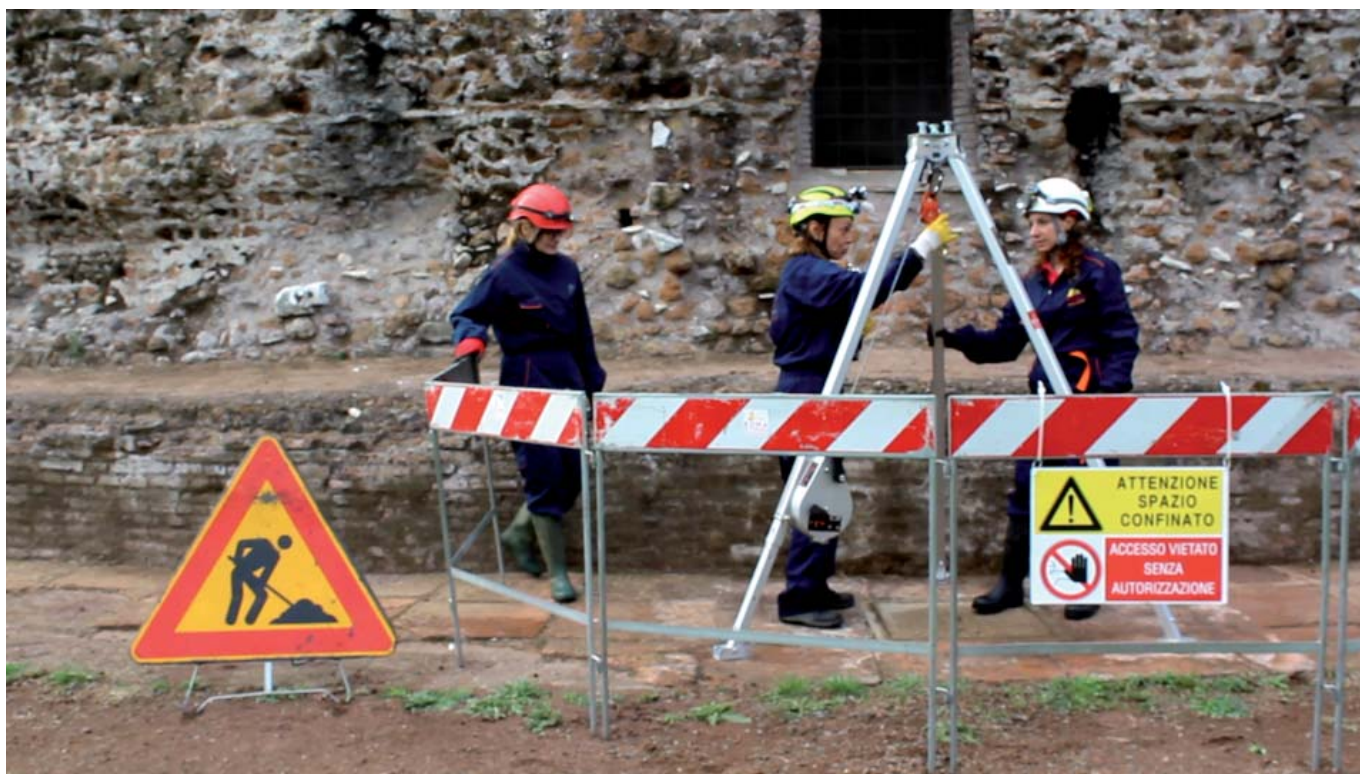
Figura 8 – Esempio di allestimento di cantiere temporaneo con posizionamento di alcuni dispositivi di protezione collettiva
