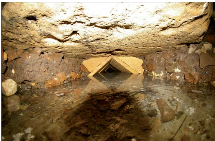
Figura 7 – Sotterranei della basilica di S.S. Apostoli
