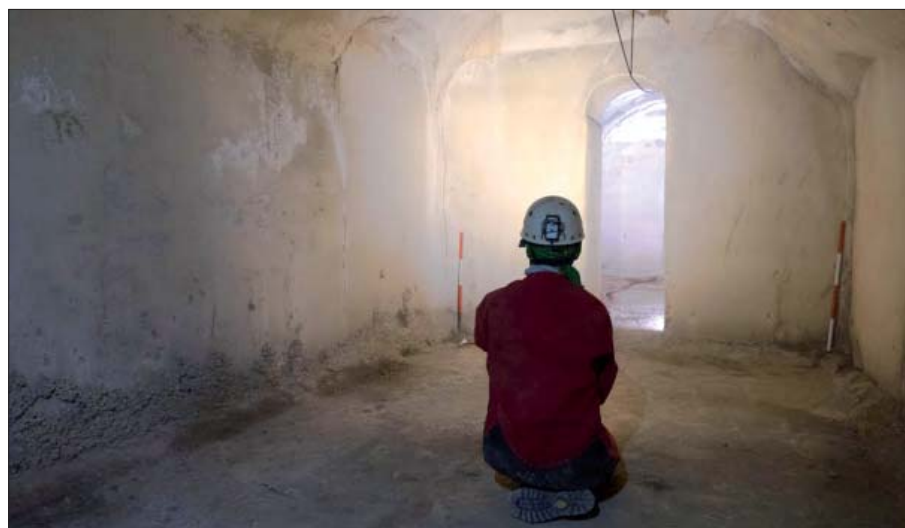
Figura 3 – Vano VIII della Cisterna I della "Cisterne sotto gli Hospitalia CA106CPNA". Si notino le gallerie murate a destra e a sinistra della camera. Foto N. Damiano
