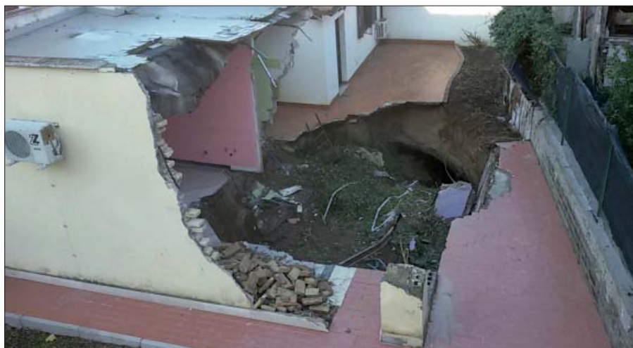
Figura 7 – La voragine apertasi tra la scuola ed il muro di recinzione dell'abitazione posta a Via Cosimo Ridolfi come si presentava nel dicembre 2015
