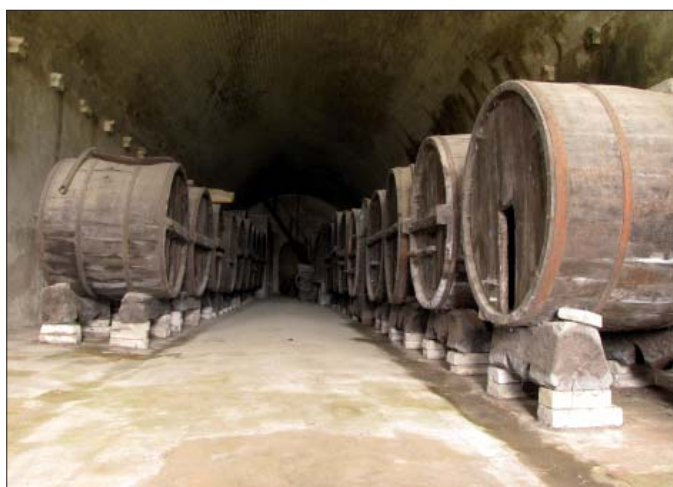
Figura 6 – Ambiente voltato al piano seminterrato del Cantinone
