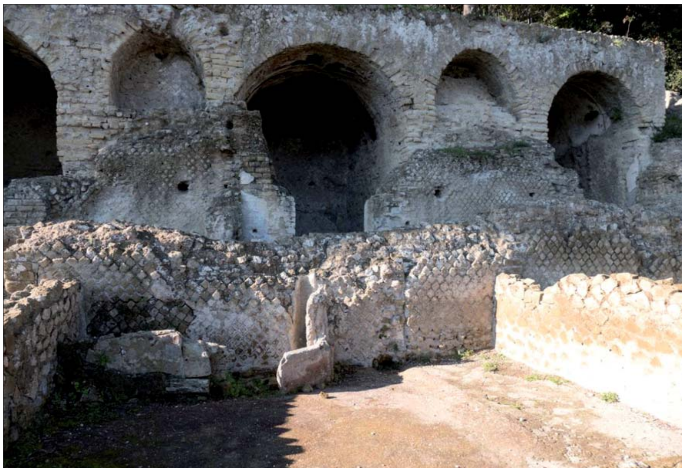
Figura 13 – Terrazza Est Hospitalia. Ambiente esterno con al centro una vasca e un pozzetto fortemente concrezionati molto prossimi al vano V della cisterna sottostante. Foto N. Damiano
