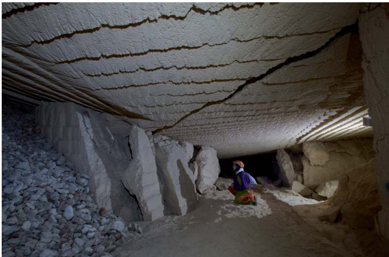
Figura 5 – Gravi fenomeni di dissesto di alcune gallerie
