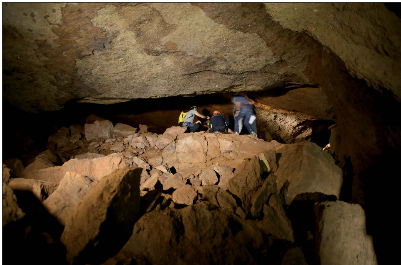
Figura 1 – Sopralluogo del GdL presso le Cave di Monteverde, Circonvallazione Gianicolense, in cui sono presenti crolli di volta
