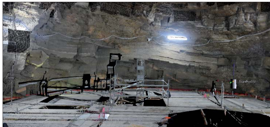
Figura 6 – Nuvola di Punti - Modello numerico reale dell'interno della calotta
