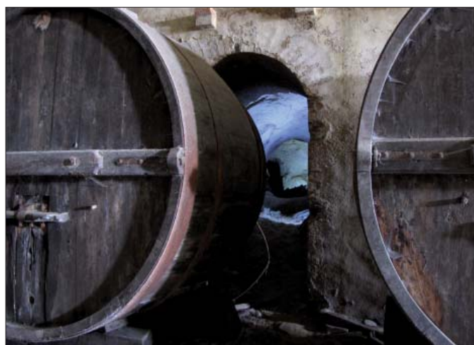
Figura 7 – Ambiente voltato al piano seminterrato del Cantinone
