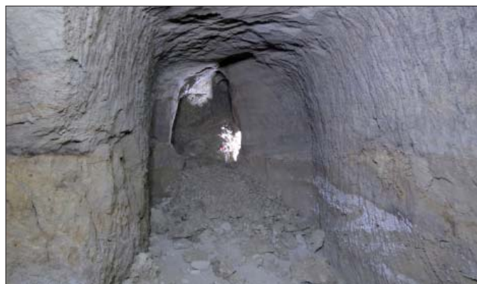
Figura 9 – Pozzo a sezione rettangolare da cui si diparte uno dei tratti dell'acquedotto romano (Cap. 8)
