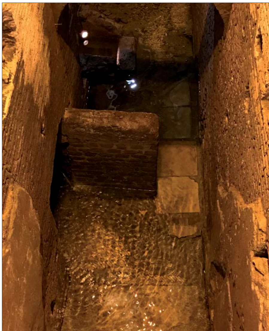
Figura 11 – Castellum Aquae di Vicus Ciprianus: un ambiente sotterraneo che costituiva un serbatoio di raccolta d'acqua proveniente dall'acquedotto dell'Acqua Vergine
