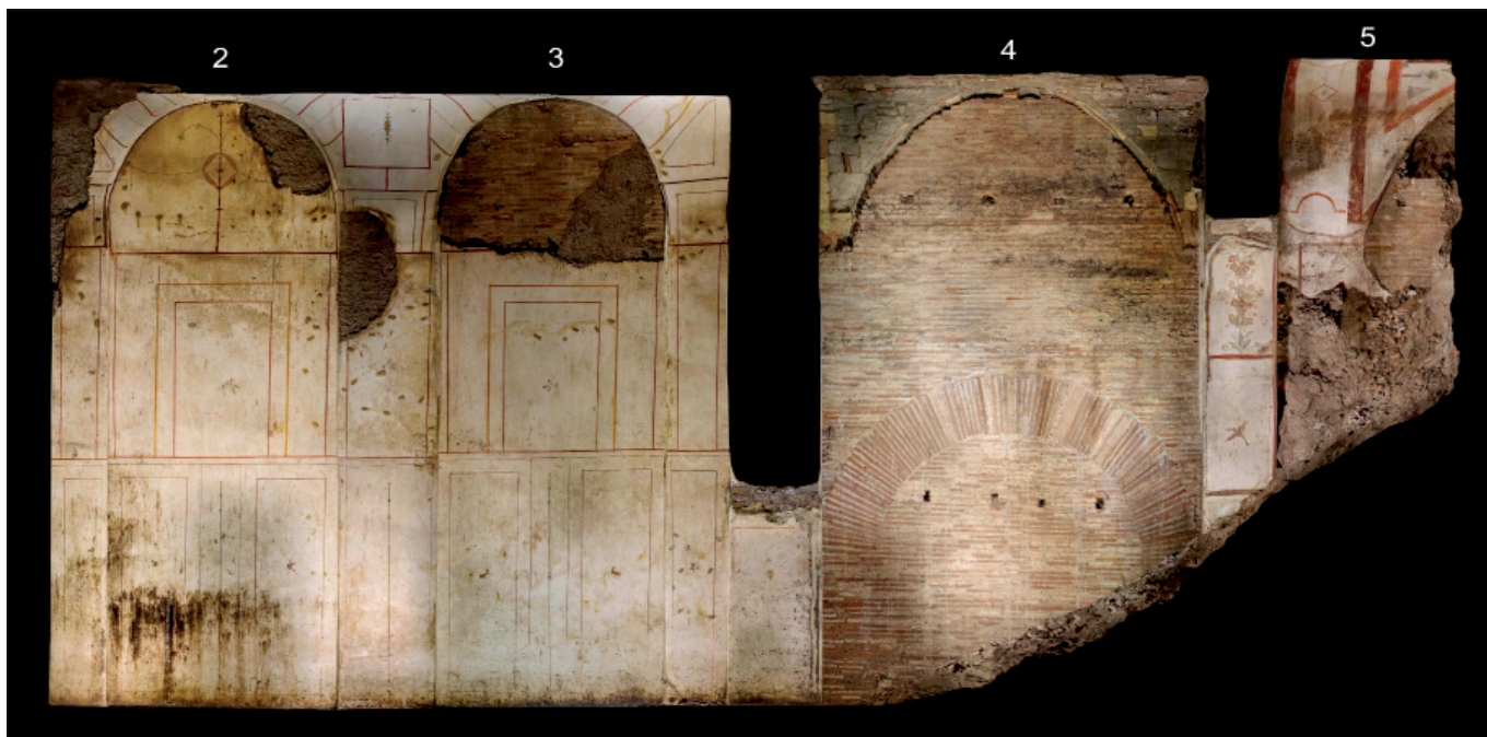
Figura 5 – Ortofoto delle pareti sud-ovest degli ambienti 2, 3, 4, 5 della Privata Traiani domus (elaborazione da rilievo fotogrammetrico tridimensionale di S. Calò, E. Santucci)
