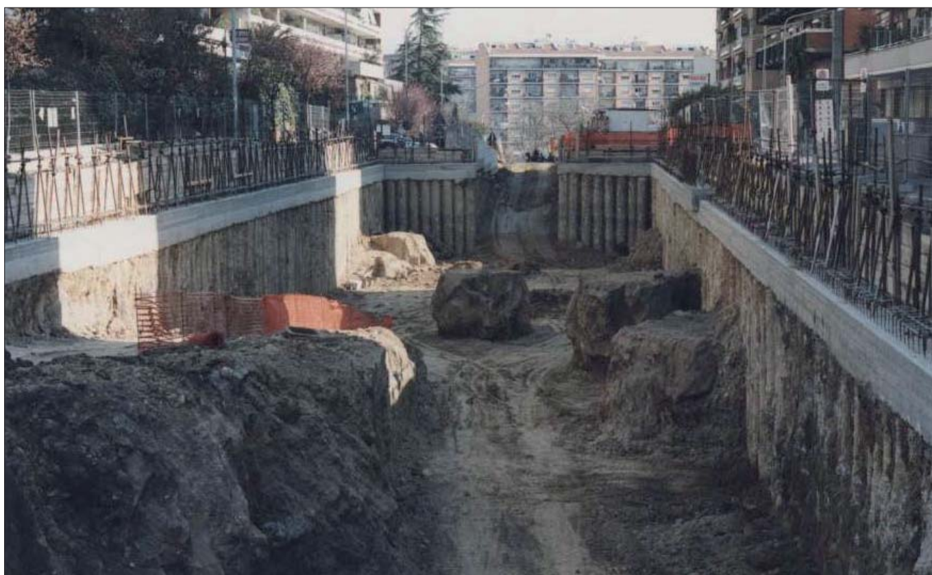
Figura 20 - Cantiere parcheggio in Via Ricci Curbastro, con evidenti i testimoni di cava e blocchi lavorati di tufo lionato. La vista è verso sud-est
