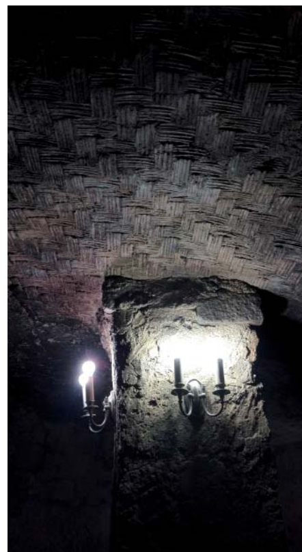
Figura 13 – Impronta della stuoia di cannuce intrecciate utilizzata per rinforzare l'intonaco che rivestiva il soffitto di un ipogeo oggi adibito ad enoteca a Civita. Foto di Claudia Gentili
