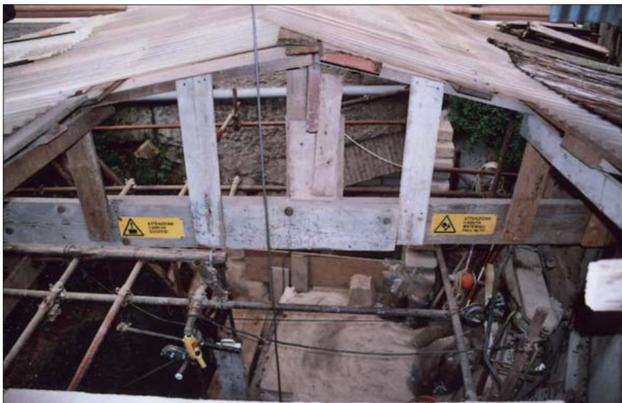
Figura 4 – Cantiere di scavo
