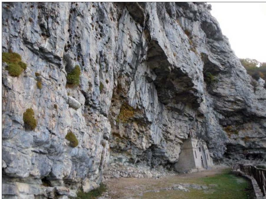
Figura 7 – Immagine fotografica dell'eremo e dei tetti rocciosi incombenti sul sito
