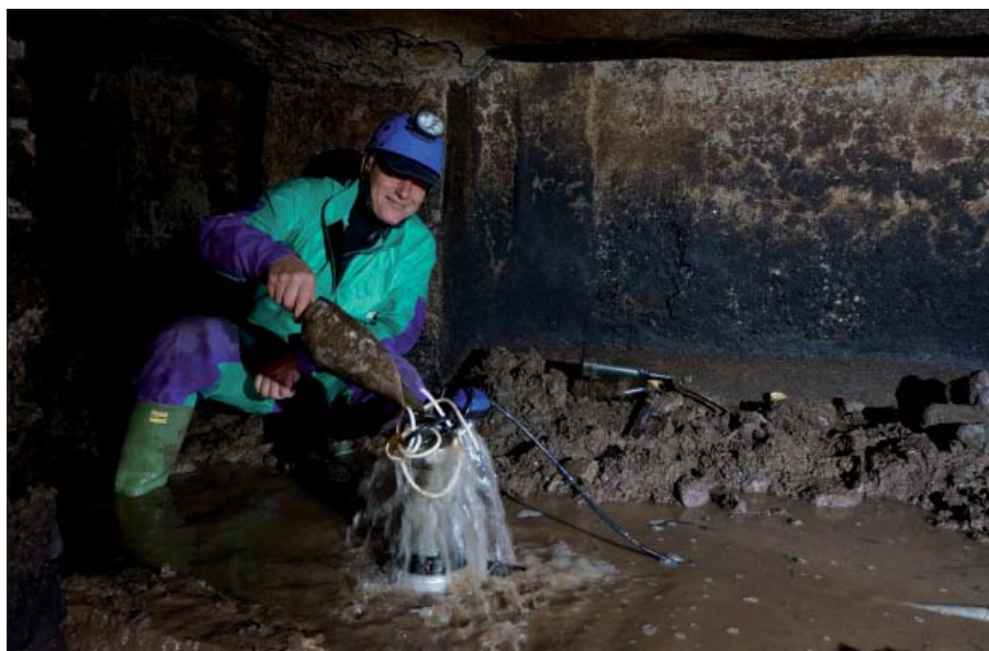
Figura 3 – (Ph Stefano Barbaresi - ASSO) Middle cistern at Villa dei Quintili in Roma: after inspection and removal of water and mud, the electric pump is now being cooled La cisterna mediana della Villa dei Quintili a Roma: dopo la rimozione di acqua e fango, si raffredda manualmente la pompa ormai emersa
