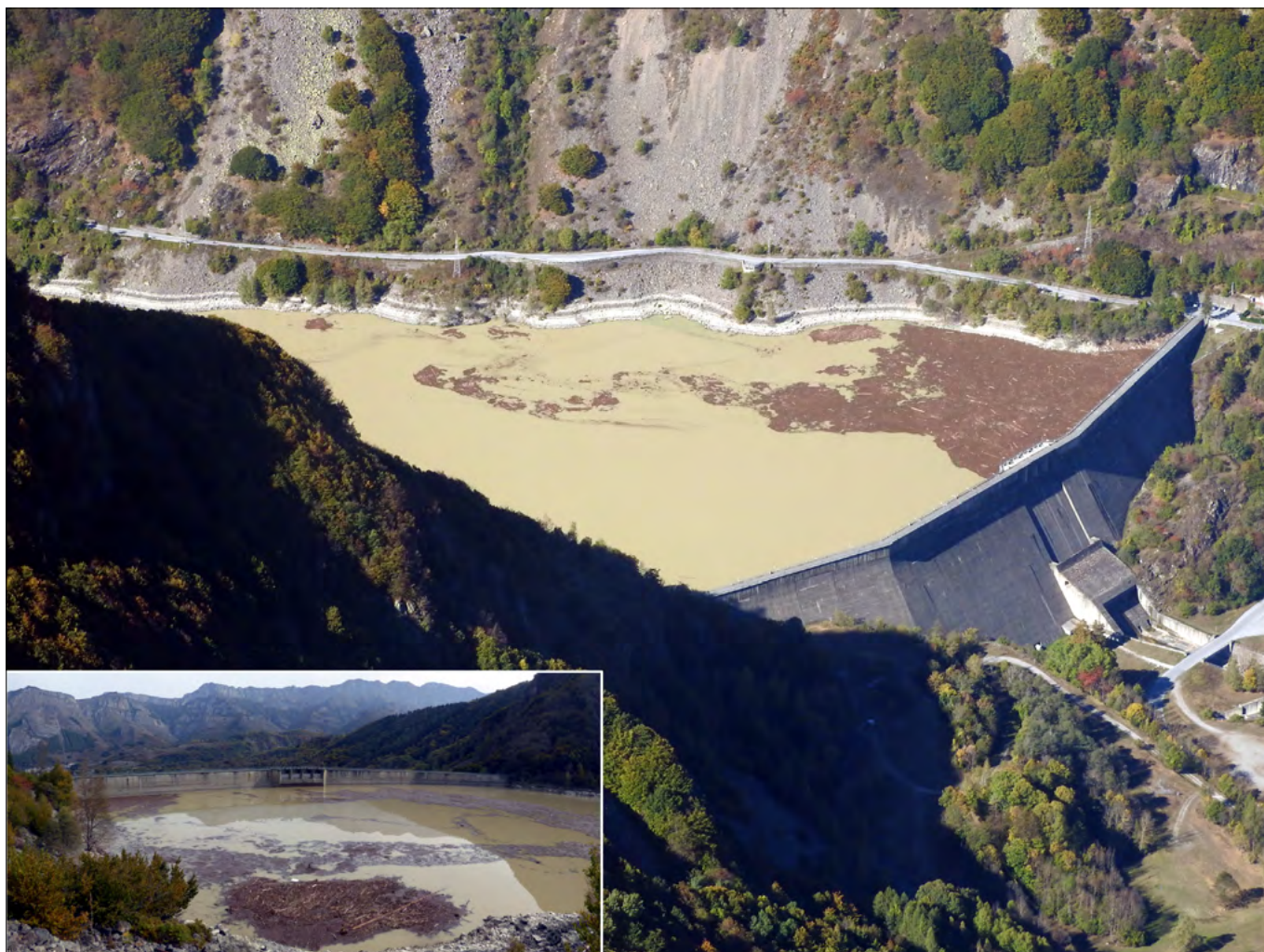
Figura 90. Diga della Piastra, veduta aerea dell'8 ottobre 2020 e ripresa da terra (foto Turconi). L'invaso è stato parzialmente riempito da materiale flottante e da un rilevante volume, anche se non quantificabile, di materiale lapideo.
