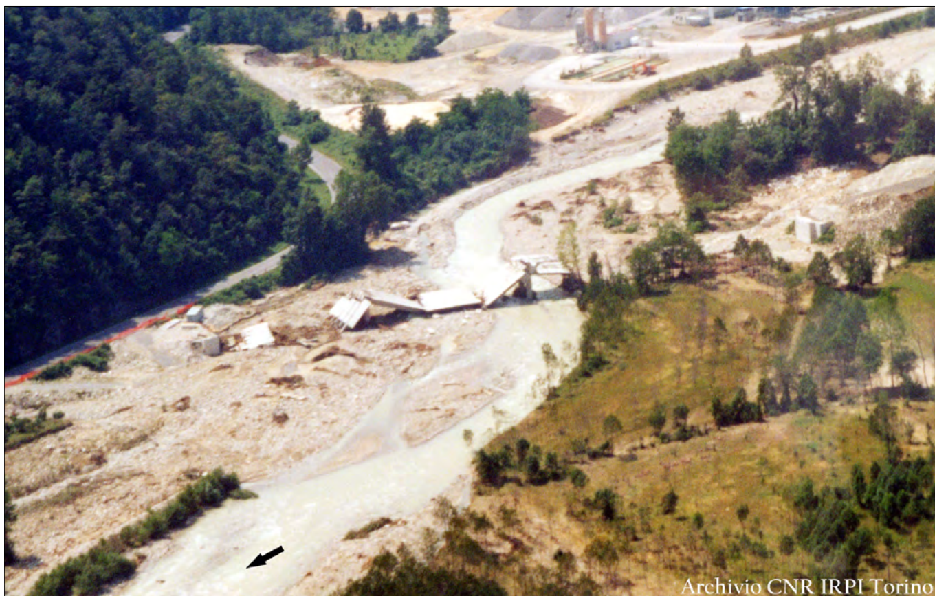
Figura 143. La piena del Torrente Vermenagna danneggiò gravemente il ponte dell'attuale Via Provinciale Boves, circa 500 m a monte della confluenza nel T. Gesso.
