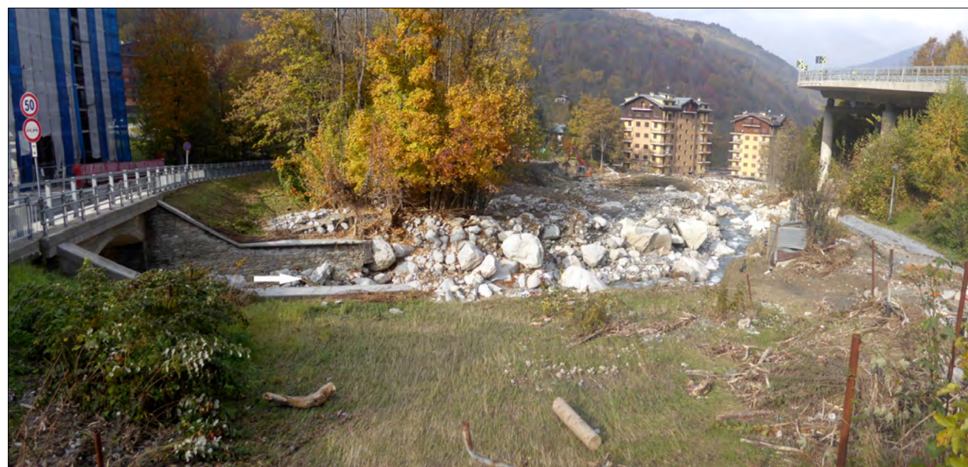
Figura 166. A sinistra nell'immagine si nota la SS20, che sovrappassa il T. Vermenagna con un ponticello avente una luce di circa 25 \text{ m}^2 (lo si scorge anche nella figura precedente). In contemporanea alla piena del T. Vermenagna, confluita totalmente al di sotto della statale, è sopraggiunto un contributo inaspettato del Rio Panice che, sormontando la strada statale e poi settori privati, si è poi ricongiunto "fuori alveo" con il Vermenagna che ha proseguito la sua corsa distruttiva verso l'abitato di Limone (foto Luino).
