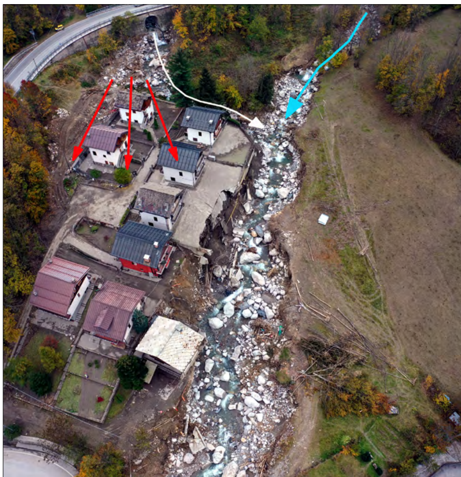
Figura 163. Immagine ripresa dalla Ditta Eurodrone per conto del Comune di Limone da cui si evincono le circostanze che hanno indotto effetti dannosi sul nucleo edificato di Tetti Mecci. Sono infatti ben visibili l'alveo originario del Rio Panice (tratto bianco), che si immetterebbe a circa 90° nell'alveo del T. Vermenagna (tratto azzurro), ma che nel corso dell'evento di piena ha optato per differenti vie di deflusso a causa dell'ingente portata dell'asta principale (freccie rosse), attraversando il nucleo abitato fino riunirsi a valle di questo nell'asta principale.
