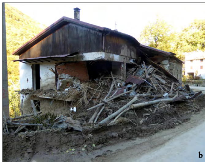
Figura 69. Sul versante destro della Valcasotto ( 44^{\circ}14'40.75''N 7^{\circ}54'05.14''E ) si è innescata una frana superficiale (a) che ha coinvolto la copertura eluvio-colluviale per uno spessore di circa 50–60 cm. Il volume stimato, circa 650 m 3 , si è abbattuto su una casa (b) posta lungo la SP178, lesionandola gravemente (entrambe foto Luino).
