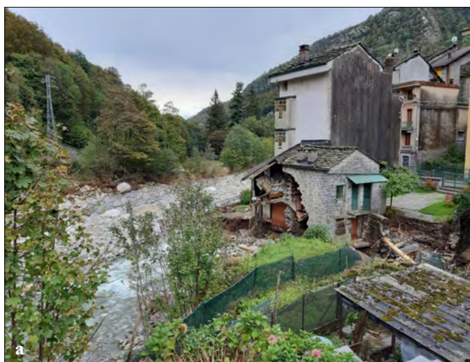
Figura 240. Rosazza: a) danni a un edificio adiacente il ponte di Vittone crollato per il transito della piena; b) erosione per tracimazione in regione Fornaca.
