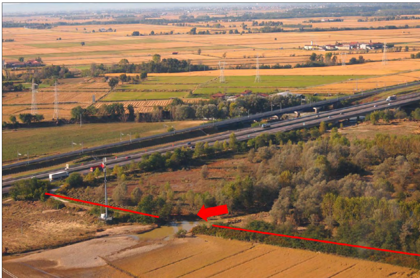
Figura 244. Rottura dell'argine in corrispondenza della roggia Berzetti.
