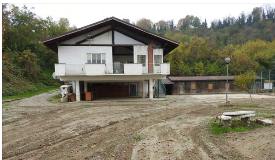
Figura 50. L'edificio degli spogliatoi dei campi sportivi di Bastia Mondovì nuovamente allagato, come nel 2016 (foto Silvestro).
