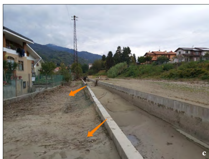
Figura 228. Borgosesia (VC): Rione Isola alcuni giorni dopo il passaggio dell'acqua che ha invaso gli scantinati e i primi piani degli edifici; a) I laboratori del centro Enaip di Borgosesia (f. TG Vercelli 07/10/2020); b) la linea rossa indica l'altezza raggiunta dall'acqua in via Isole II; c) il canale di derivazione che ha convogliato l'acqua all'interno dell'edificato.
