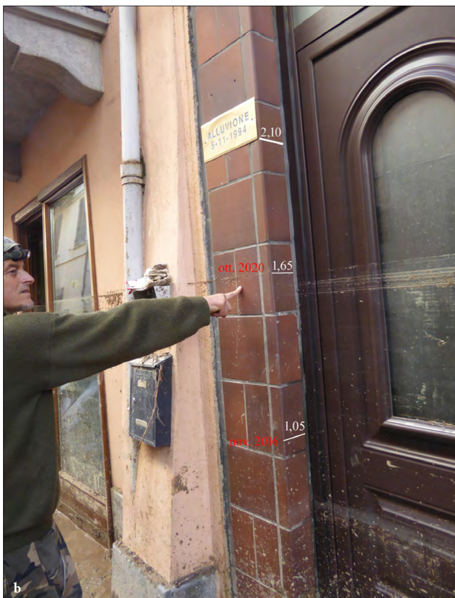
Figura 38b. Garessio, Via Vittorio Emanuele II, sabato 3 ottobre: i segni della piena di qualche ora prima mostrano il livello raggiunto dalle acque, circa 45 cm in meno della targa commemorativa del novembre 1994 dove però l'apporto del Rio Luvvia fu molto rilevante. Più in basso l'altezza raggiunta nel novembre 2016 (ricostruita da fotografie scattate 4 anni fa) (foto Luino).
