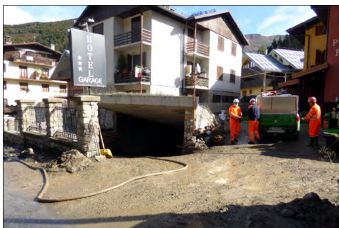
Figura 181. Effetti della piena del T. Vermenagna e dei tributari nelle aree edificate. I numerosi garage in sotterranea, così come moltissimi piani terreno degli edifici, sono stati colmati totalmente dalle acque ricche di apporti fangoso-detrifici che hanno reso molto difficoltoso il loro svuotamento con le pompe sommergibili (foto Turconi e Luino).
