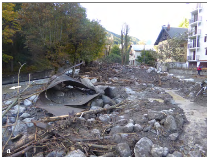
Figura 177. Edifici posti lungo il T. Vermenagna invasi da acqua, detrito fine e grossolano. Il corso d'acqua si è ampliato notevolmente sulla piana (a) su cui sorge gran parte dell'abitato di Limone, occupando quasi tutto il fondovalle (foto Luino). Sovente un ruolo negativo lo hanno svolto ponticelli di accesso alle abitazioni (b), aventi luce decisamente insufficiente (vedasi riquadro) che durante la piena hanno provocato uno sbarramento al deflusso e la sua diversione verso la strada (in sinistra) e le abitazioni (in destra)(foto Turconi).
