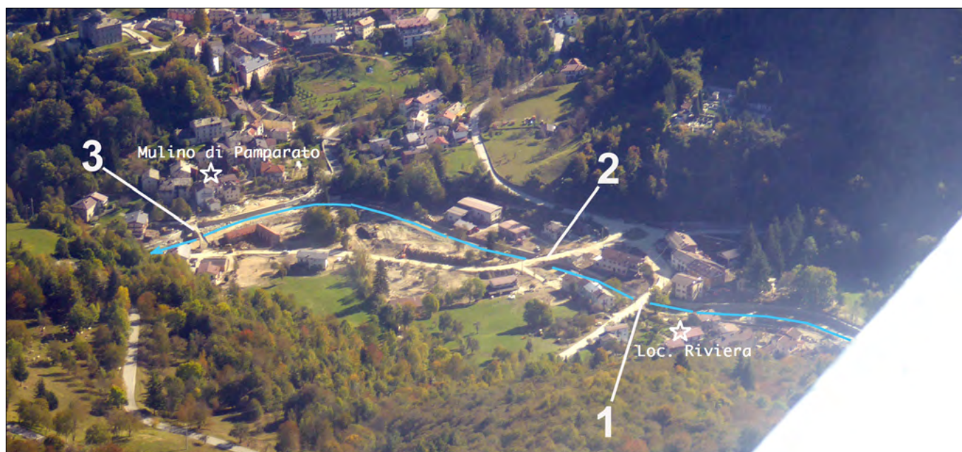
Figura 70. Pamparato: veduta aerea. I tre ponti della parte bassa dell'abitato lungo il T. Casotto (tratto azzurro) sono evidenziati: 1) ponte della SP35 (Via Riviera), 2) ponte della SP164, 3) antico ponte romano (foto Luino).
