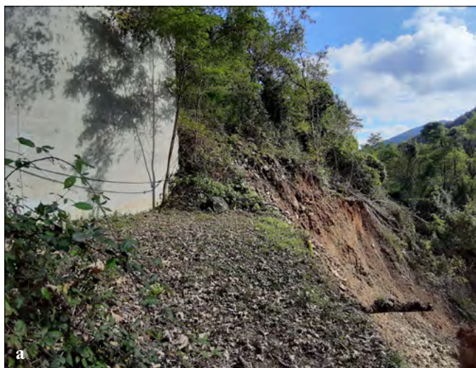
Figura 248. Frana prossima alla base dei piloni centrali del viadotto di Pistolesa.
