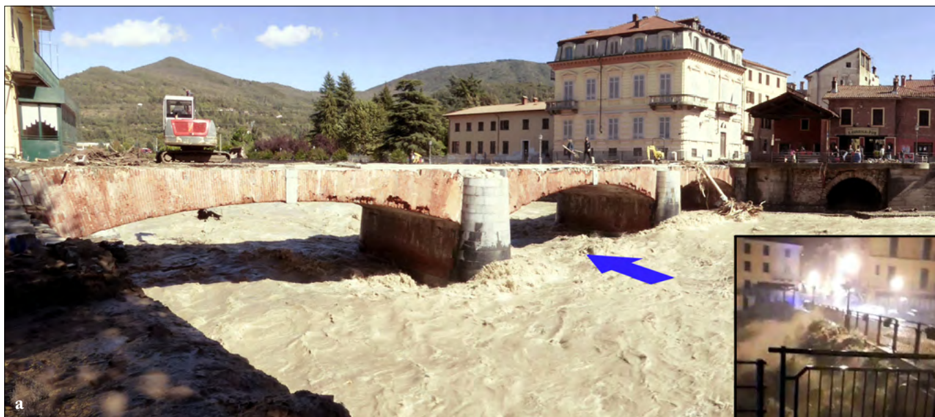
Figura 38a. La possente struttura del Ponte Odasso, fotografato dalla sponda sinistra sabato 3 ottobre (foto Luino). Le ringhiere, ricostruite dopo l'evento del 2016, sono state nuovamente asportate. La luce delle tre arcate si è sempre dimostrata insufficiente al deflusso delle portate straordinarie anche per la presenza di notevole materiale flottante. Dopo oltre 25 anni di discussioni, l'opera è stata demolita nel novembre 2020. Nel riquadro un'immagine della tarda serata del 2 ottobre (foto L'Unione Monregalese).
