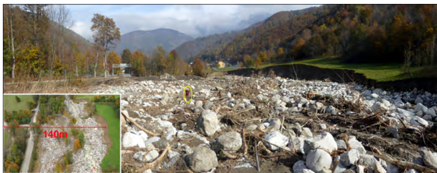
Figura 168. Estensione della sezione di deflusso del T. Vermenagna, circa 500 metri a valle della loc. Tetti Mecci, dove la piena ha esaltato gli effetti dannosi lungo il fondovalle. Nell'immagine è riconoscibile un'estesa erosione in destra idrografica, dell'altezza di oltre 6 metri. In tale tratto è stata effettuata una misura indiretta della sezione raggiunta dal corso d'acqua in piena (foto Luino). L'ampiezza dell'alveo in questo tratto è passata da circa 15 m a 140 m con il passaggio della piena del 2 ottobre 2020.
