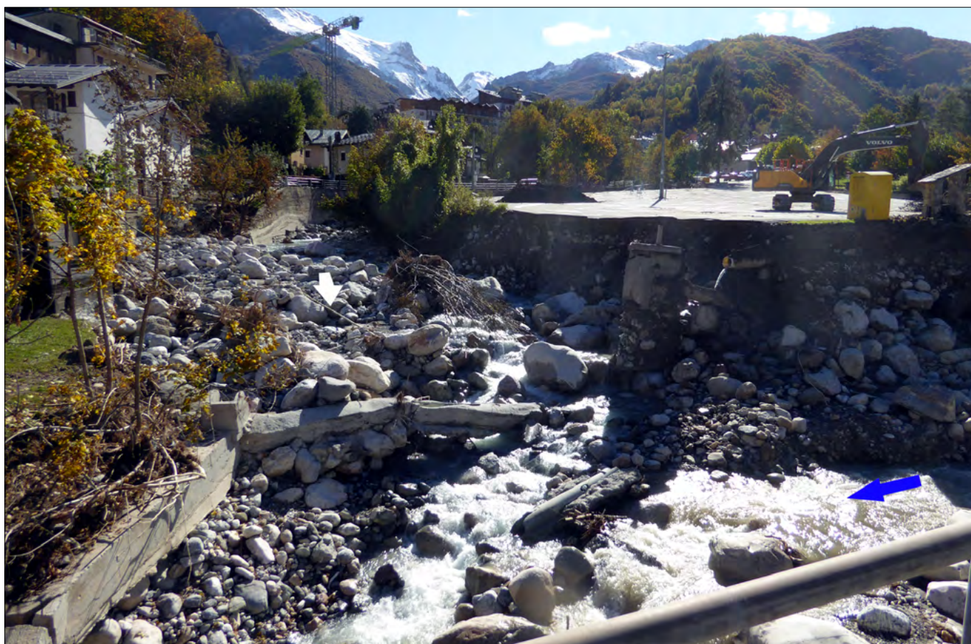
Figura 184. All'entrata del centro abitato vi è la confluenza del T. Vermenagna (freccia blu) con il tributario T. San Giovanni (bianca). L'ampio piazzale di parcheggio (cfr. figura successiva), realizzato su depositi incoerenti di entrambi i corsi d'acqua, è stato vistosamente eroso dall'azione congiunta delle piene (foto Luino).
