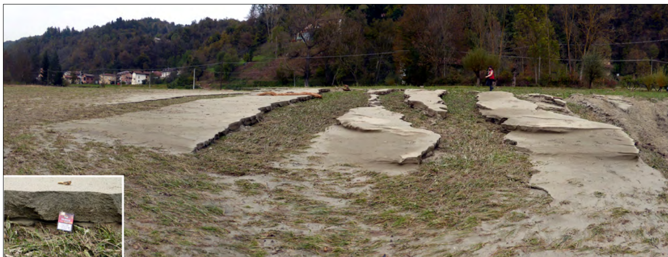
Figura 78. T. Casotto, presso C.na Ascheri. In sponda destra, materiale sabbioso-limoso depositato dalla piena (con spessore medio sui 15 cm) e successivamente eroso dalle acque di ruscellamento.
