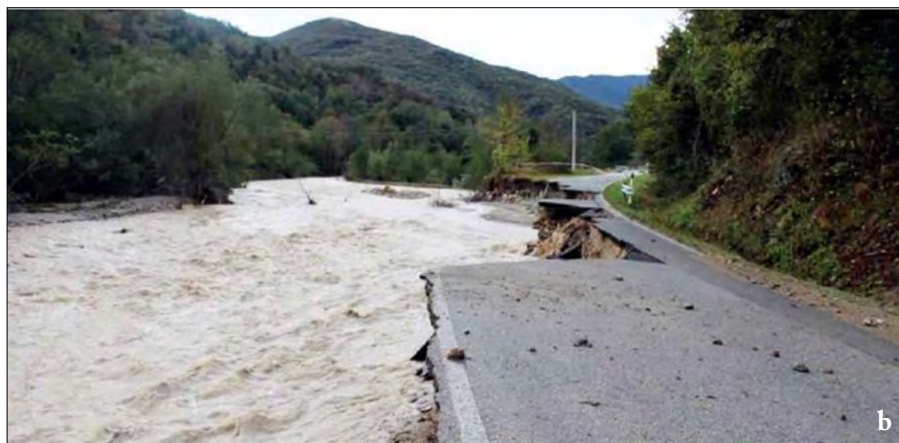
Figura 67. Strada provinciale 34 fra Lisio e Viola, a) prima (Google Earth) e b) dopo l'evento di piena del T. Mongia (L'Unione Monregalese).
