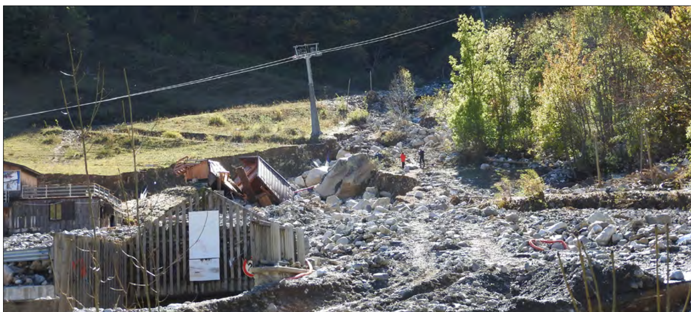
Figura 155. Effetti dannosi agli impianti di risalita della seggiovia Morel e alla struttura ricettiva. L'accumulo detritico ha seppellito parte dei piloni di sostegno, le opere accessorie e il piazzale con spessori medi di oltre 3 metri ed ha colmato il parcheggio sottostante l'area di sosta, visibile in primo piano (foto Turconi).
