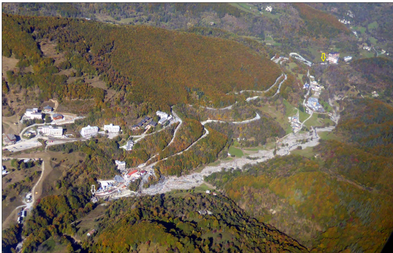
Figura 161. Vista aerea dell'esteso e continuo alluvionamento lungo il Rio Panice. In alto a destra nell'immagine, verso valle, è riconoscibile la loc. Tetti Mecci (freccia gialla), in prossimità della confluenza del Rio Panice nel T. Vermenagna, mentre in basso s'intravede l'ingresso del lato italiano del tunnel di Tenda (freccia bianca)(foto Luino).
