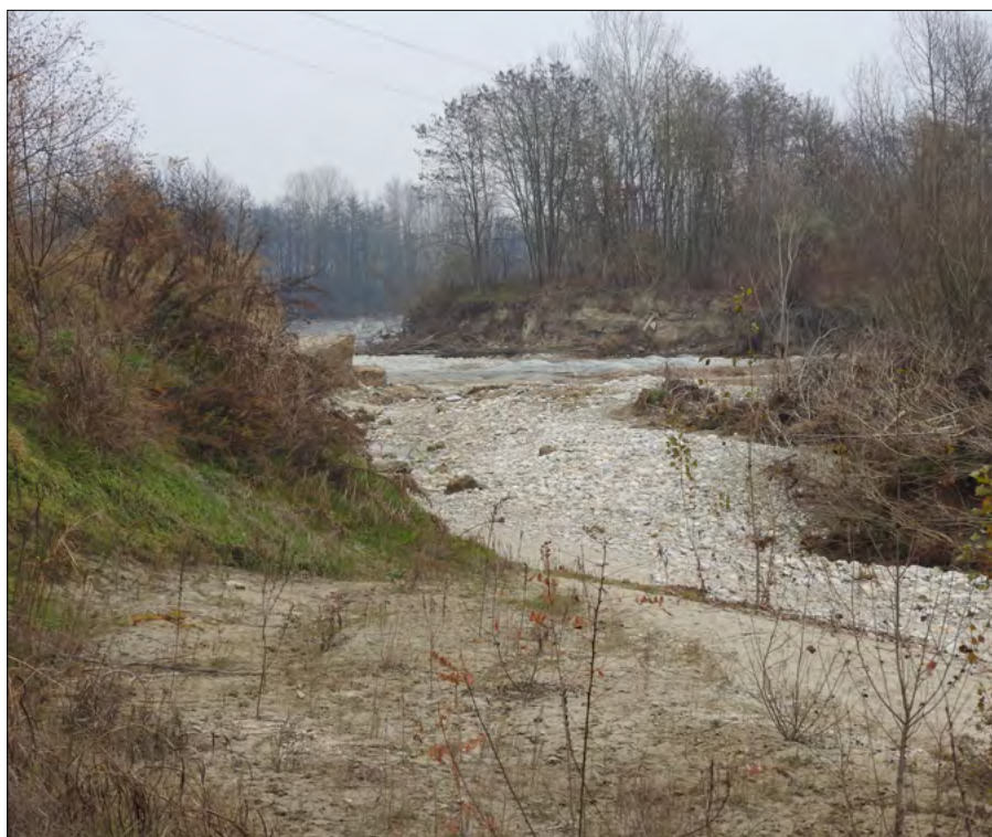
Figura 62. La profonda erosione sulla sponda destra poco a valle del ponte della SP7. Sullo sfondo si vede l'alternanza di marne ed arenarie della sponda sinistra del Tanaro, il cui letto risulta privo di sedimenti e ad una quota di circa 6 m inferiore alla sponda (foto Silvestro).
