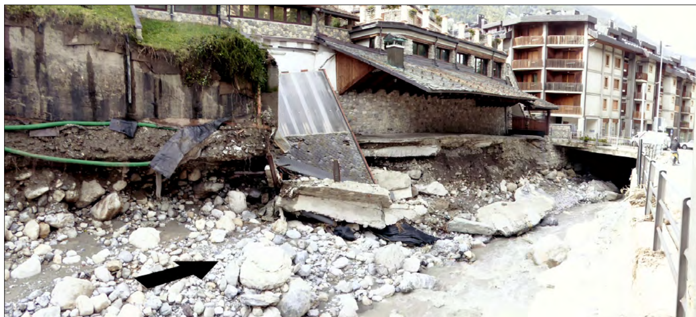
Figura 210. Rio San Giovanni, nel tratto fra il ponte ferroviario e il centro cittadino, prima che inizi un lungo tratto tombato sul quale è sorta Piazza Risorgimento. L'azione erosiva delle acque di piena ha gravemente lesionato i muri d'argine in sinistra sui quali era "appoggiato" un accesso per garage di un vicino condominio (foto Luino).
