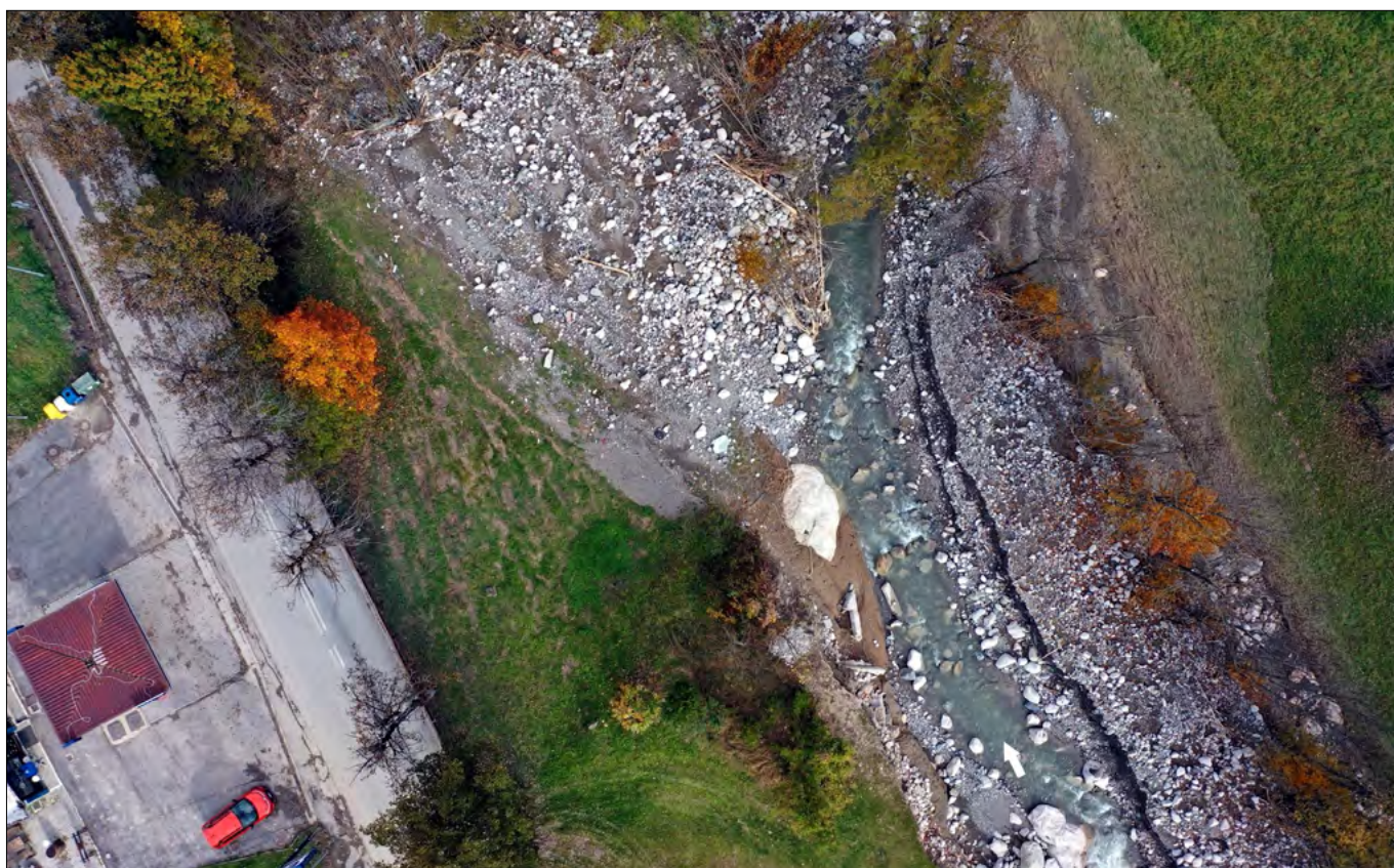
Figura 170. Limone Piemonte: ampiezza dell'area di deflusso del T. Vermenagna a valle di loc. Fantino, di fronte al distributore Europam (a sinistra nella fotografia). In tale sito è stata ricostruita la sezione trasversale. Prima della piena, in tale tratto l'alveo canalizzato aveva un'ampiezza pari a 4,5 m, che si è ampliata di circa 10 volte (foto Eurodrone)
