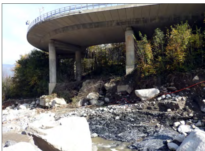
Figura 167. Vistose erosioni lungo le sponde del T. Vermenagna, poco a valle dell'immissione del Rio Panice e del nucleo di Tetti Mecci, a danno della stabilità di un pilastro di sostegno della strada statale n. 20 che risale il bacino fino al Colle di Tenda e al confine con il territorio francese; a destra il dettaglio dell'erosione alla base del pilone (foto Turconi).
