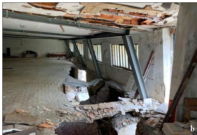
Figura 186. Effetti distruttivi a danno delle fondazioni di un edificio sito in via San Maurizio, in sinistra del T. Vermenagna, a valle del ponte della SS20 all'inizio del concentrico di Limone (per gentile concessione Vigili del Fuoco di Cuneo). A destra particolari dell'interno (foto Luino).
