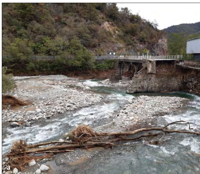
Figura 249. Cedimento della sede stradale lungo il torrente Strona di Postua.
