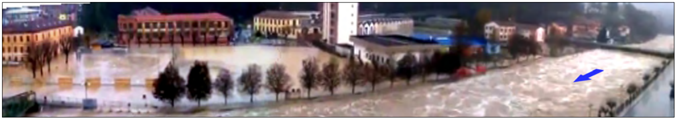
Figura 123. Ceva, pomeriggio del 24 novembre 2016. Collaggio di 4 frame tratto da un filmato. Il Tanaro in piena inondò ampiamente la sponda destra coinvolgendo le scuole, la caserma dei carabinieri, il parcheggio di Porta Tanaro e diverse altre infrastrutture.
