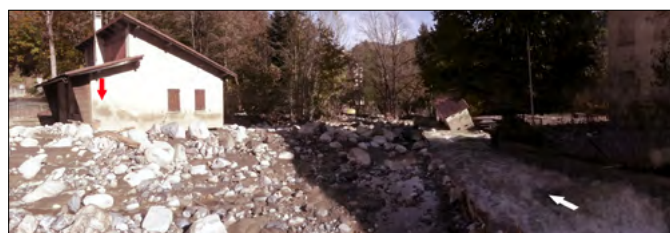
Figura 179. Diversi edifici lungo il T. Vermenagna sono stati distrutti, lesionati o invasi da acqua e detrito: la fascia di deflusso durante la piena si è più che decuplicata coinvolgendo le zone abitative (sia condomini, sia villette) molto prossime al corso d'acqua. Nell'immagine è possibile riconoscere l'ampiezza dell'alveo originaria (circa 3,5 m) e quella raggiunta dalla piena in grado di trasportare anche massi di notevoli dimensioni. La freccia rossa indica l'altezza raggiunta in tale punto della piena iperconcentrata (foto Turconi).
