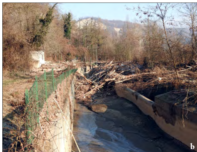
Figura 48. Effetti del passaggio della piena sul canale che conduce l'acqua alla centrale ENEL di Niella Tanaro nel 2020 (a) e nel 2016 (b) (entrambe foto Silvestro).
