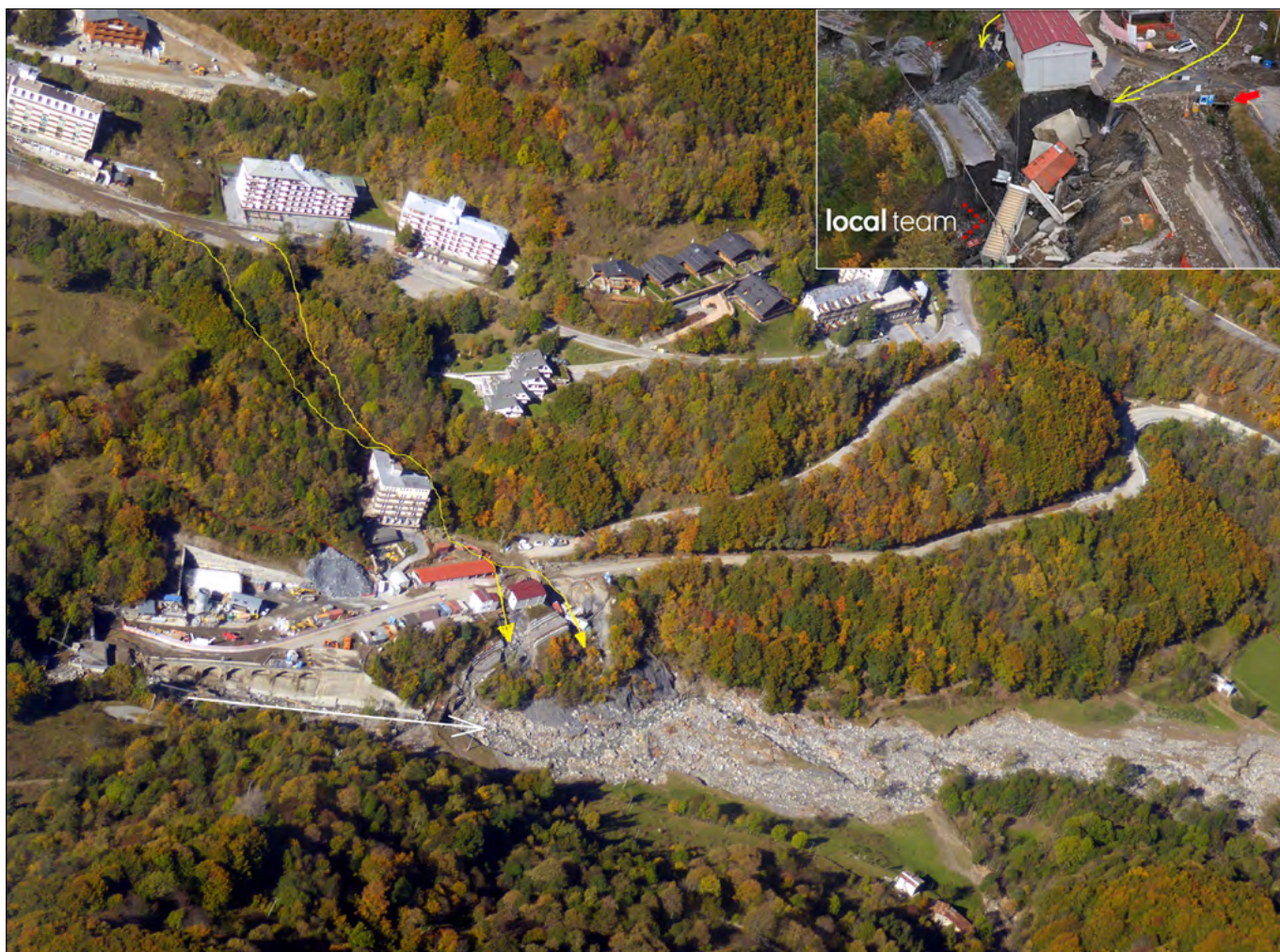
Figura 162. Un piccolo impluvio, convogliante le acqua provenienti dalla parte alta della frazione (linee gialle), tombinato presso il condominio (cfr. freccia rossa nel riquadro tratto da volo Local team), ha provocato l'interruzione dell'accesso al tunnel di passaggio italo-francese del Colle di Tenda, lato italiano. Il Rio Panice in piena iperconcentrata (freccia bianca), si è ampliato notevolmente, provocando evidenti erosioni spondali lungo l'alveo (foto Turconi).
