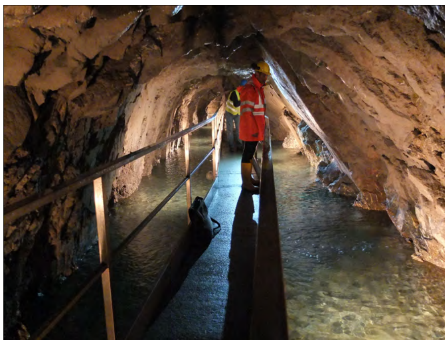
Figura 107. La captazione della sorgente del Colle di Tenda, caratterizzata da numerose venute idriche dall'ammasso fratturato.
