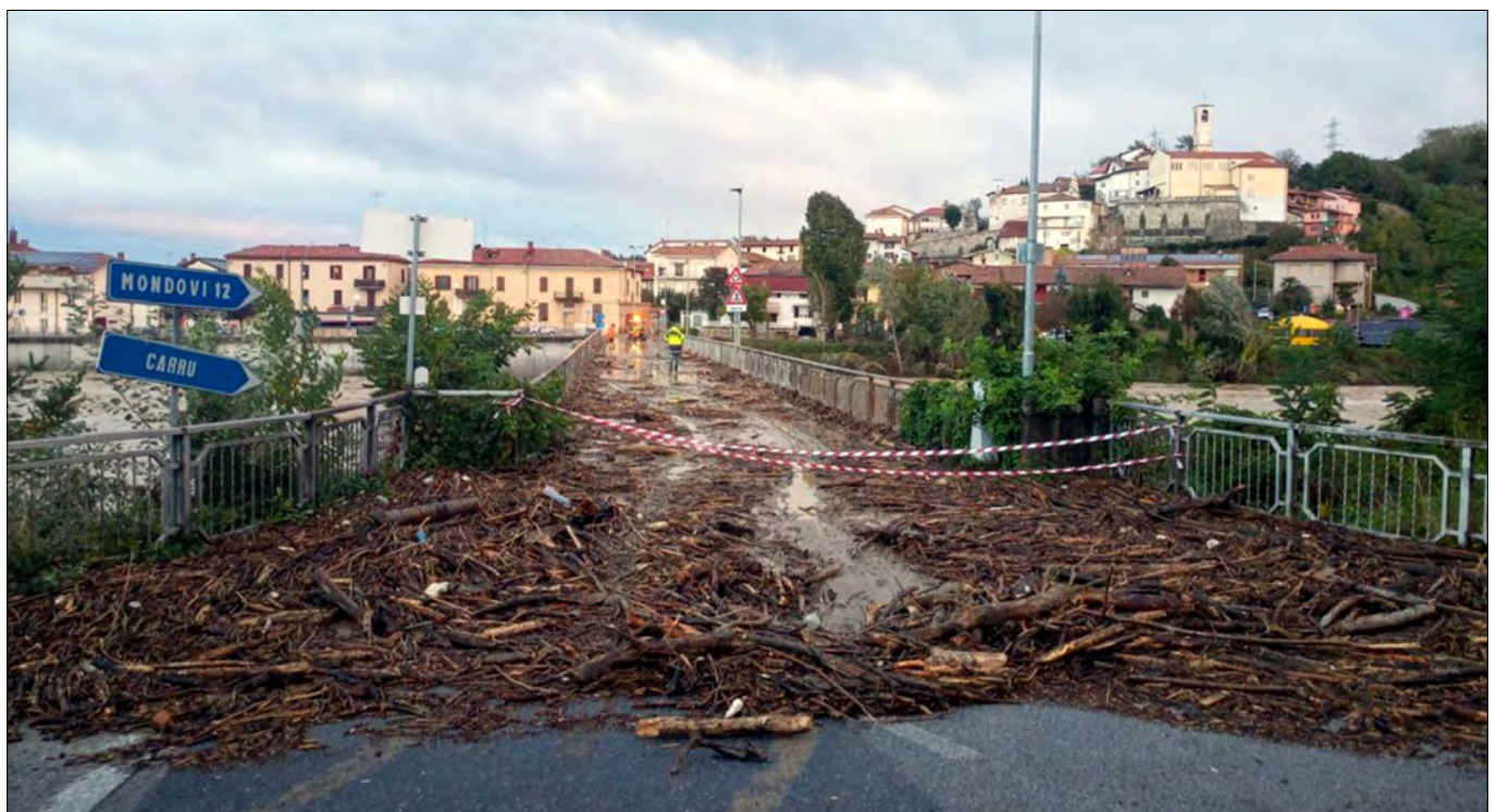
Figura 51. Bastia Mondovì: il ponte principale del paese ripreso dalla sponda sinistra, sabato 3 ottobre. (foto L'Unione Monregalese). Il rilevante materiale flottante depositato sulla strada testimonia l'altezza raggiunta dal livello del Tanaro.
