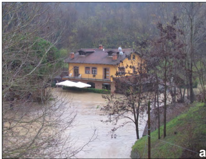
Figura 49. Comune di Niella Tanaro: ristorante Vecchio Mulino in sponda sinistra, a monte ponte della SP12. Nel 2016 fu alluvionato (foto Luino) con effetti analoghi a quelli del 2020; b) le acque nell'edificio, qui fotografato qualche settimana dopo l'evento, hanno raggiunto la sala da pranzo con altezze di 90-100 cm, mentre le cucine semi-interrate sono state completamente sommerse (foto Silvestro). Nel 1994 l'acqua arrivò poco sopra il davanzale del primo piano (livello indicato dalla freccia bianca, in alto a sinistra).
