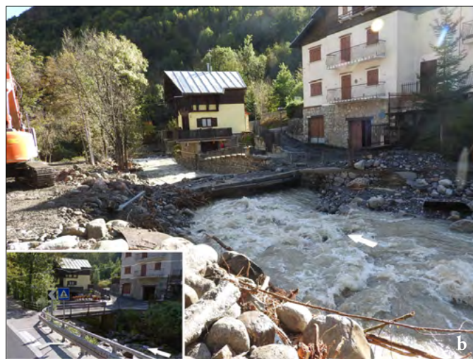
Figura 177. Edifici posti lungo il T. Vermenagna invasi da acqua, detrito fine e grossolano. Il corso d'acqua si è ampliato notevolmente sulla piana (a) su cui sorge gran parte dell'abitato di Limone, occupando quasi tutto il fondovalle (foto Luino). Sovente un ruolo negativo lo hanno svolto ponticelli di accesso alle abitazioni (b), aventi luce decisamente insufficiente (vedasi riquadro) che durante la piena hanno provocato uno sbarramento al deflusso e la sua diversione verso la strada (in sinistra) e le abitazioni (in destra)(foto Turconi).
