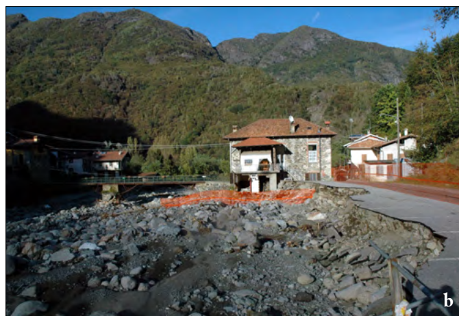
Figura 235. Morca (VC): a) fotografia da elicottero di frazione Solivo, in evidenza gli edifici danneggiati; b) l'Osteria dei Cacciatori il cui edificio è stato danneggiato dall'acqua e dai massi trasportati dalla corrente; è stato inoltre asportato in parte il parcheggio a monte.
