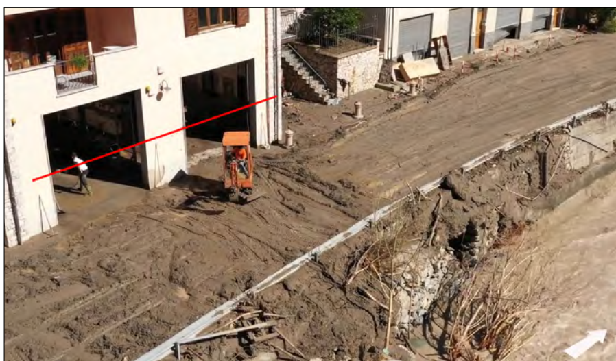
Figura 30b. Ponte di Nava: abitazioni in sinistra Tanaro, a pochi metri dalla sponda, inevitabilmente inondate sino al livello indicato durante la tarda serata del 2 ottobre 2020 (frame da volo drone GEDI Visual, modificato).
