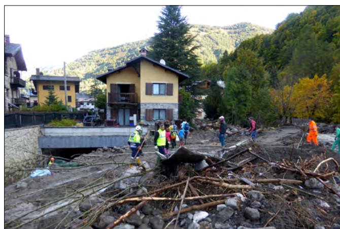
Figura 181. Effetti della piena del T. Vermenagna e dei tributari nelle aree edificate. I numerosi garage in sotterranea, così come moltissimi piani terreno degli edifici, sono stati colmati totalmente dalle acque ricche di apporti fangoso-detrifici che hanno reso molto difficoltoso il loro svuotamento con le pompe sommergibili (foto Turconi e Luino).
