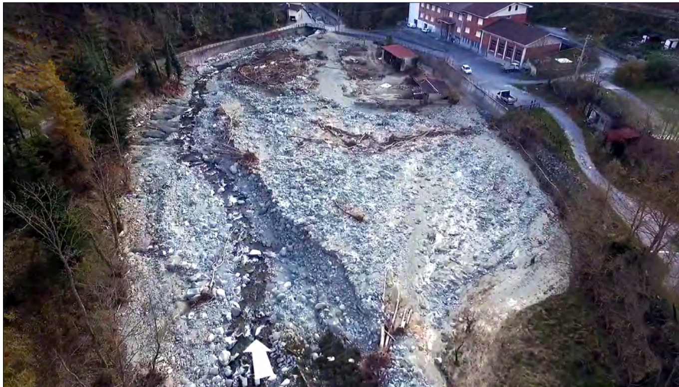
Figura 31. T. Armella presso le scuole medie (in alto a destra) di Ormea. A monte del primo ponte del paese il torrente si è allargato notevolmente, giungendo ad occupare un'area ampia circa 80 m prima di incunearsi sotto il ponte e scorrere nell'abitato (frame da volo drone Gemy Isan, modificato).
