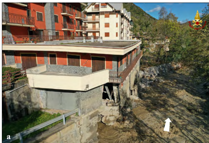
Figura 186. Effetti distruttivi a danno delle fondazioni di un edificio sito in via San Maurizio, in sinistra del T. Vermenagna, a valle del ponte della SS20 all'inizio del concentrico di Limone (per gentile concessione Vigili del Fuoco di Cuneo). A destra particolari dell'interno (foto Luino).
