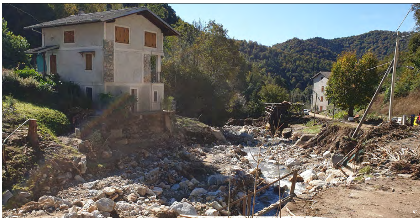
Figura 236. Camasco (VC): a) la nicchia di distacco da cui ha avuto origine la frana nel bacino del rio Nono e il canale riattivato (b); c) erosioni spondali accentuate con danni alla strada di fondovalle.
