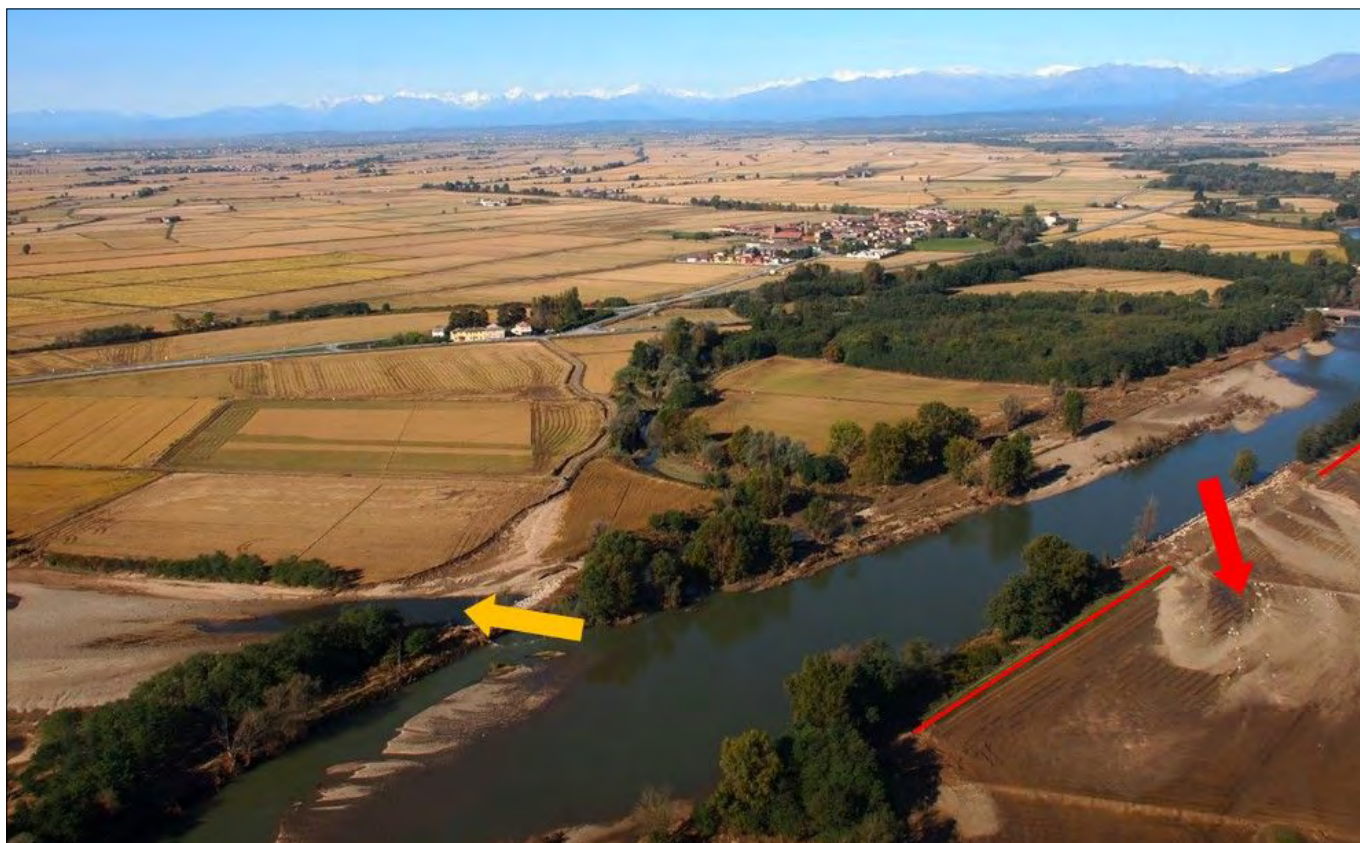
Figura 246. A valle del ponte di Quinto V. se la piena del torrente Cervo ha causato la rotta arginale in sinistra idrografica, indicata dalla freccia rossa, e l'allagamento dei campi coltivati. In destra, la freccia gialla indica il punto di esondazione delle acque del Cervo in piena.
