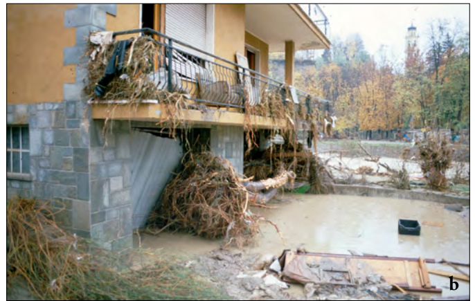
Figura 45. Ceva, Corso IV Novembre. Villetta in sponda sinistra, a pochi metri dall'alveo del Tanaro (che scorre oltre il muro d'argine realizzato nel 1995, evidenziato con la freccia rossa), gravemente danneggiata. Confronto dei danni e del livello raggiunto dalle acque: a) a sinistra 2-3 ottobre 2020 (foto Luino), l'altezza è indicata dalla freccia bianca; b) a destra, 5-6 novembre 1994 (foto Luino), le acque inondarono per circa un metro d'altezza l'appartamento al primo piano.
