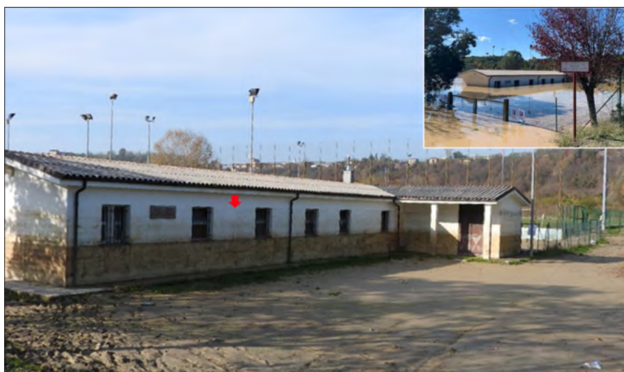
Figura 57. Ubicato a circa 20 m dalla sponda destra del Tanaro, l'edificio degli spogliatoi dei campi sportivi in località Gerino di Clavesana è stato ampiamente inondato come nel 2016: la freccia indica l'altezza raggiunta dalle acque (foto Silvestro). Nel riquadro, gli spogliatoi ripresi il sabato mattina 3 ottobre, con il livello delle acque già in fase di diminuzione (L'Unione Monregalese).
