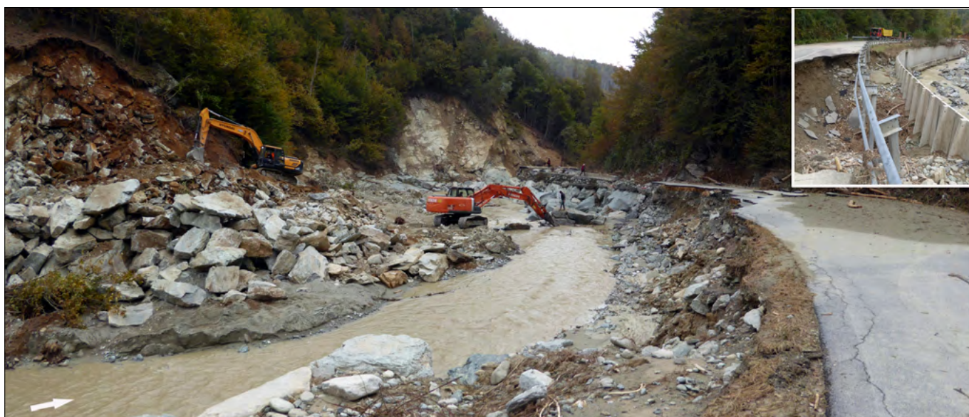
Figura 75. Ansa del T. Casotto presso Casa Sciandra: la strada provinciale è stata asportata per un lungo tratto dalle acque in piena del torrente, nello stesso punto ove fu danneggiata nel 1994 e nel 2016. Nel riquadro, particolare dell'erosione che ha portato a giorno i muri prefabbricati tipo Tensiter, posizionati dopo l'evento del novembre 2016.
