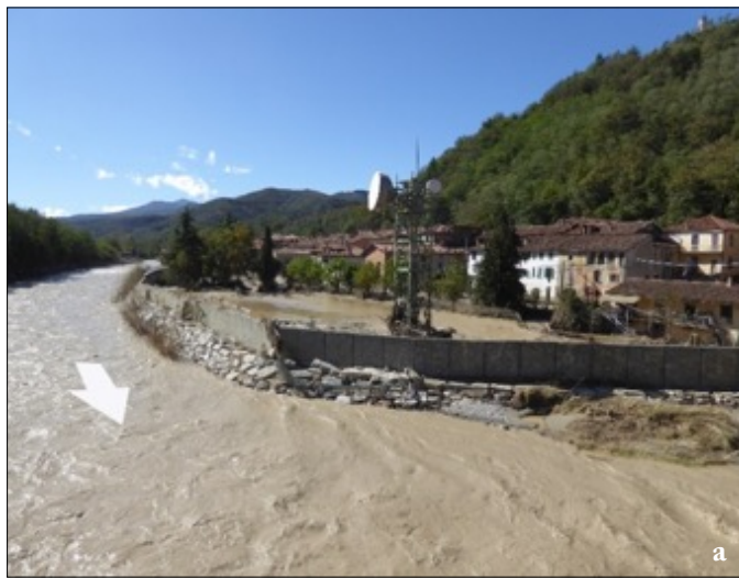
Figura 40a. Nucetto: immagini della zona prospiciente il Tanaro. In primo piano il lungo muro di contenimento, in sponda sinistra, realizzato per evitare l'esondazione (foto Luino).
