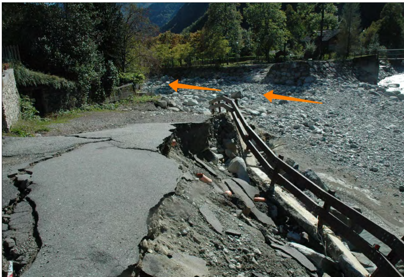
Figura 224. Riattivazione del canale secondario in prossimità di Campertogno.
