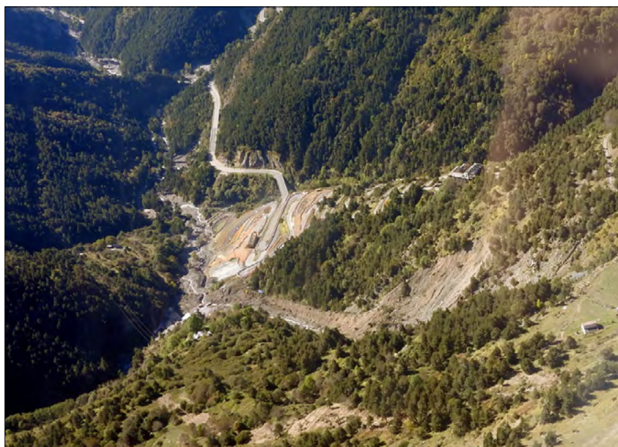
Figura 149. Effetti dannosi del flusso detritico che ha interrotto l'accesso al tunnel del Colle di Tenda di collegamento italo-francese (foto www.alpidoc.it ).
