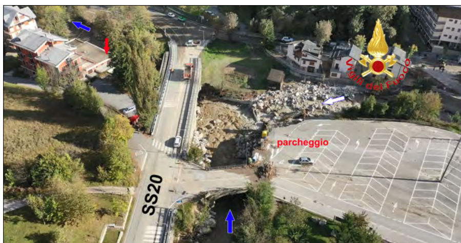
Figura 185. All'entrata dell'abitato di Limone P. vi è la confluenza Vermenagna-San Giovanni. Vista da drone degli effetti dannosi delle piene del 2 ottobre 2020: la freccia bianca indica l'asta del T. San Giovanni, mentre quella blu il T. Vermenagna. La freccia rossa evidenzia l'edificio lesionato nelle strutture portanti in sinistra del T. Vermenagna (cfr. figure successive) (per gentile concessione dei Vigili del Fuoco di Cuneo).
