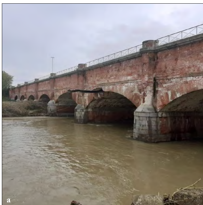
Figura 245. Pila del ponte del Canale Cavour crollata in seguito alla piena del torrente Cervo (f. a) da osservatoreitalia del 07/10/20 e f. b) da agromagazine del 14/10/20).
