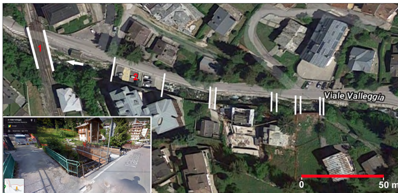
Figura 209. Rio San Giovanni nel tratto ove vi sono stati i maggiori danni. Nell'arco di soli 180 m sono presenti: 1) un ampio ponte ferroviario, 2) una copertura (che si sviluppa per 32 m) adibita a parcheggio ed entrata del condominio con tetto grigio, 3) 4 ponticelli in cemento di servitù privata della larghezza massima di 2 m. Le sezioni di deflusso, come si evince nell'immagine nel riquadro, erano decisamente insufficienti.
