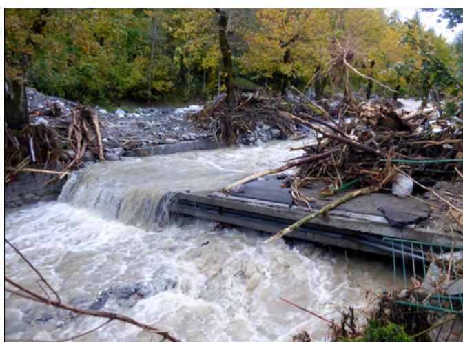
Figura 176. Effetti della piena del T. Vermenagna in corrispondenza della Bocciofila Limonese. Il percorso pedonale che si sviluppava in destra del corso d'acqua è stato completamente divelto e tutti gli attraversamenti sormontati o asportati anche a causa delle numerose ostruzioni al deflusso prodotte dall'ingente quantitativo di materiale vegetale (foto Luino).
