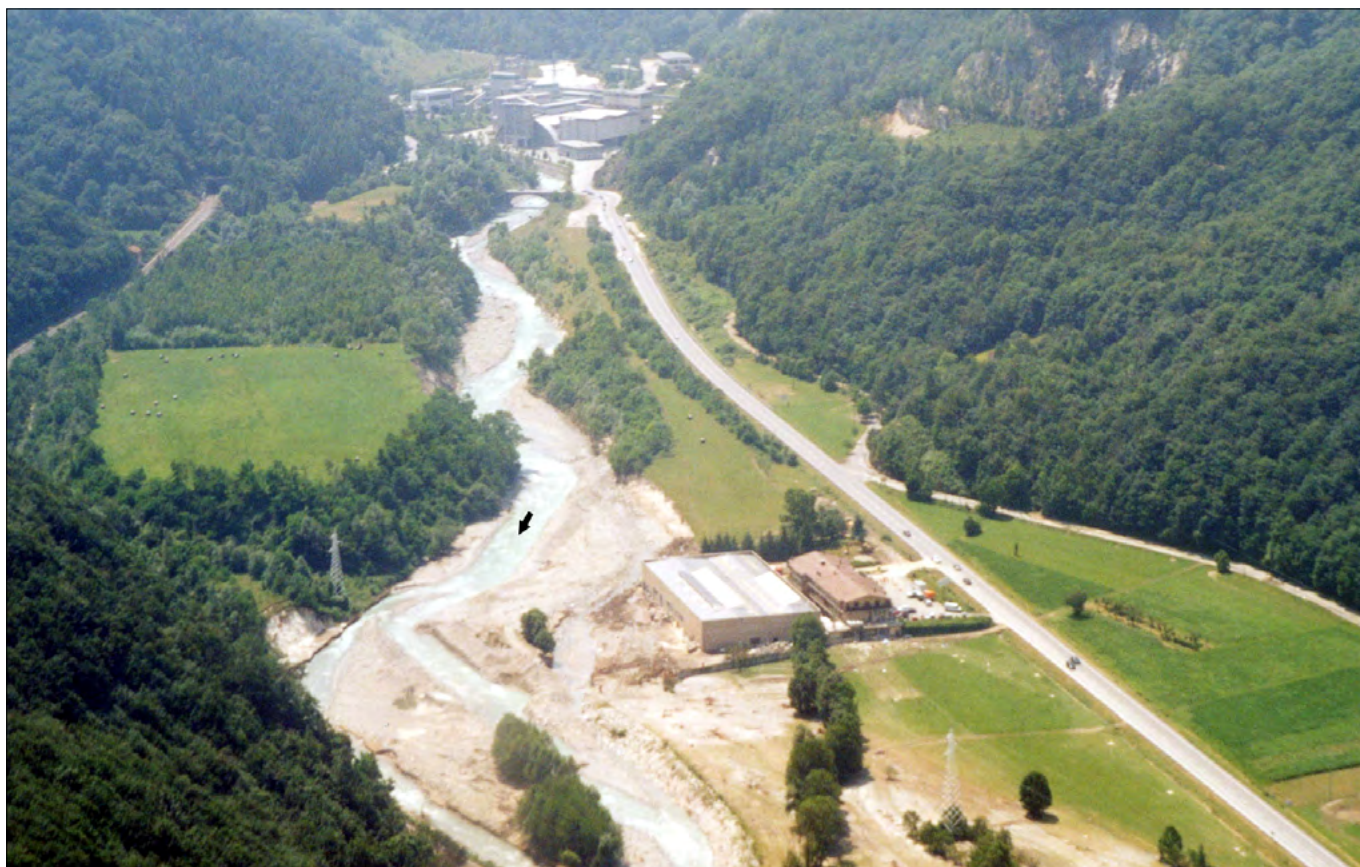
Figura 142. Robilante, luglio 2002: stabilimento Cuba (ora Venchi) sulla sponda sinistra del T. Vermenagna. Le acque raggiunsero il capannone, lesionandone uno spigolo.
