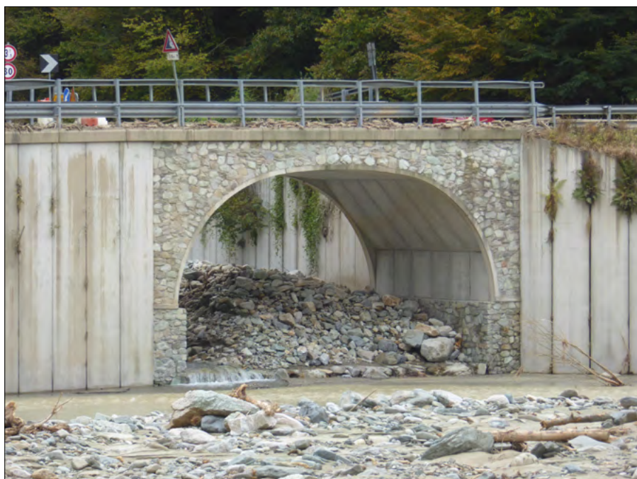
Figura 75. Ansa del T. Casotto presso Casa Sciandra: la strada provinciale è stata asportata per un lungo tratto dalle acque in piena del torrente, nello stesso punto ove fu danneggiata nel 1994 e nel 2016. Nel riquadro, particolare dell'erosione che ha portato a giorno i muri prefabbricati tipo Tensiter, posizionati dopo l'evento del novembre 2016.
