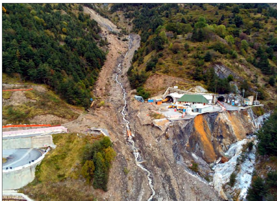
Figura 150. Soil slip in territorio francese, incanalatosi lungo impluvio laterale al cantiere di ampliamento del tunnel del Colle di Tenda (foto Turconi).
