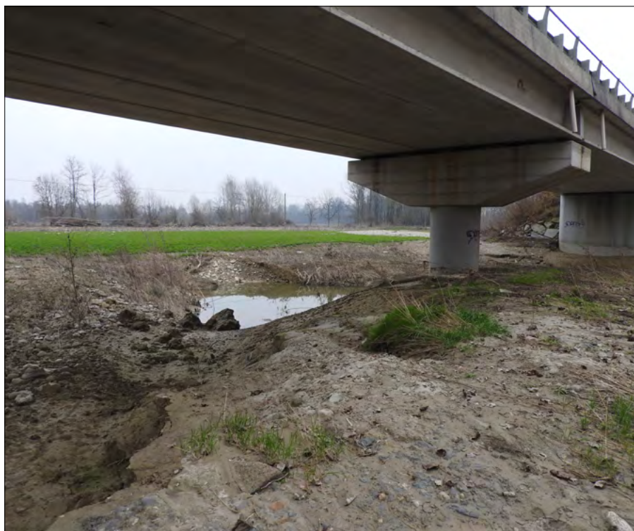
Figura 61. Il passaggio appositamente creato nel rilevato della SP7, per consentire il transito dell'acqua che esonda sulla sponda destra a monte del ponte di Pollenzo, ha funzionato egregiamente anche durante questo evento (foto Silvestro).
