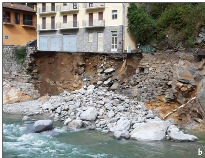
Figura 240. Rosazza: a) danni a un edificio adiacente il ponte di Vittone crollato per il transito della piena; b) erosione per tracimazione in regione Fornaca.
