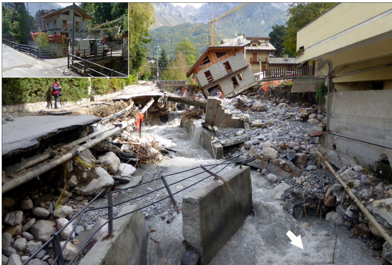
Figura 191. Effetti erosivi connessi alla piena del T. San Giovanni a danno di manufatti di attraversamento e di edifici prossimi all'alveo. I danni più evidenti sono riferibili ad un edificio in corso di ristrutturazione che ha subito il collasso delle opere di fondazione, per scalzamento e aggiramento a monte, da parte dell'ingente portata in transito ostruita nel deflusso dai numerosi attraversamenti occlusi da materiale vegetale e lapideo. L'edificio avanzava lungo la sponda attiva del torrente in modo verosimilmente non congruo allo smaltimento di portate anche solo ordinarie (cfr. riquadro)(foto Luino).
