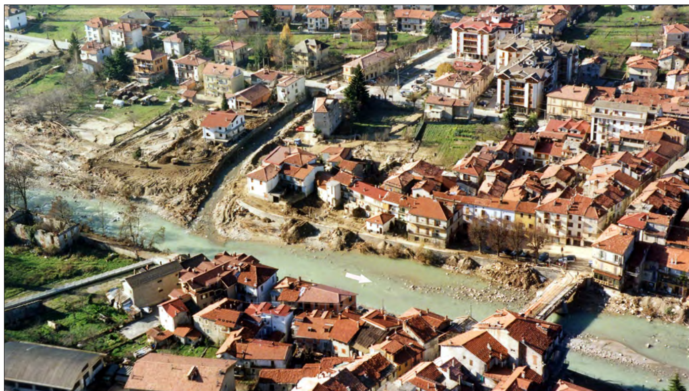
Figura 112. Garessio, 9 novembre 1994. Vista aerea del concentrico, la zona maggiormente colpita dall’inondazione: alveo del Tanaro e confluenza sinistra del Rio Luvria (foto Luino).
