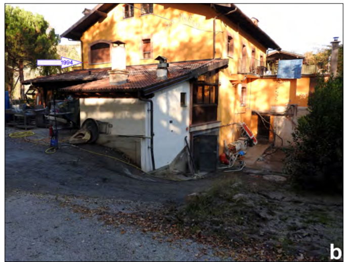
Figura 49. Comune di Niella Tanaro: ristorante Vecchio Mulino in sponda sinistra, a monte ponte della SP12. Nel 2016 fu alluvionato (foto Luino) con effetti analoghi a quelli del 2020; b) le acque nell'edificio, qui fotografato qualche settimana dopo l'evento, hanno raggiunto la sala da pranzo con altezze di 90-100 cm, mentre le cucine semi-interrate sono state completamente sommerse (foto Silvestro). Nel 1994 l'acqua arrivò poco sopra il davanzale del primo piano (livello indicato dalla freccia bianca, in alto a sinistra).
