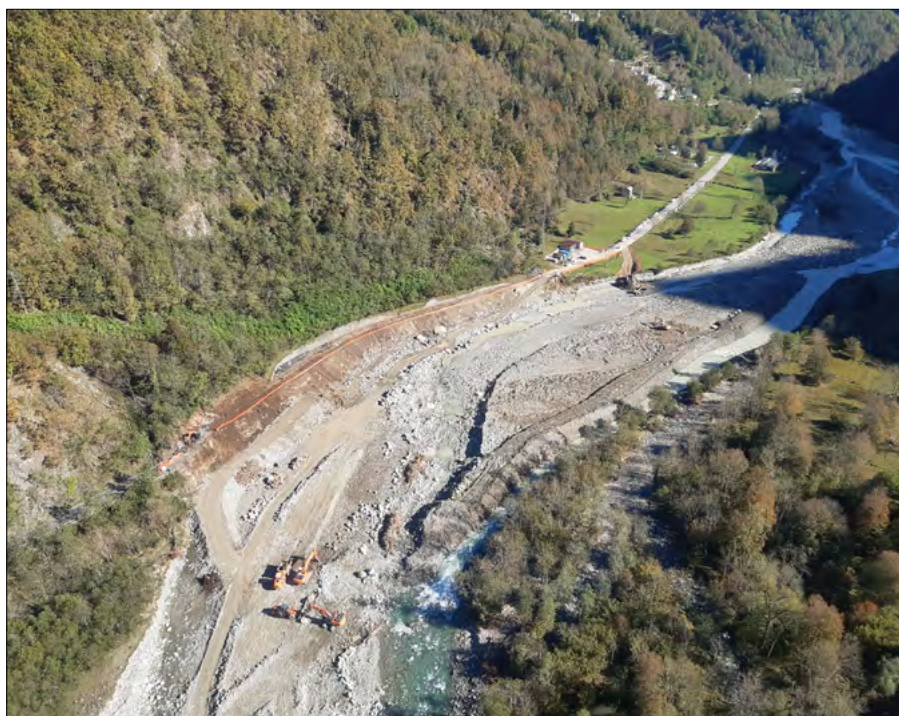
Figura 234. Cravagliana (VC) località Pian delle Fate: il tratto di strada di fondovalle eroso dalla corrente che ha determinato l'isolamento dell'intera valle.
