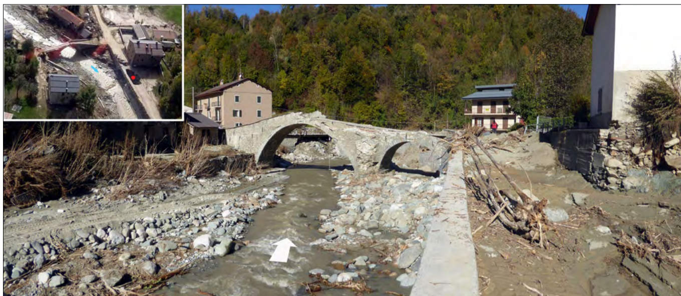
Figura 74. Pamparato. L'antico ponte romano ( 44^{\circ}16'36.44''N 7^{\circ}54'37.83''E ), simbolo del centro abitato, è stato sormontato e parzialmente danneggiato, ma ha comunque resistito all'impatto dell'ennesima piena del T. Casotto (foto Luino). Nel riquadro (foto Arpa Piemonte) si può notare il sifonamento subito dal muro di contenimento che ha provocato un'ampia cavità (pallino rosso) nella strada provinciale.
