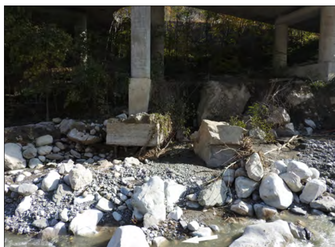
Figura 167. Vistose erosioni lungo le sponde del T. Vermenagna, poco a valle dell'immissione del Rio Panice e del nucleo di Tetti Mecci, a danno della stabilità di un pilastro di sostegno della strada statale n. 20 che risale il bacino fino al Colle di Tenda e al confine con il territorio francese; a destra il dettaglio dell'erosione alla base del pilone (foto Turconi).
