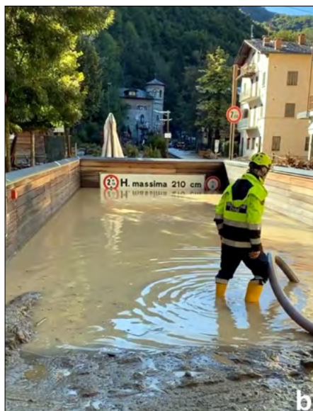
Figura 181. Effetti della piena del T. Vermenagna e dei tributari nelle aree edificate. I numerosi garage in sotterranea, così come moltissimi piani terreno degli edifici, sono stati colmati totalmente dalle acque ricche di apporti fangoso-detrifici che hanno reso molto difficoltoso il loro svuotamento con le pompe sommergibili (foto Turconi e Luino).
