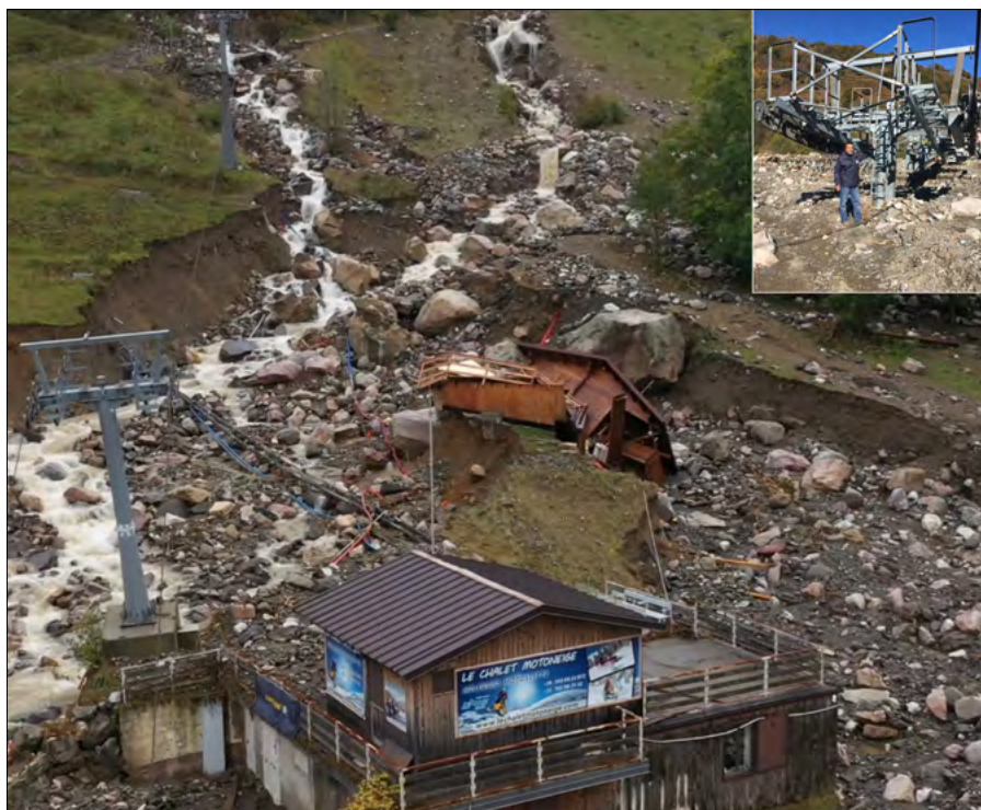
Figura 154. Vista verso monte del settore di transito delle miscele detritiche provenienti dalla coalescenza delle Valli Salauta e San Lorenzo, che con elevato potere erosivo hanno raggiunto il piazzale della seggiovia Morel (foto tratta da volo con drone di Local Team). Nel riquadro il primo pilone della seggiovia ricoperto per oltre un terzo della propria altezza dai detriti lapidei (foto Turconi).
