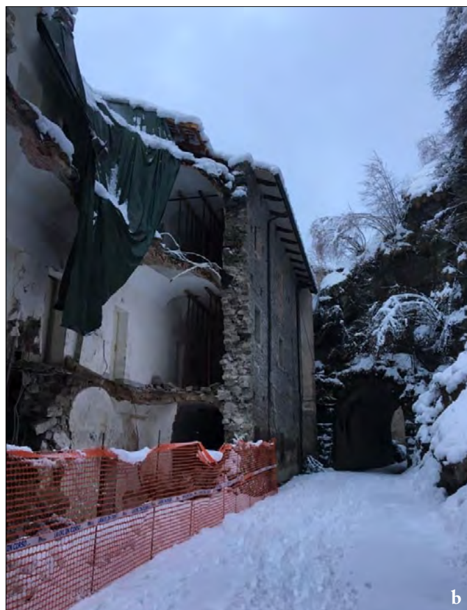
Figura 247. a) La frana di crollo staccatasi dalla parete rocciosa retrostante il perimetro del Santuario di San Giovanni; b) l'immagine mette in evidenza la gravità del danno arrecato all'ala dei Pellegrini dopo l'asportazione del materiale lapideo crollato (f. da Primabiella del 06/01/21).
