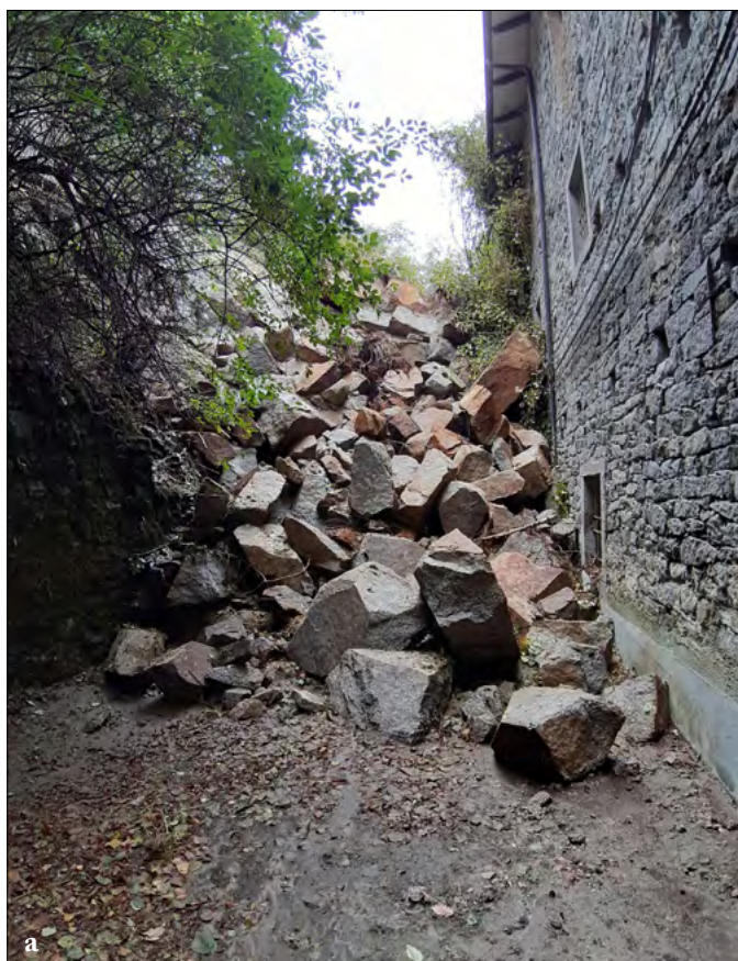
Figura 247. a) La frana di crollo staccatasi dalla parete rocciosa retrostante il perimetro del Santuario di San Giovanni; b) l'immagine mette in evidenza la gravità del danno arrecato all'ala dei Pellegrini dopo l'asportazione del materiale lapideo crollato (f. da Primabiella del 06/01/21).
