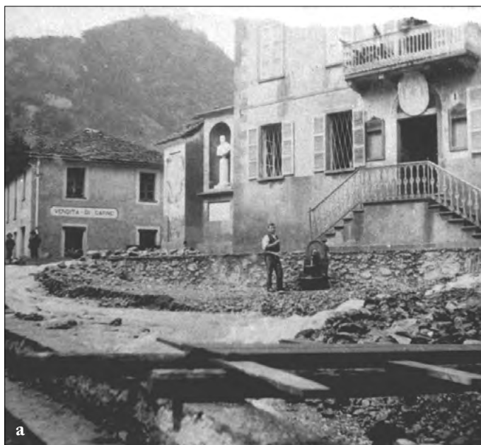
Figura 233. Fobello (VC): a) nella foto d'epoca scattata a seguito dell'alluvione del maggio 1923 (archivio Arpa Piemonte), si vedono le acque del rio Montà, provenienti dal versante dietro gli edifici, causare profonde erosioni davanti al Municipio in via Roma; b) lo stesso corso d'acqua durante la piena di ottobre 2020 ha dato vita ad una colata detritica interessando le medesime aree del 1923 nel concentrico. Nell'immagine a destra, è stato evidenziato in marrone il percorso della colata.
