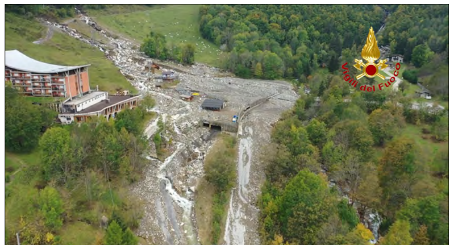
Figura 153. Limonetto, piazzale della seggiovia Morel. Vista dall'alto del vasto accumulo lapideo che provenendo dai valloni Salauta e San Lorenzo ha ricoperto con oltre 5-6 metri di detrito la zona di partenza degli impianti (per gentile concessione Vigili del Fuoco di Cuneo). Dettaglio in figura 152C.
