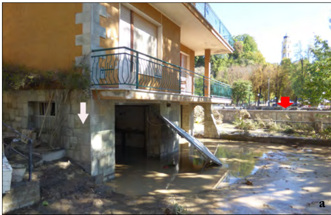
Figura 45. Ceva, Corso IV Novembre. Villetta in sponda sinistra, a pochi metri dall'alveo del Tanaro (che scorre oltre il muro d'argine realizzato nel 1995, evidenziato con la freccia rossa), gravemente danneggiata. Confronto dei danni e del livello raggiunto dalle acque: a) a sinistra 2-3 ottobre 2020 (foto Luino), l'altezza è indicata dalla freccia bianca; b) a destra, 5-6 novembre 1994 (foto Luino), le acque inondarono per circa un metro d'altezza l'appartamento al primo piano.
