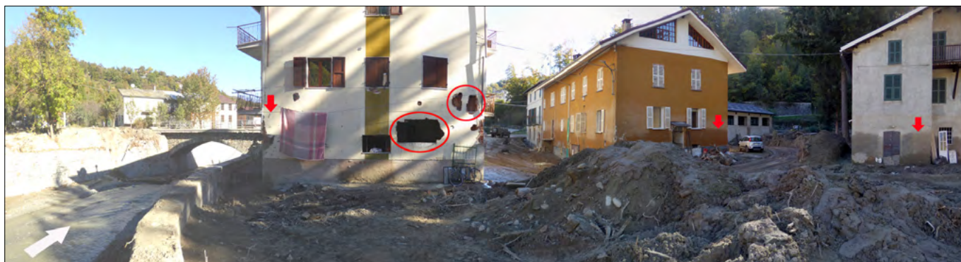
Figura 71. Pamparato, centro paese. La parte lungo l'alveo, in sponda destra a monte del ponte di Via Riviera, è stata invasa con un tirante che ha sfiorato e talora raggiunto i primi piani delle case, come indicato dalle tre frecce rosse. I cerchi rossi indicano i punti di impatto di tronchi di alto fusto che hanno sfondato o lesionato i muri perimetrali dell'edificio (foto Luino).
