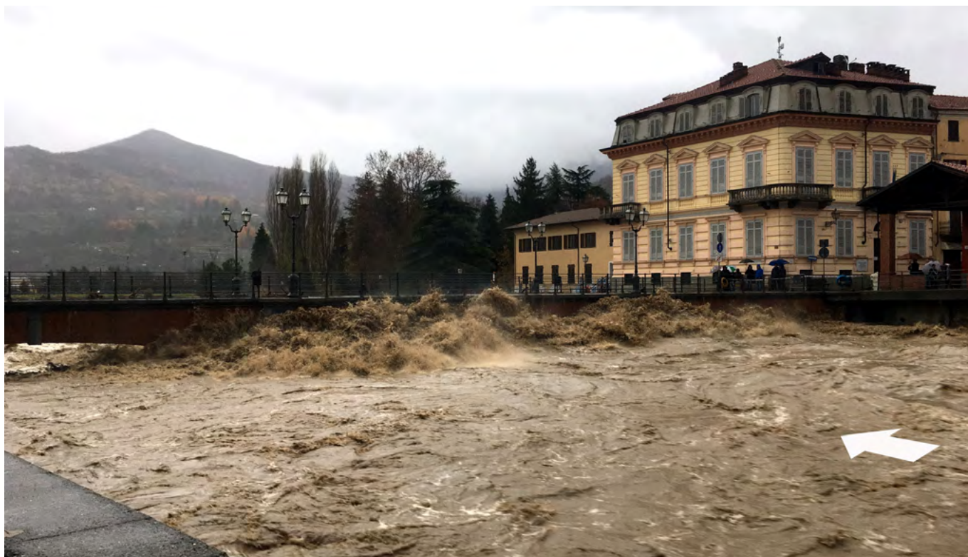
Figura 113. Garessio, 24 novembre 2016, ore 9:45. Le acque del Tanaro in piena stavano lambendo il Ponte Odasso. Nelle ore successive sormonteranno nuovamente la massiccia opera di attraversamento ed invaderanno il centro abitato (foto Luino).
