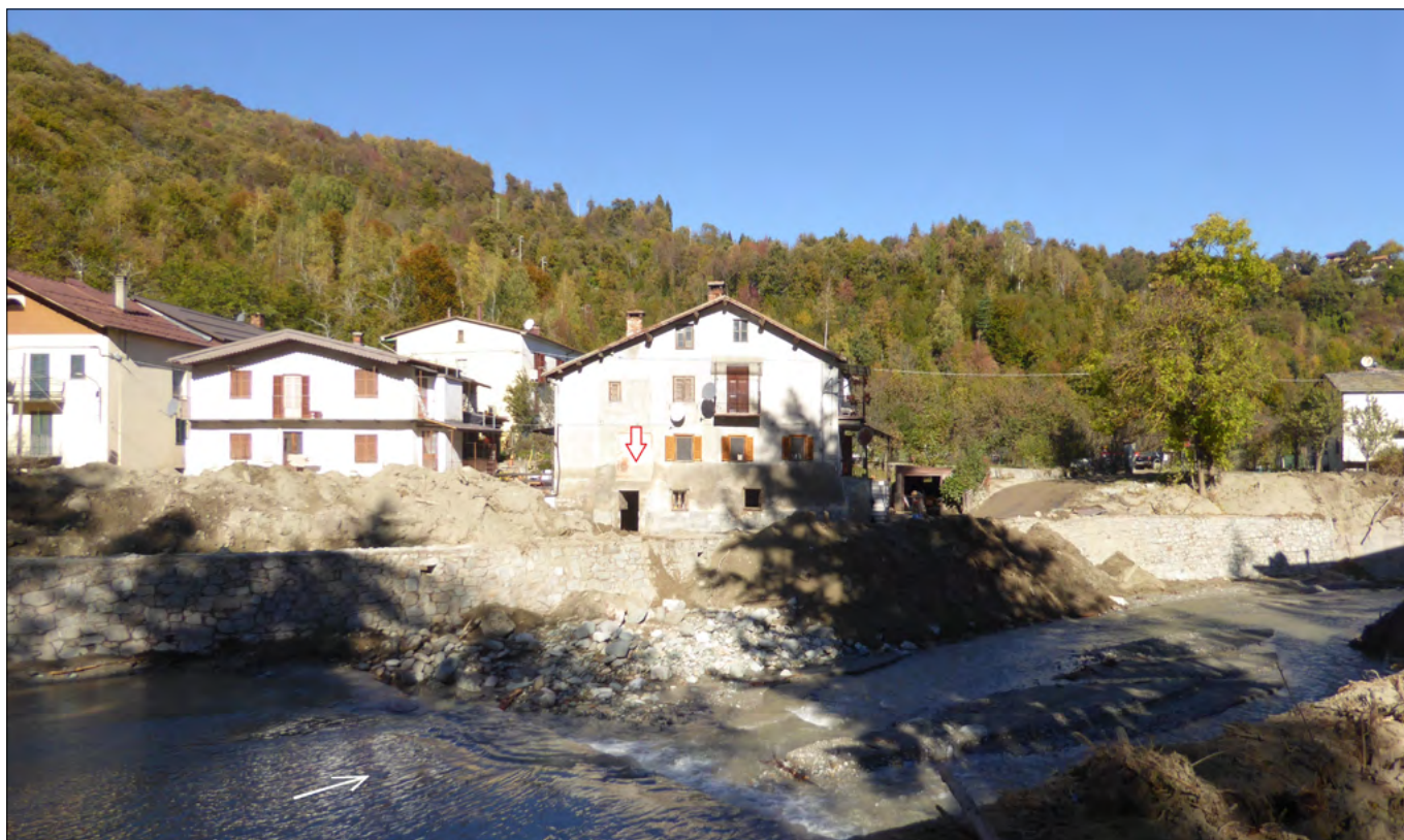
Figura 72. Pamparato: case sulla sponda sinistra gravemente inondate per altezze ampiamente superiori a 3 m, come evidenziato dalle tracce sui muri perimetrali (freccia rossa)(foto Turconi).
