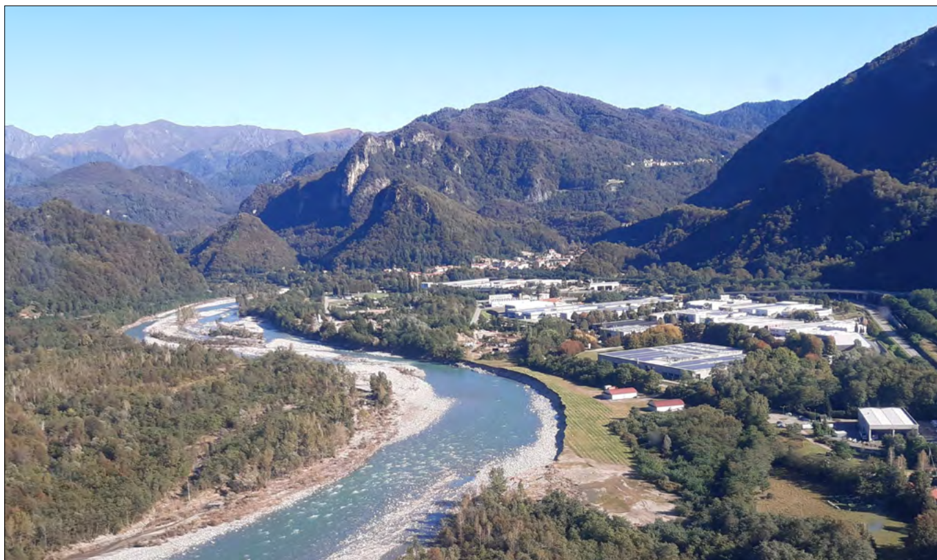
Figura 227. Roccapietra (VC): Zona industriale di Roccapietra, ripresa da valle a monte qualche giorno dopo l'evento. In primo piano è evidente la profonda erosione di sponda che ha causato l'asportazione di gran parte del terreno su cui insiste l'avo superficie.
