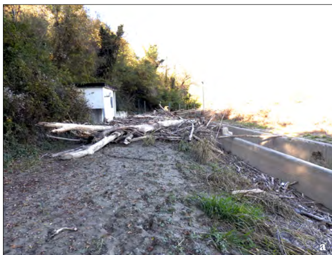
Figura 48. Effetti del passaggio della piena sul canale che conduce l'acqua alla centrale ENEL di Niella Tanaro nel 2020 (a) e nel 2016 (b) (entrambe foto Silvestro).
