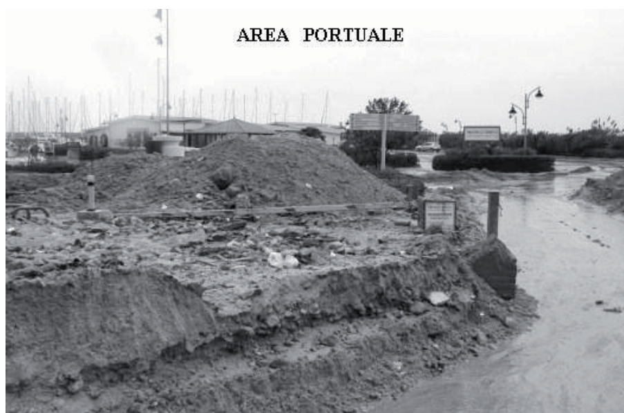
Figura 12 – Accumulo di detriti eterogenei nel porto di Tropea a seguito dell'esondazione delle acque dei Torrenti Burmaria e della Grazia.
