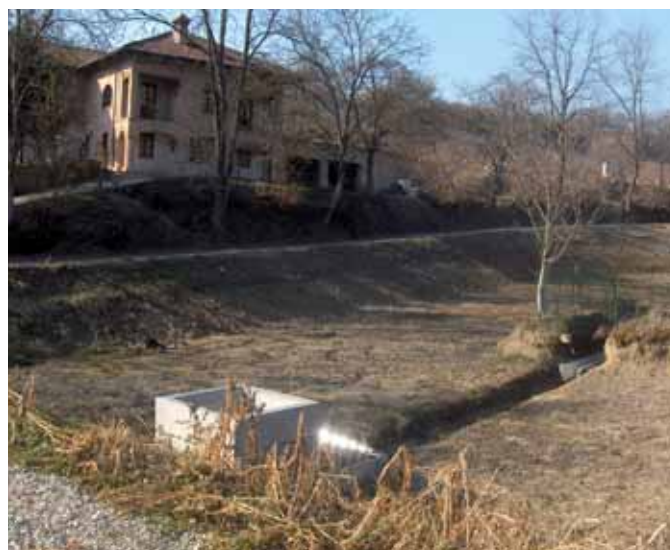
Figura 4 – Scarico di superficie dell'opera. In primo piano il rilevato arginale
