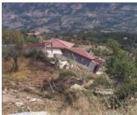
Figura 2 – Agriturismo gravemente danneggiato nel quartiere San Benedetto.
