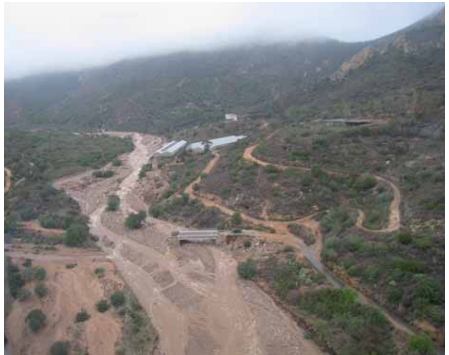
Foto 8 - La zona del ponte per l'eremo di San Girolamo (Foto Protezione Civile - Ing. Cicalò).
