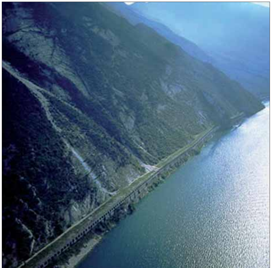
Figura 1 – Tratto di interesse con galleria paramassi artificiale tra le progr. km 89+550 e 90+900.
