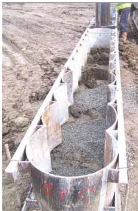
Figura 15 – Trave guida e pali secanti a Riana.
