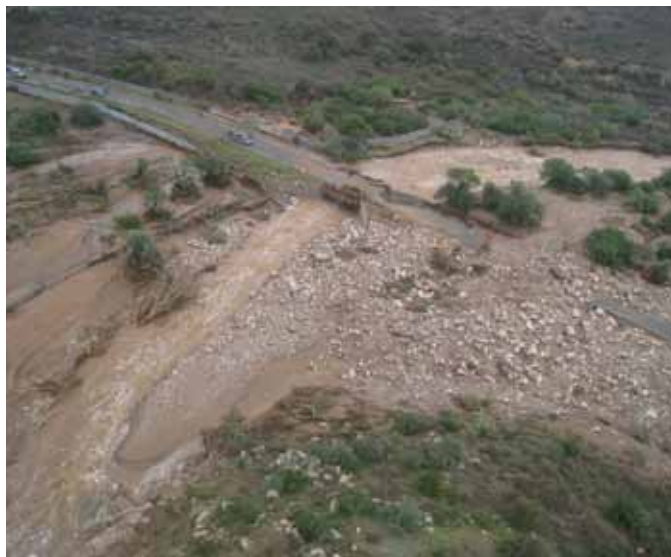
Foto 9 e Foto 10 - Le zone di sedimentazione dei detriti trasportati dal fiume sono occupate dalle infrastrutture stradali: a destra il ponte a valle dell'Hydrocontrol completamente distrutto. I depositi fluviali sono formati in prevalenza da massi e pietrame vario e in minor misura da sabbia.
