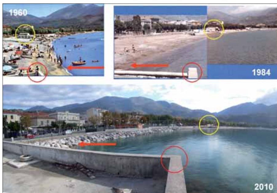
Fig. 9 – Report fotografico (1960 - 2010) del settore di litorale maggiormente eroso; le frecce indicano i capisaldi di riferimento; il tratteggio la linea di costa al 1960.
