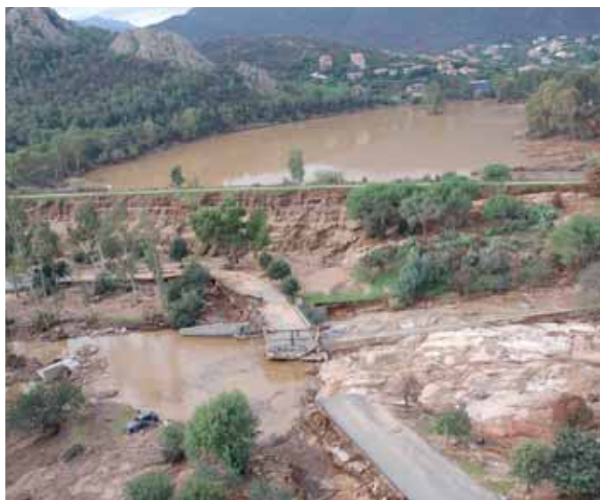
Foto 13 e Foto 14 - La zona della diga in terra di Poggio dei Pini: il canale di scarico la mattina del 22 ottobre erode il rilevato del ponte e la diga tracimata ha il paramento eroso, a destra si vede anche il quarto ponte distrutto (Foto Protezione Civile - Ing. Cicalò - Foto Genio Civile - Dr. G. Novella)
