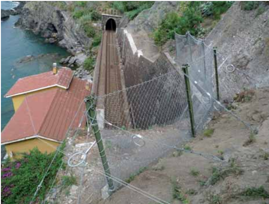
Figura 16 – La barriera SL protegge la linea ferroviaria presso Vernazza (SP).
