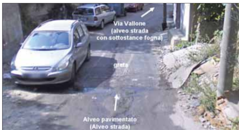
Figura 12 – La grata che separa l'alveo strada pavimentato, proveniente da monte, che si immette nella Via Vallone. La grata, nelle intenzioni di coloro che l'hanno realizzata, dovrebbe inghiottire l'acqua, il fango e i detriti che affluiscono verso valle.
