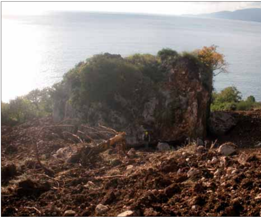
Figura 5 – Panoramica del blocco franato.
