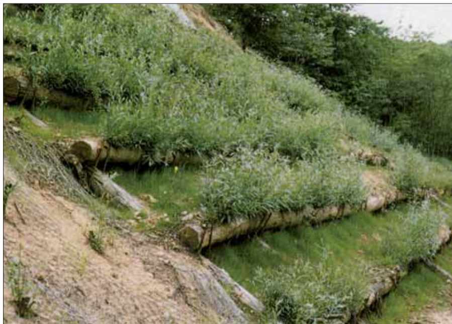
Figura 1 – Grata viva a Cadibona (SV) (da F.Boccalaro, 1994).
