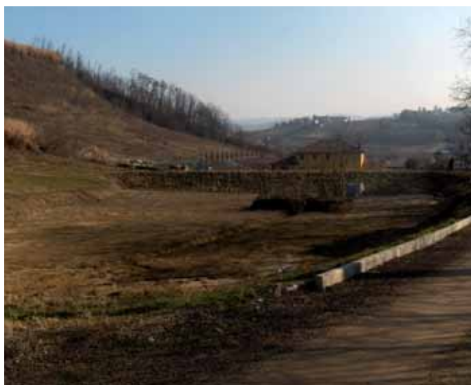
Figura 3 – Panoramica dell'invaso realizzato.
