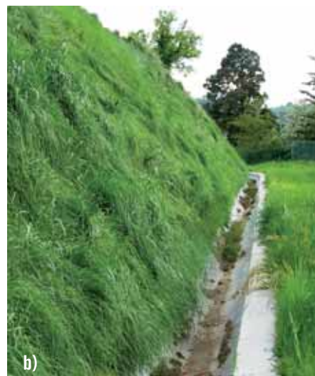
Figura 6. Orvieto (Terni) - SP111 della Badia: a) canaletta intasata (foto settembre 2005); b) canaletta pulita (foto maggio 2006).
