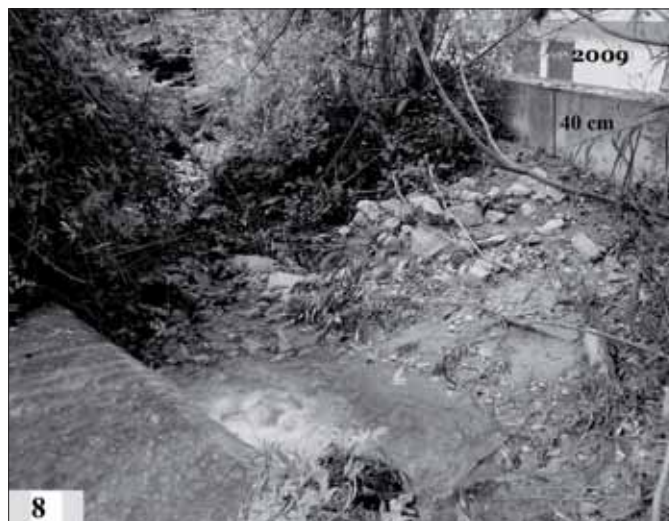
Figura 7 e 8 – Torrente della Grazia: accumulo di sedimenti in prossimità del muro perimetrale di monte dell'impianto di depurazione nel periodo intercorso tra il 2003 (Fig. 7) e il 2009 (Fig. 8).
