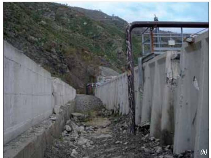
Figura 9 (a, b) – Corpo di frana (a) ed effetti sul muro di protezione e sul depuratore (b).
