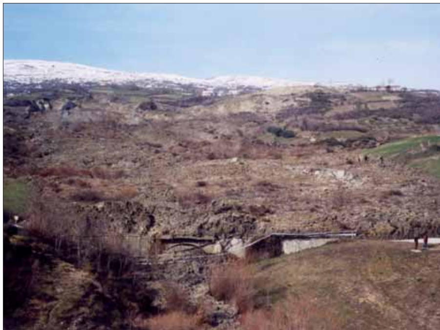
Figura 8 – Il ponte San Nicola poco prima di essere totalmente ricoperto dalla colata.
