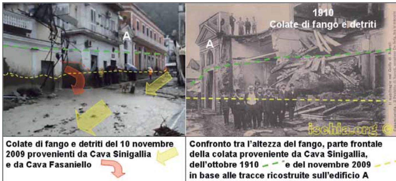
Figura 19: Confronto tra gli effetti ambientali delle colate di fango riversatesi nell'alveo strada all'altezza di Piazza Bagni di Casamicciola Terme durante gli eventi del 10 novembre 2009 (linea gialla tratteggiata e linea rossa tratteggiata nella foto a sinistra) e dell'ottobre 1910 (linea verde. La lettera A individua la cappella presente nelle due immagini).
