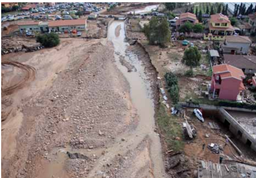
Foto 22 – La zona della lottizzazione Rio San Girolamo dove sorge la scuola materna, visibile sulla sinistra in alto nella foto (Foto Genio Civile – Dr. Novella).
