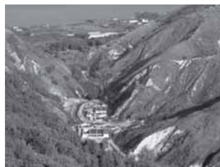
Figura 6 – Impianto di depurazione fognario edificato all'interno del greto del Torrente della Grazia.
