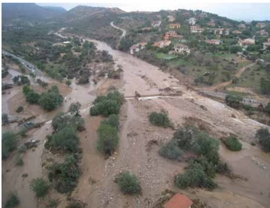
Foto 12 - Il ponte sulla strada vicinale S. Barbara in coda al lago di Poggio dei Pini, è ben visibile l'estensione del conoide (Foto Protezione Civile - Ing. Cicalò).
