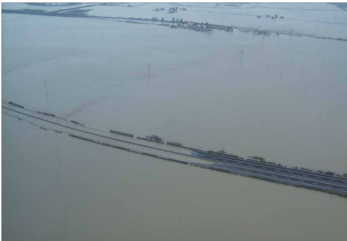
Figura 1 – Evento marzo 2005: esondazione del fiume Fortore con allagamento dell'autostrada A14 della linea ferroviaria adriatica e della stazione ferroviaria di Ripalta (foto: Regione Puglia).
