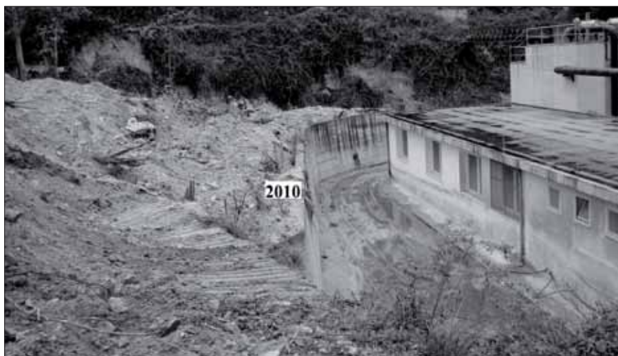
Figura 7 e 8 – Torrente della Grazia: accumulo di sedimenti in prossimità del muro perimetrale di monte dell'impianto di depurazione nel periodo intercorso tra il 2003 (Fig. 7) e il 2009 (Fig. 8).
