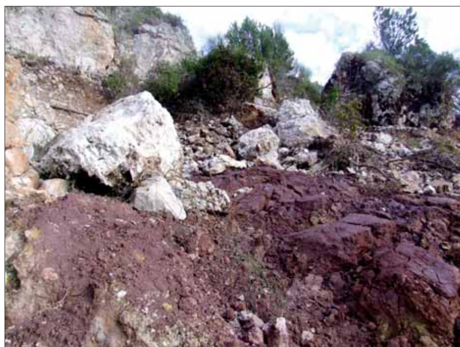
Figura 9 – Dettaglio del piano d'appoggio del blocco franato.
