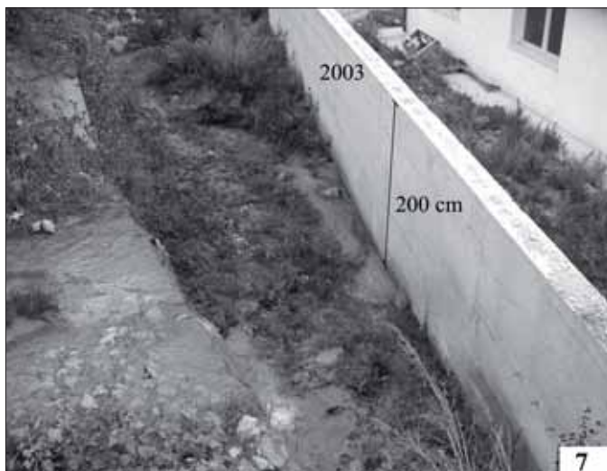
Figura 7 e 8 – Torrente della Grazia: accumulo di sedimenti in prossimità del muro perimetrale di monte dell'impianto di depurazione nel periodo intercorso tra il 2003 (Fig. 7) e il 2009 (Fig. 8).
