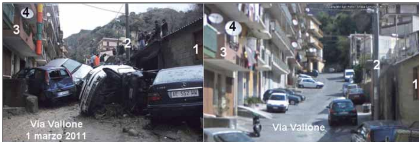
Figura 16: Via Vallone a valle del sito f indicato in figura 9 prima (foto a destra) e dopo lo scorrimento dei flussi detritico-fangosi che hanno trascinato numerose autovetture causandone l'accatastamento in un restringimento della strada. I numeri evidenziano gli stessi soggetti ripresi nelle due foto.
