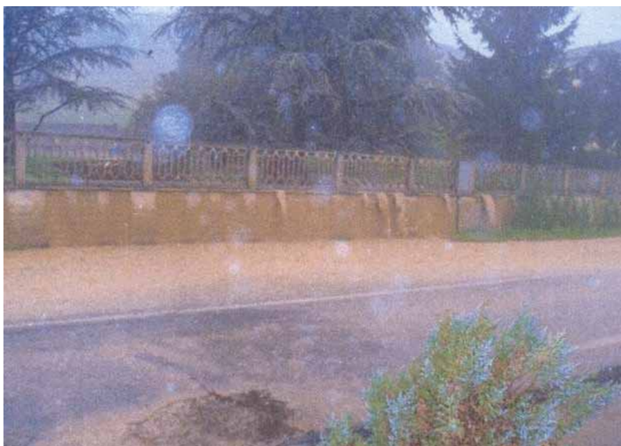
Figura 6 – Effetti delle piogge intense in corrispondenza di edifici di civile abitazione e della S.P. 59.
