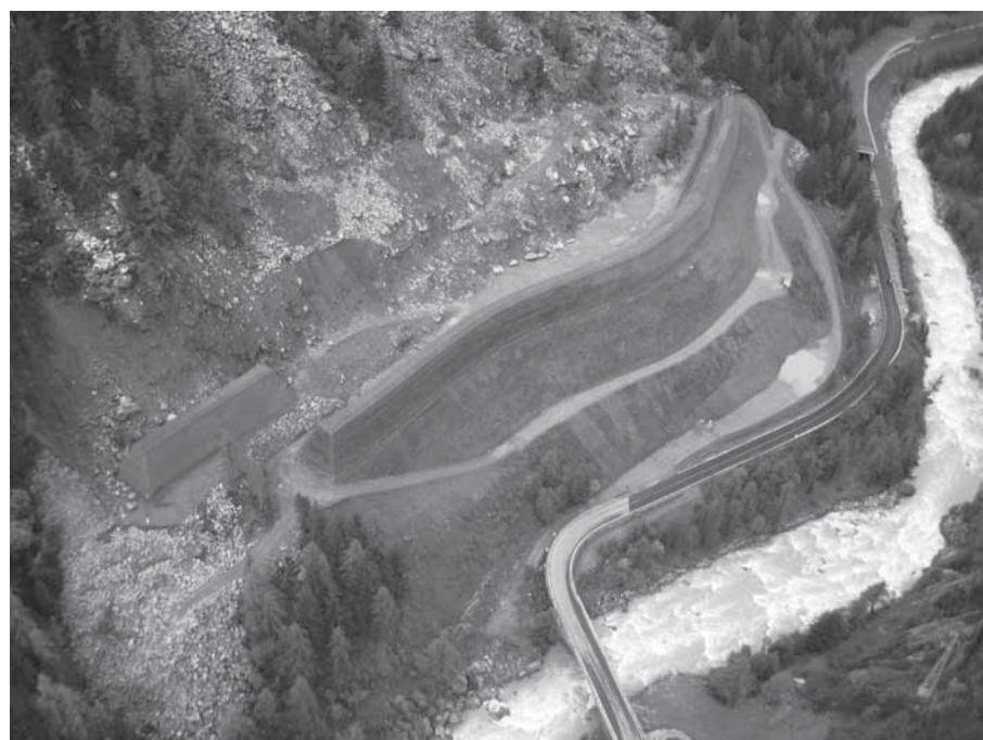
Fig. 1 Sguardo d'insieme del Rilevato Paramassi Realizzato.
