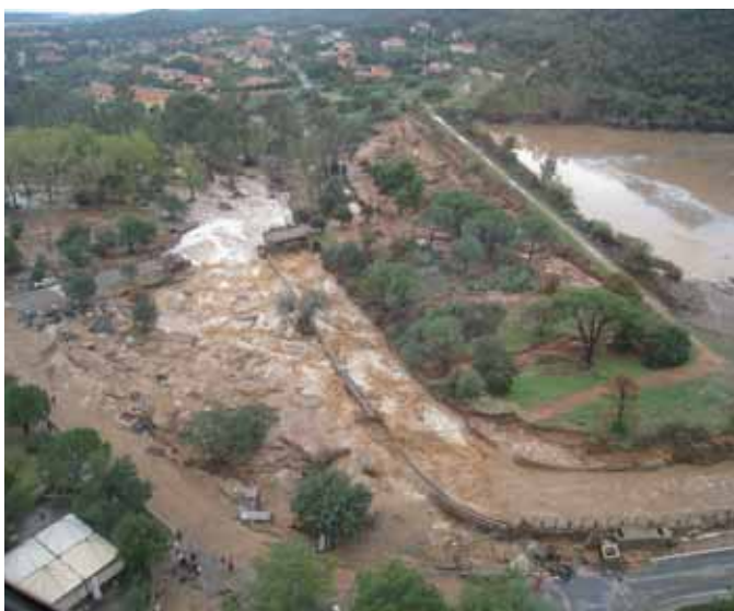
Foto 13 e Foto 14 - La zona della diga in terra di Poggio dei Pini: il canale di scarico la mattina del 22 ottobre erode il rilevato del ponte e la diga tracimata ha il paramento eroso, a destra si vede anche il quarto ponte distrutto (Foto Protezione Civile - Ing. Cicalò - Foto Genio Civile - Dr. G. Novella)
