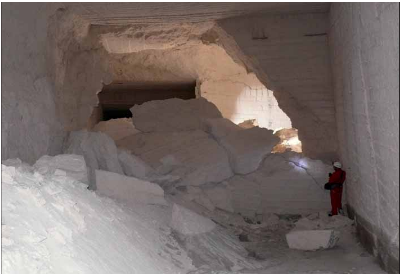
Figura 2 – Crollo di una parete divisoria tra ambienti di cava sotterranea a Cutrofiano, in provincia di Lecce.
