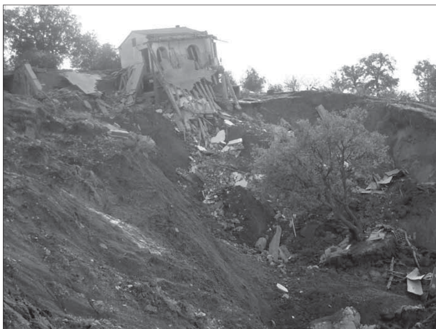
Figura 4 – Particolare della nicchia di distacco centrale in progressivo arretramento a novembre 2010.
