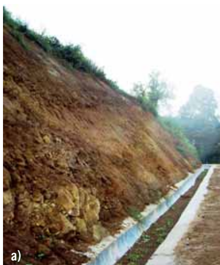
Figura 6. Orvieto (Terni) - SP111 della Badia: a) canaletta intasata (foto settembre 2005); b) canaletta pulita (foto maggio 2006).
