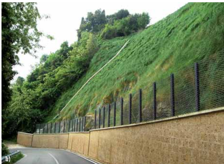
Figura 5. Orvieto (Terni) - SP111 della Badia: a) situazione del versante nel dicembre 2004, prima dell'intervento; b) dopo l'intervento di rinaturalizzazione (maggio 2006).
