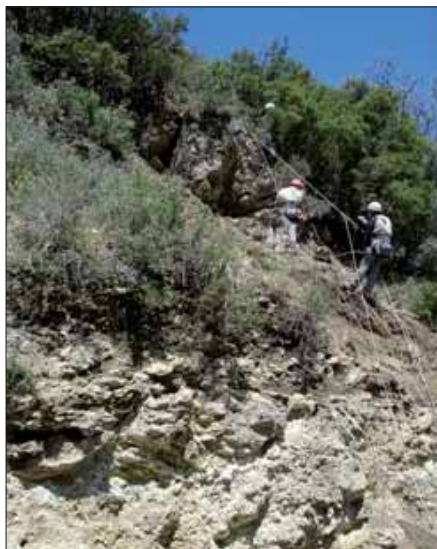
Figura 4. Operazione di disaggio masso
