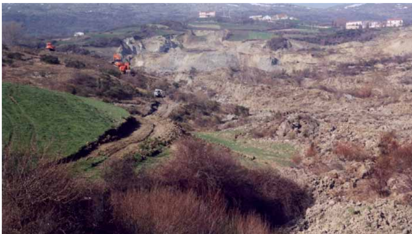
Figura 7 – Settore a NNW della frana ove si riscontra il secondo grosso cedimento.
