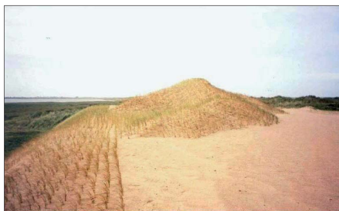
Figura 27 – Riprofilatura di dune con riporti di sabbia (da Scottish Natural Heritage, 2004).
