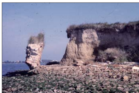
Figura 13 - In alto: vista aerea dell'Ottagono abbandonato, nei pressi dell'antico porto del Meduacus/Brenta; in basso: fenomeni erosivi sul lato orientale dell'Ottagono abbandonato (da BONDESAN, MENEGHEL, 2004).
