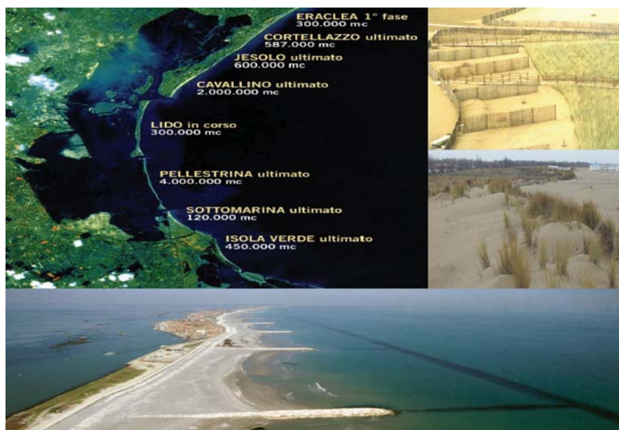
Figura 1 – Il rinforzo dei litorali veneziani: creazione di cordoni dunosi lungo il litorale di Cavallino (a destra); ripascimento protetto nel litorale di Pellestrina (sotto).
