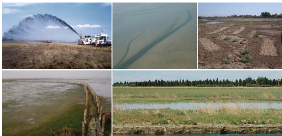
Figura 4 – Esempi di protezioni locali dei bordi di velme e barene naturali anche attraverso la sperimentazione di schermi di sedimentazione, ripascimento superficiale, canali di vivificazione e trapianti di vegetazione.
