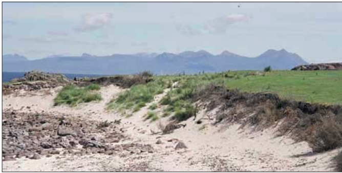
Figura 13 – Ricopertura grezza lungo un orlatura di "machair" in erosione, utilizzando locali tagli forestali (da DEFRA, 1999).
