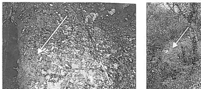
Fig. 2 - Briglia completamente interrita e ricoperta da vegetazione; (a) lungo il F.so di Cortaccione, (b) lungo il F.so di Liè - Belfiore.
