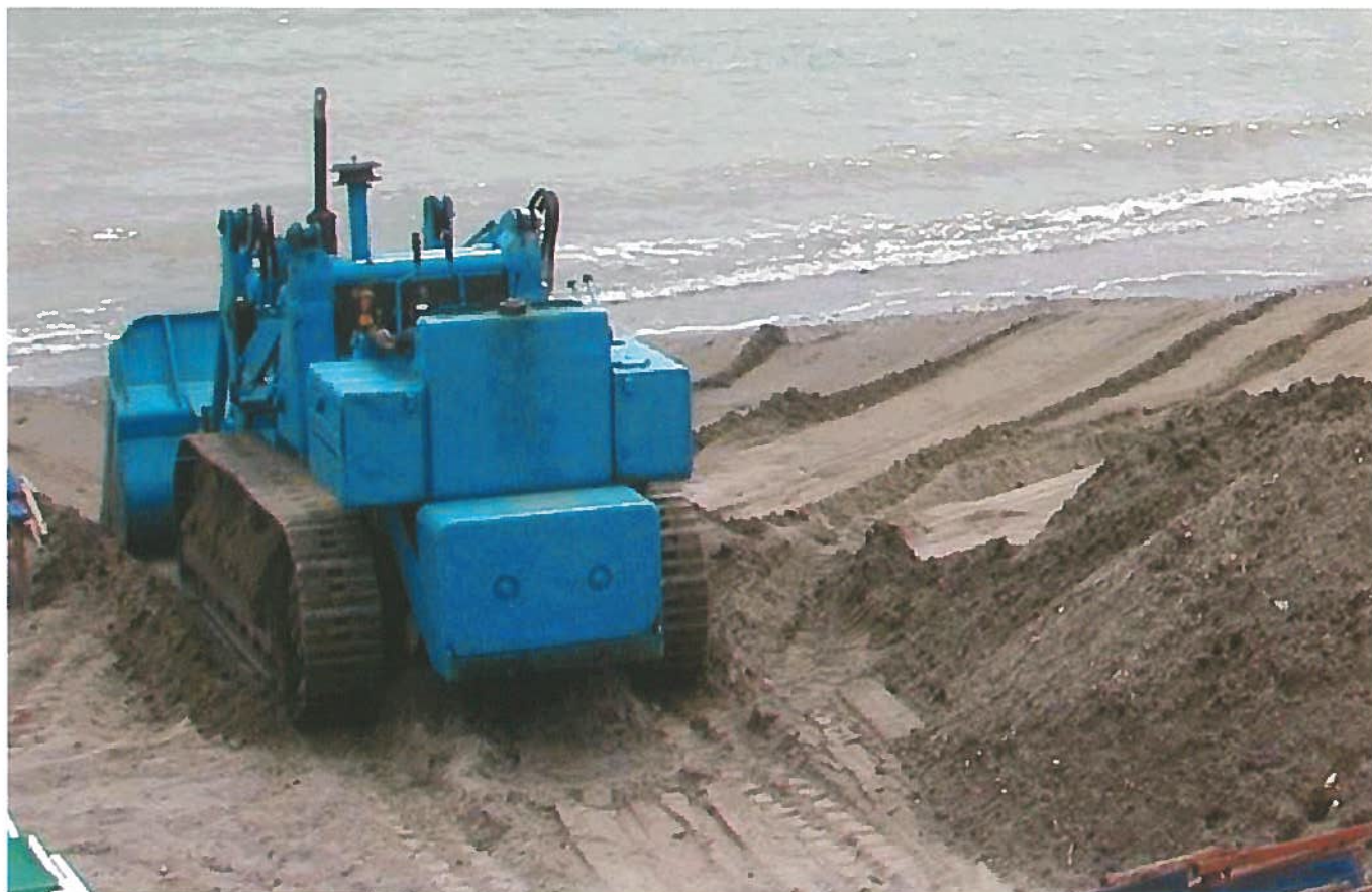
Fig. 2 - Attività di ripascimento in corso.
