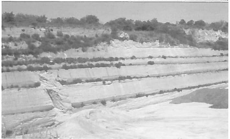
Foto 3 - Particolare della parete Nord-Ovest del giacimento interessato dal recupero geoambientale previsto.
