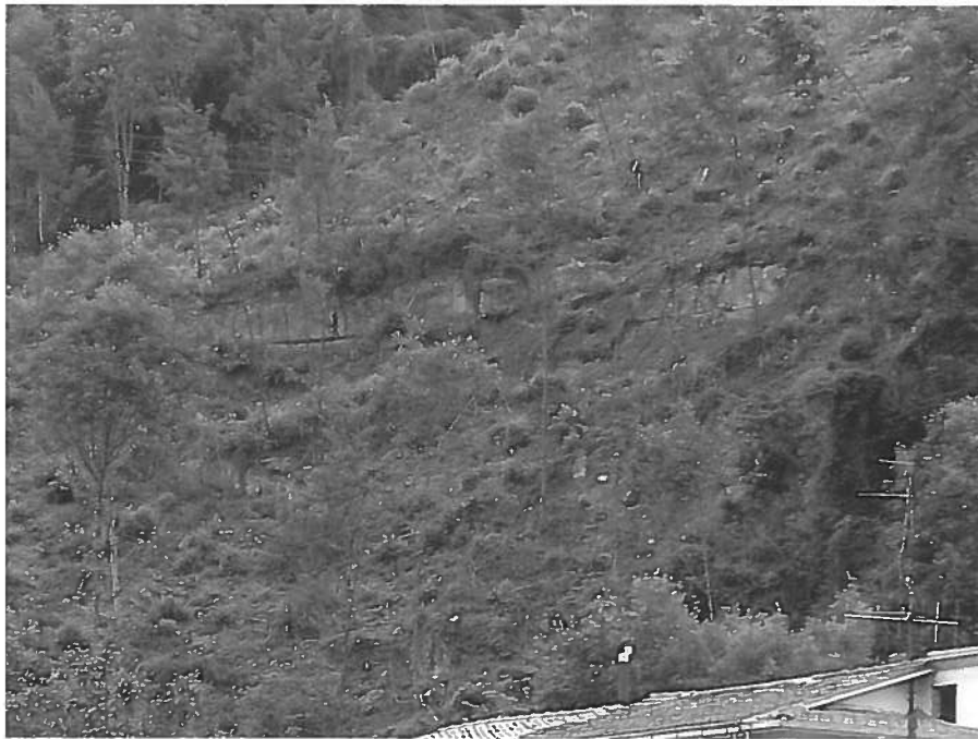
Fig. 4 - Fenomeni di crollo dalle scarpate strutturali ricoperti da vegetazione.
