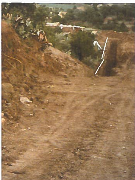
Figura 13 - Ripristino dell'area dopo l'interramento di una condotta (a sinistra subito dopo l'interramento, a destra a ripristino ambientale avvenuto).
