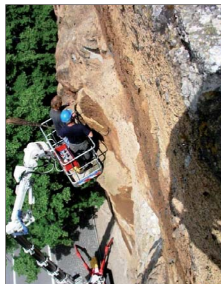
Figura 2 – Eliminazione della vegetazione infestante sulla parete di tufo consolidata
