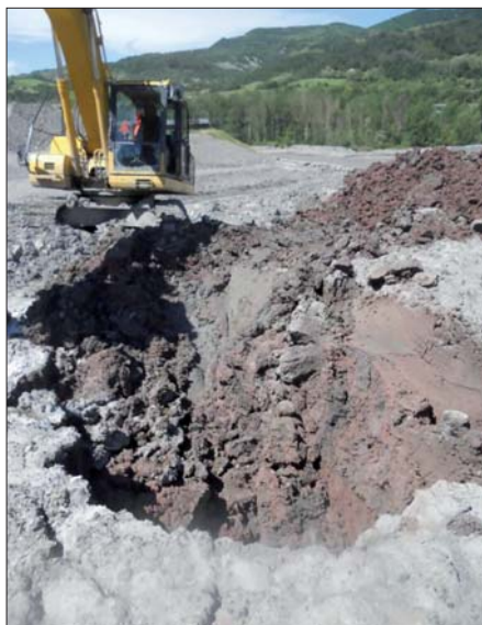
Figura 2 – Cumuli di terre e rocce da scavi in galleria
