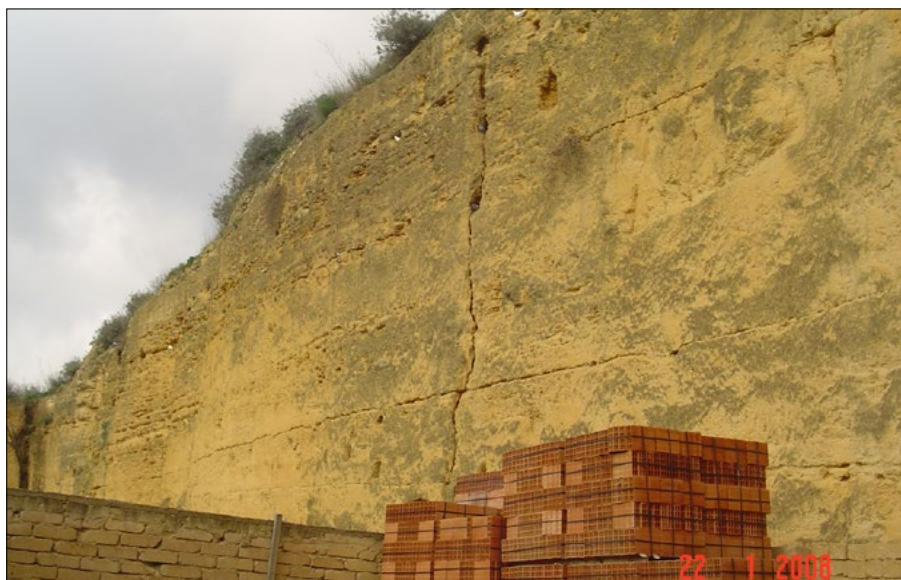
Foto 8. Fenditura verticale beante nei banconi calcarenitici di una vecchia cava di via Agrigento
