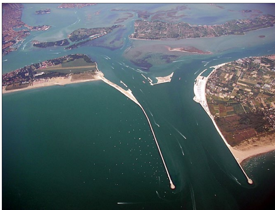
Figura 4. L'attuale bocca di porto del lido divisa in due parti per la costruzione delle opere di imposta del Mose (isola centrale, conca di navigazione e spalle)
