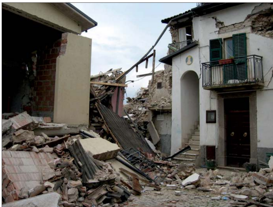
Figura 2. Danni ad edifici a seguito del terremoto dell'Aquila dell'aprile 2009. (Foto Fausto Marincioni)
