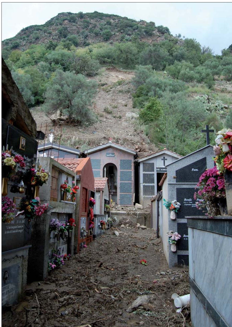
Figura 1. Danni al cimitero comunale di Samo (RC) a seguito di un fenomeno franoso di tipo scorrimento-colata avvenuto nel novembre del 2015. (Foto di Loredana Antronico)
