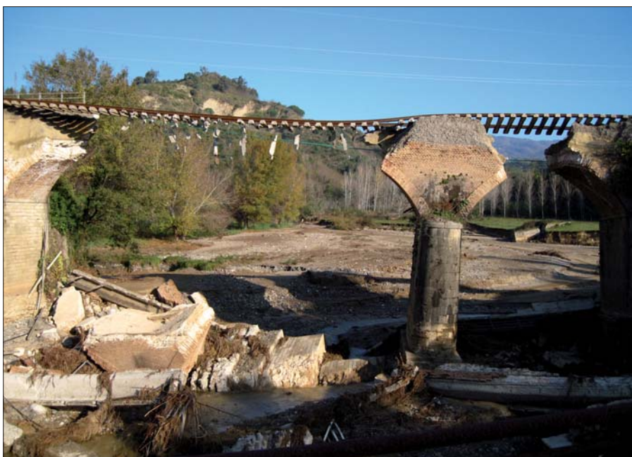
Figura 4. Crollo del ponte ferroviario a seguito della piena del torrente Cancellò (Marcellinara, CZ) che ha causato l'interruzione della linea Catanzaro-Lamezia nel novembre 2011. (Foto Loredana Antronico)
