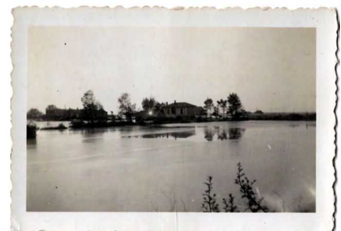
Figura 12. Cesena, maggio 1939: vasti allagamenti causati dalle acque del Fiume Savio (www.forlittoday.it)
