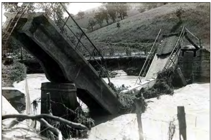
Figura 13. Maggio 1939: crollo del ponte Sibetta sul torrente Marzeno, affluente di destra del Fiume Lamone
