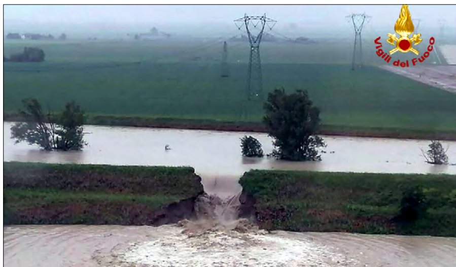
Figura 2. La breccia nell'argine del Sillaro che ha causato l'allagamento di Spazzate Sassatelli, ad Ovest di Concesio (foto VV.FF.)
