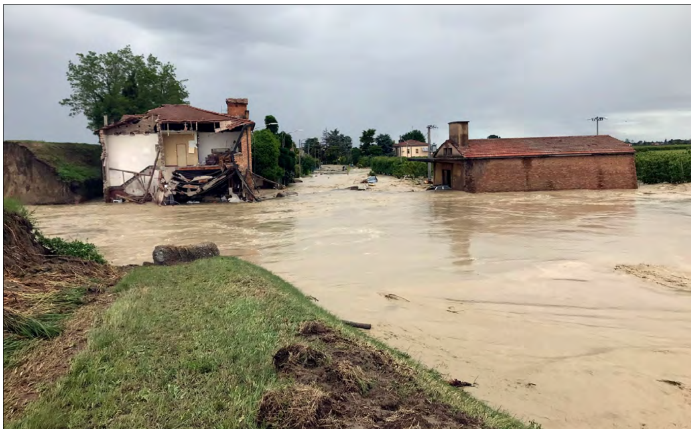
Figura 7. Cà di Lugo (Ravenna), 17 maggio 2023: inondazione e crollo di un edificio per la rottura di un argine del fiume Santerno, visibile a sinistra nell'immagine (foto Leandra Ricci Bitti, via Emilia-Romagna Meteo)
