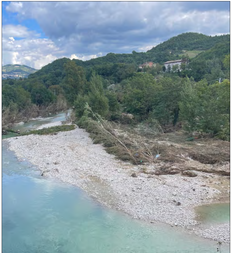
Figura 23. Il Fiume Burano dal Ponte Vecchia Flaminia dopo l'alluvione
