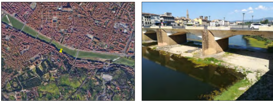
Figura 11. Nella foto a destra, particolare della soglia al Ponte alle Grazie dove l'Arno defluisce in corrispondenza della sola arcata centrale
