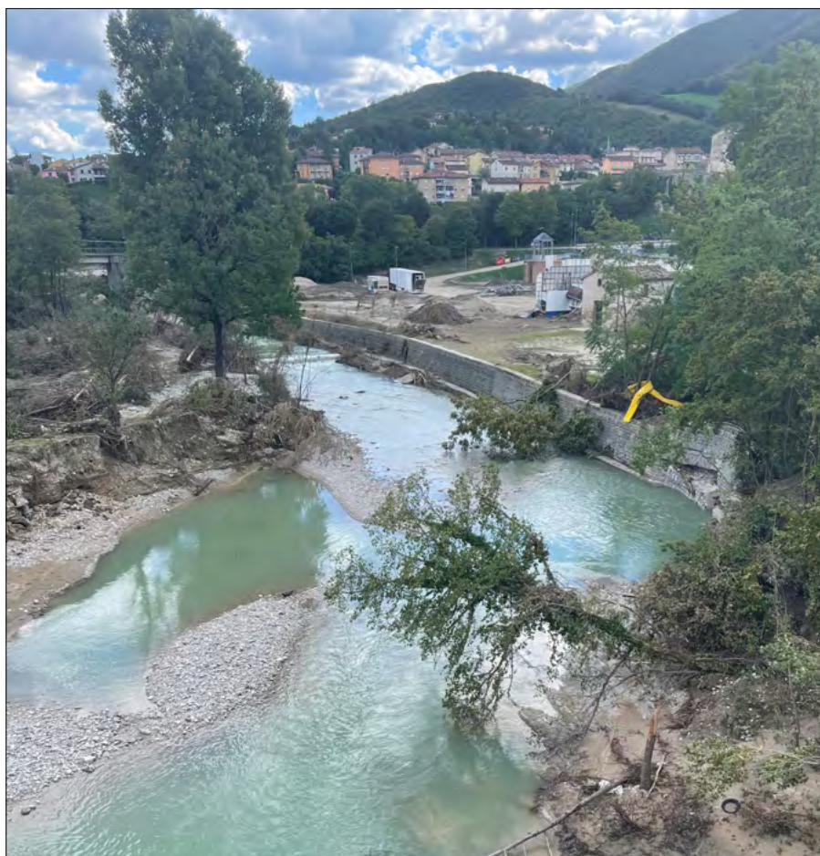
Figura 25. Il Fiume Burano dal Ponte Vecchia Flaminia dopo l'alluvione. Sullo sfondo l'arena di Sant'Emidio alluvionata (Area R2)
