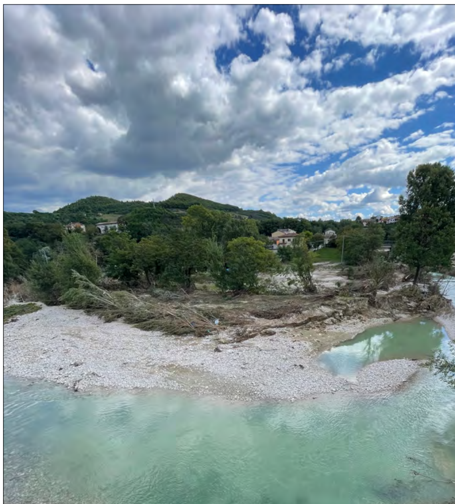
Figura 24. Il Fiume Burano dal Ponte Vecchia Flaminia dopo l'alluvione
