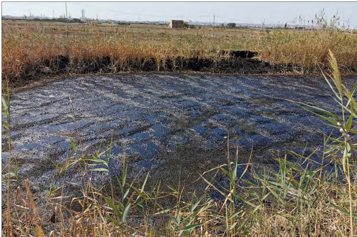
FIGURA 14. SIN Gela: discarica C.da Marabusca foto Vasca B1 (sopralluogo Enti settembre 2020).
