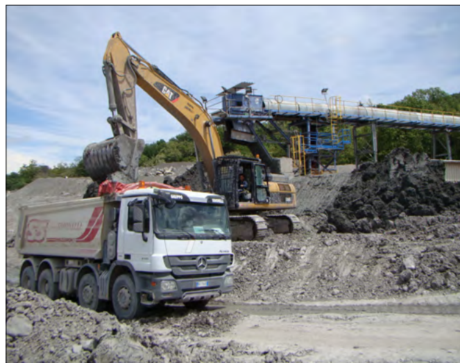
FIGURA 7. Scavi per realizzazione di infrastrutture viarie.
