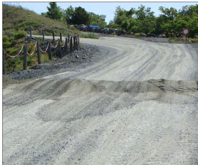
FIGURA 8. Realizzazione viabilità secondaria.
