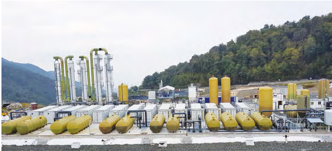
impianto di trattamento del percolato, Discarica di Scarpino (GE). Amiu S.p.A. Capacità: 220 m3/h.
