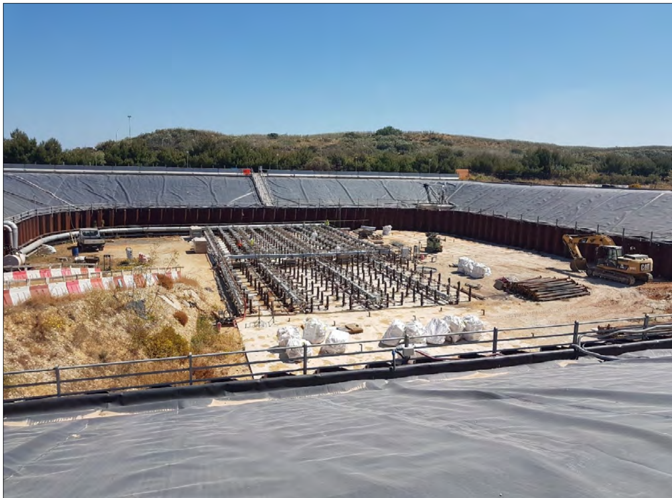
FIGURA 9. SIN di Gela: area Vasca A zona 2 (foto sopralluogo ISPRA/ARPA/Eni del maggio 2019).
