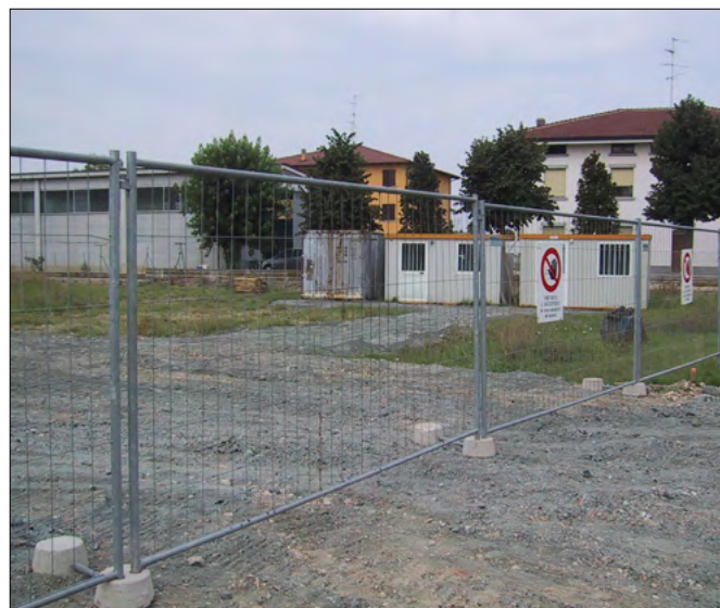
FIGURA 12. Strada di cantiere in pietrisco ofiolitico.
