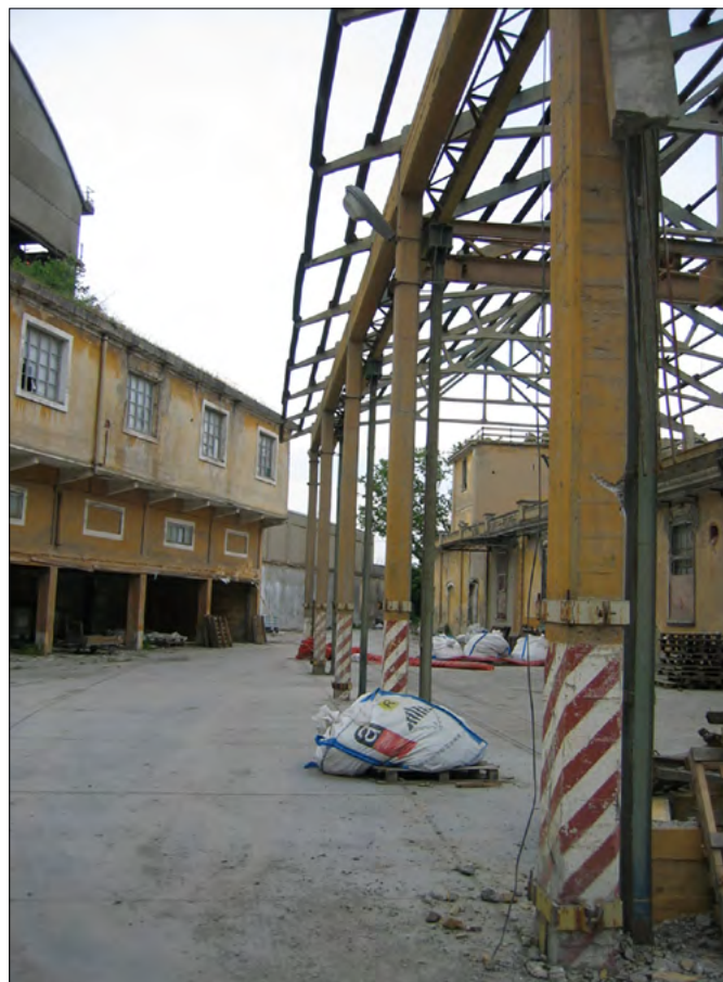
FIGURA 5. Ex stabilimento ETERNIT- Casale Monferrato.
