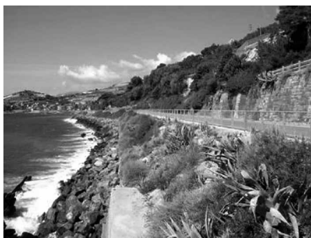
Figura 3. Tratto costiero in adiacenza alla ex linea ferroviaria passante per San Lorenzo al Mare (M), futura pista ciclabile
