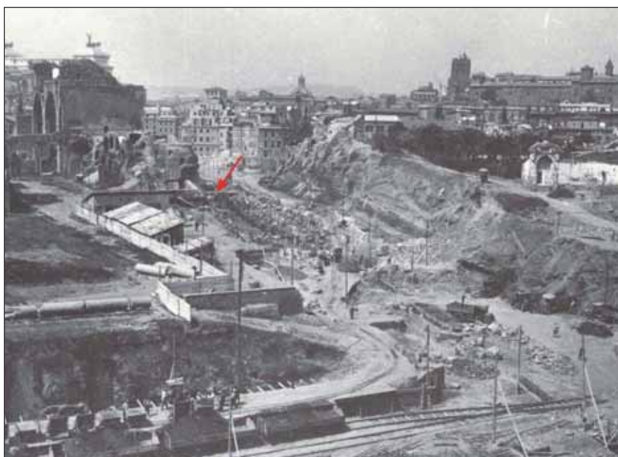
Fig. 9 - Via dei Fori Imperiali, smantellamento della Collina Velia nel corso della costruzione di Via dell'Impero nel 1932.
