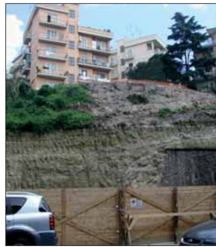
Fig. 12 - Via di Donna Olimpia, affioramento del contatto Pliocene-Pleistocene esposto temporaneamente nel corso della costruzione di un parcheggio interrato.
