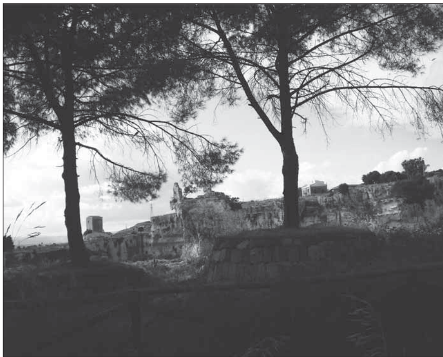
Fig. 6 - L'edificio che si intravede sulla sommità del pilone è sicuramente antico e precedente al crollo della volta delle latomie (terremoto del 1693).
