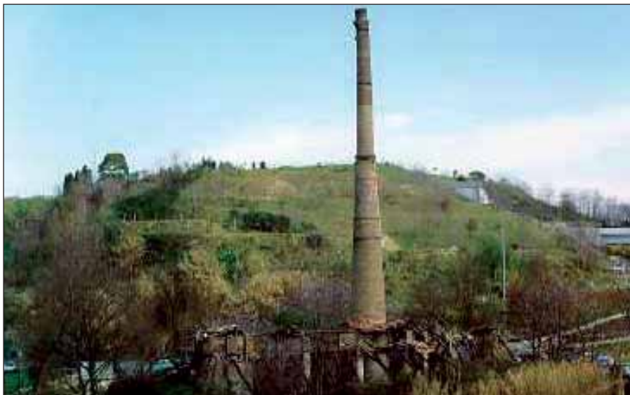
Fig. 14 - Viale di Valle Aurelia, Valle dell'Inferno, resti dell'antica Fornace Veschi.
