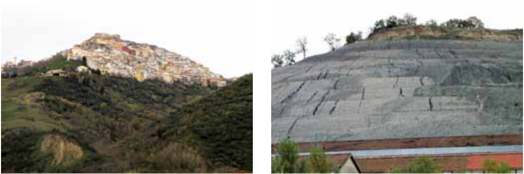
Fig. 9 - a) l'abitato di Calitri a struttura piramidale, edificato sulle sabbie argillose (visibili in basso a sinistra); b) le cave di argilla pliocenica (in basso gli opifici di lavorazione).
