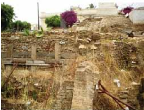
Fig. 11. Muro inclinato. (per la localizzazione si veda Fig. 8)
