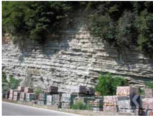
Fig. 4 - Lungo il versante sinistro del T. Uzzone si osservano scarpate incise nelle arenarie della Formazione di Cortemilia (disposizione a reggipoggio delle discontinuità rispetto al versante). Affioramento limitrofo alla Ditta A.L.P. snc, specializzata nella lavorazione della Pietra di Langa. Tappa n. 1 dell'itinerario.
