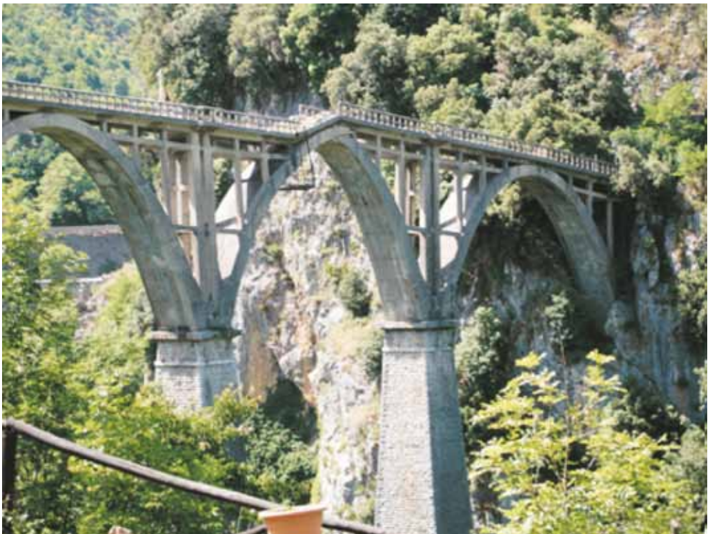
Fig. 6 - Ponte delle FCL, visto da sud-est (foto Propato).
