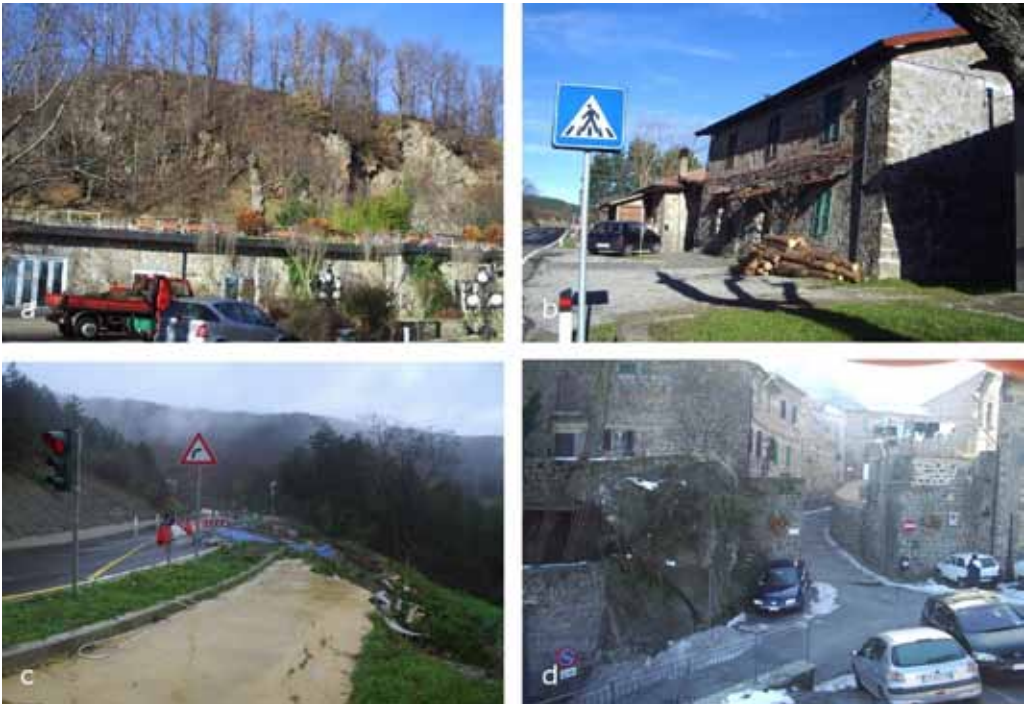
Fig. 3a. Scarpata sul fianco destro della DSGM di S. P. Il substrato è intensamente fratturato e suddiviso in larghi blocchi; Fig. 3b. L'edificio di Podere Mangiavacchi fortemente basculato; Fig. 3c. Strada che conduce a Piancastagnaio interrotta da una frana; Fig. 3d. La strada di ingresso a Piancastagnaio è ubicata all'interno di una antica trincea nei pressi del bordo della scarpata principale della DSGM di PM. Gli edifici di questa zona sono stati riedificati più volte in seguito alle lesioni generate da passate fasi di attività.
