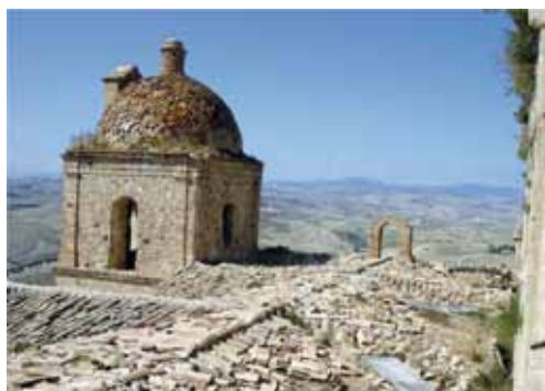
Fig. 7 - Il campanile, realizzato su tre ordini e coperto da una cupola estradossata di maioliche e da volte a vela.
