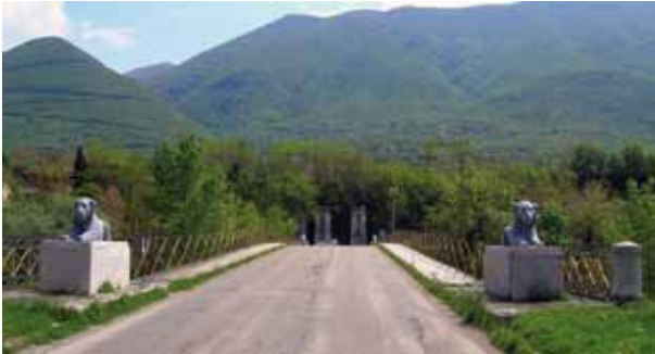
Fig. 15 - Ponte sul Calore.
