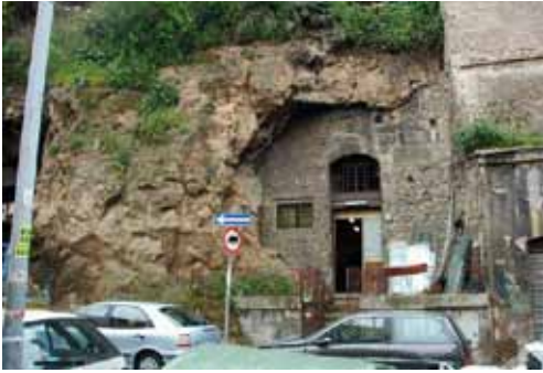
Fig. 5 - Scarpa artificiale di Tufo Lionato legata ad antiche attività di cava di epoca romana. Sono visibili numerosi accessi alla rete caveale adibiti ad attività artigianali.
