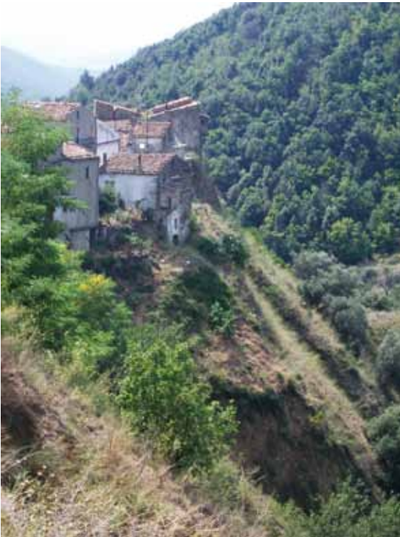
Fig. 8. Fabbricati del borgo lungo la scarpata occidentale in arretramento.
