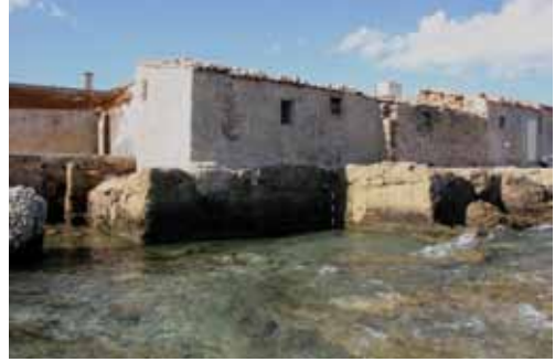
Fig. 5b - Latomia Maggiore. Settore meridionale. Abitazioni del borgo antico edificate sulle superfici di estrazione della cava.
