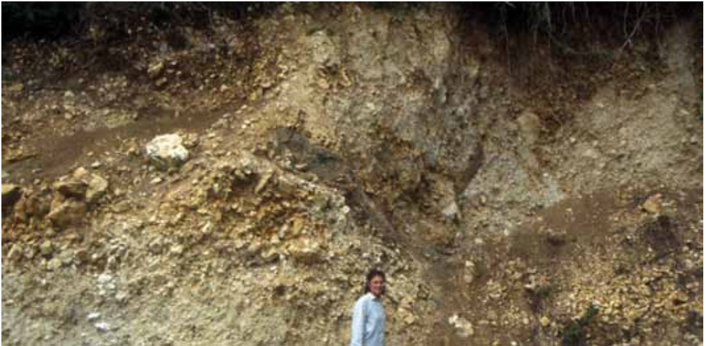
Fig. 8 - Il corpo di frana del colamento di S. Rita, in posizione sospesa sullo spartiacque tra due corsi torrentizi. L'ammasso è costituito da detrito angoloso e blocchi di SMN. Sono visibili anche lembi della sottostante AVV coinvolta nel movimento.
