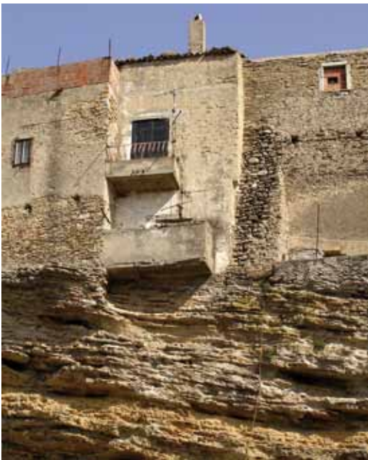
Fig. 9 - Case del centro storico di Acerenza su rocce calcarenitiche plioceniche ( Bacino di Potenza-Tricarico, Subsintema di Acerenza).
