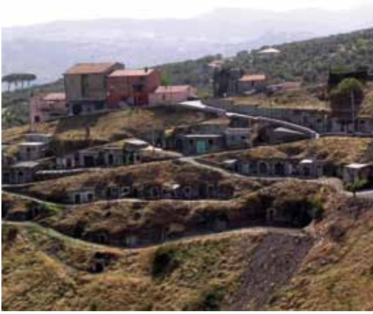
Fig. 13 - Cantine scavate lungo i versanti tufacei nel pressi di Barile (PZ).
