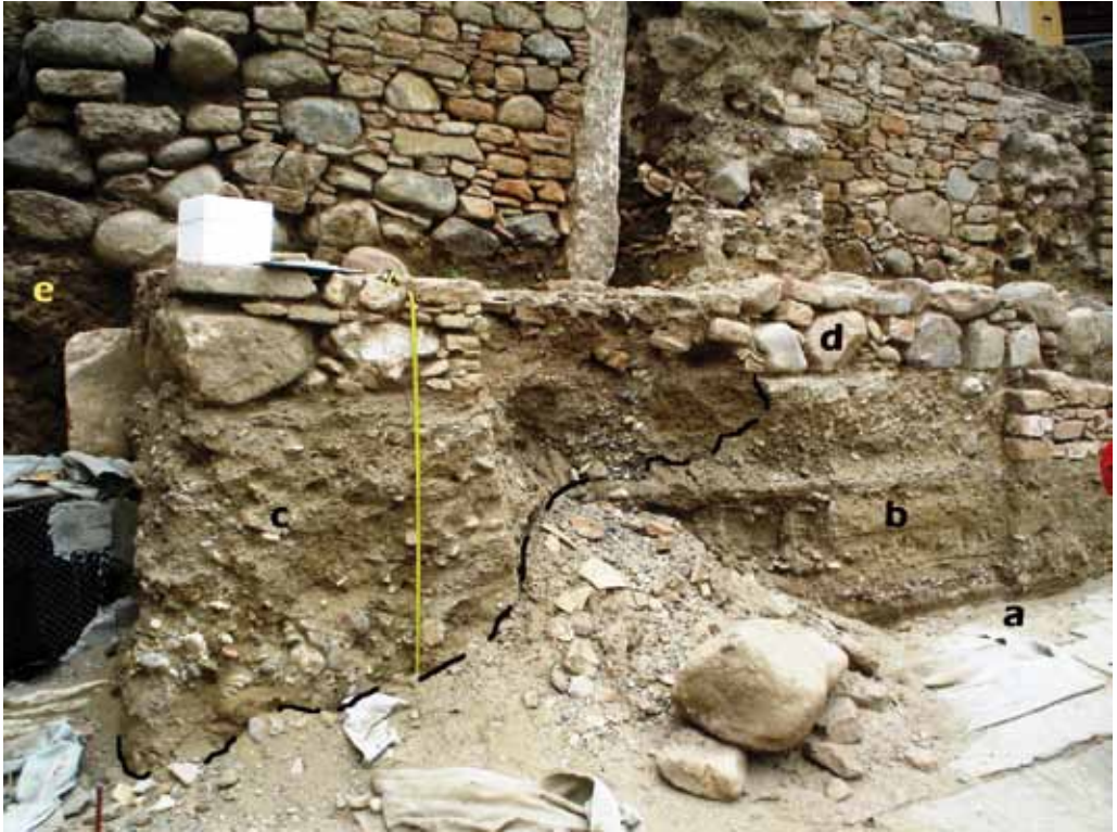
Fig. 13. Canale di erosione (la linea tratteggiata indica la superficie di erosione alla base).
