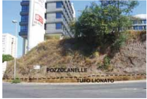
Fig. 6 - Affioramenti di Tufo Lionato e Pozzolanelle nel quartiere Laurentino 38.
