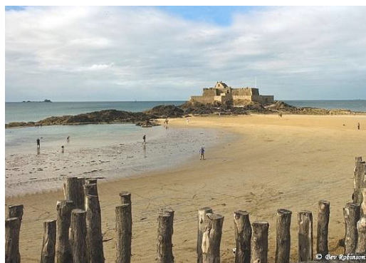
Figg. 13.10 e 13.11 – Pennelli permeabili per dune in legname, da APAT Atlante delle spiagge (2007) (a sx) e da DEFRA (1999) (a dx)
