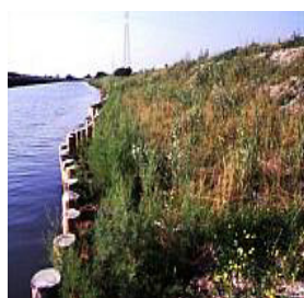
Figg. 12.12 e 12.13 - A dx: Consolidamento con tronchi, rulli di cocco, geotessuti e fibre miste, abbinati a fascine di tamerice (fiume Natissa, Laguna di Grado GO). A sx: Lo stesso canale perilagunare dopo un anno (Foto Giuliano Sauli)
