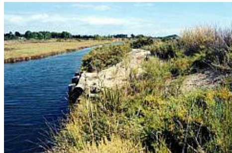
Figg. 12.58 e 12.59 - Laguna di Nora (CA), rullo spondale, fase di costruzione 1996 (a sx) e palificata spondale con palo infisso e fascine di tamerici, in primo piano effetti del rullo spondale settembre 2003 (a dx) (Foto Giuliano Sauli)
