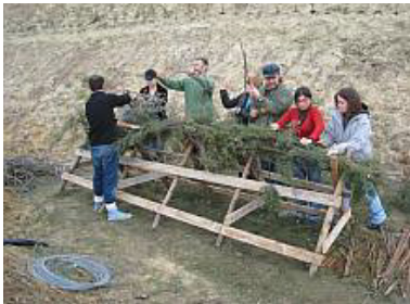
Figg. 12.42 e 12.43 - Realizzazione di fascine vive di tamerici e messa a dimora di arbusti mediterranei, aprile 2007 (Foto Paolo Cornolini)
