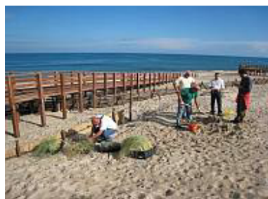
Figg. 12.36 e 12.37 - Realizzazione delle graticciate (a sx) e piantagione di piante psammofile (a dx)
