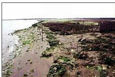
Figg. 12.19 e 12.20 - Stabilizzazione di cordoni dunali mediante graticciate e trapianti di cespi di Ammophila arenaria e graticci con legno morto e vivo di Salix alba , in località La Vallona - Po di Levante (RO)
