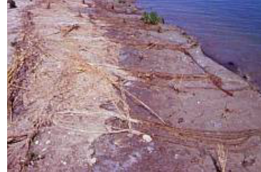
Figg. 12.3 e 12.4 - I fanghi post-fresatura con mezzo meccanico (a sx) e Totale inefficacia dell'impiego di stuoie di juta quale antiersivo spondale (a dx) (Foto G. Sauli)
