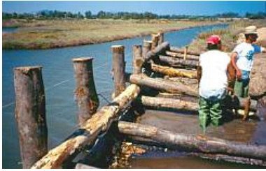
Figg. 12.56 e 12.57 - Laguna di Nora (CA), palificata spondale con palo infisso e fascine di tamerici, 1996 (a sx) e rullo spondale, fase di costruzione, 1996 (Foto Giuliano Sauli)
