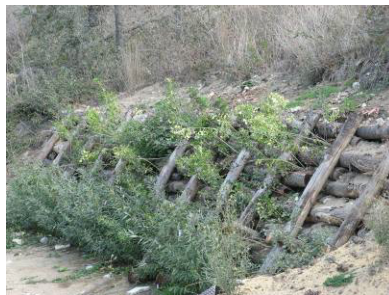
Figg. 12.45, 12.46 e 12.47 - Realizzazione di palizzate in tronchi orizzontali, palificate vive con arbusti mediterranei, al piede delle scarpate attigue alle residenze (Foto Paolo Cornellini)
