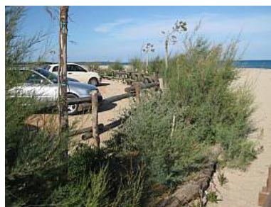
Figg. 12.31 e 12.32 - Realizzazione di una palificata viva con inserimento di talee di tamerice (a sx) e palificate e palizzate di consolidamento lungo un'infrastruttura viaria (a dx)
