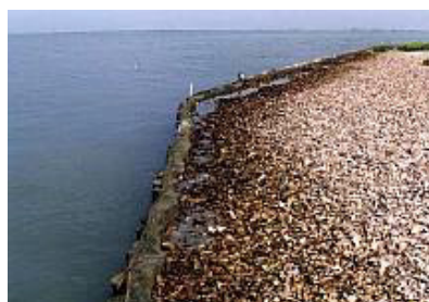
Figg. 12.17 e 12.18 - Ricostruzione di barene con fanghi di dragaggio; contenimento con pali e geotessuti in località La Vallona - Po di Levante (RO)
