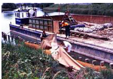
Figg. 12.12 e 12.13 - A dx: Consolidamento con tronchi, rulli di cocco, geotessuti e fibre miste, abbinati a fascine di tamerice (fiume Natissa, Laguna di Grado GO). A sx: Lo stesso canale perilagunare dopo un anno (Foto Giuliano Sauli)
