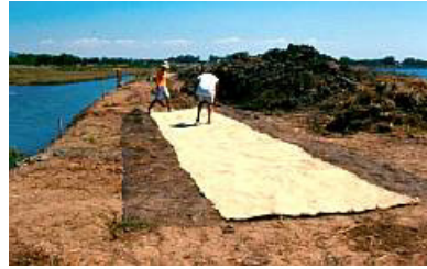
Figg. 12.56 e 12.57 - Laguna di Nora (CA), palificata spondale con palo infisso e fascine di tamerici, 1996 (a sx) e rullo spondale, fase di costruzione, 1996 (Foto Giuliano Sauli)
