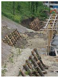
Figg. 12.45, 12.46 e 12.47 - Realizzazione di palizzate in tronchi orizzontali, palificate vive con arbusti mediterranei, al piede delle scarpate attigue alle residenze (Foto Paolo Cornellini)
