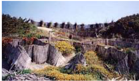
Fig. 12.50 – P. N. del Circeo, aprile 2003, resti di graticciate utilizzate per filtrare la sabbia e limitare l'erosione delle dune costiere. In alto fascine morte di saggina
