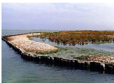
Figg. 12.17 e 12.18 - Ricostruzione di barene con fanghi di dragaggio; contenimento con pali e geotessuti in località La Vallona - Po di Levante (RO)
