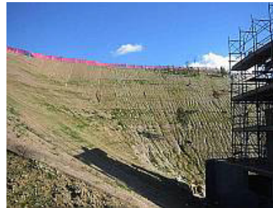
Figg. 12.40 e 12.41 - Scarpate artificiali su terreni sabbiosi con evidenti fenomeni erosivi nonostante l'impiego di biostuoie inerbite
