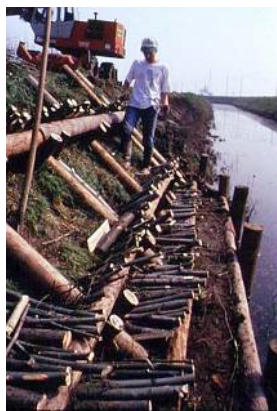
Figg. 12.14 e 12.15 - Palificata e grata viva con salici in un canale del delta Po, in provincia di Rovigo, in fase di realizzazione (a sx) e dopo alcuni anni (a dx)
