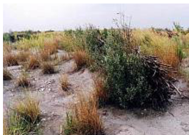
Figg. 12.19 e 12.20 - Stabilizzazione di cordoni dunali mediante graticciate e trapianti di cespi di Ammophila arenaria e graticci con legno morto e vivo di Salix alba , in località La Vallona - Po di Levante (RO)
