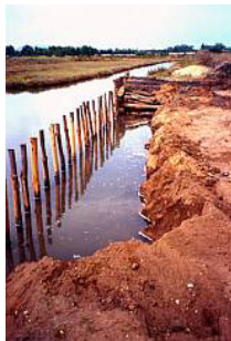
Figg. 12.58 e 12.59 - Laguna di Nora (CA), rullo spondale, fase di costruzione 1996 (a sx) e palificata spondale con palo infisso e fascine di tamerici, in primo piano effetti del rullo spondale settembre 2003 (a dx) (Foto Giuliano Sauli)
