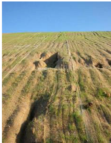
Figg. 12.40 e 12.41 - Scarpate artificiali su terreni sabbiosi con evidenti fenomeni erosivi nonostante l'impiego di biostuoie inerbite
