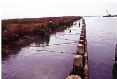
Figg. 12.10 e 12.11 - Consolidamento spondale di un canale perilagunare, con tronchi e tavole tirantati, e messa a dimora di tamerici (Laguna di Grado GO e Marano UD) (Foto Giuliano Sauli)
