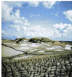
Fig. 12.48 - Stabilizzazione di sistemi dunali con messa a dimora a gradoni di piantine di Ammophila arenaria (dune sul Mare del Nord, Germania)
