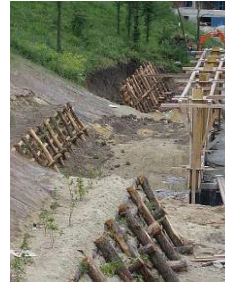
Fig. 12.44 - Le fascine vive di tamerici delle foto precedenti a settembre dello stesso anno
