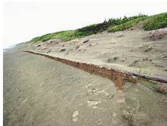
Fig. 12.51 – Difesa al piede della duna con paleria di legname e stuoia in cocco (Foto Giancarlo Bovina)
