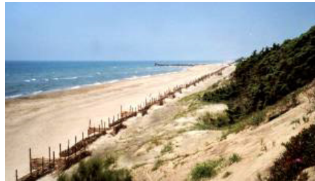
Figura 13.13 – Costruzione di barriere basali in viminate, chiusura dei varchi mediante palizzate e realizzazione di schermi frangivento nel Parco Nazionale del Circeo [Foto S. Puglisi, 2000]
