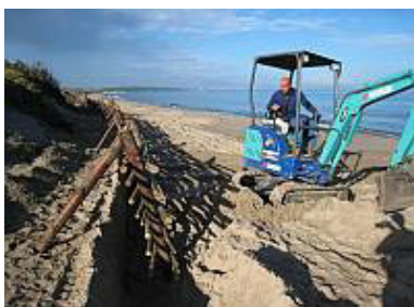
Figg. 12.36 e 12.37 - Realizzazione delle graticciate (a sx) e piantagione di piante psammofile (a dx)
