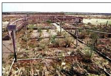
Figg. 12.19 e 12.20 - Stabilizzazione di cordoni dunali mediante graticciate e trapianti di cespi di Ammophila arenaria e graticci con legno morto e vivo di Salix alba , in località La Vallona - Po di Levante (RO)
