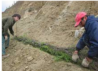
Figg. 12.42 e 12.43 - Realizzazione di fascine vive di tamerici e messa a dimora di arbusti mediterranei, aprile 2007 (Foto Paolo Cornolini)
