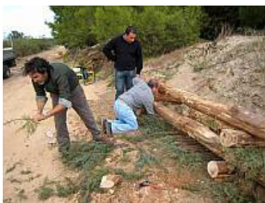
Figg. 12.31 e 12.32 - Realizzazione di una palificata viva con inserimento di talee di tamerice (a sx) e palificate e palizzate di consolidamento lungo un'infrastruttura viaria (a dx)
