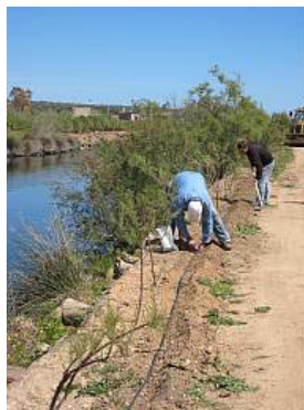
Figg. 12.33 e 12.34 - Realizzazione di palificate vive spondali (a dx) e trapianto di specie arbustive autoctone (a sx) (Foto Paolo Cornelini)
