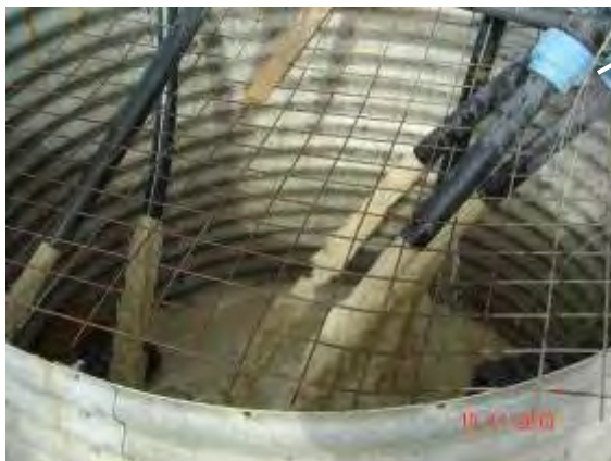
Particolare pozzo di derivazione
