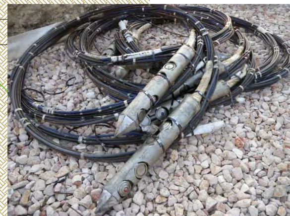
Ancoraggi con sistema T-FEG
