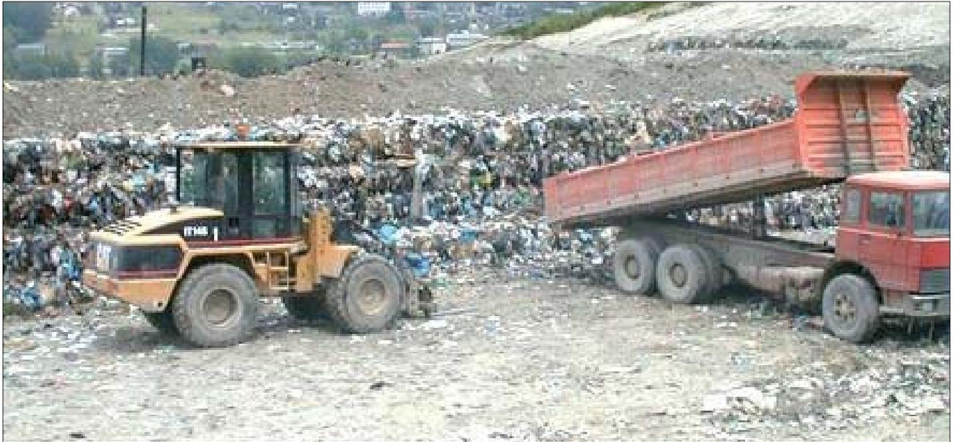
La coltivazione della discarica "on site" avviene accatastando le balle pressate in fronti di altezza costante. Durante la coltivazione, il fronte di avanzamento viene ricoperto con terra: in tal modo inizia la decomposizione anaerobica della parte biologica. Per control-
