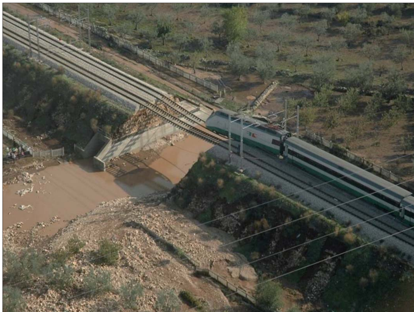
Figura 6 – Cedimento del rilevato ferroviario nella lama Scappagrano
