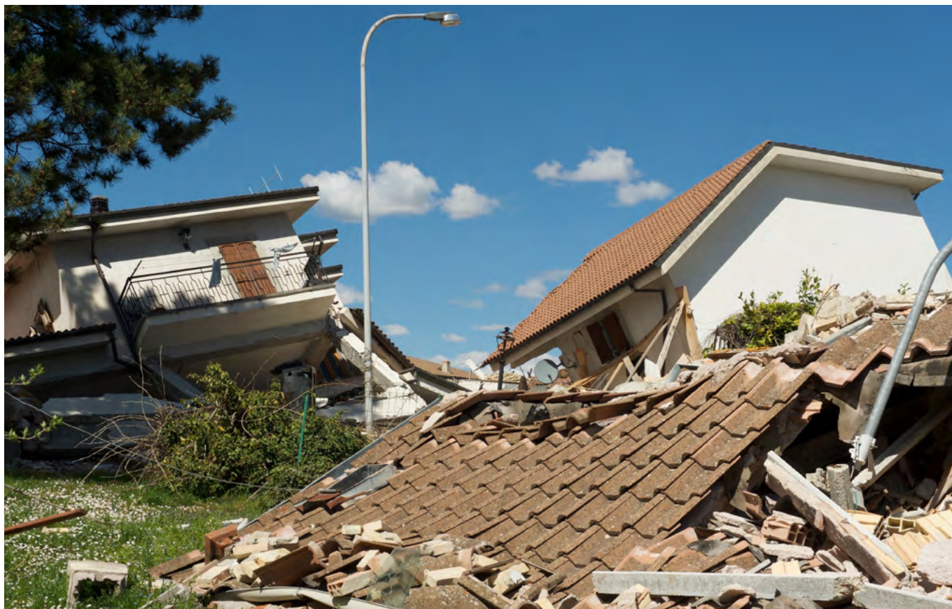
Figura 3. Edifici residenziali collassati e ribaltati a causa della scossa sismica del 24 agosto 2016. Località Amatrice (Foto V. Ottaviani, 9 aprile 2017)
