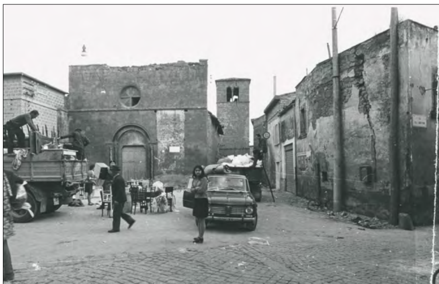
Figura 6. Tuscania, Chiesa di S. Silvestro (sec. XV), danni alla facciata e campanile
