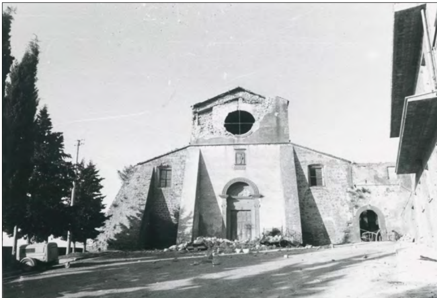
Figura 4. Tuscania, Chiesa di S. Maria del Riposo, danni alla facciata
