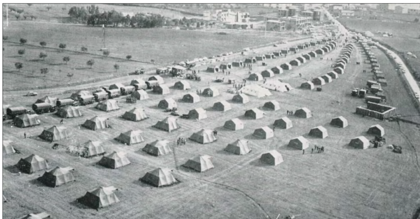
Figura 13. Tuscania, panoramica della tendopoli allestita in località Guadigliolo dopo il terremoto
