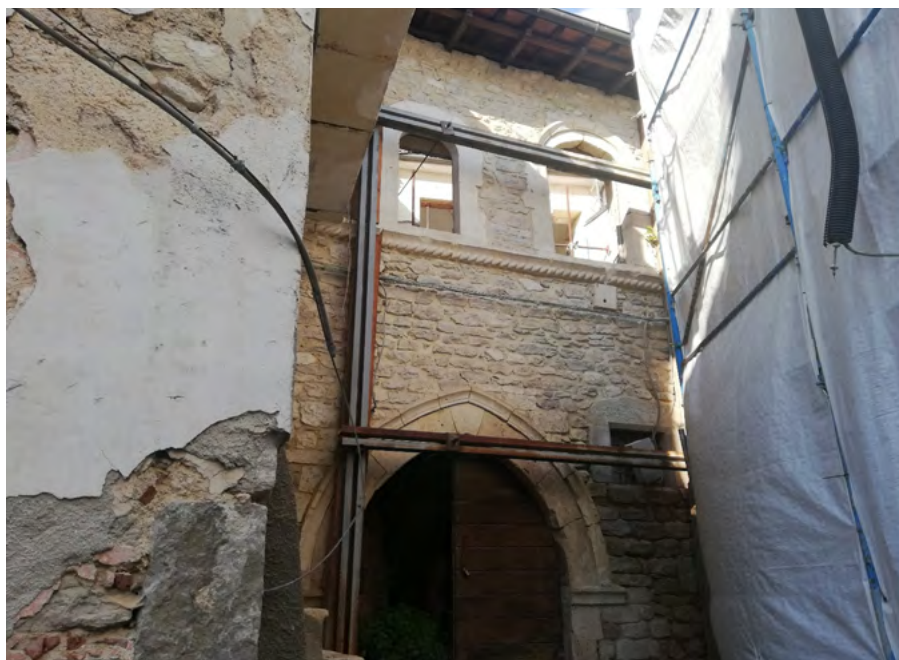
Figura 7. La "casa Gotica" di Paganica. Il soffitto ed i pavimenti di questo edificio trecentesco situato in via degli Angeli sono crollati a marzo 2011 a causa del maltempo e dell'incuria, dal momento che in seguito al sisma l'edificio non presentava puntellamenti adeguati. La facciata esterna, col caratteristico portale ogivale, è l'unica cosa rimasta in piedi dell'edificio, probabilmente grazie ad un lavoro di restauro conservativo effettuato prima del 2009
