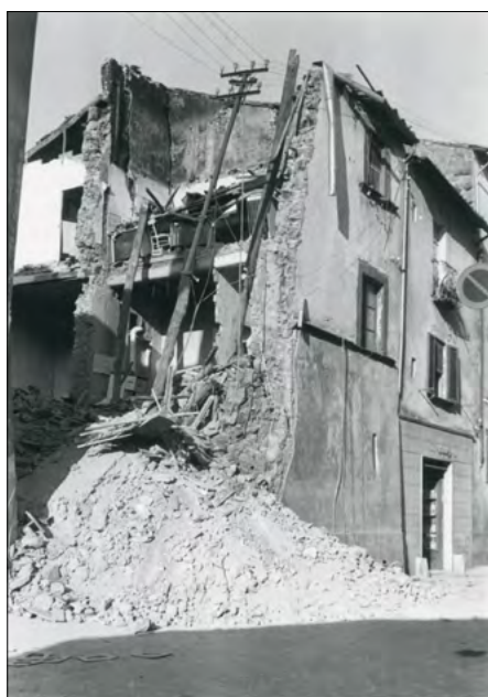
Figura 9. Edifici crollati in via XX Settembre a Tuscania. In gran parte a due e tre piani, in muratura di tufo, con solai in legno, senza idonee attestature delle travi, con pesanti volte e con coperture a tetto in genere spingenti
