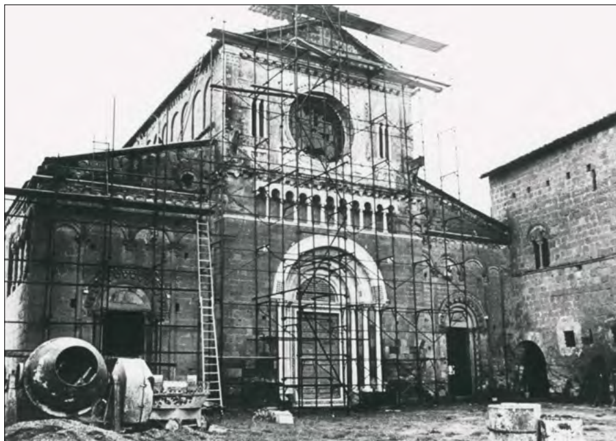
Figura 15. Tuscania, Basilica di S. Pietro, i lavori di ricostruzione
