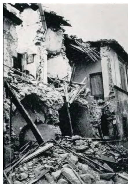
Figura 11. Tuscania, rovine subite dai fabbricati della zona medioevale. Si notano le caratteristiche volte di copertura
