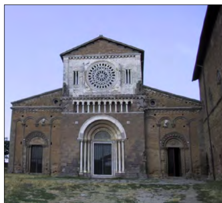
Figura 16. Tuscania, Basilica di S. Pietro, oggi dopo la riparazione dei danni.
