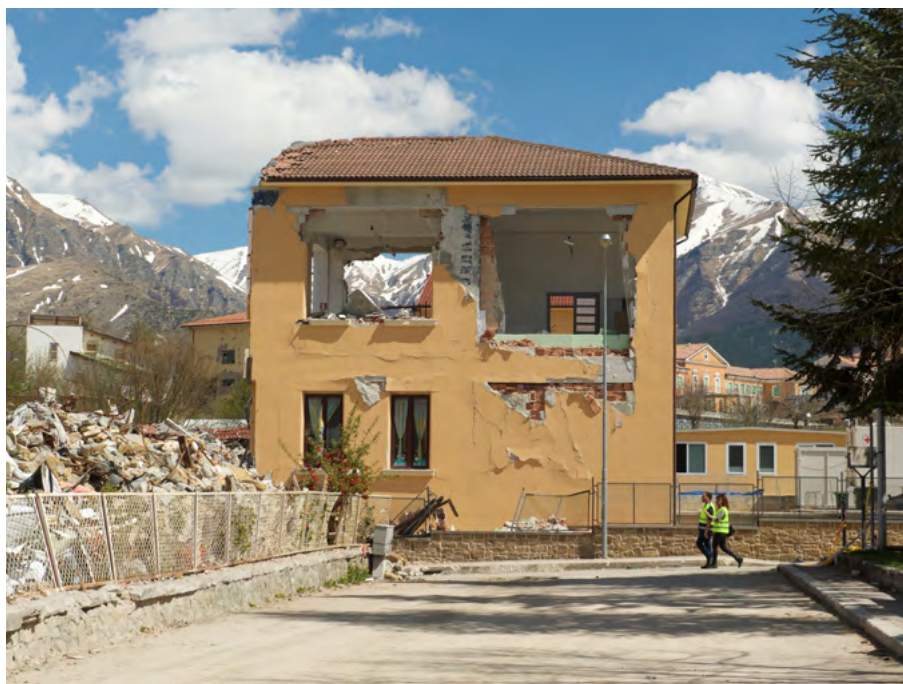
Figura 4. Edificio residenziale ad Amatrice, danneggiato dal sisma 2016 con ribaltamento delle pareti di tamponatura verso l'esterno. (Foto V. Ottaviani, 9 aprile 2017)
