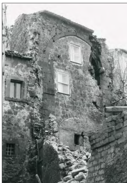
Figura 10. Tuscania, via dell'Orso. Costruzioni con muri a sacco, paramenti esterni di materiali misti blocchetti di tufo, riempiti di pietrame sciolto, e tetti costruiti con travi di legno e tegole
