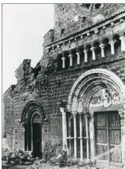
Figura 8. Tuscania, Chiesa di S. Pietro, i danni alla facciata e al rosone
