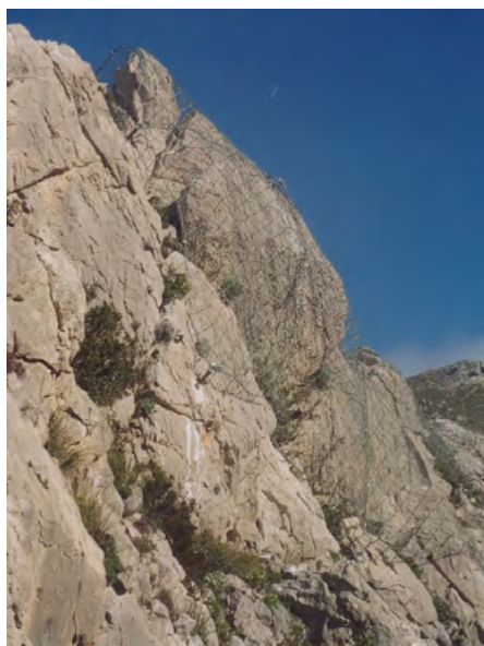
Figura 19. Intervento di consolidamento di carattere esteso della fascia sommitale della Rocca con pannelli di funi (Cafiso, 2007)
