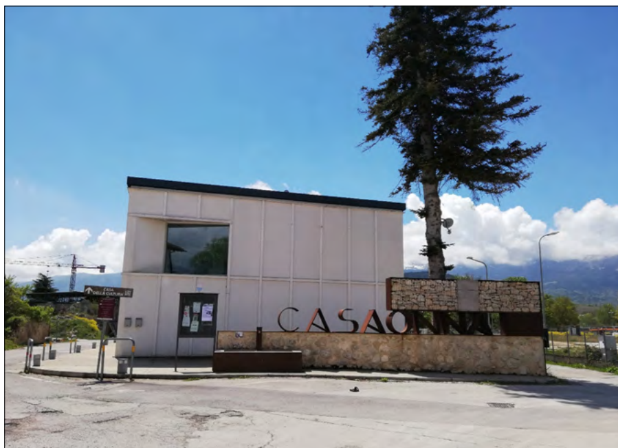
Figura 14. Casa Onna, costruita con i fondi donati dalla Germania affinché gli onnesi potessero avere nuovamente un luogo di aggregazione e di incontro prima che iniziasse la ricostruzione vera e propria
