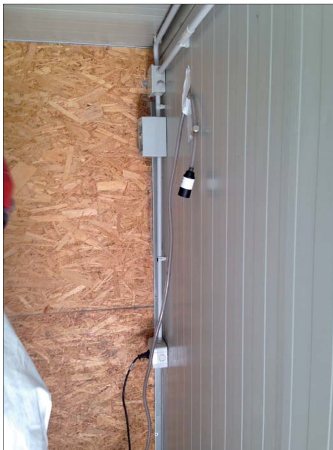
Figura 5 – Campionatore collocato all'interno della porzione pulita dello spogliatoio della Unità di Decontaminazione del Personale
