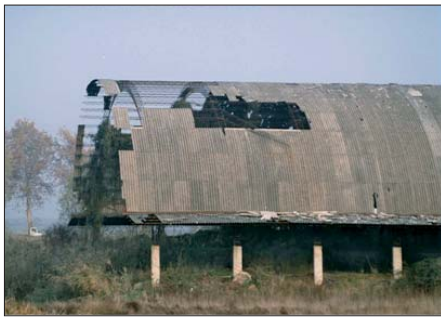
Figura 1 – Esempi di diverse tipologie di coperture in cemento-amianto, a volta, a falda e piana
