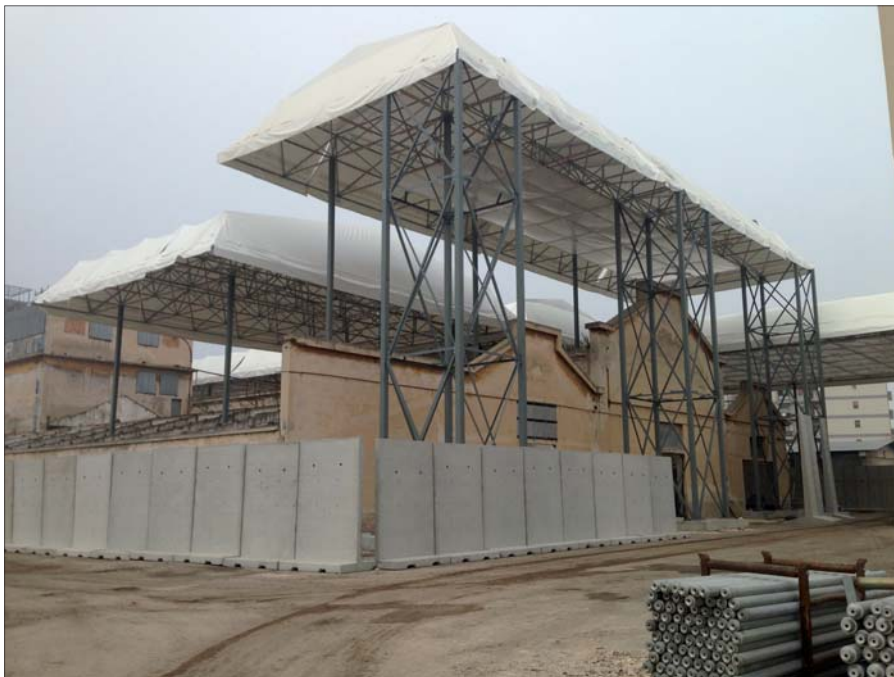
Figura 4 – Tendostruttura di confinamento in fase di montaggio, al di sopra degli edifici da demolire.
