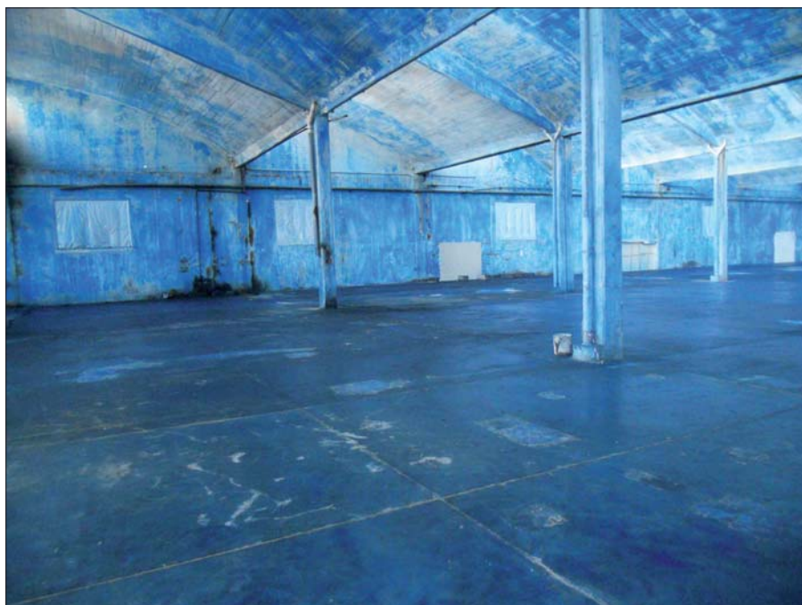
Figura 3 – Capannone B1 dopo il completamento della bonifica
