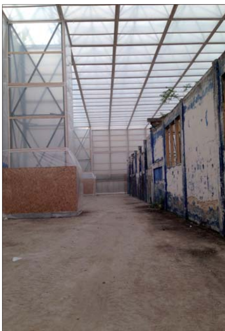
Figura 5 – Sistemi di confinamento interni alla tendostruttura per la creazione della camera confinata di lavoro
