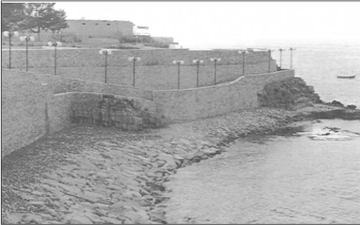
Figura 6 - Struttura di difesa radente al piede di un rivestimento della falesia realizzata con la tecnica della terra armata; litorale della città di Bisceglie (BA).
