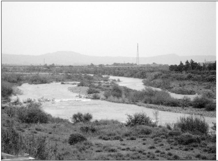
*Figura 21 - Alluvione nel bacino del f. Sinni del mese di ottobre 2005. In tale occasione l'invaso si è riempito senza il contributo dal f. Sarmento ed ha rilasciato acqua dagli scarichi. Per la prima volta dopo la costruzione della diga di M. Cotugno si sono uniti i flussi del ramo principale e di quello del f. Sarmento, con un involontario ripascimento della costa a costo zero.*
