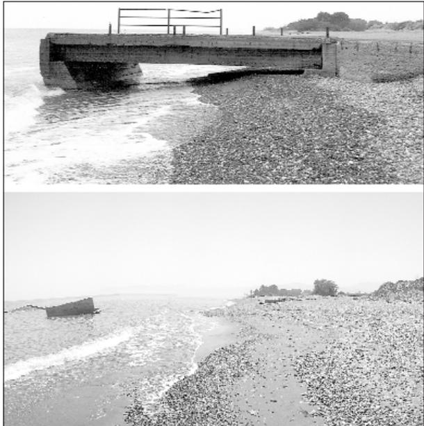
Figura 17 - Rovine di un piccolo ponte costruito su un canale di bonifica ad oltre 100 m dalla costa. a: 2002; b: 2005.
