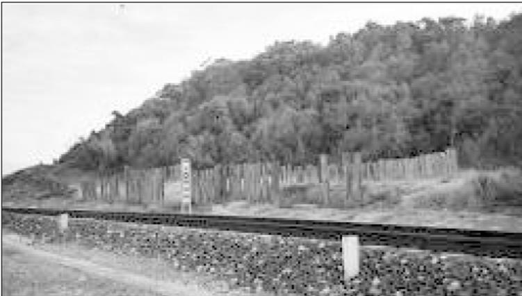
Figura 6 - La duna di Balestrate (PA) definitivamente consolidata dal rimboschimento. Sono ancora visibili, consunte dal tempo e dai venti salmastri, le traverse ferroviarie impiegate per contrastare la deflazione (foto Puglisi).
