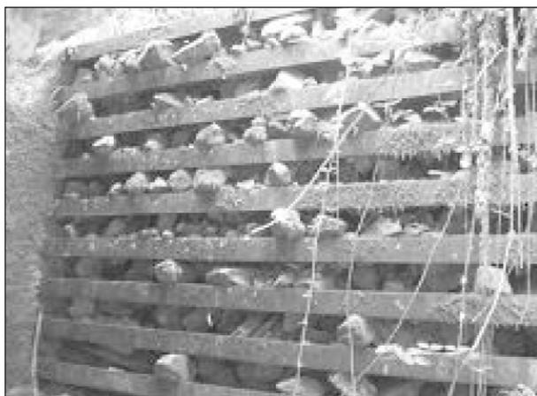
Figura 11 Briglia filtrante costruita ad Anzi (PZ) nel Vallone dell'Inferno, tributario del fiume Basento, dopo 40 anni circa di funzionamento. E' evidente la selezione del trasporto solido operata dalla griglia, con trattenuta dei soli materiali grossolani e formazione di una colmata drenante che ha innescato processi di ritorno spontaneo della vegetazione (da Puglisi, 2005).
