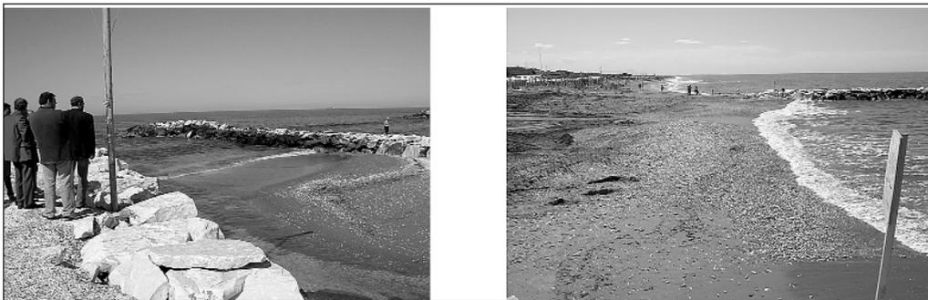
Figura 12 - Opere di difesa con pennelli emersi e scogliera sommersa di chiusura sul lato mare - a realizzare delle celle - , nel secondo tratto a sud di Marina di Massa. Ancora più a sud, dove finiscono le celle, il litorale è protetto solo con pennelli sommersi realizzati con sacchi di sabbia; questo tratto è estremamente critico e nei primi mesi del 2006, a seguito di una mareggiata si è avuta una forte erosione del litorale ed è stato necessario effettuare degli interventi di "urgenza".
