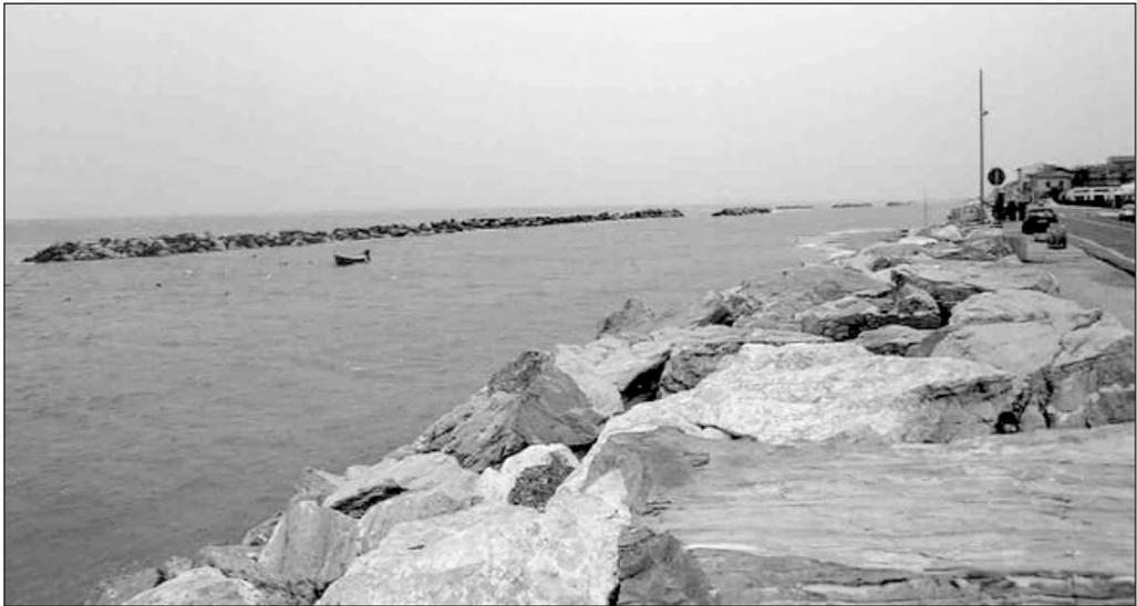
Figura 17 - Foto delle opere di protezione di Marina di Pisa, si notano le scogliere aderenti, realizzate agli inizi del 1900, e le scogliere emerse, realizzate tra il 1960 e il 1970. E' da notare la quasi assenza di spiaggia.
