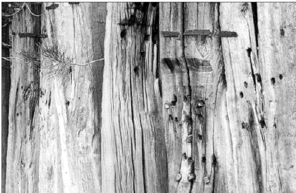
Figura 1 - Particolare delle traverse ferroviarie di legno ormai consunte, infisse a suo tempo nella duna di Balestrate (PA) a difesa della strada ferrata Palermo-Trapani dal sorrenamento (foto Puglisi).
