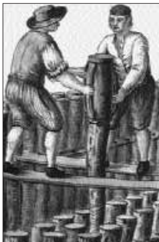
Figura 1 - Il palo infisso senza estrazione di terreno. Questa tipologia di pali affonda le sue radici nella storia, il primo palo di questo tipo impiegato dall'uomo è il palo in legno noto ed utilizzato nei secoli. Venezia ne è una testimonianza.
