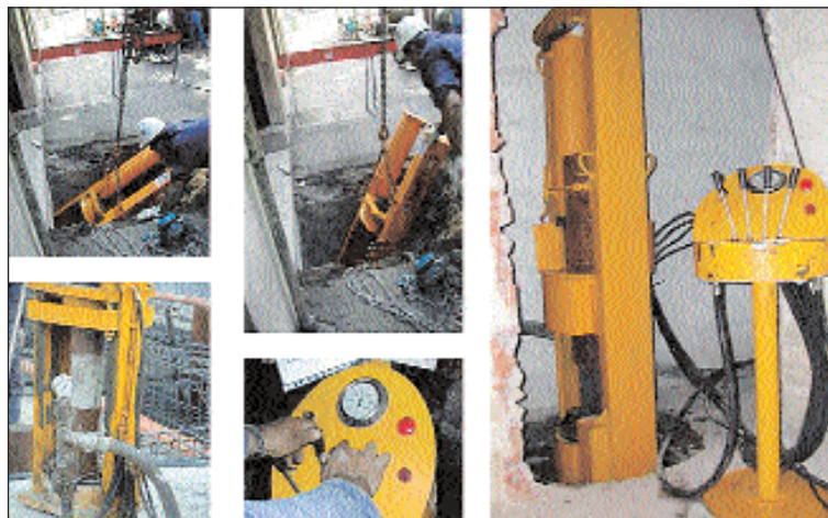
Figura 4 - Attrezzatura di infissione del palo Soles® e strumenti di misura.
