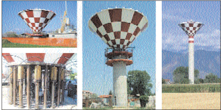
Figura 5 - Costruzione di serbatoi pensili . La vasca è costruita a terra e poi sollevata con speciali martinetti fino ad altezze di 50 -60 m
