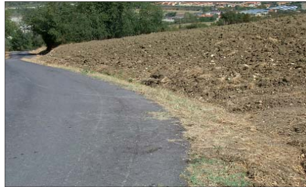
Figura 4 – Lavorazioni sino al ciglio stradale (mancato rispetto art. 28 – fasce di rispetto)
