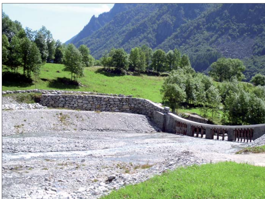
Figura 3 – La briglia costruita a valle della conca dei Gabi, sopra Forno A.G., dopo l'alluvione del 1993, con il bacino colmato dai sedimenti
