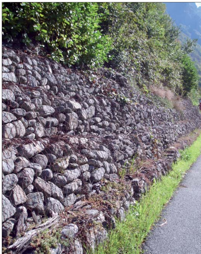
Figura 4 – I gabbioni di pietre collocati presso Chialamberto negli anni Cinquanta per contenere il versante instabile della montagna
