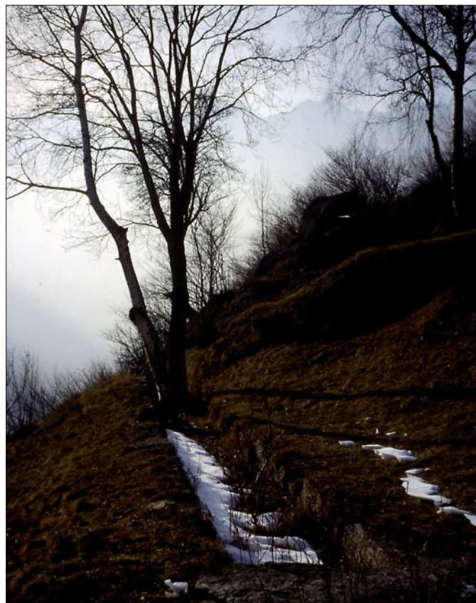
Figura 5 – Ai Rivotti di Pialpetta, un tratto del canale scolmatore, rimasto ostruito in occasione delle intense precipitazioni del 2000. Esempio di mancata manutenzione del territorio e delle opere di difesa del suolo
