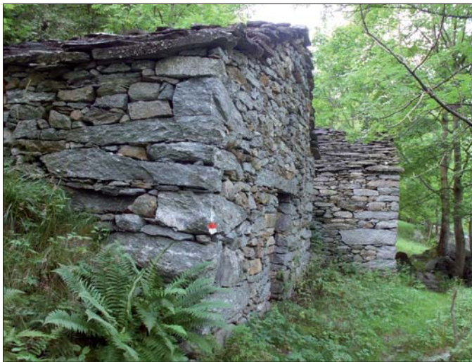
Figura 11 – I due “porti vej” dei Gabi (Forno A.G.) di cui risaltano i cantonali. Non dovendo riparare le facciate, i tetti non hanno aggetto
