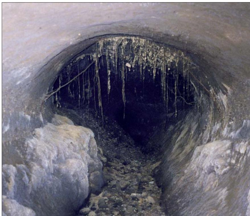
Foto b – Tratto superiore del cunicolo idraulico prossimale alla parte di imbocco delle acque del canale naturale di monte. Nel corso dei secoli i processi erosivi idraulici e termoclastici hanno ampliato (soprattutto nel tratto superiore) l'originaria antica sezione di scavo subrettangolare
