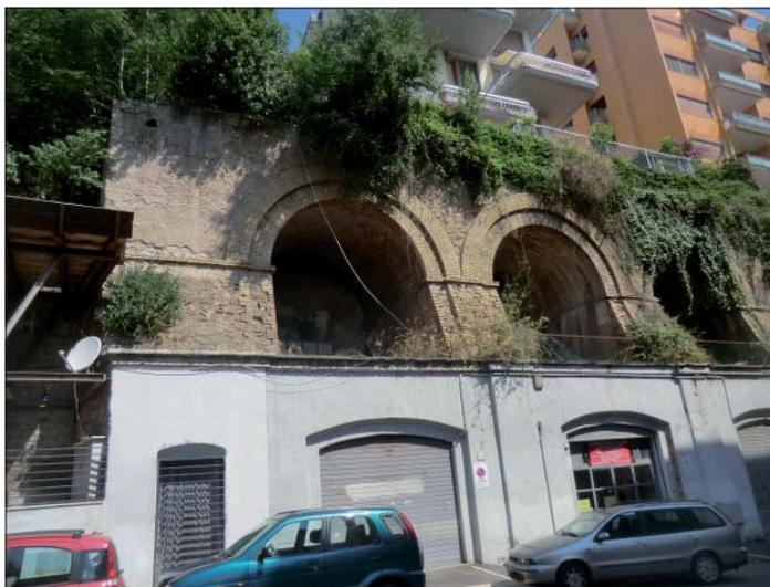
Foto b – Visuale del tratto di scarpata sostenuta da contrafforti ad arcate in muratura lungo la parte iniziale di Via di Ponziano
