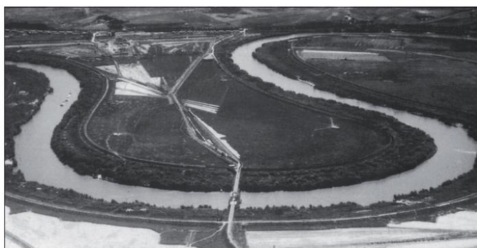
Foto b – Foto storica del meandro ancora esistente e dei lavori di scavo del drizzagno (1930)
