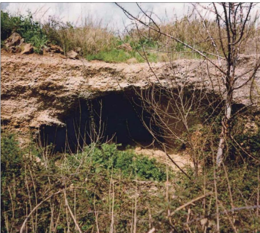
Foto a – Cavità di ingresso a sezione semicircolare, della galleria iniziale collegata con lo sviluppo di una rete caveale sotterranea, per l'estrazione di sedimenti ghiaiosi.
