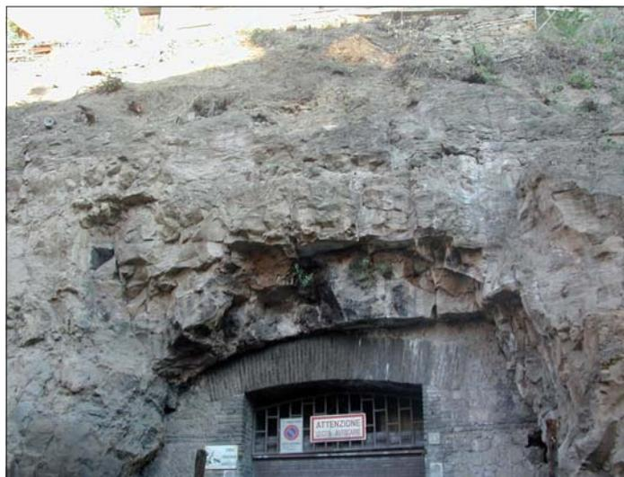
Foto c – Fratture e distacchi in corrispondenza della calotta di alcuni accessi alla rete caveale
