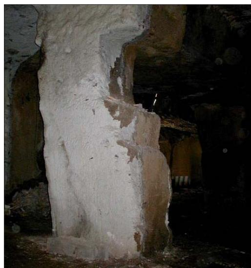
Foto b – Particolare di un pilastro lesionato
