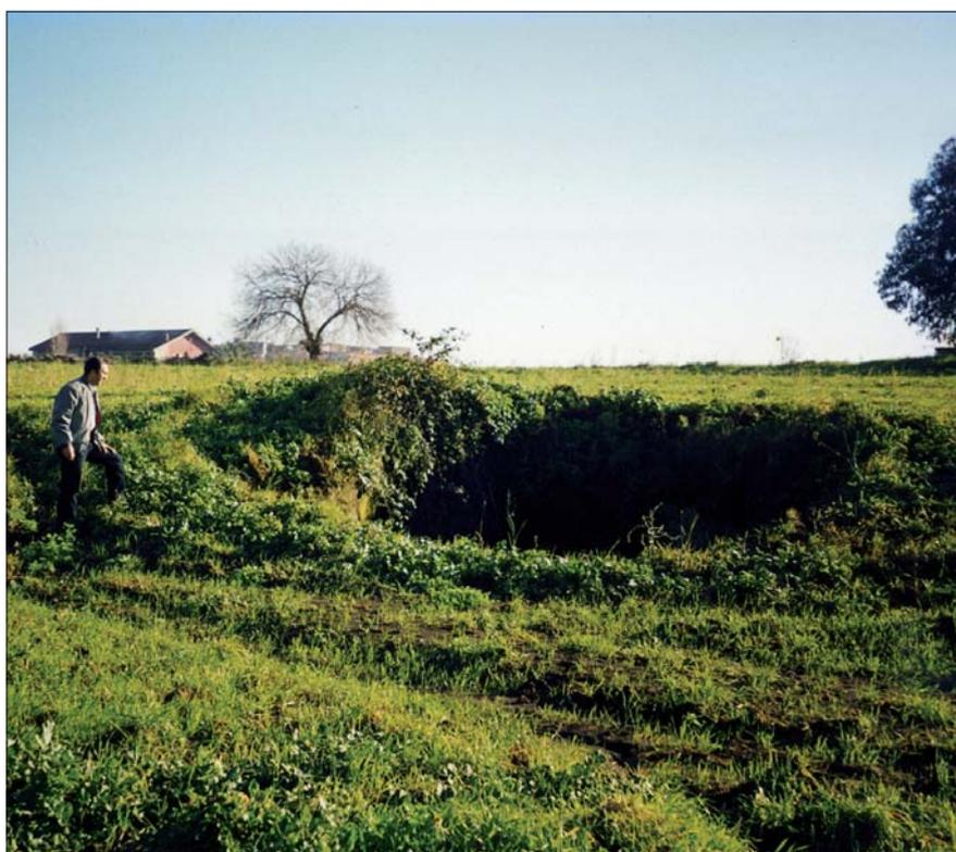
Foto d – L'apertura subcircolare di uno dei 13 pozzi di scavo e di ispezione collegati verticalmente con il cunicolo idraulico. I processi erosivi hanno notevolmente ampliato la sezione rettangolare di scavo
