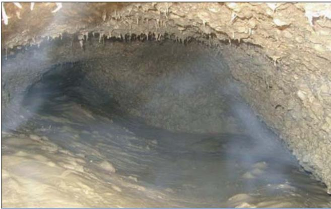
Foto b – Cavità sotterranee al piede della scarpata emersa durante i lavori
