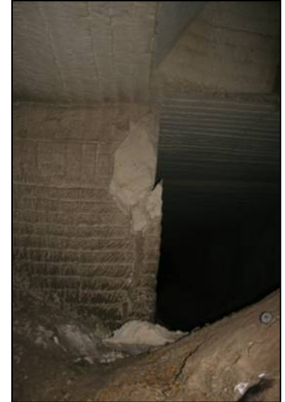
Rotture agli spigoli dei pilastri
