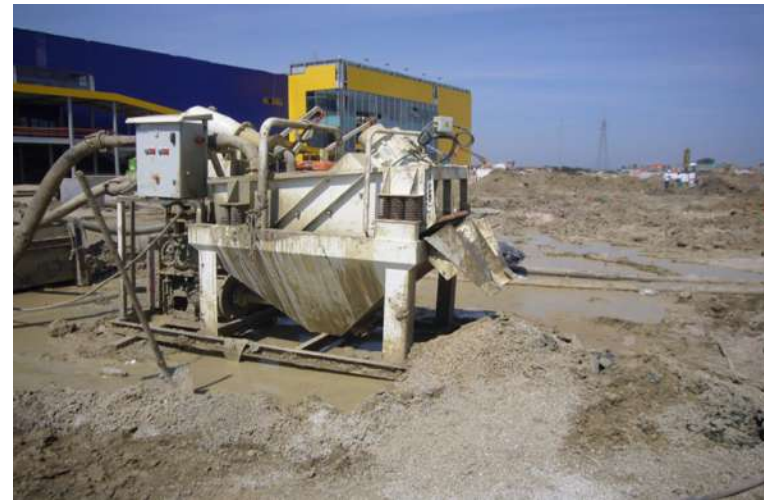
Pompa di iniezione per la cementazione dal basso
