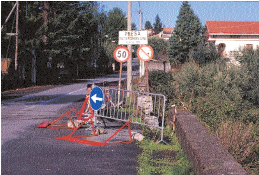
Foto 3 - Segmento della Faglia della Pernicana che disloca (circa 40-45 cm) un tratto della strada dell'accesso meridionale all'abitato di Presa.
