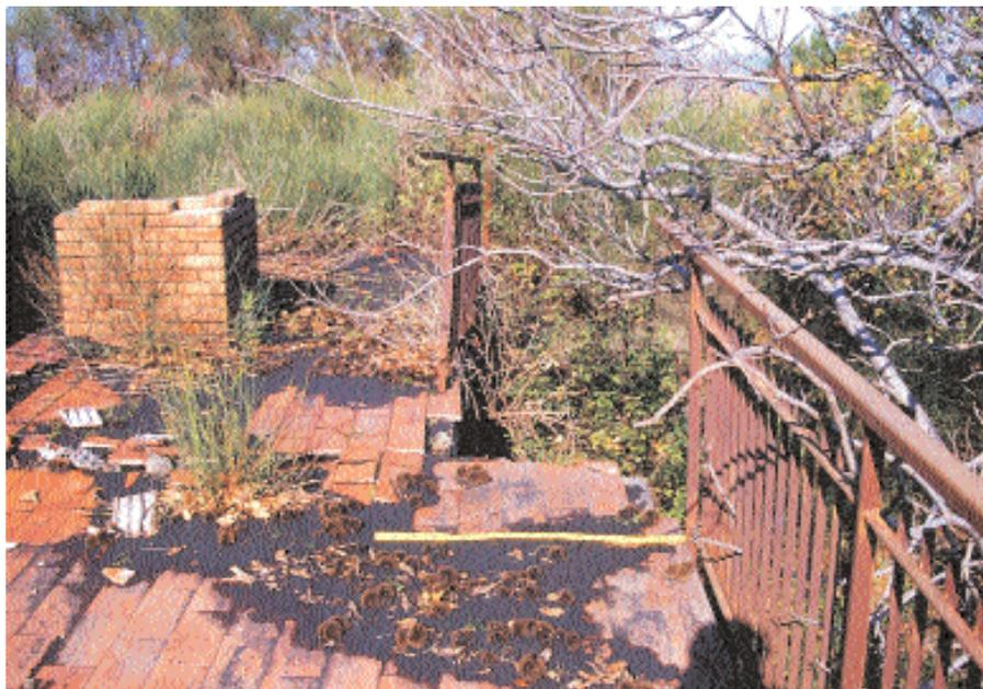
Foto 1 - La foto mostra gli effetti della dislocazione registrata su struttura antropica costruita sulla faglia. Da notare che il rigetto, di circa 90 cm, registrato nella struttura antropica è il prodotto della sommatoria di più eventi tettonici, compreso quello dell'ultimo episodio.
