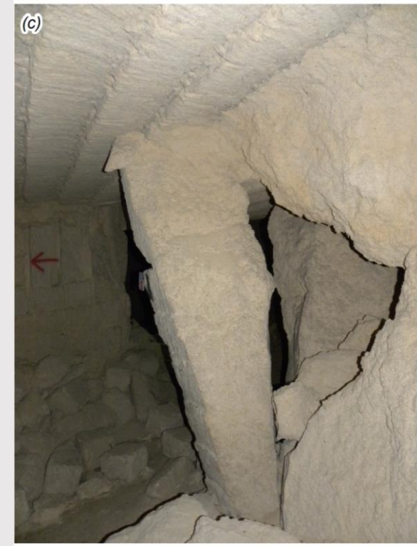
(c) Distacco di blocchi colonnari dalle pareti
