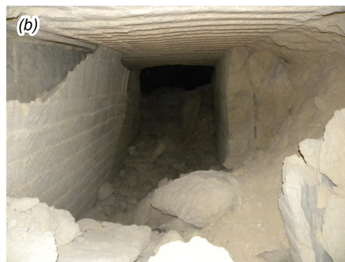
(a) Crolli con conseguente accumulo di materiale
