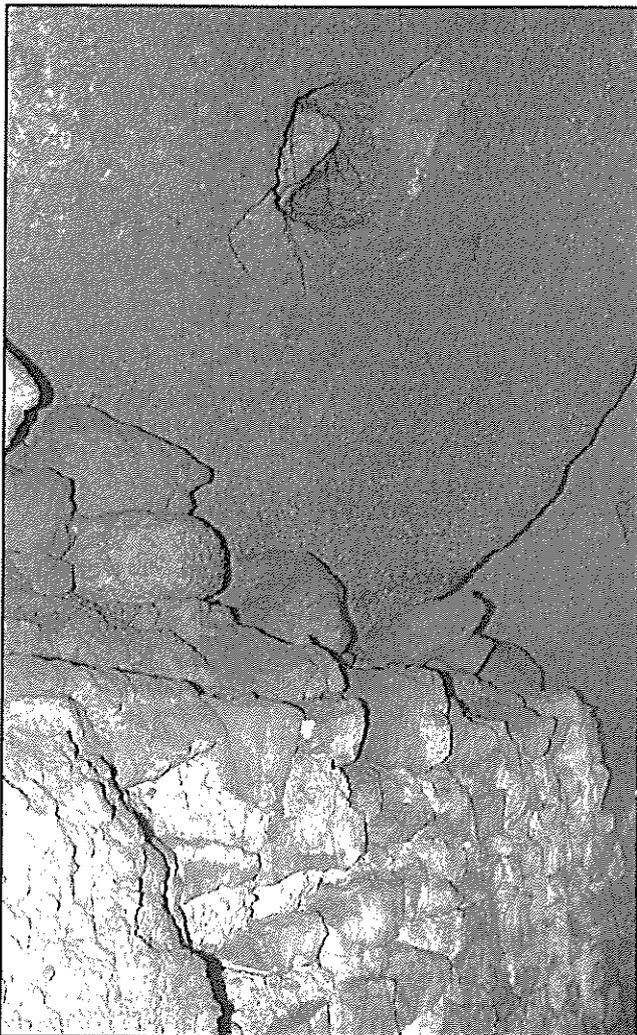
Figura 16 - Acquedotto delle Facciate di Nemi: una delle mole utilizzate per riparare il tratto di volta crollato (foto G. Filippi).
