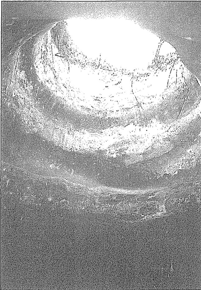
Figura 6 - Vista dall'interno del tratto superiore del cunicolo idraulico di uno dei pozzi scavo e di ispezione notevolmente ampliato nella sua sezione originaria di scavo rettangolare dai processi erosivi (foto CASTELLANI).
