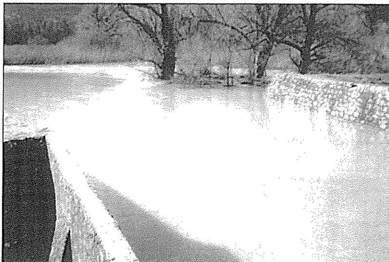
Figura 11 - Funzionalità degli organi di scarico durante l'esondazione del F. Aniene del marzo 2000
