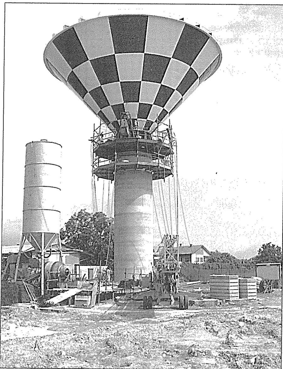
Figura 5 - Fase di sollevamento vasca con contemporanea costruzione del fusto in sottomuratura.
