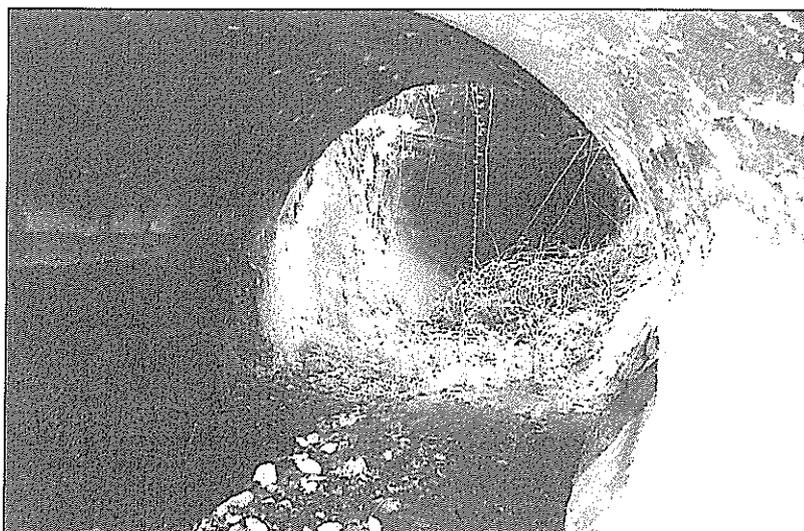
Figura 3 - L'ampia cavità di ingresso, del cunicolo idraulico in cui le acque di monte furono deviate in epoca etrusca, e fatte defluire al suo interno tramite un "gomito di cattura" artificiale a cielo aperto. Queste dimensioni iniziali del condotto, del diametro di circa 4 metri ed opera dei processi erosivi, diminuiscono progressivamente inoltrandosi verso l'interno (foto SUCCHIARELLI).
