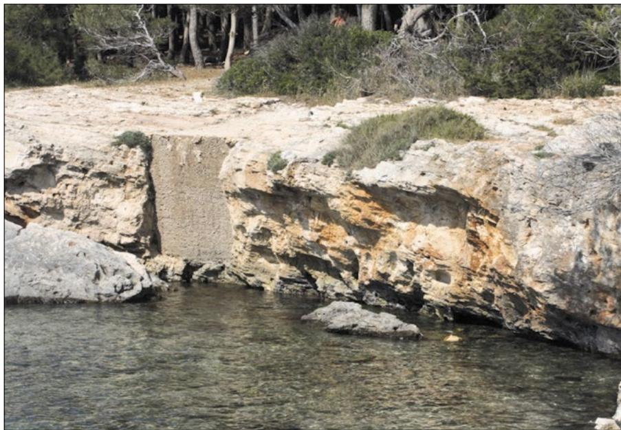
Figura 7. Sito 3: un muro in calcestruzzo ostruisce una copiosa sorgente costiera presente nella baia di Portoselvaggio. L'intervento fu realizzato negli anni '50 del secolo scorso nel tentativo di aumentare la produzione di alcuni pozzi realizzati a monte
