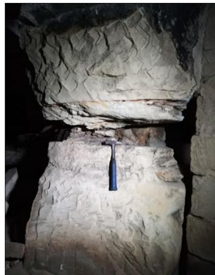
Figura 4. Particolare di un pilastro di un frantoio scavato nella Pietra leccese: assottigliamento del pilastro in corrispondenza di un intervallo marnoso particolarmente erodibile e conseguente perdita della funzione portante
