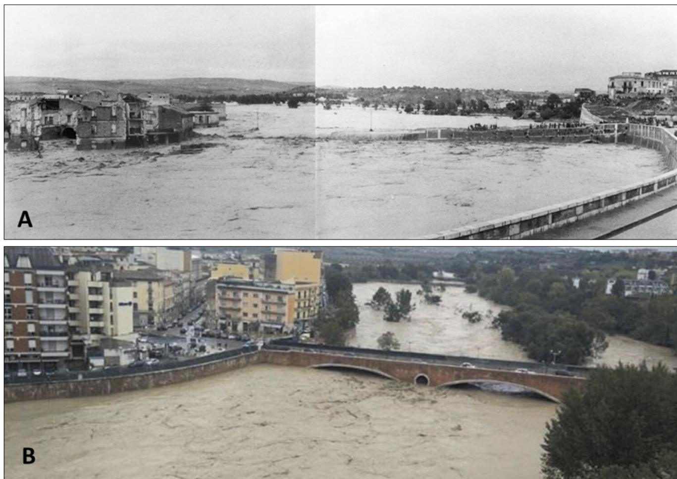
Figura 5. (A) Ponte Vanvitelli sommerso dall'alluvione del 2 ottobre del 1949; (B) il ponte rifatto con sole tre luci (di cui due visibili in foto) durante l'alluvione del 15 ottobre 2015. Si notino le mura realizzate sull'argine destro, la cui mancanza nella precedente alluvione fu causa di danni e vittime
