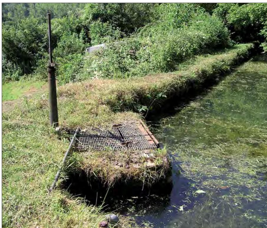
Figura 9 – La saracinesca che permette all'acqua raccolta nel bacino di mettere in azione la turbina sottostante.
