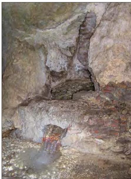
Figura 5 – La sorgente San Benedetto, fotografata all'interno dell'opera di presa per l'acquedotto di Vivaro. Essa alimenta anche il ruscello dal quale si approvvigiona il mulino. L'acqua fuoriesce dai calcari fessurati tamponati dalla formazione arenaceo-argillosa.
