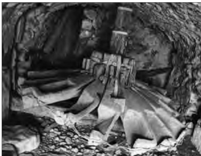
Figura 8 – La turbina orizzontale del mulino (retrecene) e suo stato di abbandono.
