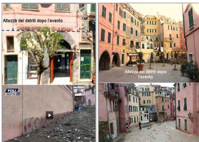
Figura 13 – Esempio dei danni causati dai flussi idrici, fangosi e detritici nell'abitato di Vernazza evitabili mediante l'isolamento dei locali al piano terra con porte a chiusura stagna.
