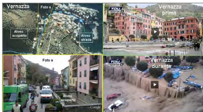
Figura 14 – In alto a sinistra: l'alveo strada che attraversa l'abitato di Vernazza; in basso a sinistra: l'alveo scoperto a monte dell'abitato. La sezione si è rivelata clamorosamente mal dimensionata ed insufficiente a smaltire il flusso fangoso-detritico che ha invaso la sovrastante strada devastandola (immagini a destra tratte dalla rete, YOU reporter).
