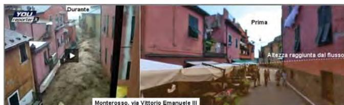
Figura 12 – Esempio dei danni causati dai flussi idrici, fangosi e detritici nell'abitato di Monterosso. L'isolamento dei locali al piano terra con porte a chiusura stagna potrebbe evitare i danni ai manufatti e alle attività economiche.
