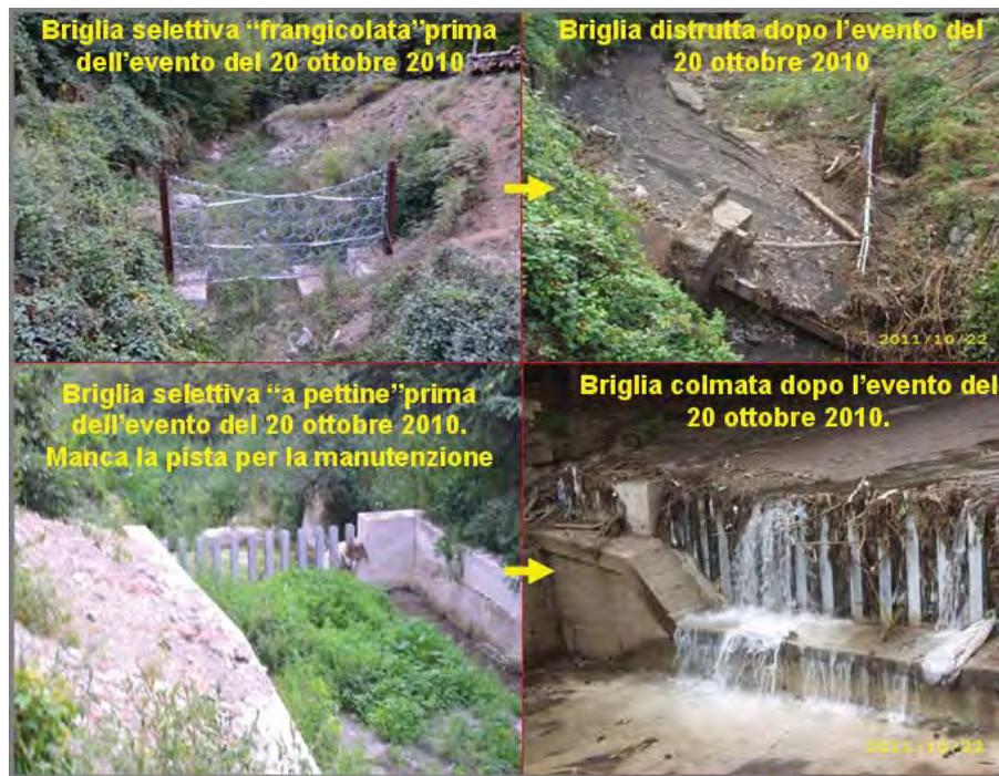
Figura 25 – Esempio di briglie mal concepite e realizzate nel bacino del Torrente Dragone a monte di Atrani dopo il disastro idrogeologico del 9 settembre 2010.
