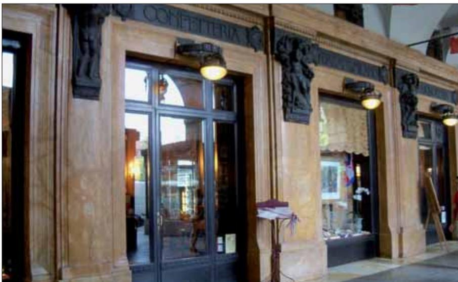
Figura 5 – rivestimento esterno del Caffè Baratti e Milano in Piazza Castello realizzato in marmo Giallo di Siena già citato nel lavoro di Sacco del 1907; la pavimentazione antistante è in Pietra di Luserna.
