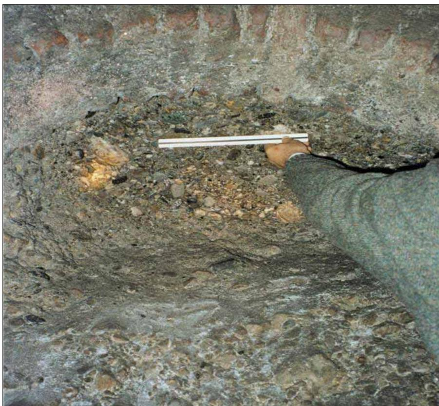
Figura 5 – Fronte in ghiaia cementata in un'antica galleria di mina e contromina della Cittadella.
