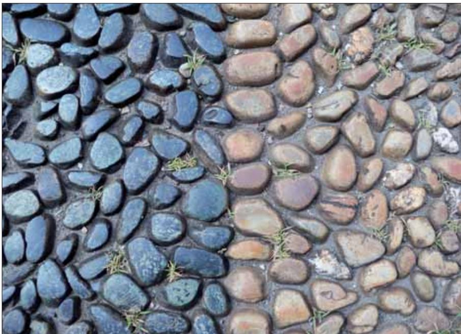
Figura 3 – acciottolato antistante alla chiesa di San Filippo Neri a tipologia bicromatica, con quarziti e più raramente gneiss negli elementi chiari e serpentiniti in quelli scuri.
