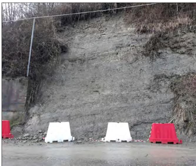
FIGURA 6. Frana da crollo localizzata lungo un versante ripido in località San Rocco sulla strada per Castiglione Alto.
