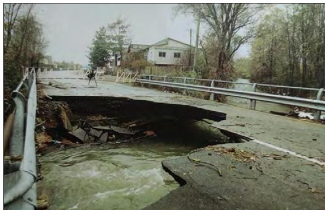
FIGURA 3 - Comune di Volpiano. Ripresa da Est dell'attraversamento sul T. Bendola, lungo la strada statale tra Volpiano e Leini, gravemente danneggiato dalle acque di piena del torrente (Regione Piemonte, 1998).
