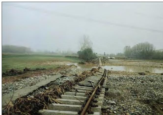
FIGURA 4 - Ripresa lungo la ferrovia canavese. Evidenti i danni causati dalle acque di esondazione del T. Malone straripate in destra idrografica a monte dell'abitato di S. Benigno (Regione Piemonte, 1998).
