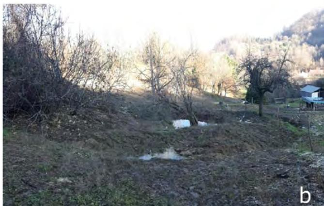
FIGURA 4. Scorrimento rotazionale avvenuto al km 2 della SP177, località Tetti Francesi, in data 24/11/2019: a) Scarpata principale e terrazzo di frana; b) Fenomeni di creep nel corpo di accumulo.
