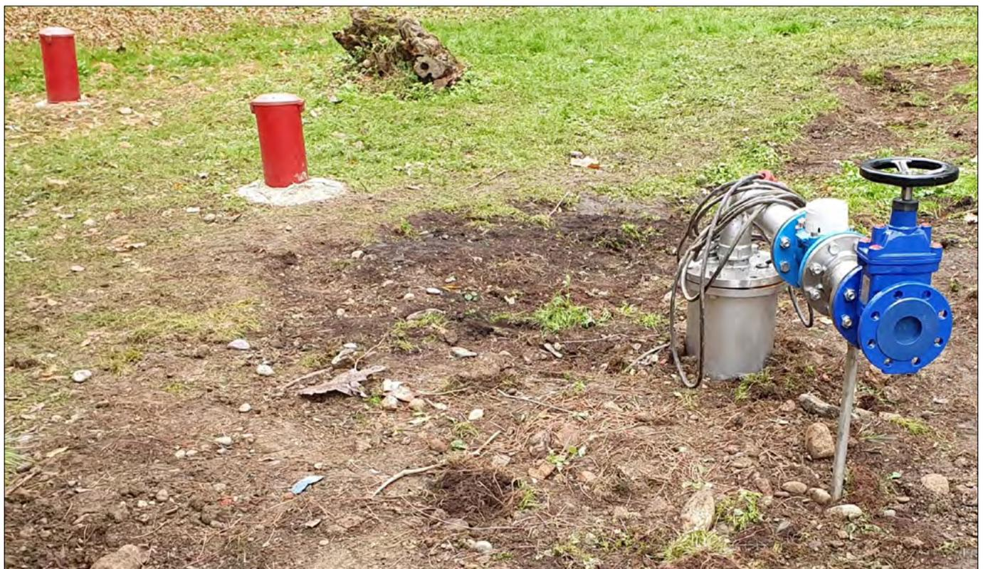
FIGURA 10 – Il pozzo con pompa sommersa capace di pompare fino a 15 l/s e i due piezometri realizzati precedentemente.
