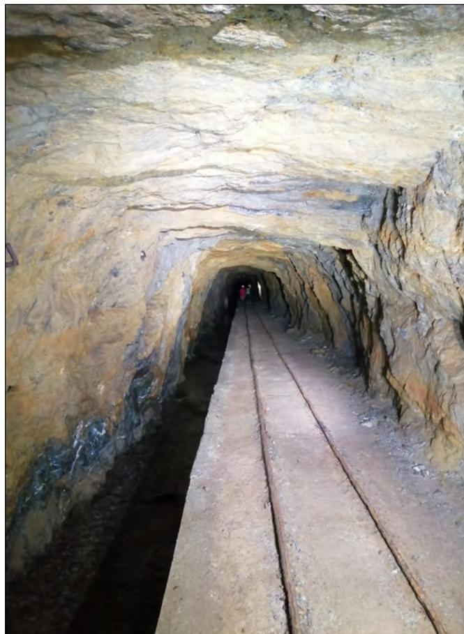
FIGURA 14. Galleria "Anglosarda" con binari delle decauville e le opere idrauliche ben conservate.
