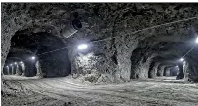
FIGURA 3. Gallerie della cava di gesso di Murisengo, scavata con esplosivo.
