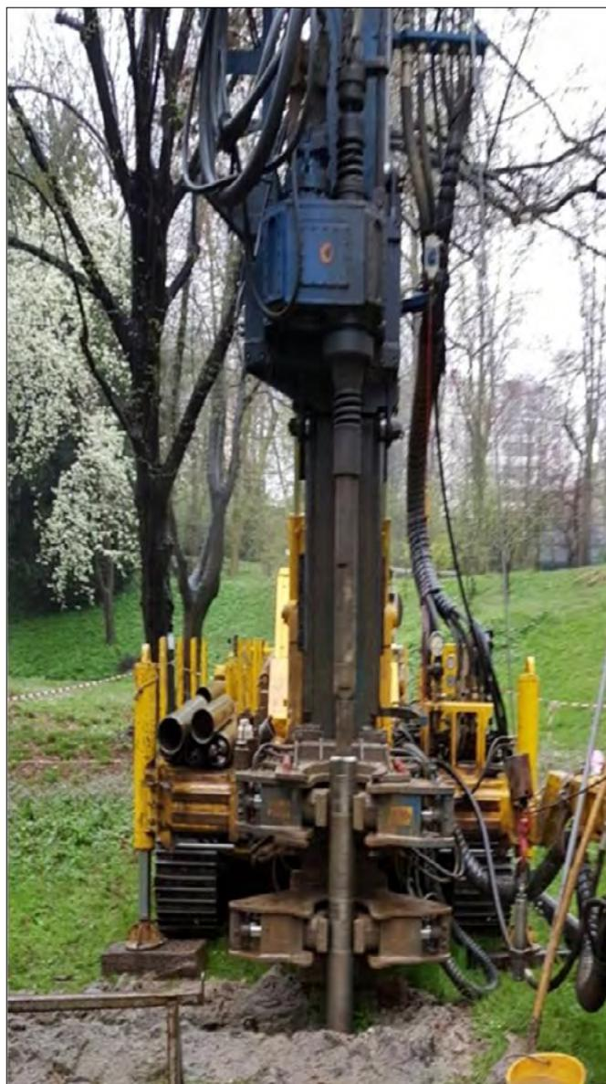
FIGURA 3 – Perforazione a carotaggio continuo per l’installazione del primo piezometro.
