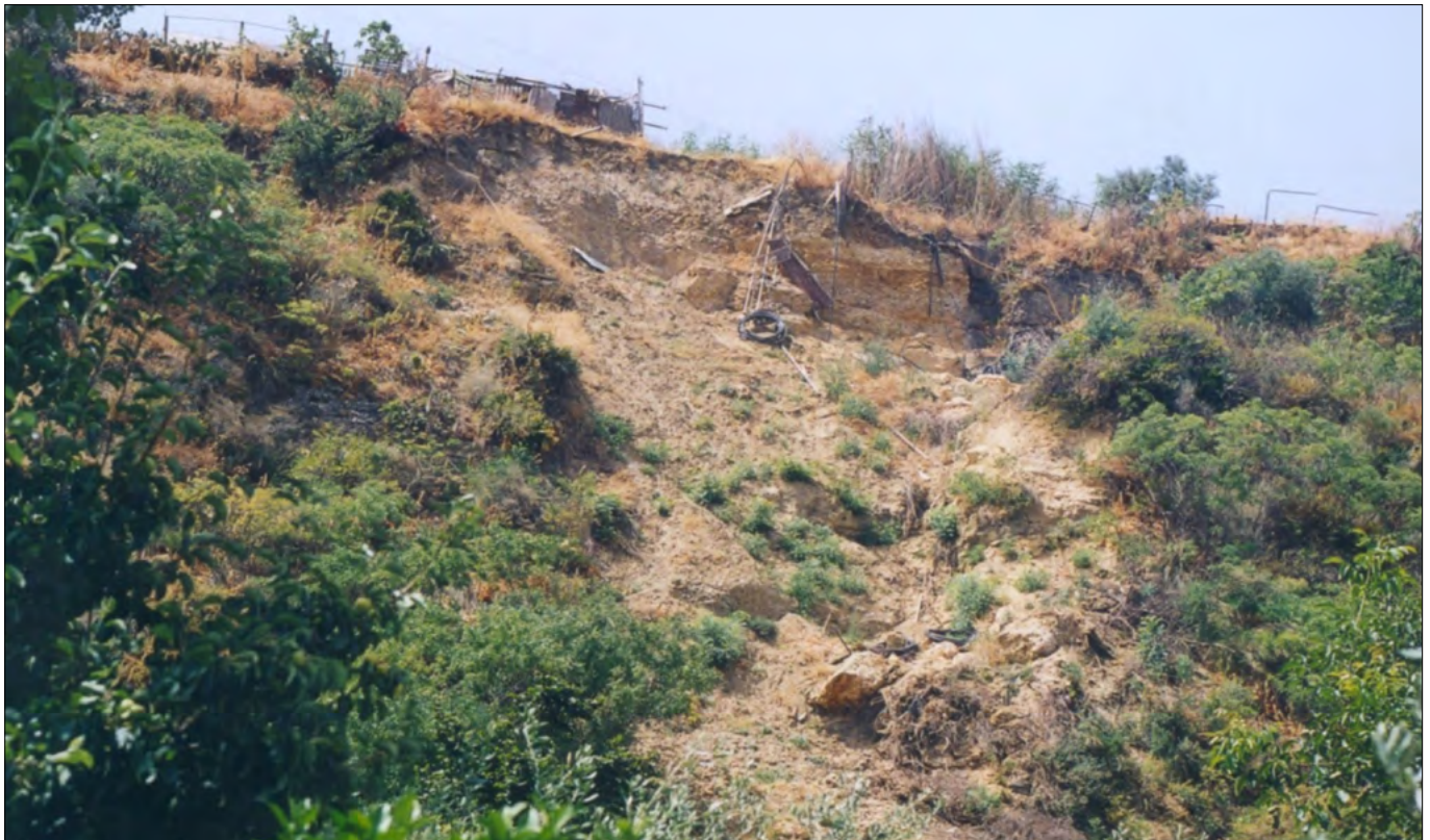
FIGURA 22. Calamonaci, Agrigento. Contrada Mancusi. Frana di crollo nei banconi calcarenitico-conglomeratici per problematiche connesse allo scalzamento al piede del terrazzo, dovuto alla rilevante azione erosiva delle acque selvagge superficiali in occasione di accadimenti piovosi torrenziali.
