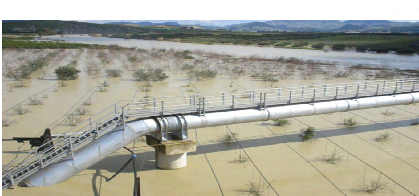
FIGURA 24. Cattolica Eraclea, Agrigento. Ottobre 2016. I terreni di contrada Vizzì, intensamente coltivati ad aranceti “Washington Navel di Ribera” le cui piante appaiono totalmente sommerse e sradicate dalla furia delle acque del fiume Platani che tendono a divagare in modo del tutto incontrollato.
